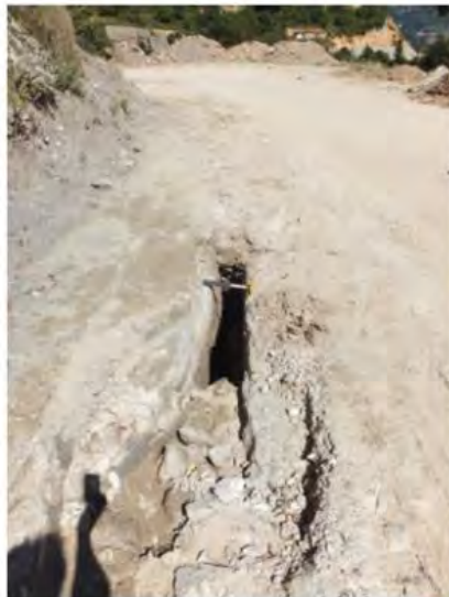
トマンクリフのり尻に生じている現道上の空洞 (出典:JICA 調査団)
