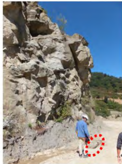
トマンクリフのり尻に生じている現道上の空洞 (出典:JICA 調査団)
