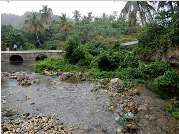
中洲・河道内樹木の出現による流下断面の阻害
