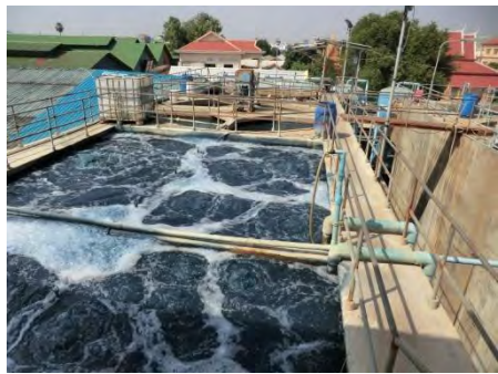
ស្ថានីយ៍ប្រព្រឹត្តិកម្មទឹកកខ្វក់នៅរោងចក្រជ្រលក់ពណ៌ក្រណាត់
