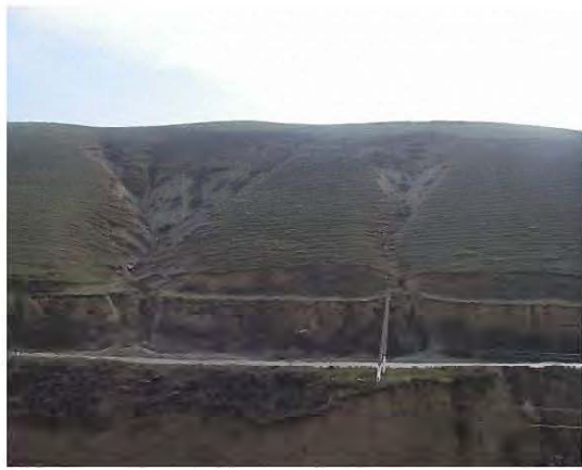
53+700 山側斜面の状態、法肩崩壊（コンクリート防護壁落下）
