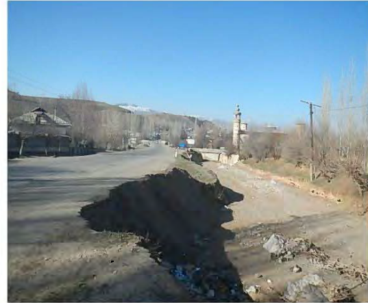
29+300 付近 流路が接近 道路本体が危険、道路を保護するブロック積み擁壁を設置する
