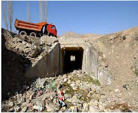
29+981 付近の横断ボックス(上流側)
