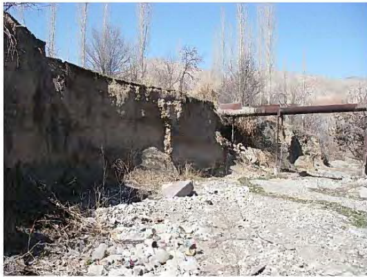
ボックス下流側の状況
