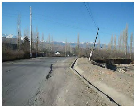
28+300 付近 流路が接近 道路の法面を保護するブロック積み擁壁を設置する
