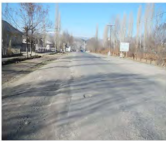
29+000 付近路面状況 亀甲状のクラック 路床・路盤の支持力低下による
