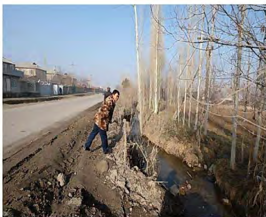
30+500 付近 右側用水路を付け替える
