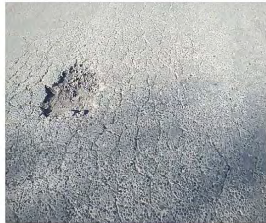
29+000 付近路面状況 亀甲状のクラック 路床・路盤の支持力低下による
