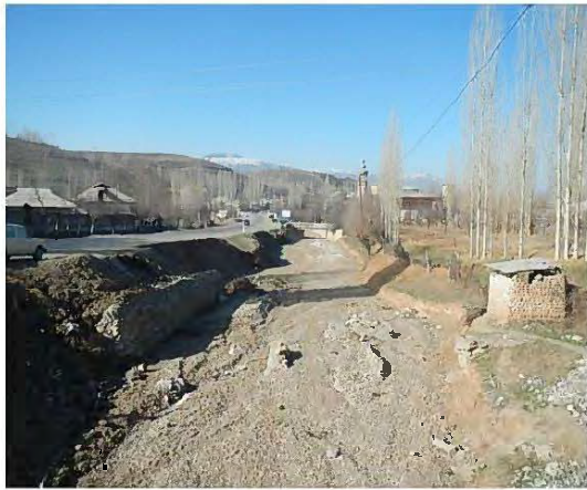
29+300 付近 流路が接近 道路本体が危険、道路を保護するブロック積み擁壁を設置する
