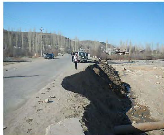
29+548Km 地点の橋梁 (L=39.67m) 手前流路が接近 道路の法面を保護するブロック積み擁壁を設置する、沿道アクセスの渡り部 (メタル橋、ボックス) が狭小であることが起因している。灌漑用水のパイプが道路、流路を横断している。(写真 右)
