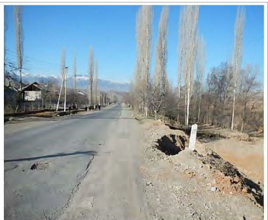
28+500 付近 流路が接近 道路の法面を保護するブロック積み擁壁を設置する
