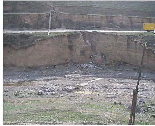
53+700 山側斜面の状態、法肩崩壊（コンクリート防護壁落下）
