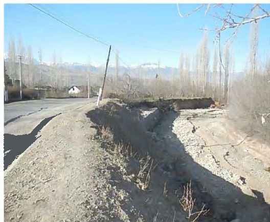
28+300 付近 流路が接近 道路の法面を保護するブロック積み擁壁を設置する
