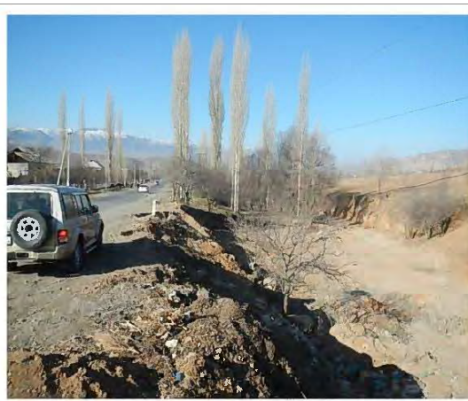
28+500 付近 流路が接近 道路の法面を保護するブロック積み擁壁を設置する
