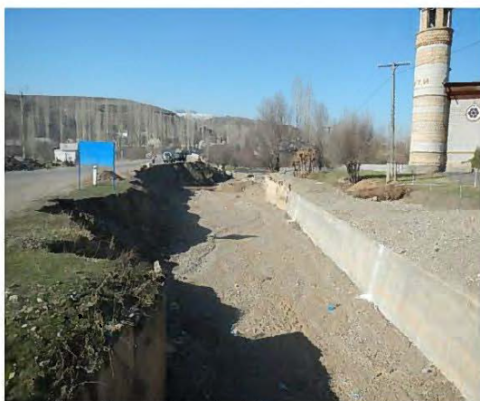
29+548Km 地点の橋梁 (L=39.67m) 手前流路が接近 道路の法面を保護するブロック積み擁壁を設置する、沿道アクセスの渡り部 (メタル橋、ボックス) が狭小であることが起因している。灌漑用水のパイプが道路、流路を横断している。(写真 右)
