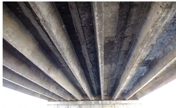
写真 7.2.3 29km+547.92 現橋の主桁・横桁状況
