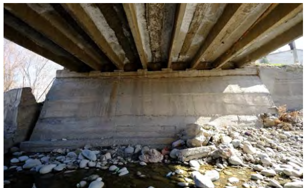
写真 7.2.4 35km+883.08 現橋の主桁・横桁状況
