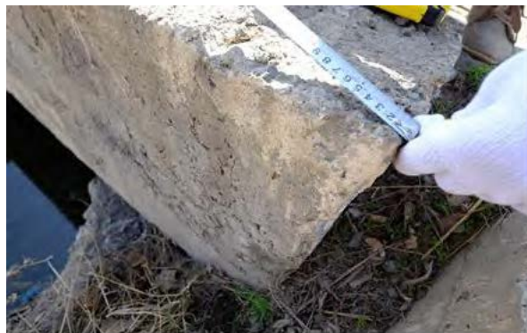
写真 7.2.6 47km+585.00 現橋の桁かかり長
