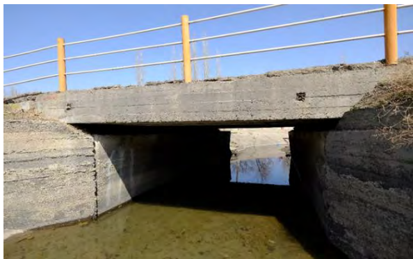
写真 7.2.5 54km+888.12 現橋の状況
