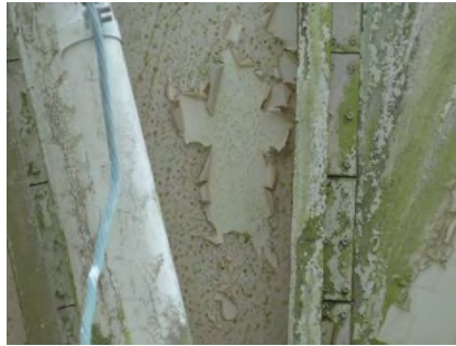
写真-11 主反射鏡背面部の塗装剥がれ
