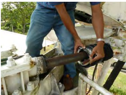
写真-4 AZ 部のジャッキシャフト
