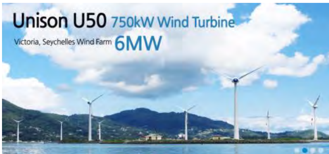
図 2.4.1-4 風力発電設備設置状況
