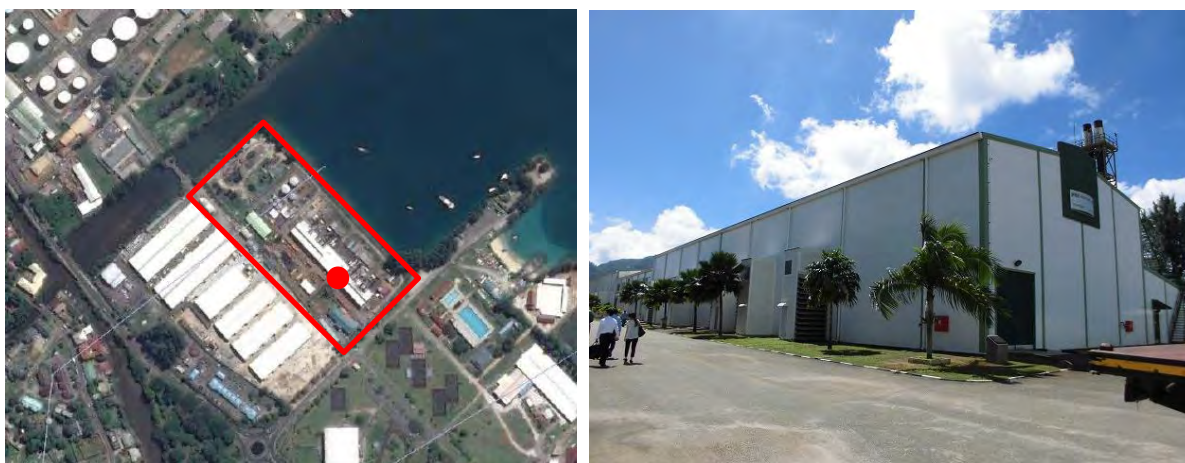
VictoriaC 発電所敷地内
