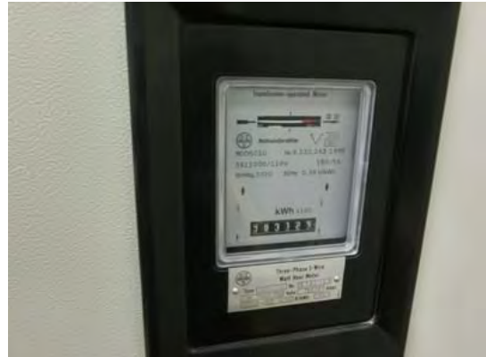
図 3. 2. 5-15 電力量計 (SET 6P-8P)
