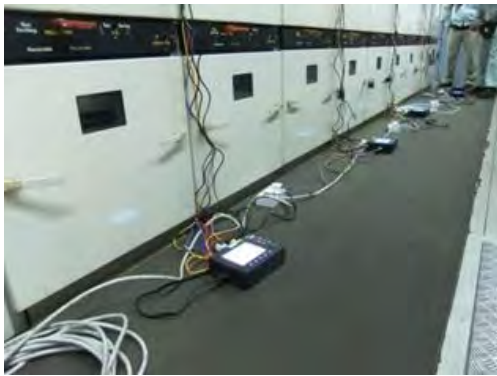
負荷遮断計測器設置状況 (Praslin 島)
