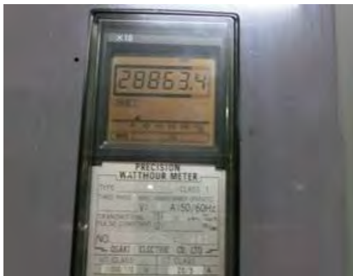
図 3. 2. 5-14 電力量計 (SET 1P-4P)
