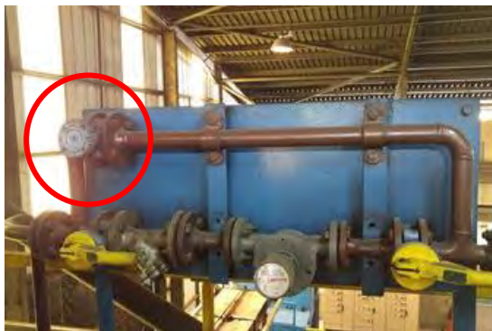
図 3.2.6-12 SET8P 流量計周り (バルブ故障)
