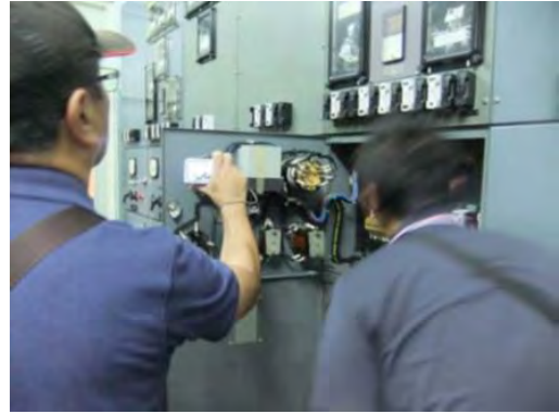
計測信号取り出し調査 (Praslin 島)
