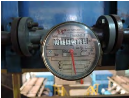
図 3. 2. 5-12 燃料流量計 (SET 6P-8P)
