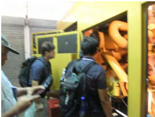
発電所調査状況 (Desroches 島)
