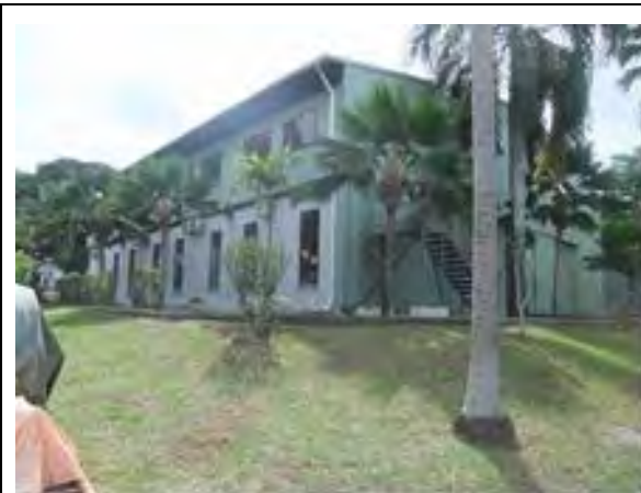
PUC Praslin 発電所 DG 発電所
