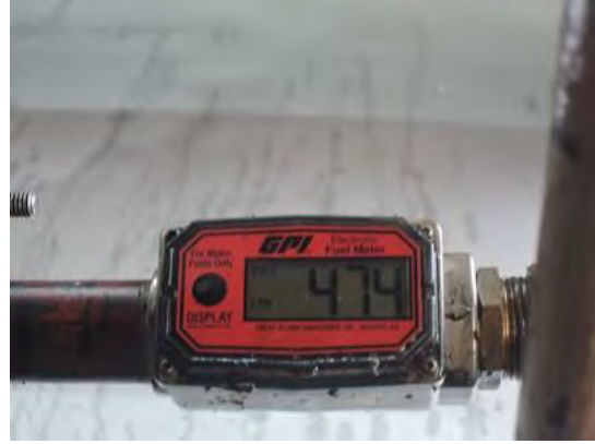
図 3. 2. 5-11 燃料流量計 (SET 1P-4P)
