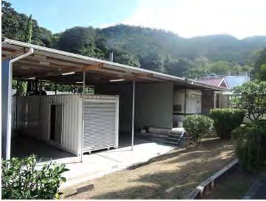
図 3. 2. 5-10 コンテナ型発電機 (SET M4-M6)
