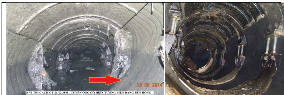
Hình 4.1.3 Sự xuống cấp của Tuyến cống bao (D800mm)
