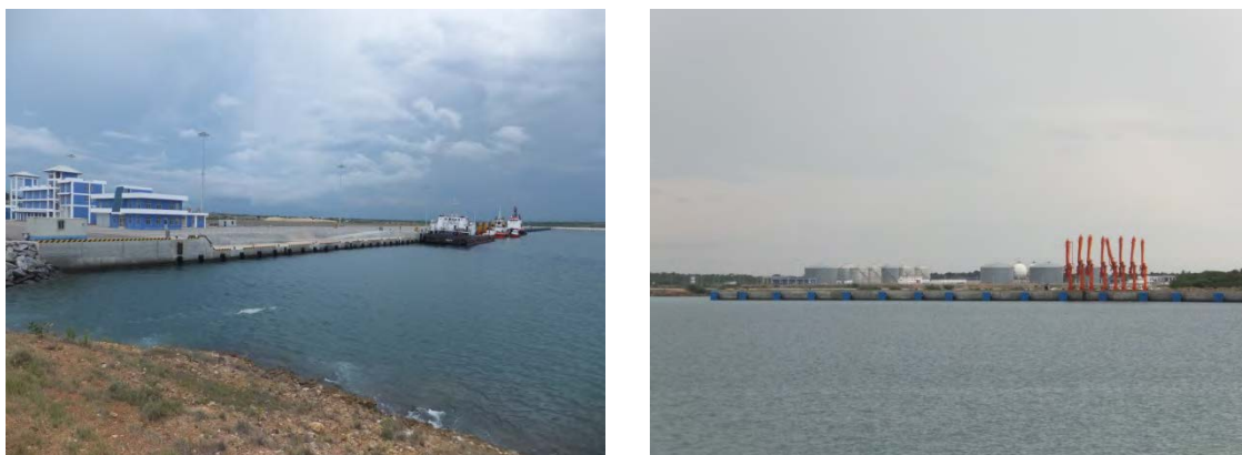
図 2.4.8 多目的埠頭と石油棧橋
