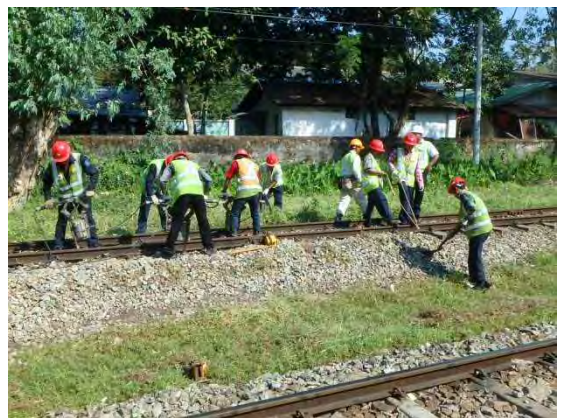
上り線0k400mむら直しとバラストかき上げ
