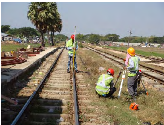
レベル測量、ホームでは上屋工事
