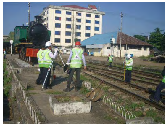
インスペクターへのレベル取扱い実習
