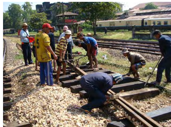
109B 号分岐器を人力だけで移動
