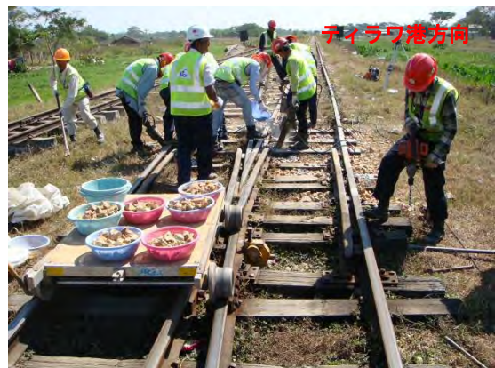
バラスト補充しながらつき固め、イヌクギ穿孔
