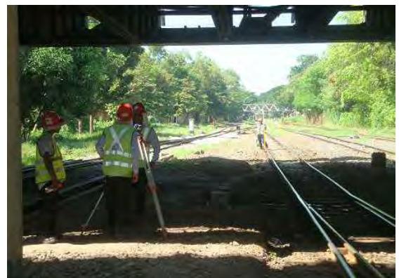
スーレーパゴダ通り交差部の測量
