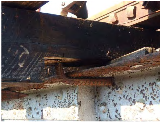
フックボルト取付け状況
