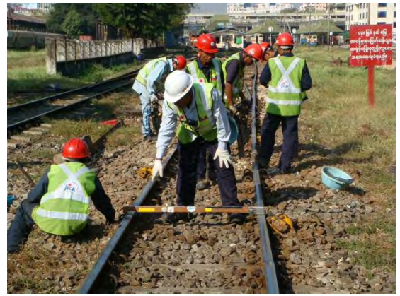
水準整正後つき固め
