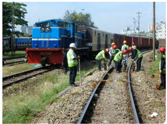
上り線 0k370m 付近むら直し(カント 40 mm)
