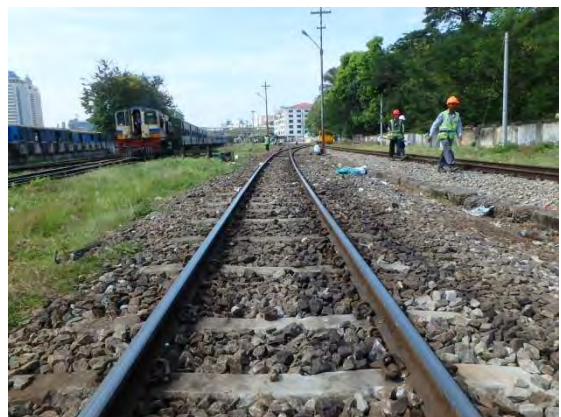
下り線 0k380m よりヤンゴン方仕上げ
