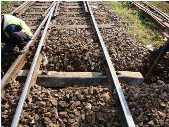
PC マクラギ挿入
