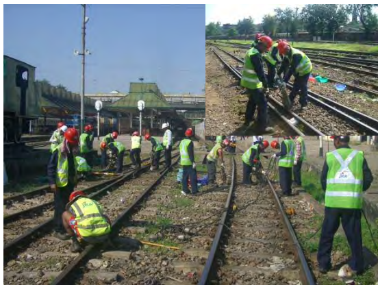
タイタンパーによるつき固め
