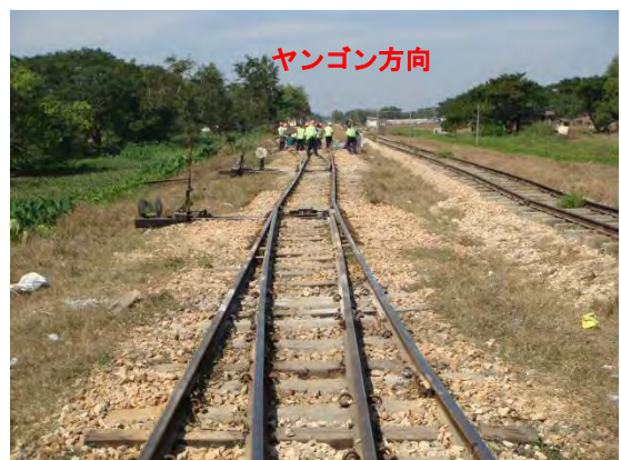
整備した分岐器
