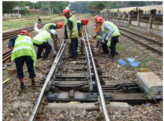
7 番線 130A 号分岐器むら直し
