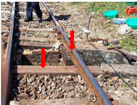
横断排水路の木マクラギ2本交換
