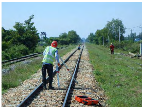
トランシットでセンターを確認
