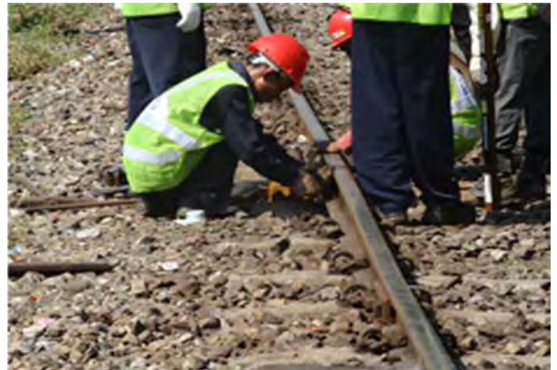
継目ボルト整備
