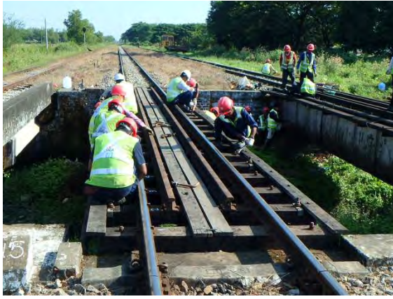
フックボルト交換
