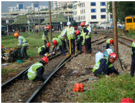
レベルを確認してレール扛上
