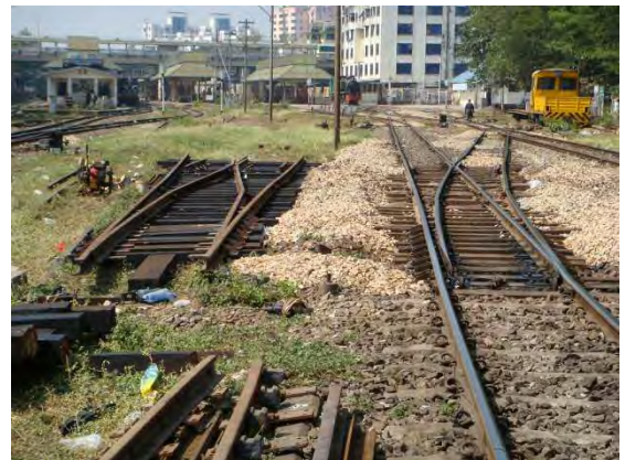
仮組した 109B 号分岐器
