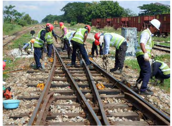
63A分岐器むら直し (上り線)
