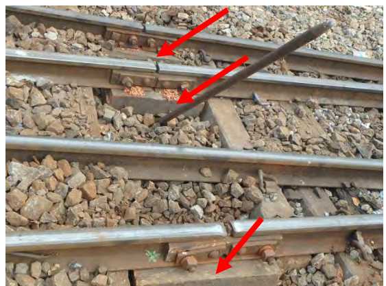
継目部に縦短マクラギ挿入
