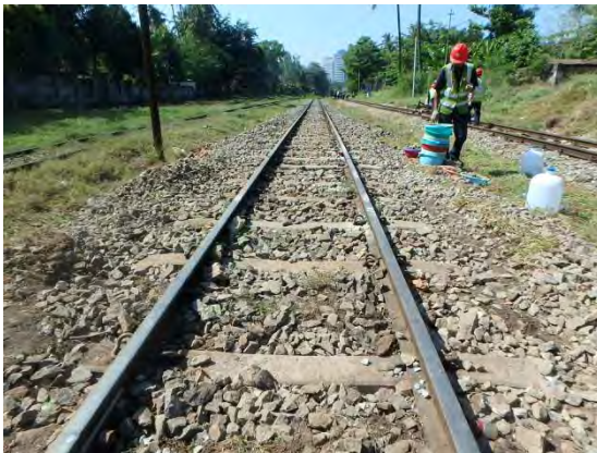
下り線仕上がり
