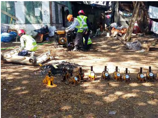
発電機のオイル交換、トロリーの補修
