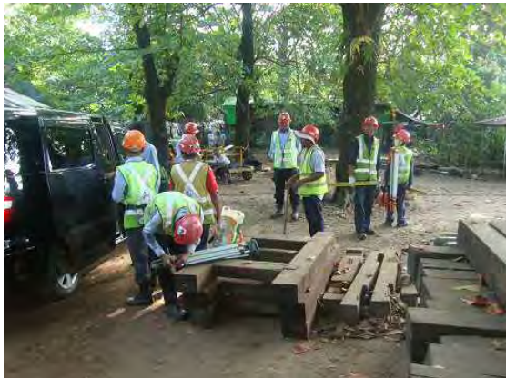
作業開始前の状況
