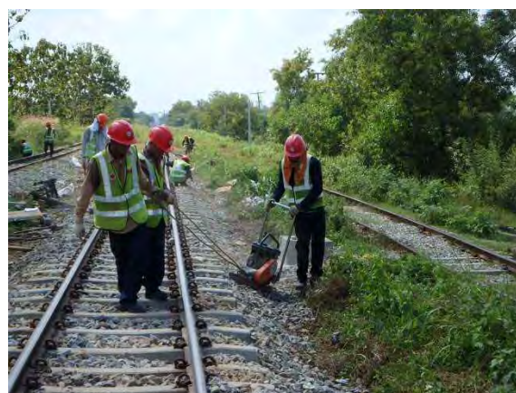
振動コンパクターによる道床肩締固め
