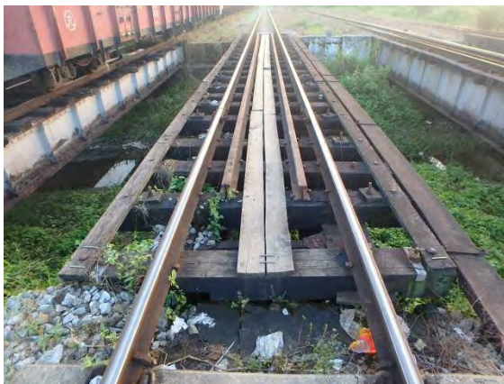
下り線 No15 橋りょうバゴー方から(施工前)
