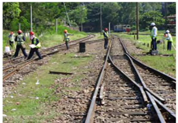
整備後の状況
