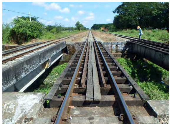
上り線 No15 橋りょうヤンゴン方から(施工後)
