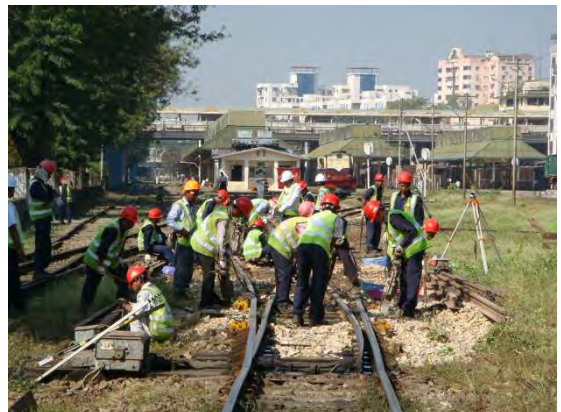
環状線内回り 130B 号分岐器むら直し
