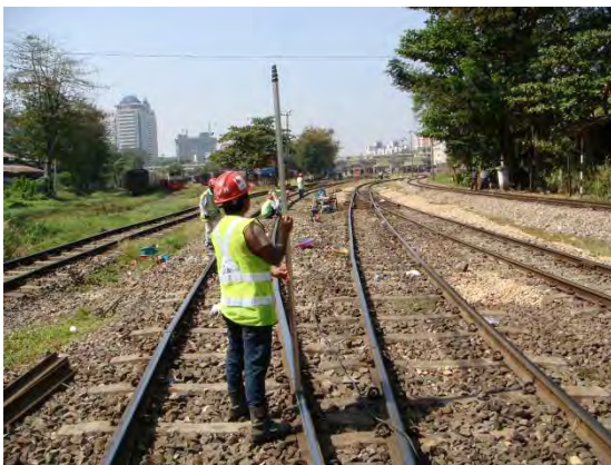
レベル測量で扛上量を測定
