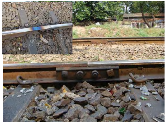
削正したレールの継ぎ目部分
