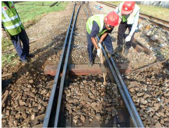
下り線 109B 号分岐器木マクラギ交換
