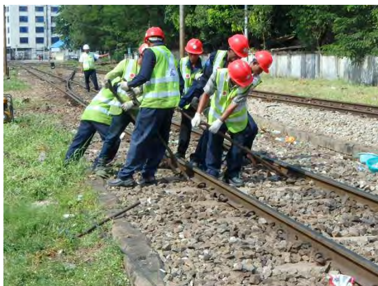
下り線 0k370m 付近通り直し
