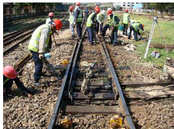
交換したマクラギをつき固め
