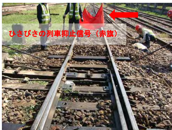
118B分岐器でマクラギ交換
