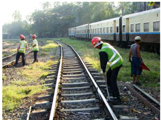
継目ボルト再締結
