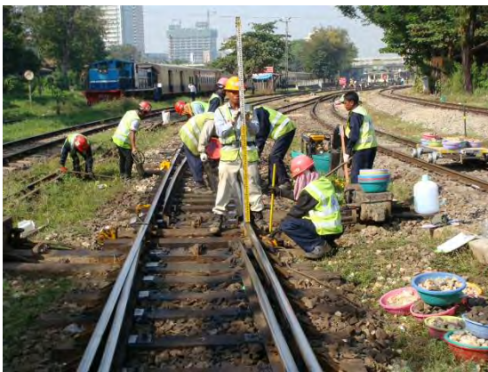
レベル測量で扛上量を確認
