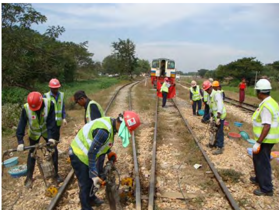
列車を抑止してつき固め
