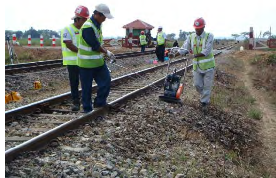
コンパクターでバラスト締固め
