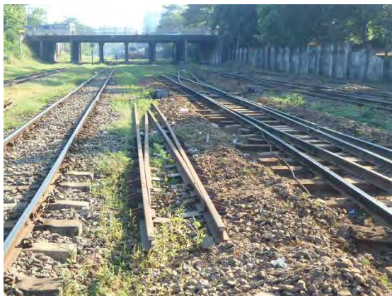
129B 分岐器 交換トング部
