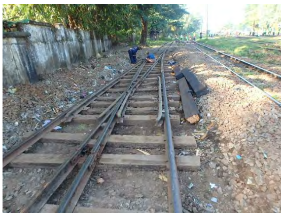
133A 号分岐器と交換木マクラギ
