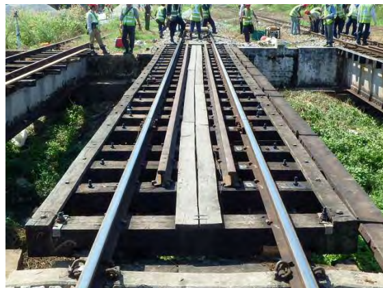
下り線 No15 橋りょうバゴー方から(施工後)
