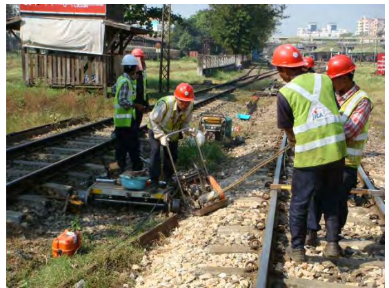
コンパクターでバラスト締固め
