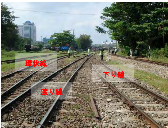
0k470m付近渡り線と下り本線の仕上がり
