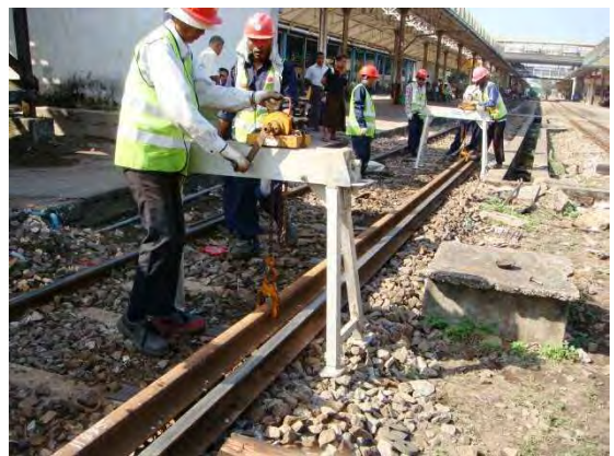
レール山越器を使ってレール交換
