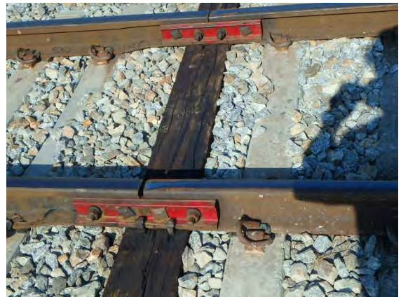
交換した継目板 (上り線 14k512m)
