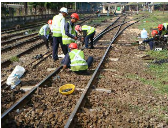
118B 号分岐器バゴー方マクラギ交換
