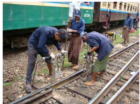
YM 幹線下り線むら直し（MR の施工）
