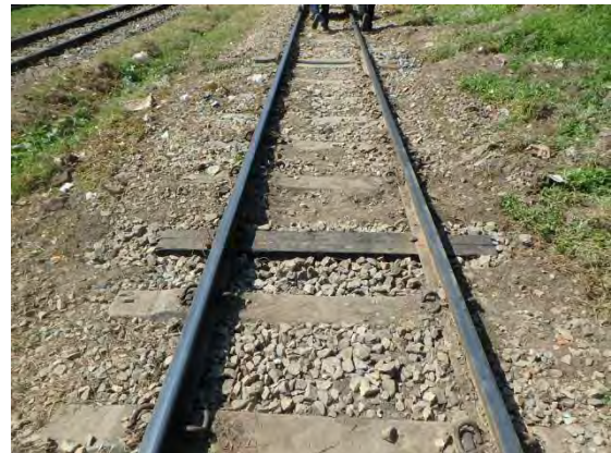
継目木マクラギ挿入
