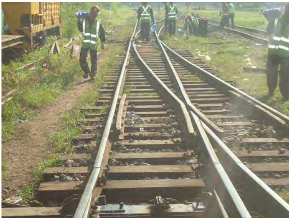
バラストがほとんどない軌道(この後、バラスト投入)
