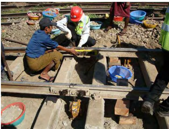
掘削後絶縁継ぎ目交換（ロンジー姿は信号屋）
