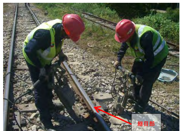
つき固め（継目部）
