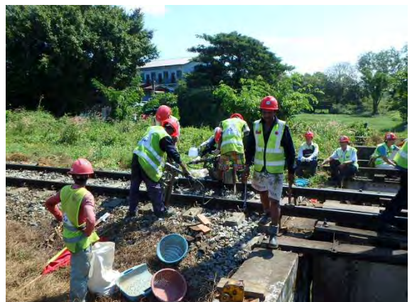
アバット部つき固め
