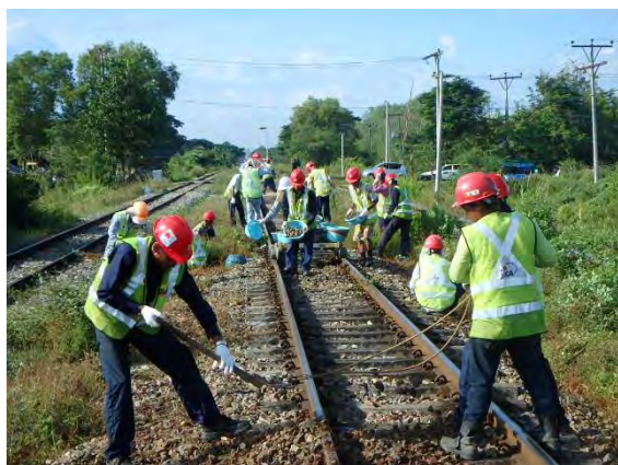
バラストかき上げとバラスト運搬
