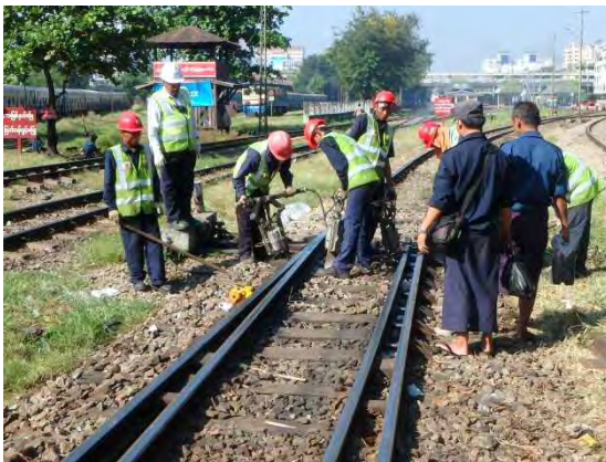
下り線128A号分岐器むら直し
