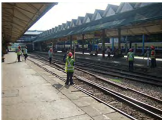
構内の測量の状況
