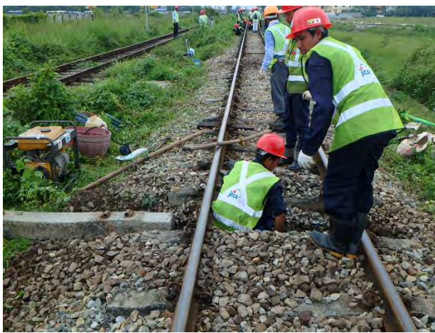
PC マクラギ挿入
