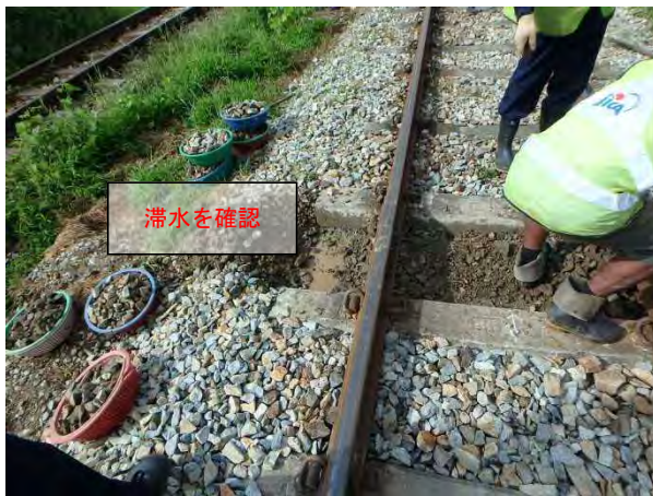
PC マクラギ下の噴泥状況
