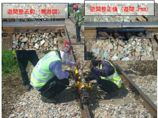
遊間整正の状況
