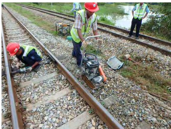
継目板ボルト再締結と道床締固め
