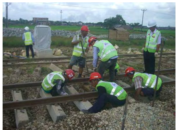
PC マクラギ位置整正
