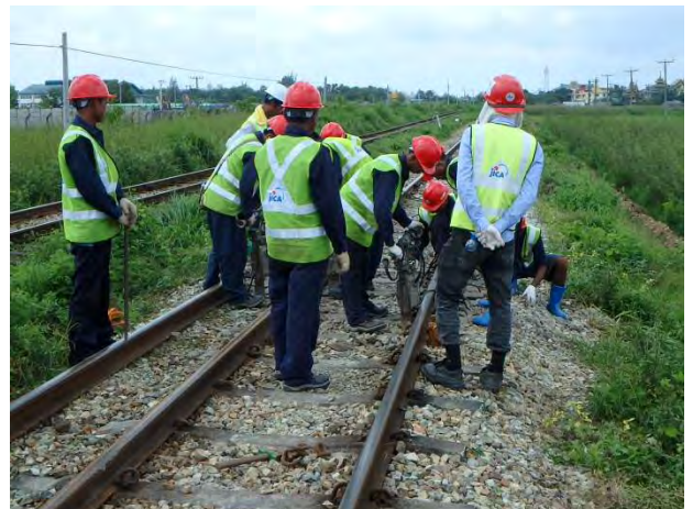
PC マクラギ挿入部つき固め
