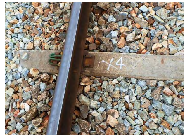
マクラギ製作中での治具陥没
