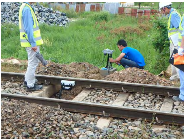
センサー設置（下り線）
