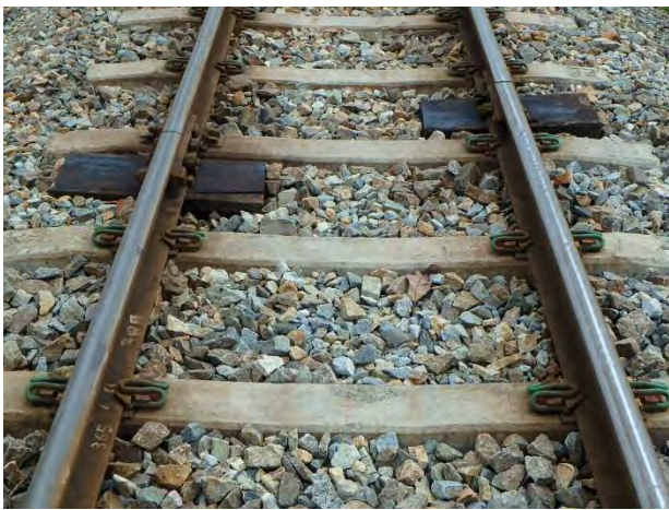
継目部施工前
