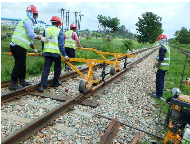
切断レール撤去
