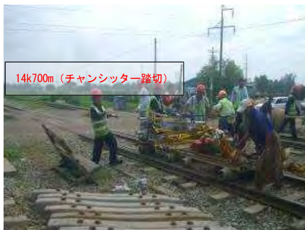
トロによる資機材運搬
