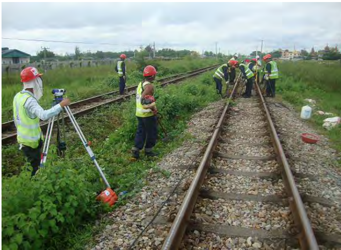
作業全体の状況
