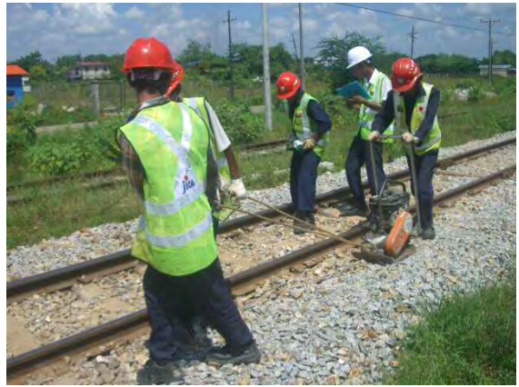
振動コンパクターによる道床肩締固め
