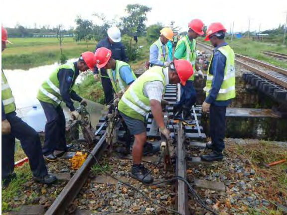
タイタンバーによるつき固め
