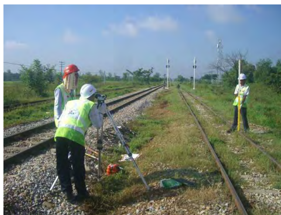
インスペクターへのレベル測量実習
