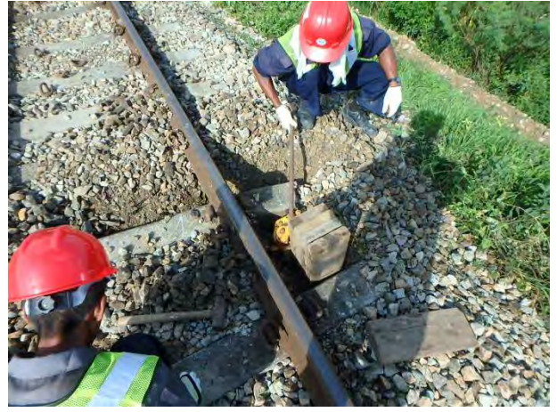
PC マクラギ位置修正
