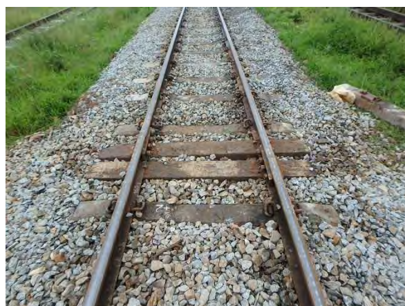
挿入した継目木マクラギ
