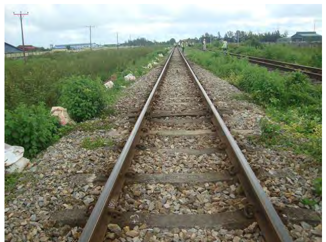
作業終了後の状況
