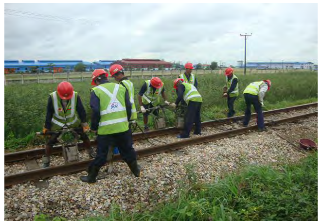
突き固めの状況
