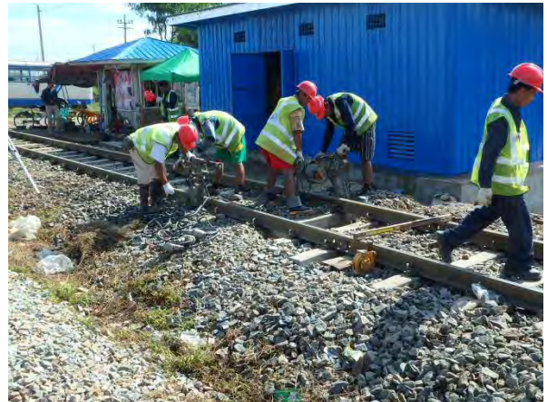
下り線踏切脇むら直し
