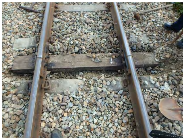
継目マクラギ位置整正
