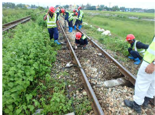
マクラギ位置整正
