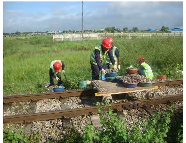
道床整理の状況
