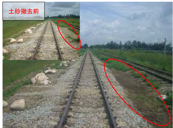
線間の土砂撤去後
