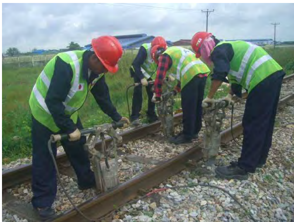
タイタンバーによるつき固め
