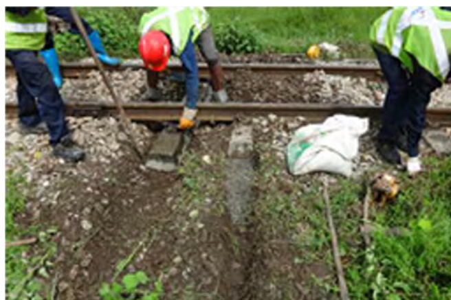
マクラギ下水抜き状況
