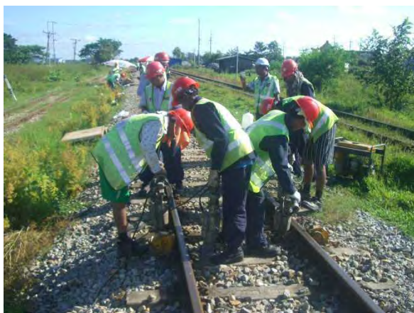
タイタンバーによるつき固め
