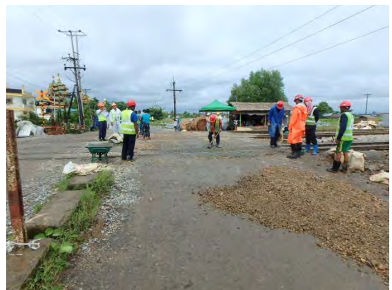
勾配摺り付け作業(土砂散布)
