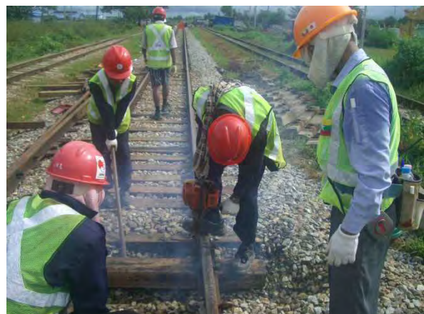
木マクラギの削孔
