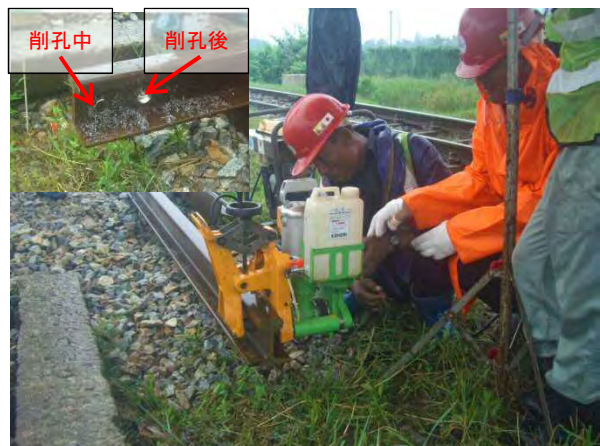
レール継目ボルトの削孔
