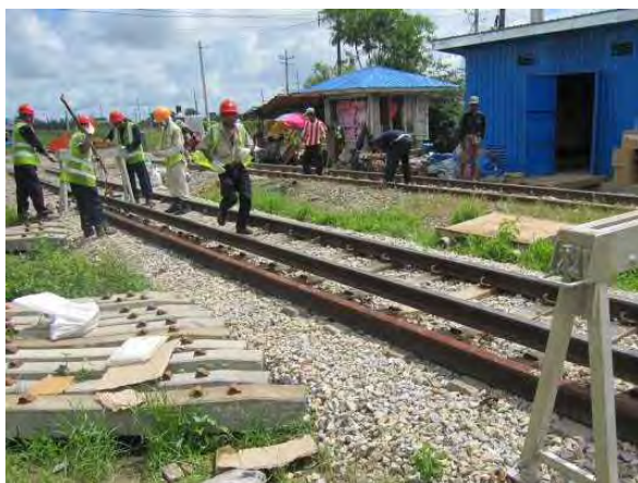
短尺レール解消レール交換
