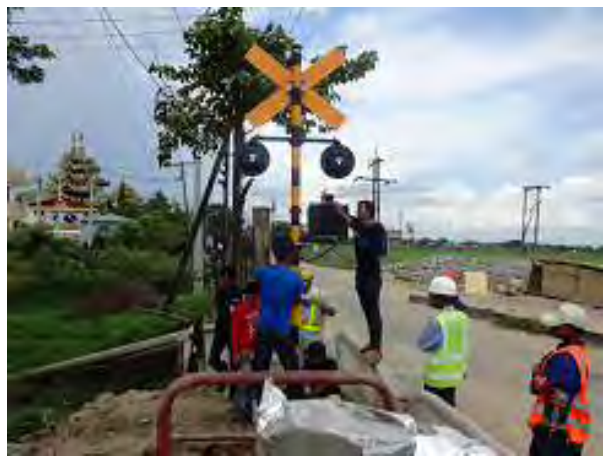
警報機の設置
