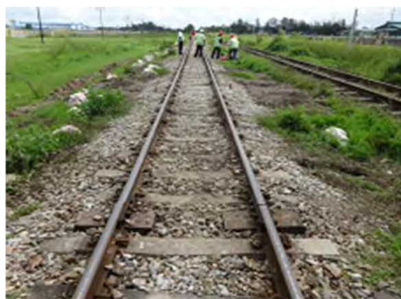
作業終了後の状況
