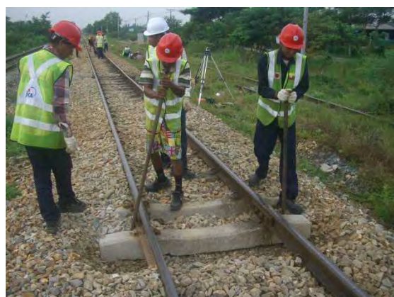
PCマクラギ位置整正
