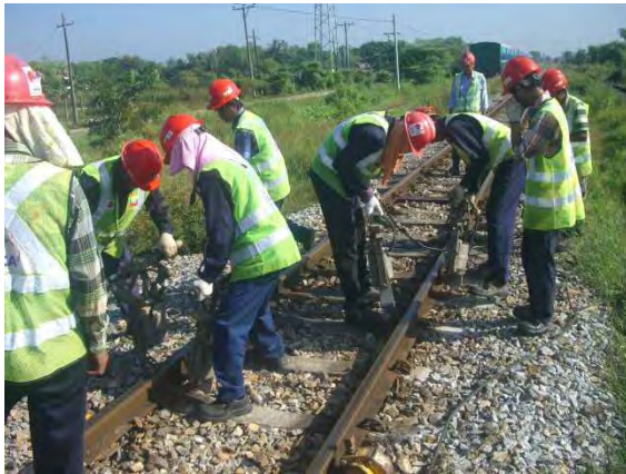
タイタンパーによるつき固め
