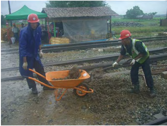
勾配摺り付け作業 線間の土砂運搬
