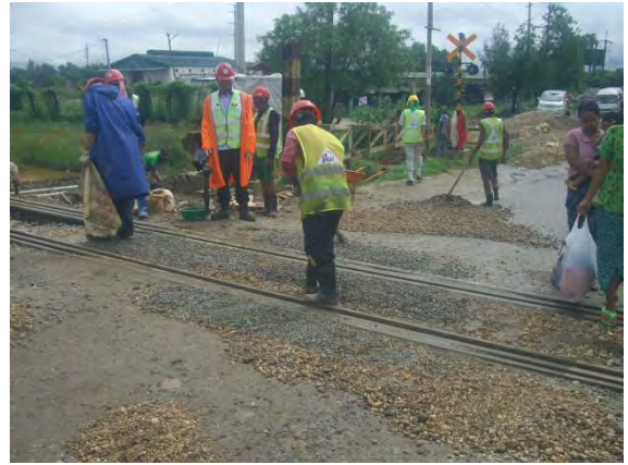
水溜り箇所への砕石散布
