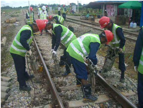
タイタンバーによるつき固め
