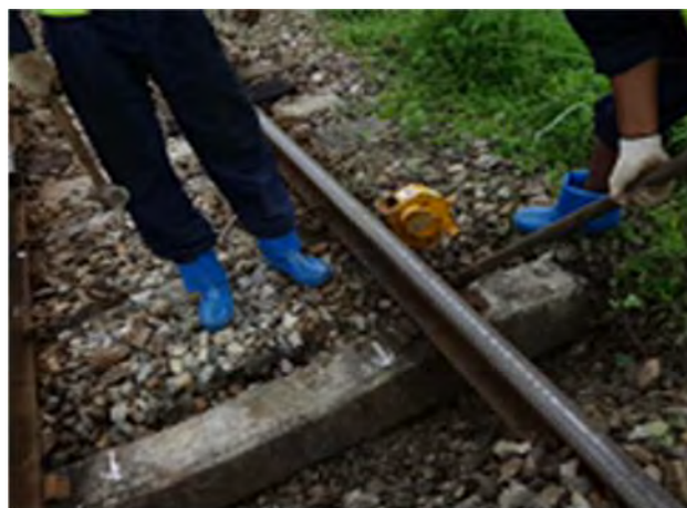
PCマクラギ位置整正
