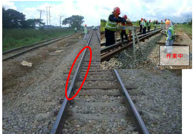
分岐トングレール撤去後
