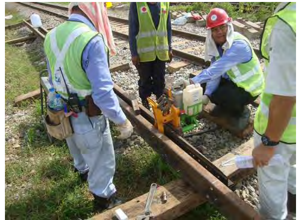
トングレール穿孔
