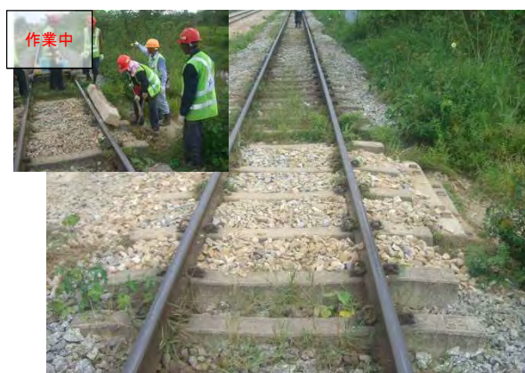
踏切道整備 (下り線)
