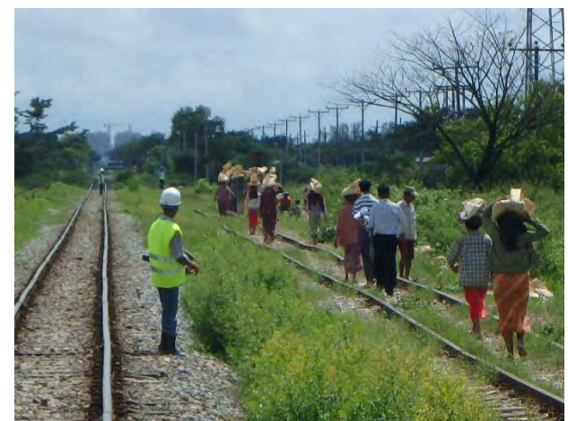
信号ケーブル敷設の為碎石運び
