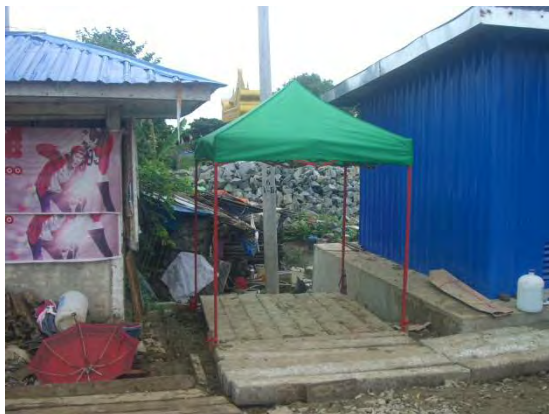
テント設営完了①
