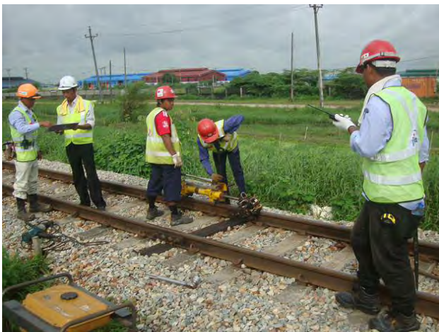
遊間調整の状況
