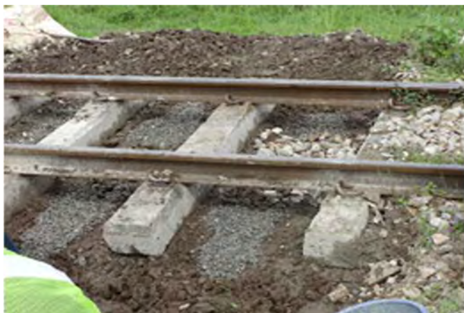
噴泥区間排水対策(まくらぎ間水抜き)
