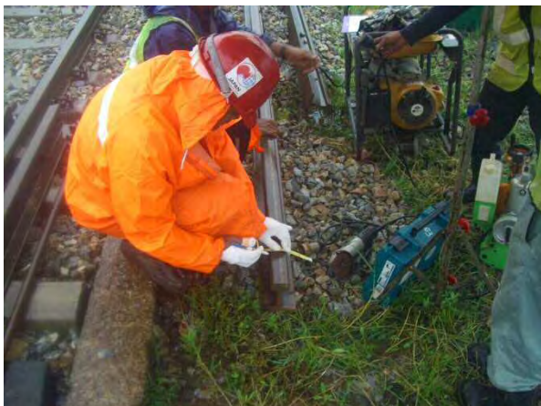
レール継目ボルトの墨出し
