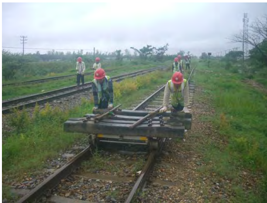
テント設営用土台 (PC マクラギ) 運搬
