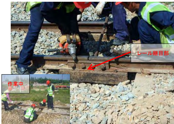
レール継目部 木マクラギ挿入後
