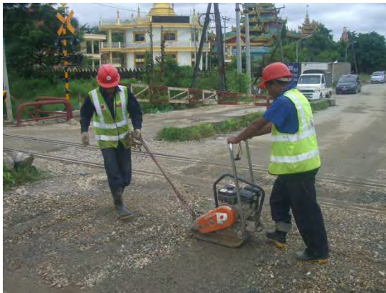
振動コンパクターによる締め
