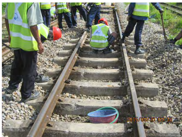
PCマクラギ撤去
