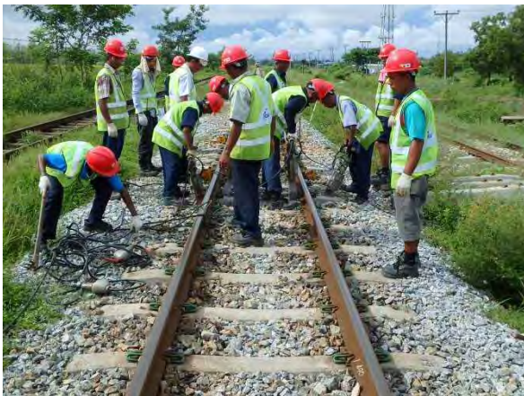
タイタンバーによるつき固め
