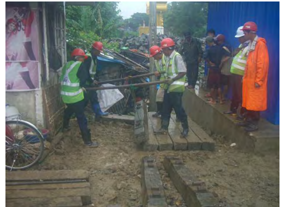
テント設営用土台 (PC マクラギ) 設置
