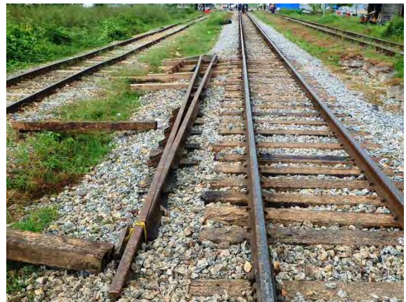
分岐トングレール部全景 (バゴーフ方)
