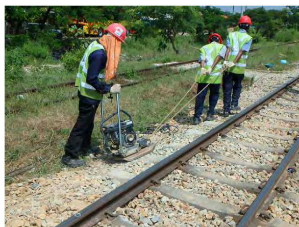
道床肩締固め
