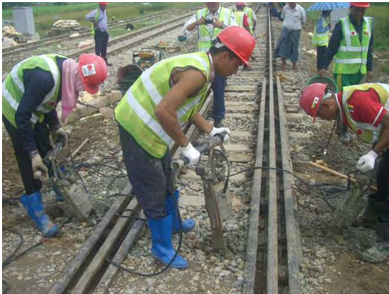
タイタンバーによるつき固め
