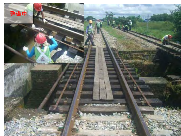
橋マクラギ整備完了(上り線)
