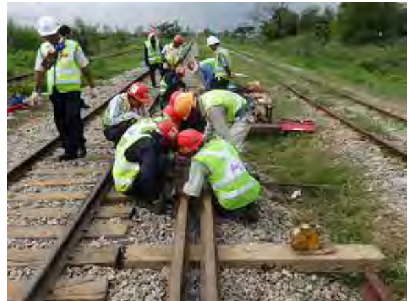
分岐ロングレール部仮組
