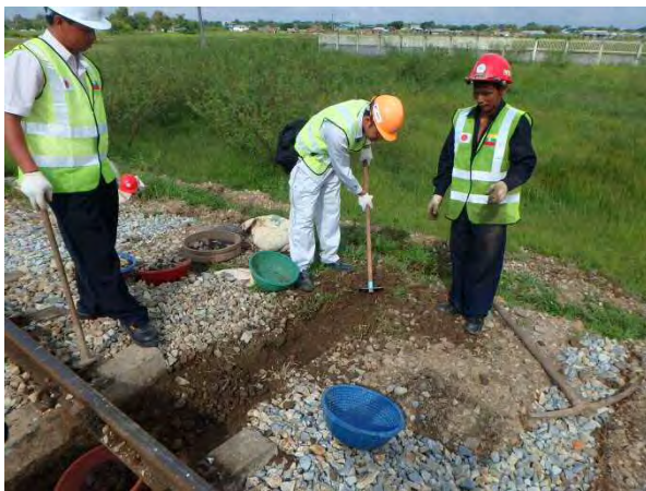
噴泥対策用排水溝掘削
