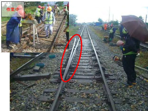
分岐トングレール部設置
