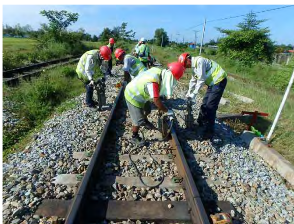
タイタンパーによるつき固め
