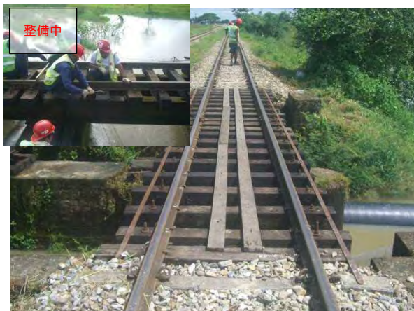
橋マクラギ整備完了(下り線)
