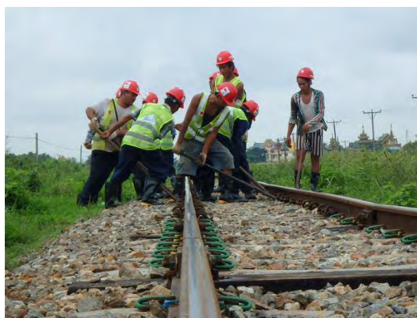
50Nレール交換区間通り直し
