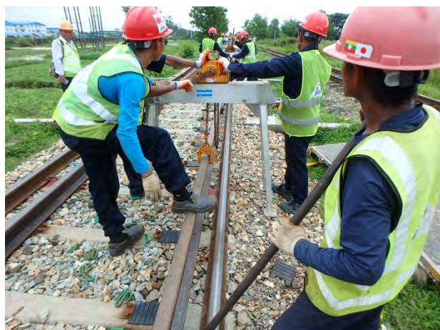
始点外軌側に 50N レールを挿入
