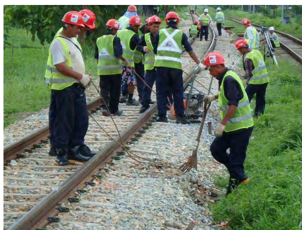
バラストかき上げ、締固め
