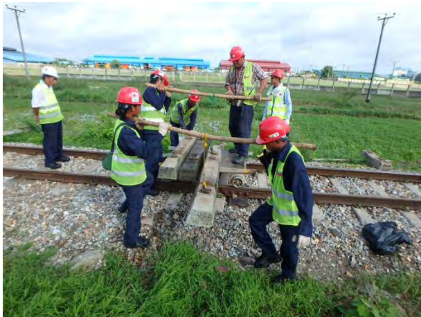
PCマクラギトrolleyに積み込み
