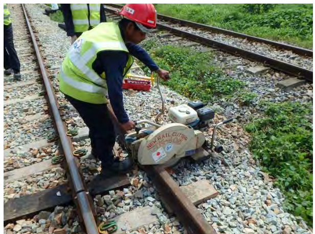
継目調整レール穿孔
