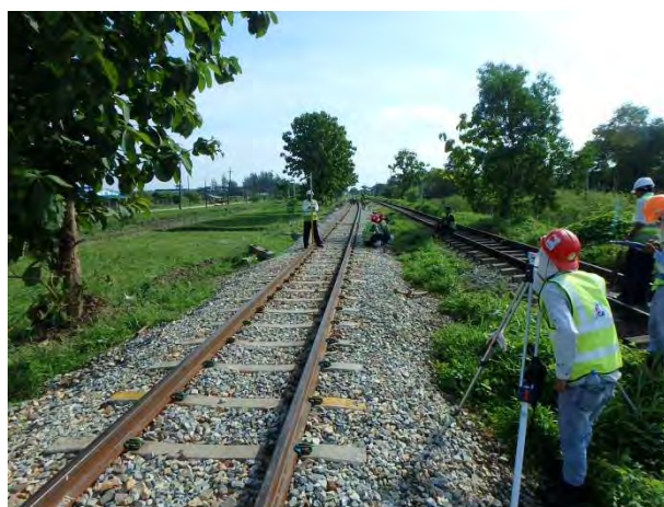
50N レール交換区間のレベル測量
