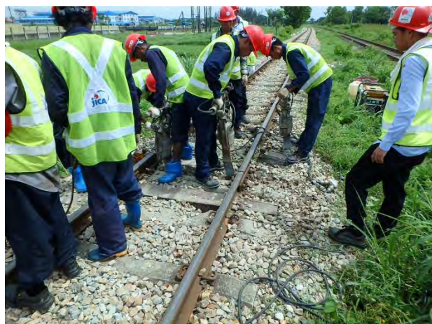
上り線 15k320m 付近むら直し
