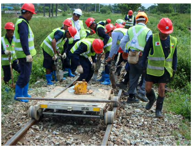
上り線 15k320m 挿入したマクラギのつき固め
