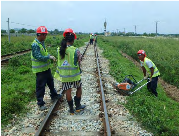
道床肩部の締固め
