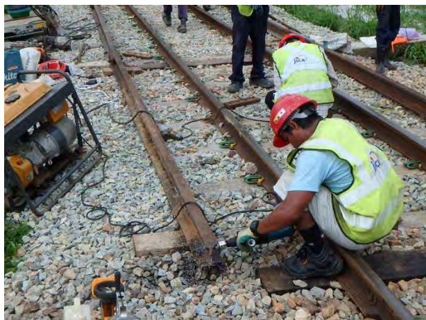
継目調整レール穿孔部の面取り
