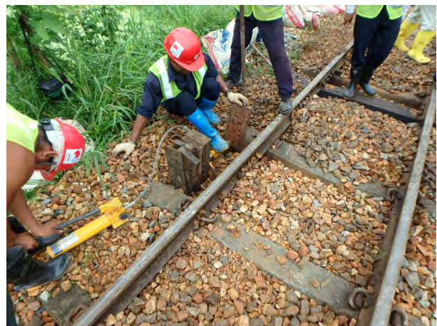
PCマクラギ位置整正
