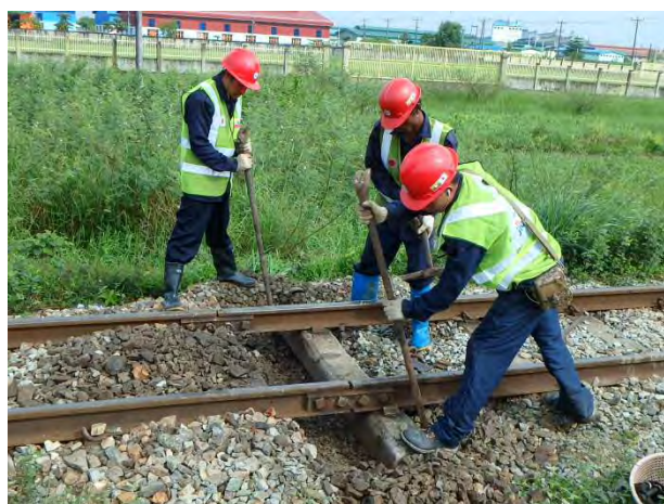
PCマクラギ位置整正
