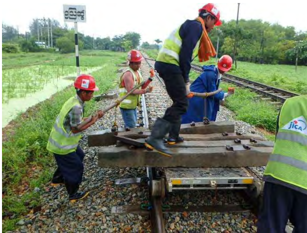
PC マクラギ積み込み
