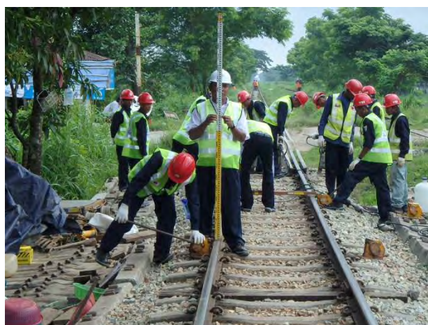
レベルで確認してレール扛上
