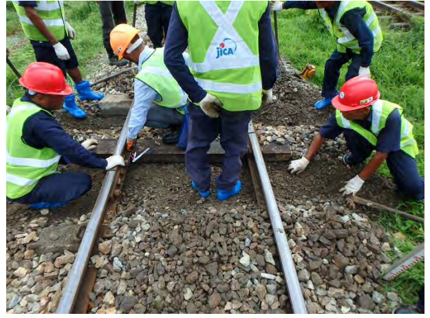
PC マクラギ挿入
