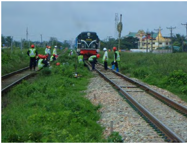
列車を停めて PC マクラギ位置修正
