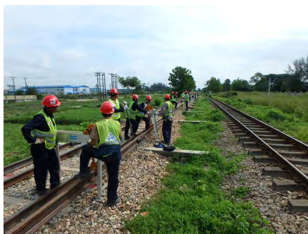
ヤンゴン方外軌レール移動
