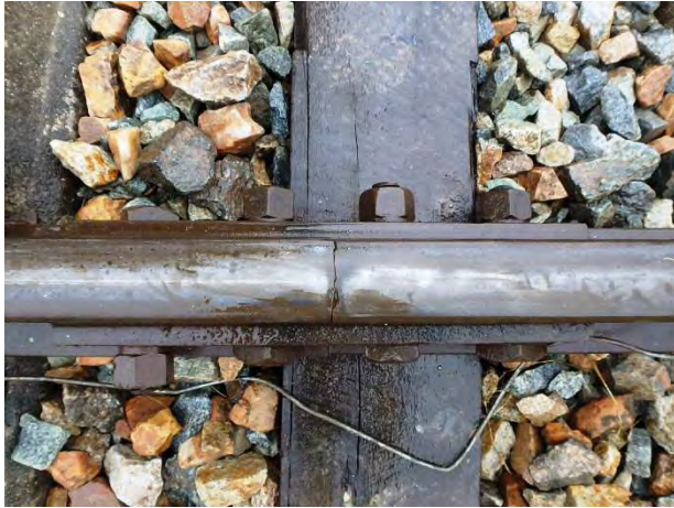
遊間調整前（レールにクラックが入っています）
