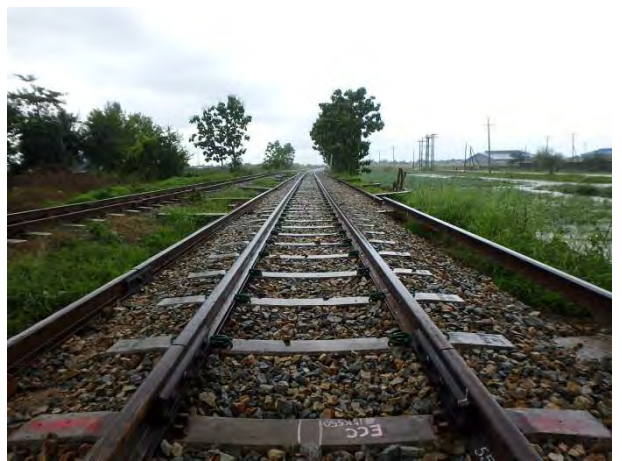
レール交換後(15k550m ヤンゴン方)
