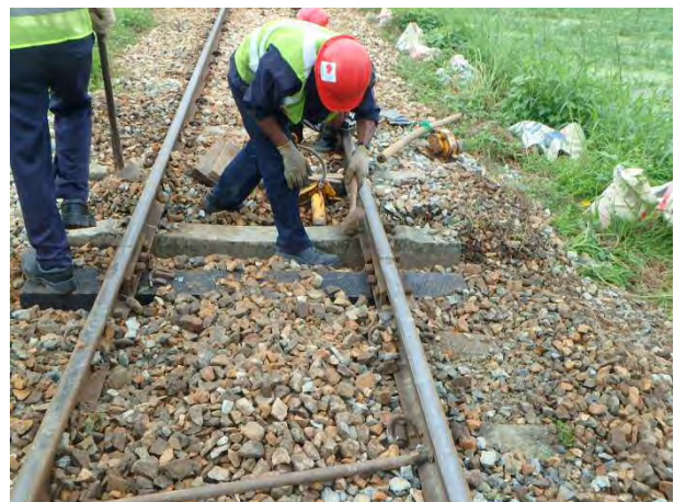
PCマクラギ位置整正
