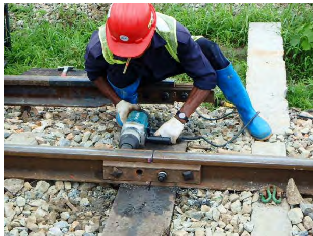
本線レール切断後継目板で締結
