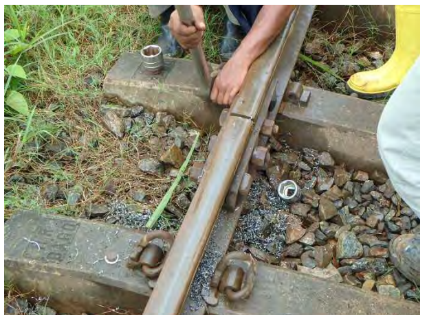
下り線 15k730m 継目部穿孔して締結（2孔）
