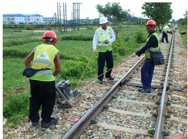
コンパクターで道床肩部を締固め
