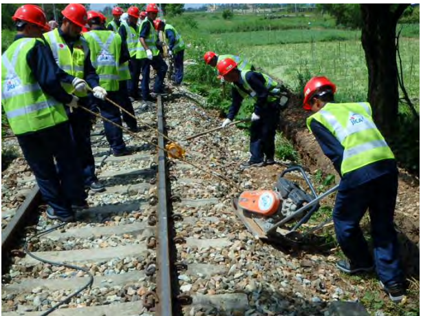
コンパクターでバラストの締固め
