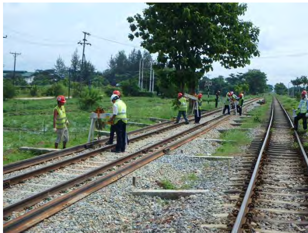
バゴーフ方外軌から内軌への山越器移動
