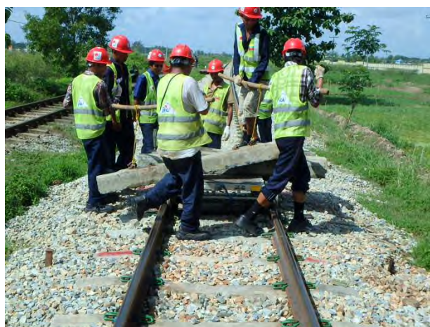
PC マクラギトロリーに積み込み
