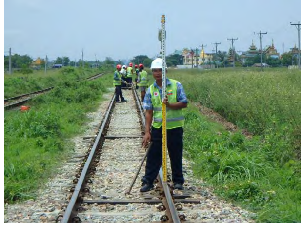
施工後のレベル検測
