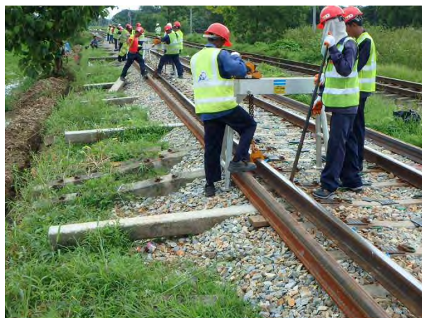
始点方内軌側 37k レールの撤去
