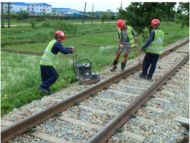
コンパクターで締固め
