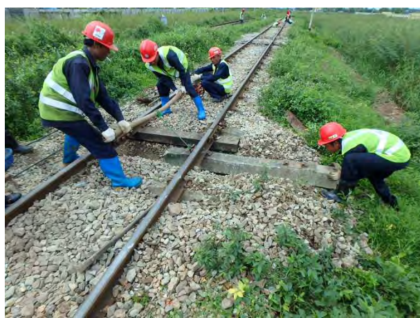
PCマクラギ挿入
