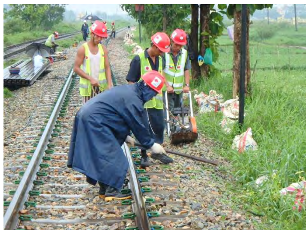
バラストかき上げ、締固め
