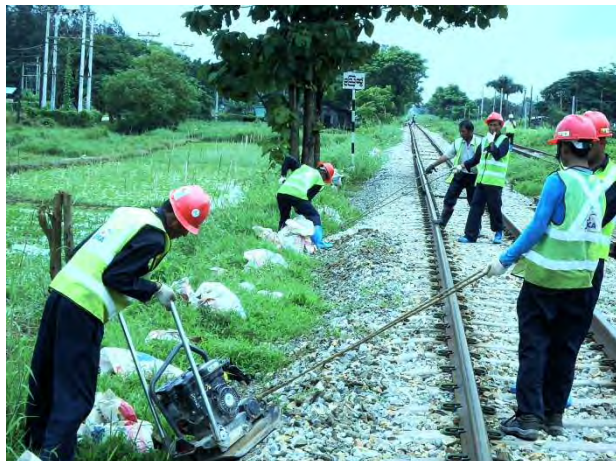
バラストかき上げと肩部整正
