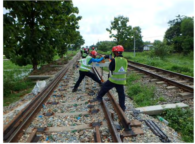
終点方外軌側へ50Nレールを挿入
