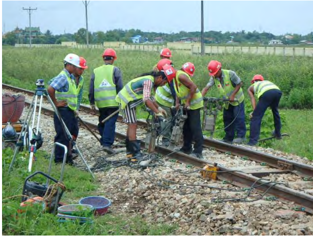
盤下げ部分のつき固め (15k375m)
