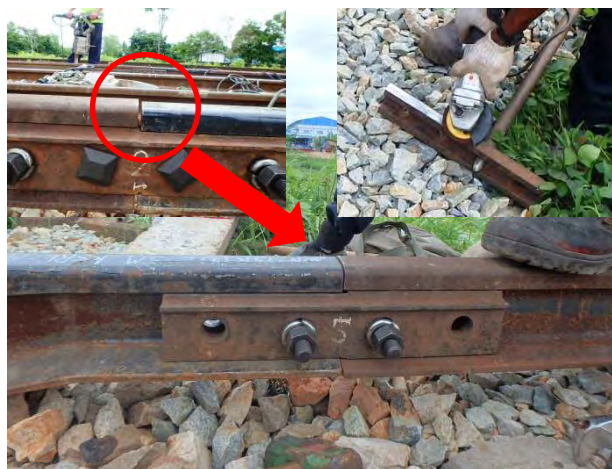
継目板加工によるレールギャップの補正
