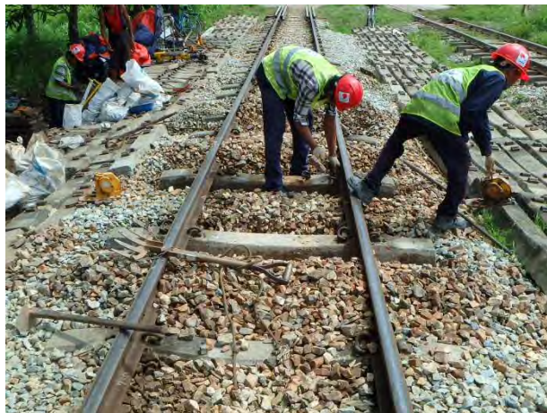
PCマクラギ挿入
