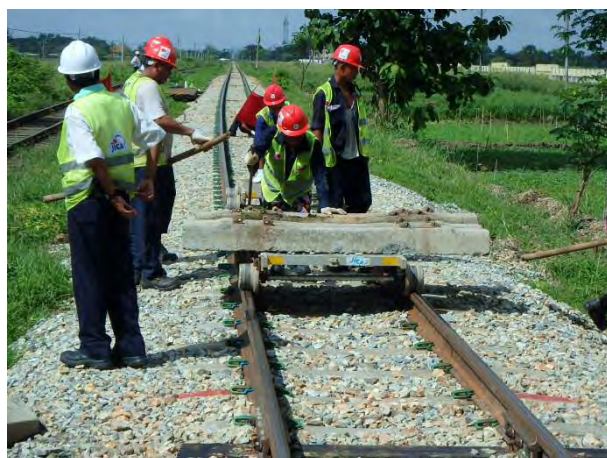
PC マクラギ運搬
