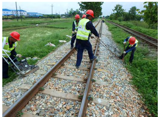
バラストかき上げと道床肩締固め
