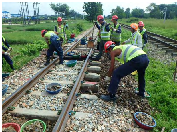
一部盤下げでバラスト撤去 (15k375m)
