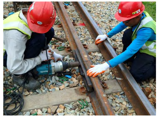
50Nレール中間部継目板の締結
