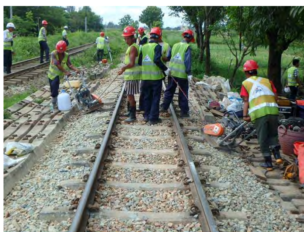
道床部の締固め
