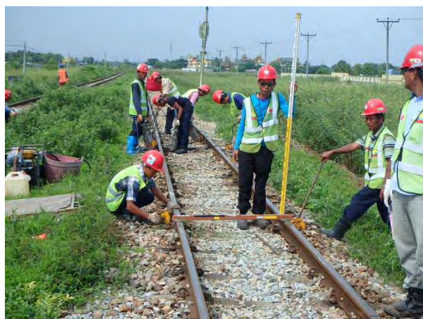
レベルで確認してレール扛上
