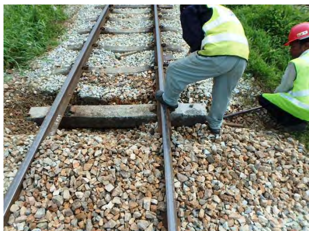
PCマクラギの交換
