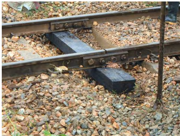
継目木マクラギ挿入
