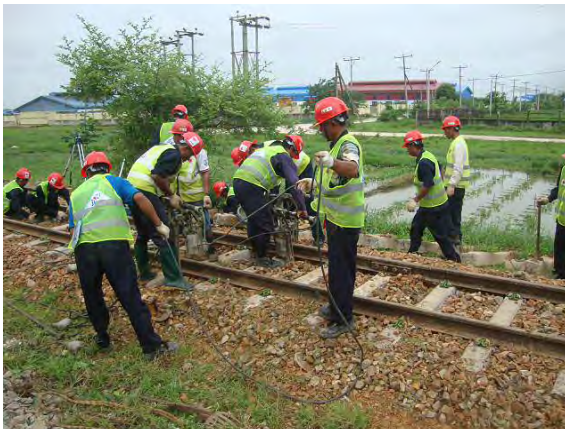
突き固めの状況
