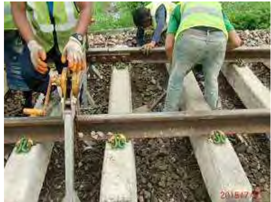
マクラギ下の人力による掻き出し
