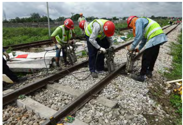
タイタンパー突き固め
