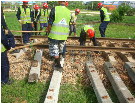
マクラギ交換作業の状況
