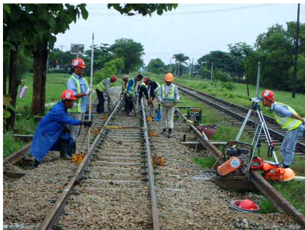
レベル測量で扛上量を測定
