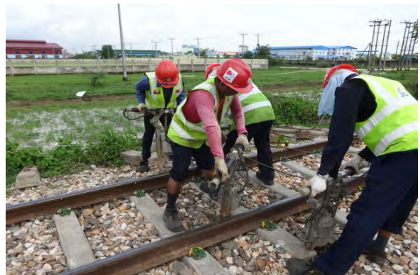
タイタンパー突き固め
