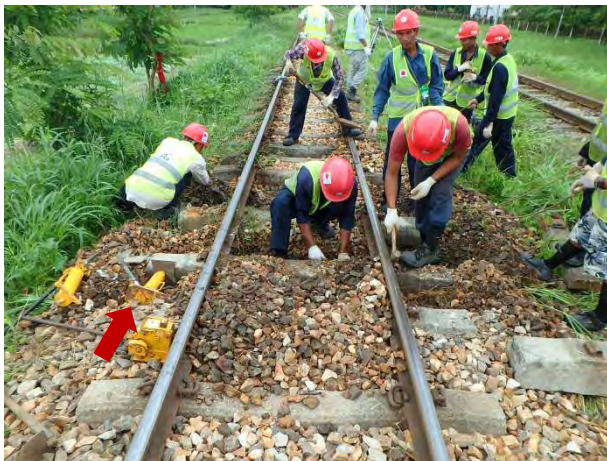
通り 整正器 を使ってマクラギ位置整正
