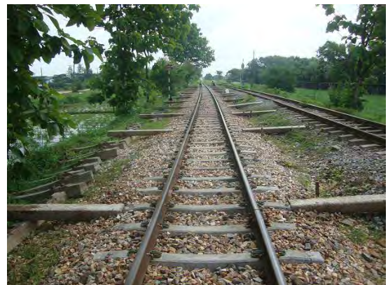
仮受け台設置後
