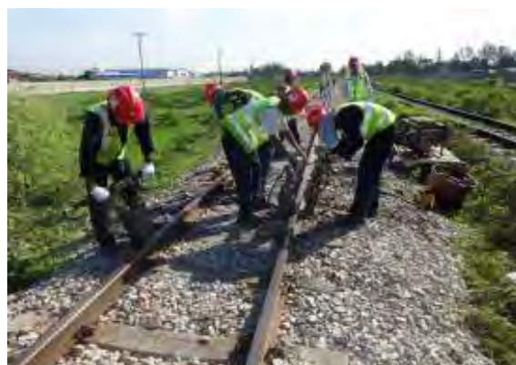
TT 突き固め
