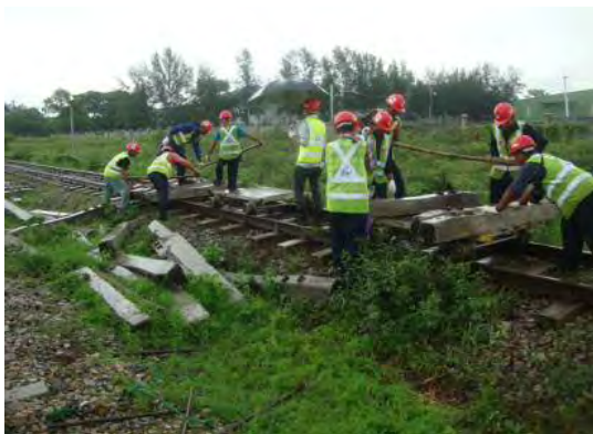
マクラギ積み込み
