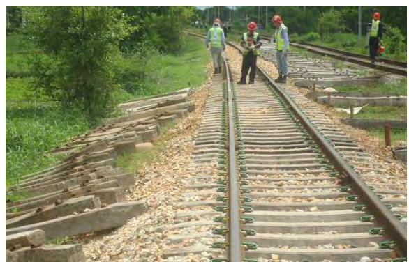
施工後の状況
