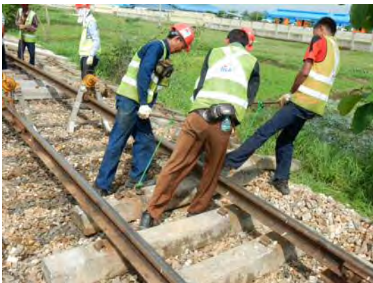
PCマクラギ交換作業
