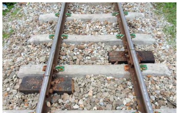
短マクラギの挿入
