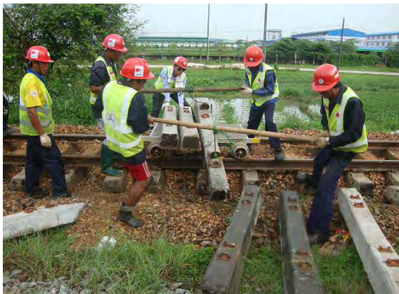
マクラギ取卸しの状況
