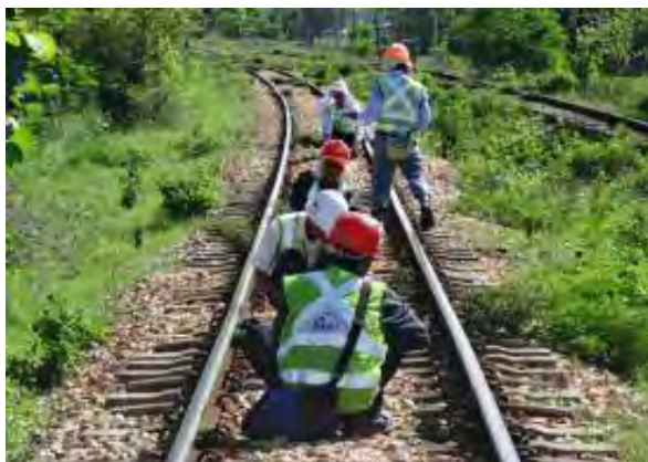
曲線部における正矢量の確認
