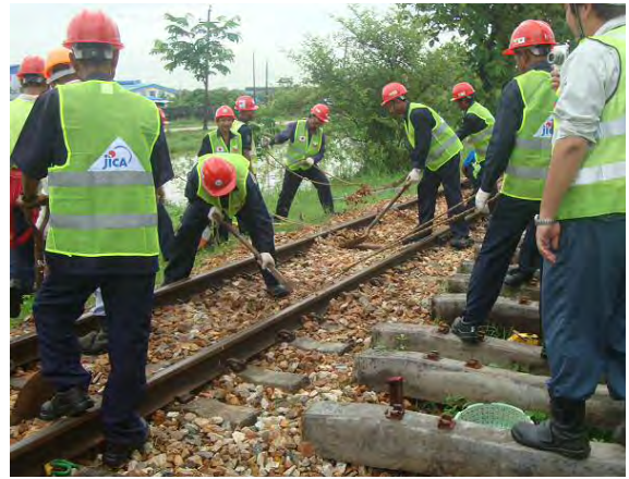
バラスト掻き出し作業
