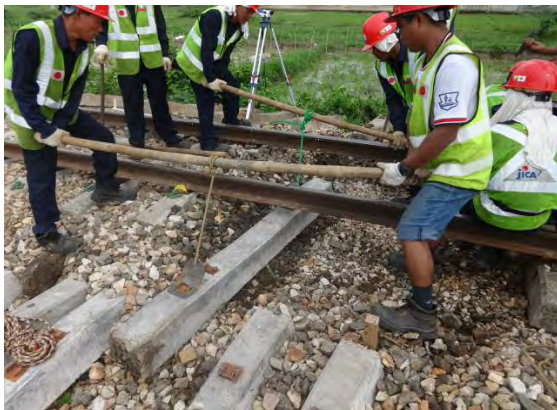
PCマクラギ交換作業
