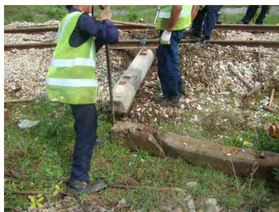
折れた PC マクラギの交換
