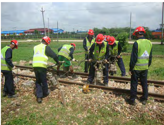
突き固めの状況
