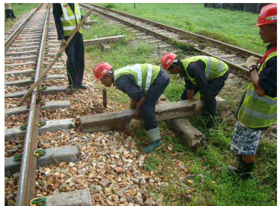
レール仮受け台の設置
