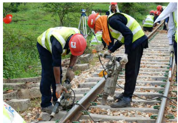
タイタンパー突き固め
