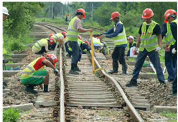
マクラギ下の掻き出し
