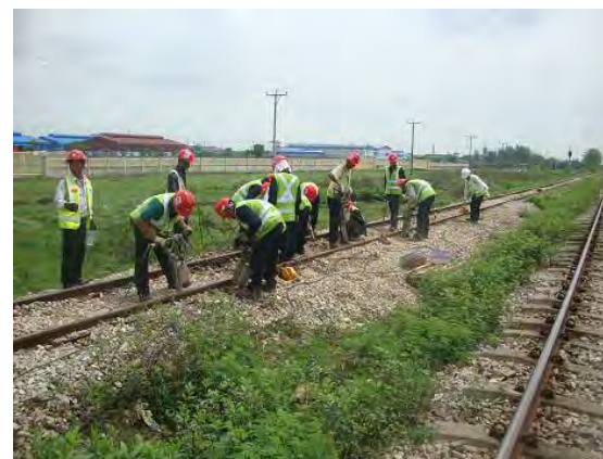
突き固めの状況
