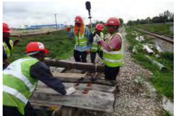
PCマクラギ運搬
