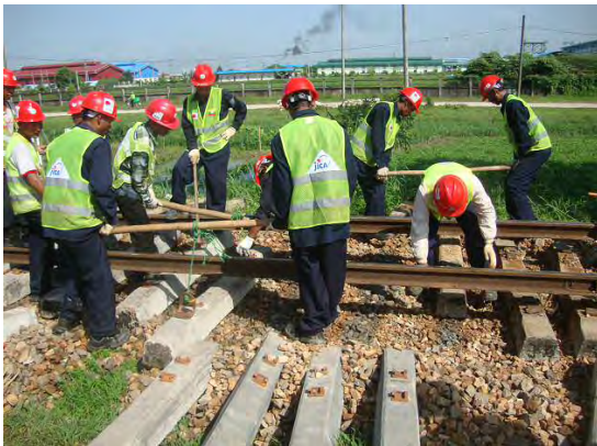
マクラギ交換作業の状況
