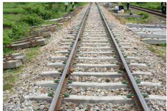
施工後の状況
