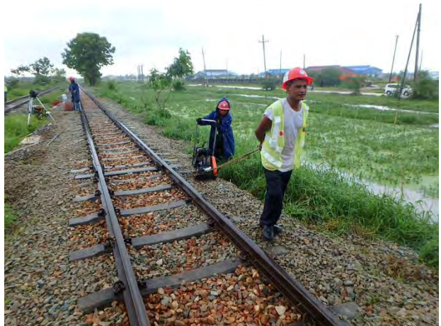
雨の中コンパクターで道床肩部締固め
