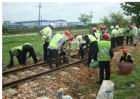
突き固め作業
