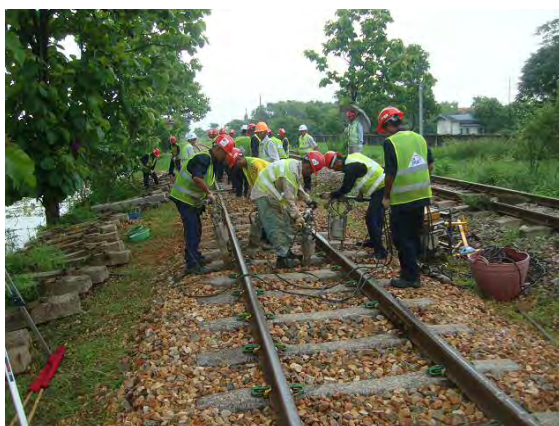
突き固めの状況
