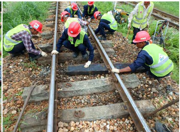
継目マクラギ挿入
