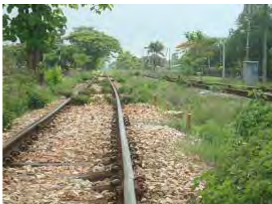
曲線部の軌道の状況
