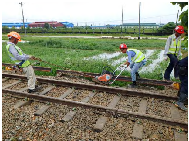
コンパクターで道床肩部を締固め
