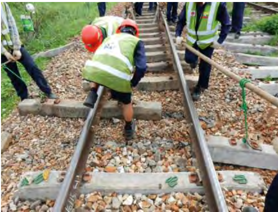
PCマクラギ交換作業
