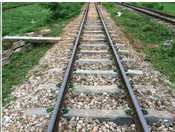
交換したPCマクラギ
