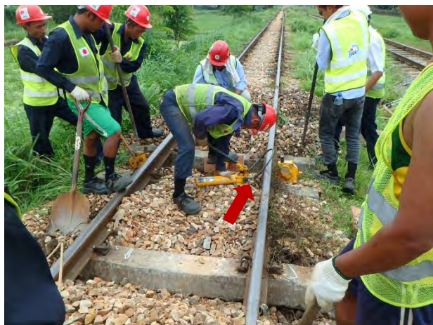
通り整正器を使ってマクラギ位置修正
