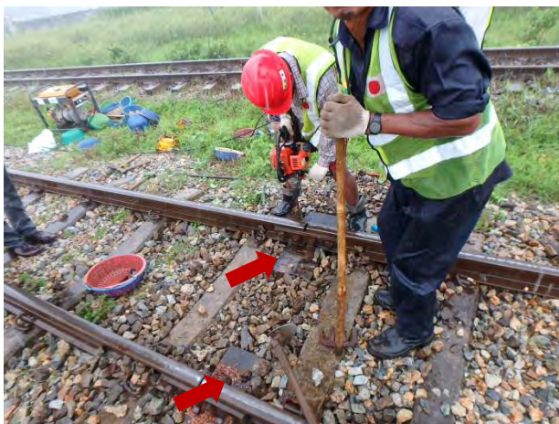
継目短マクラギ挿入
