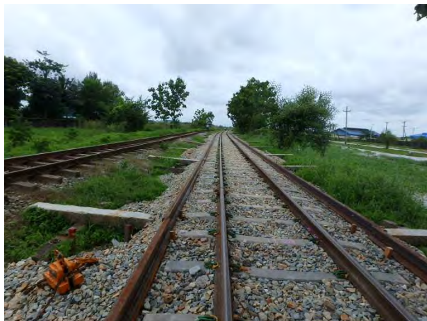
施工後 (15k560mからヤンゴン方)
