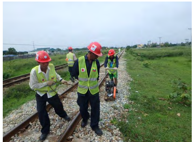
コンパクターで道床肩部締固め
