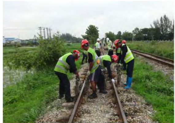
タイタンパーによる突き固め
