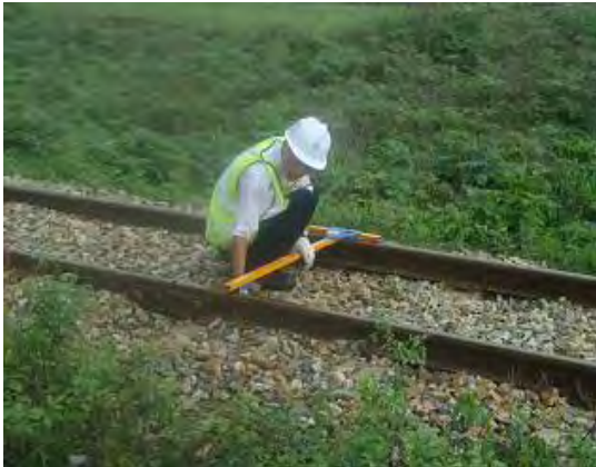
直角定規による位置出し
