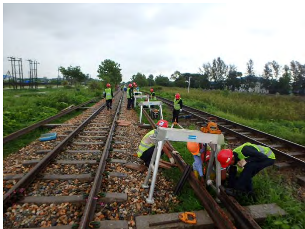
レール山越器の設置
