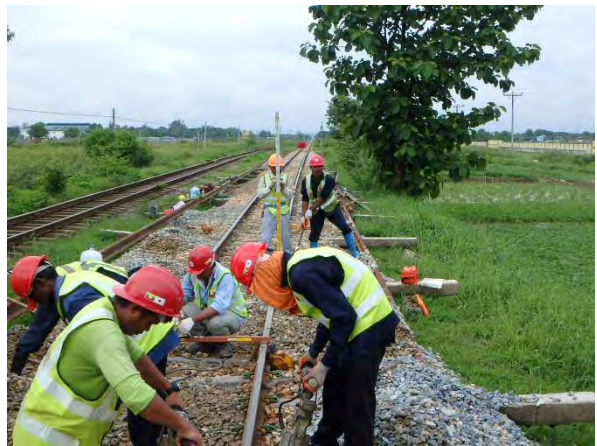
扛上量を決めながらつき固め
