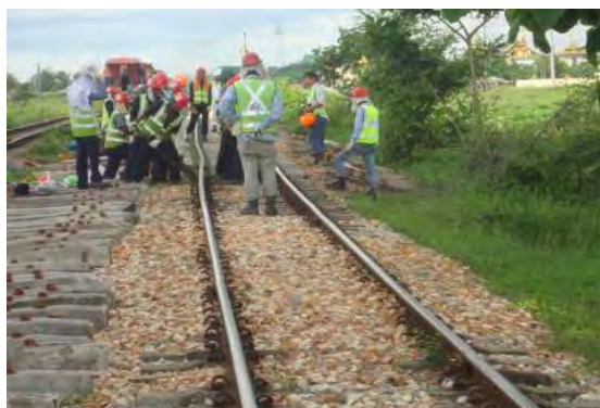
緩和曲線軌道整正
