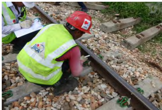
仕上がり確認
