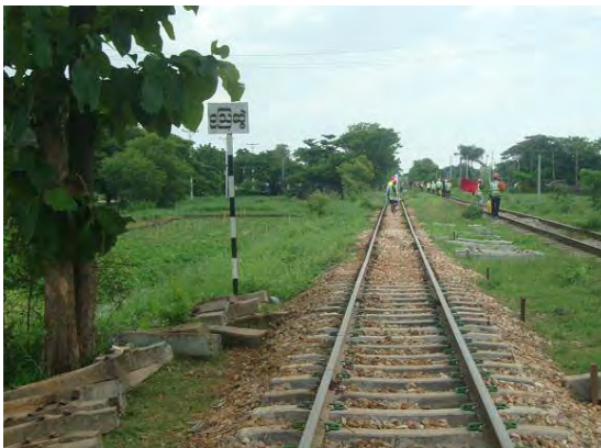
作業終了後の状況
