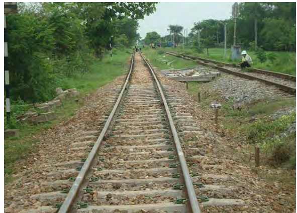
作業終了後の状況
