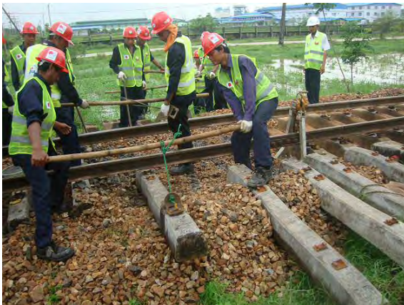
マクラギ交換作業
