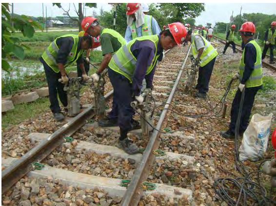
突き固めの状況
