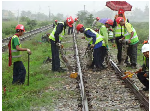
雨の中で継目部むら直し
