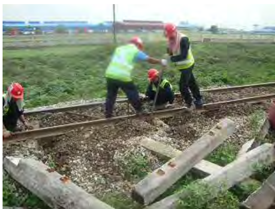
マクラギ位置整正
