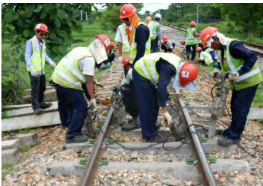
タイタンパー突き固め
