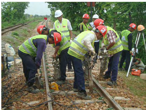
突き固めの状況
