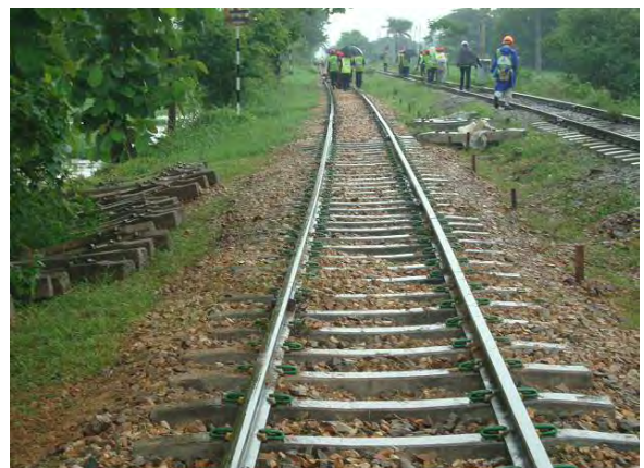
作業終了後の状況
