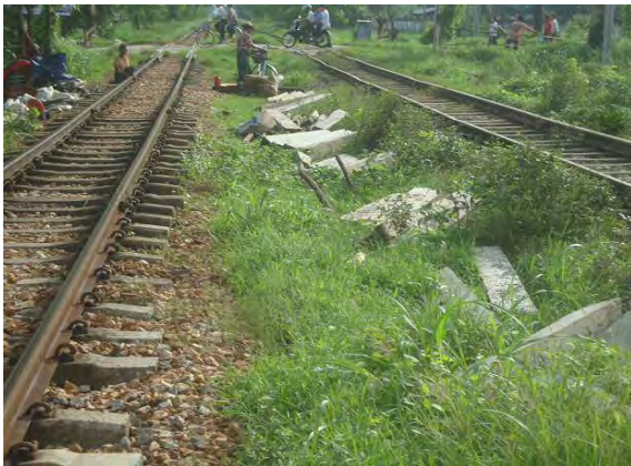
新たに搬入されたPCマクラギ
