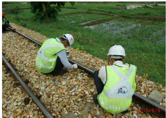
マクラギ配置間隔の印付
