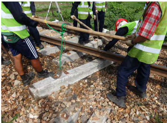
PCマクラギ交換作業
