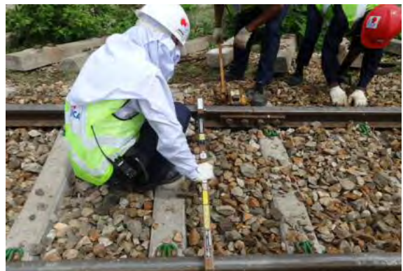
仕上がり確認
