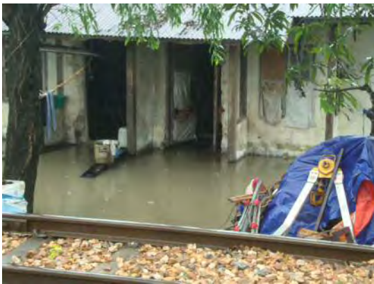
資機材倉庫は床上浸水
