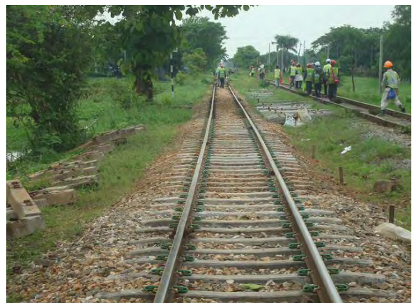
作業終了後の状況
