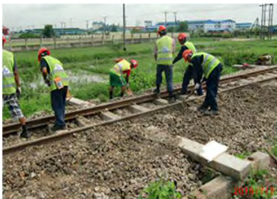
埋め戻しの状況
