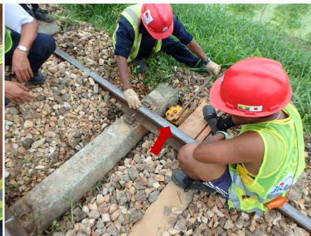
豆ジャッキを使ってマクラギ位置修正
