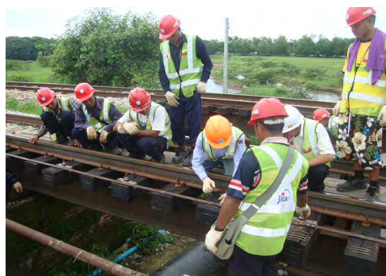
橋梁部フックボルトの指導
