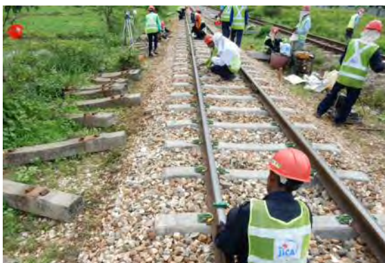
仕上がり確認
