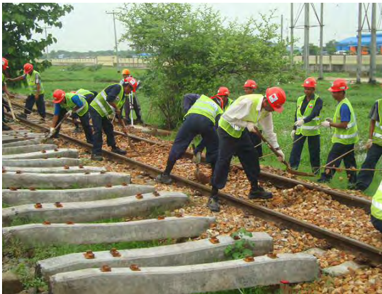
バラスト掻き出し作業
