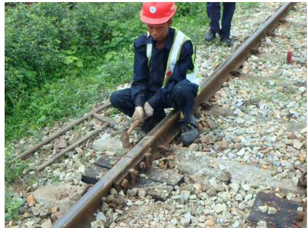
継目短マクラギ挿入 (イヌクギ打ち)
