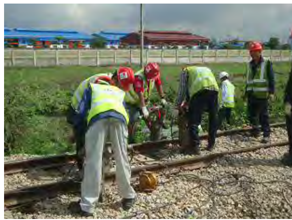
突き固めの状況
