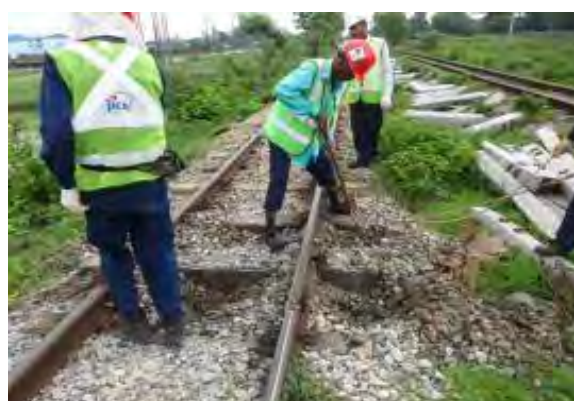
軌間内バラスト掻き出し作業
