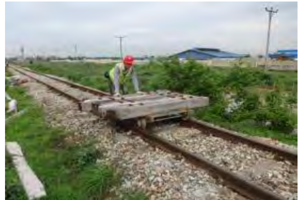
PCマクラギ運搬
