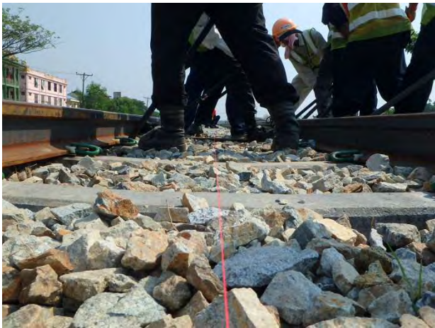
水系に合わせて通り整正
