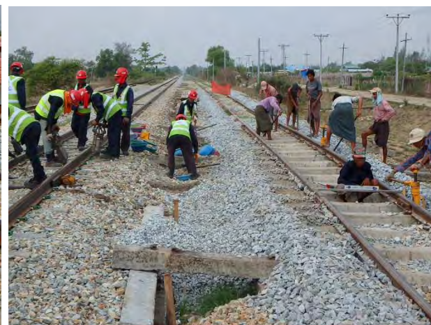
トラックジャッキで水準調整
