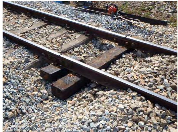
継目木マクラギ挿入
