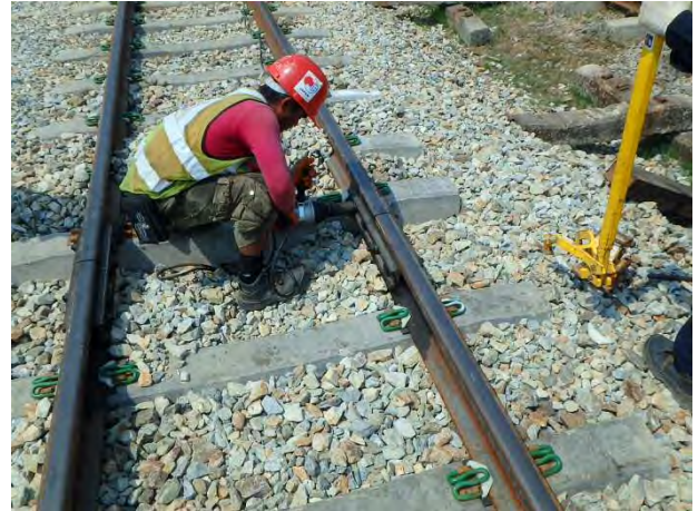
50N レール継目ボルト再緊張
