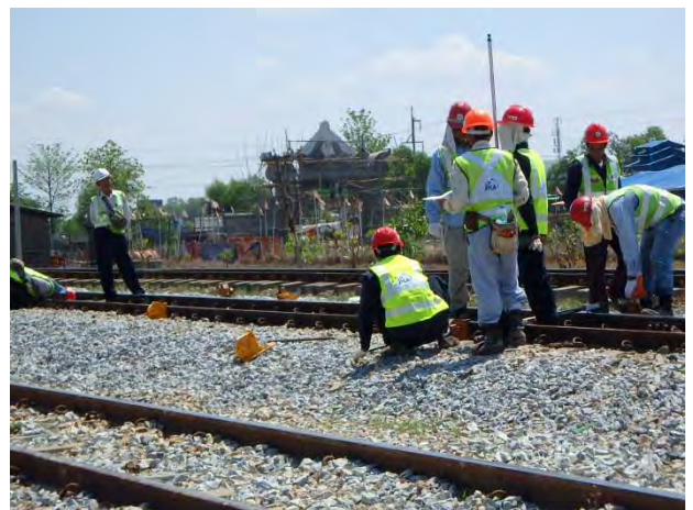
レベルで確認しながらレール扛上
