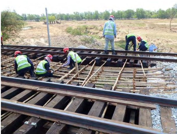
落下防護工撤去
