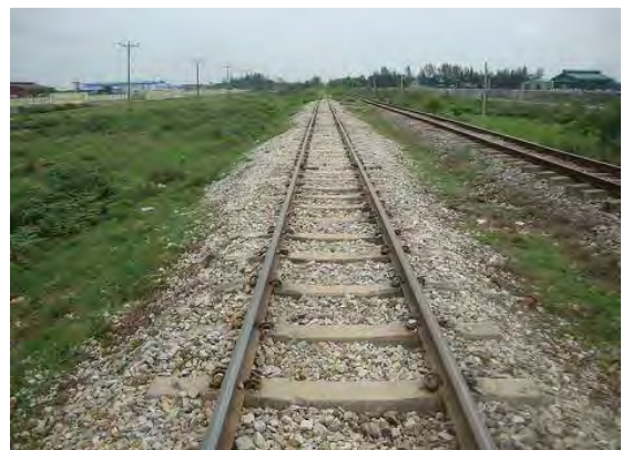
作業終了後の状況
