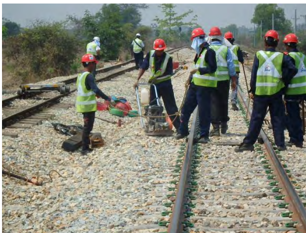
コンパクター締固め
