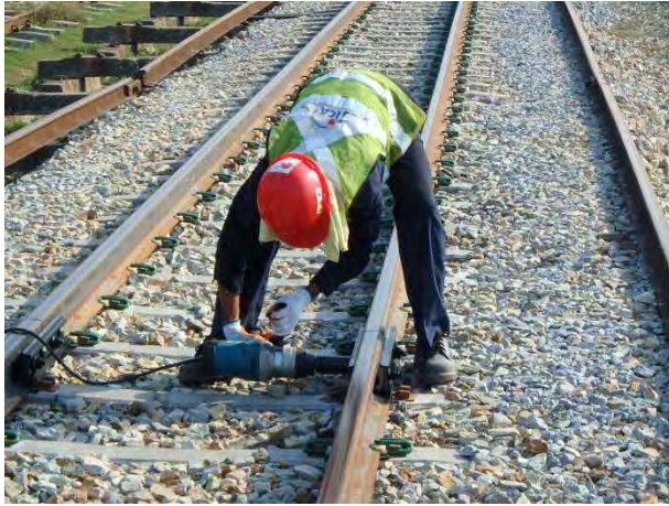
50N レール継目ボルトの再緊張 1
