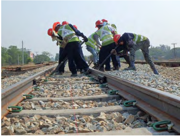
水系に合わせて通り整正
