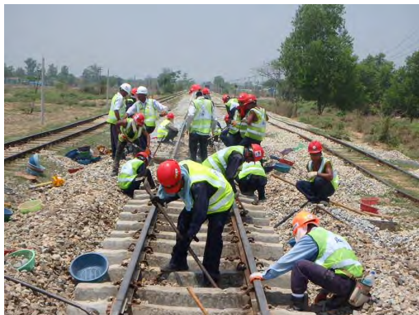
PCマクラギ位置整正
