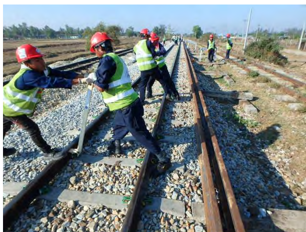
線路閉鎖前に徐行を掛け、半分の締結装置解除
