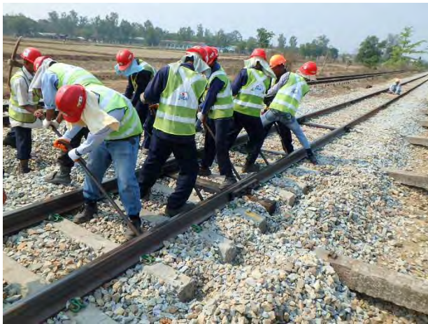
マクラギ肩を掘ってマクラギ移動
