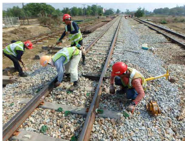
継目部木マクラギに交換
