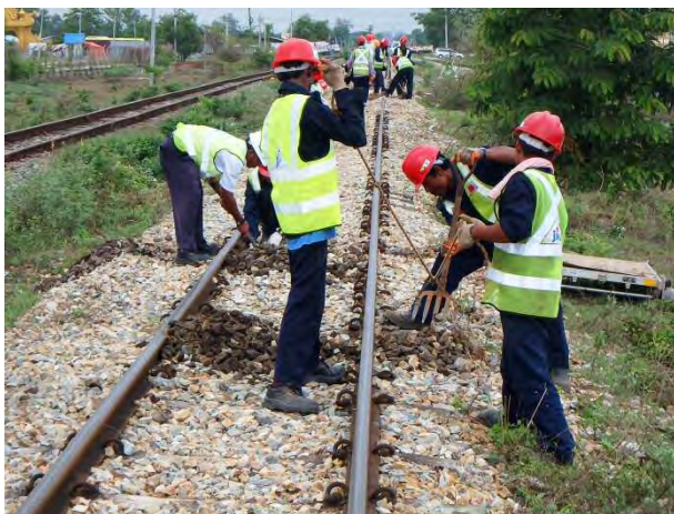
PCマクラギ位置整正の為バラストの掻き出し
