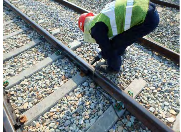
50N レール継目ボルトの再緊張 2
