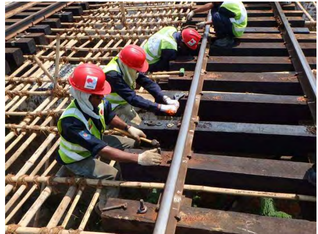
フックボルト取付け
