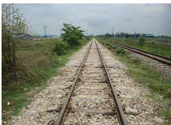
作業終了後の状況
