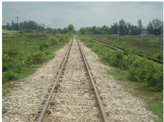
作業終了後の状況
