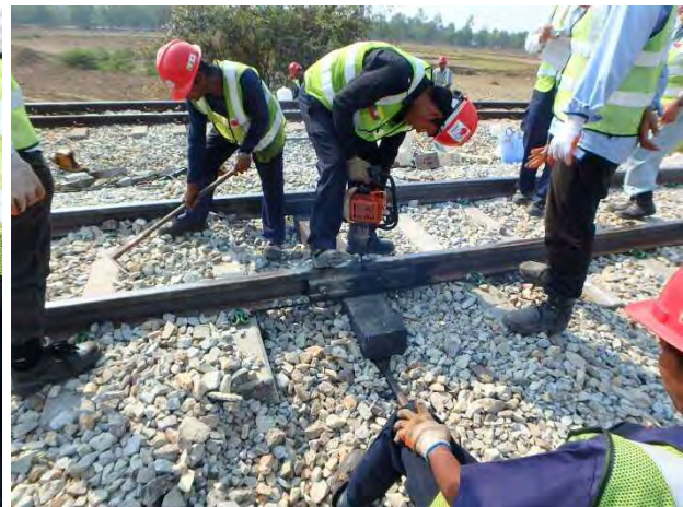
継目部に木マクラギを挿入・穿孔
