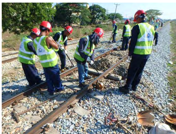
PCマクラギ位置修正
