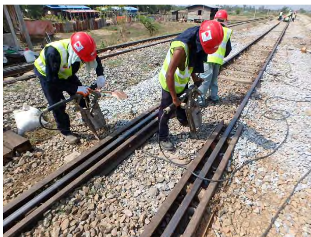
踏切部レール扛上
