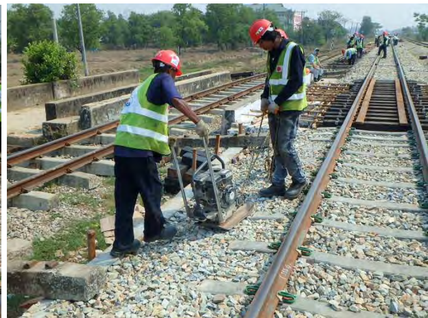
橋りょうアバット部締固め
