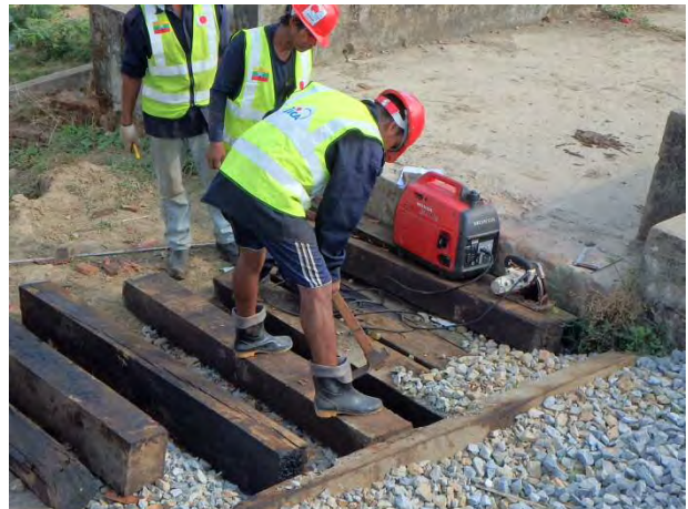
橋マクラギ加工
