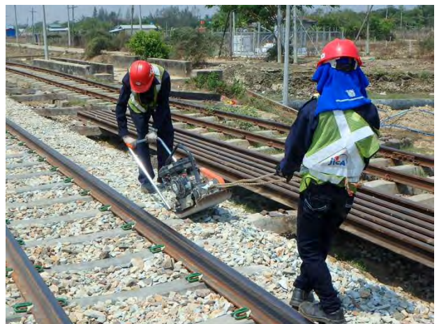
通り整正後コンパクターで締め
