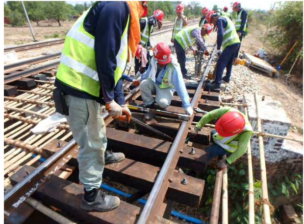
橋マクラギレベル調整アバット部むら直し
