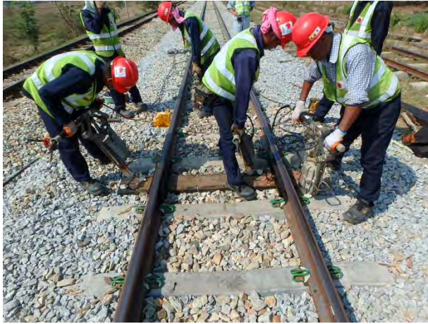
継目部木マクラギをつき固め
