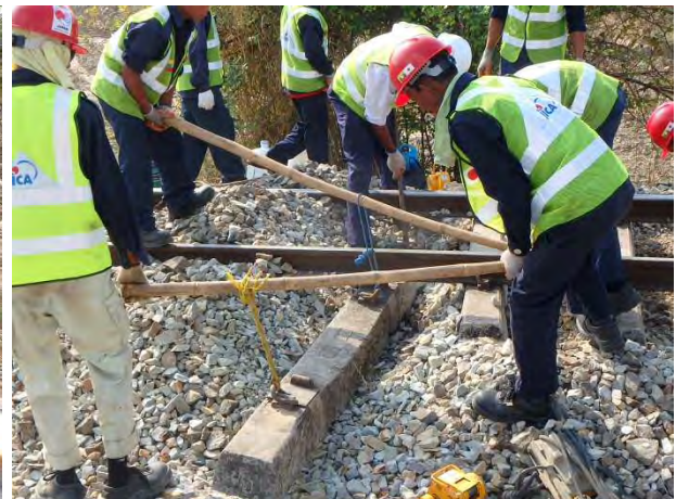
PCマクラギ挿入
