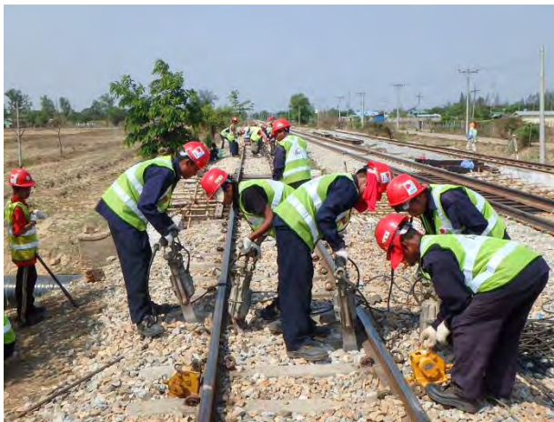
橋りょう前後部のつき固め
