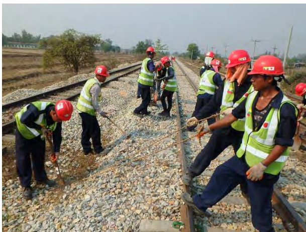
バラstkかき上げとコンパクター締固め
