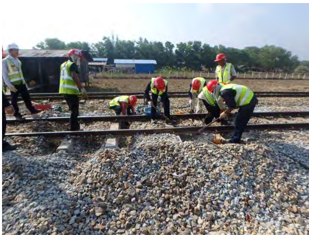
PCマクラギ位置修正
