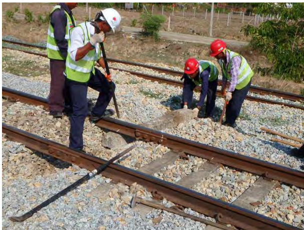
PCマクラギ挿入
