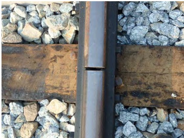
50N レール区間では遊間変化は見られない。
