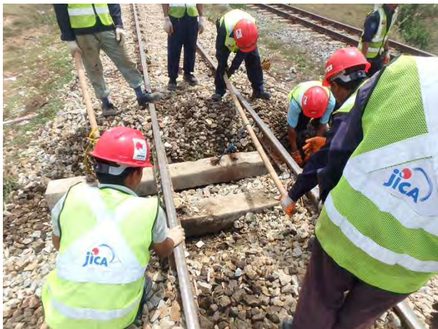
PCマクラギ挿入
