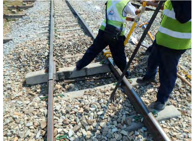
継目部 PC マクラギ移動後のクリップ締結
