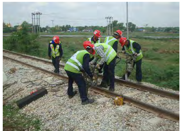
バラストの締固め
