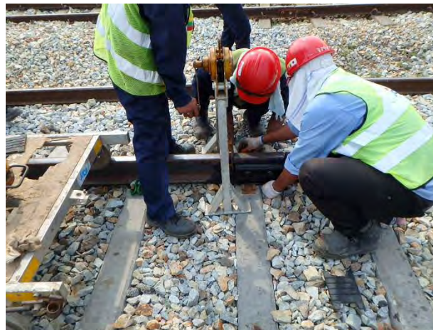
継目部のマット交換
