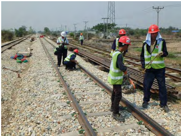
事後検測とコンパクター締固め
