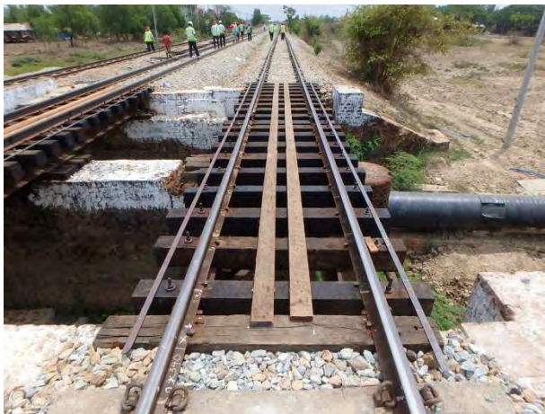
整備が終った下り線橋りょう(バギー方)
