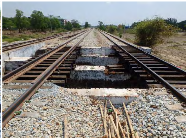
防護工撤去後の No16 橋りょう (バギー方)
