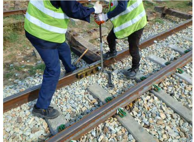
37k レール継目ボルトの解緊
