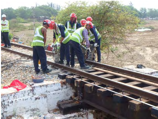
下り線橋りょうアバット部のむら直し
