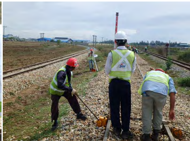
レベル測量でレールを扛上する
