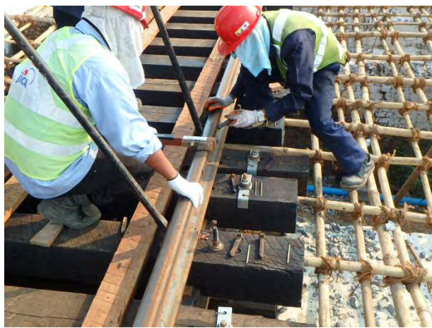
橋りょう部でイヌクギを抜いて軌間調整
