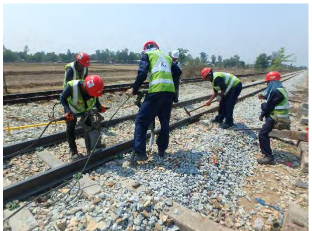
つき固めと継目部犬ギ打ち
