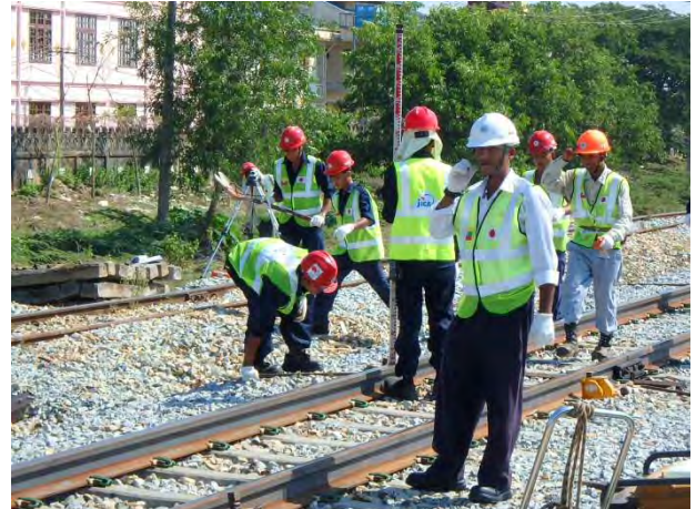
駅の信号所と連絡をしながら、レール扛上
