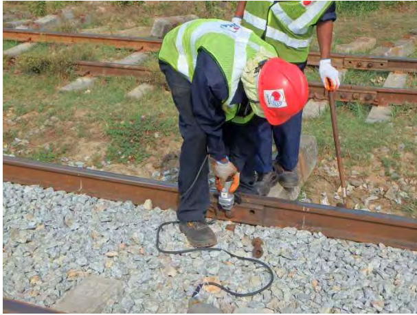
37k レール継目ボルトの切断
