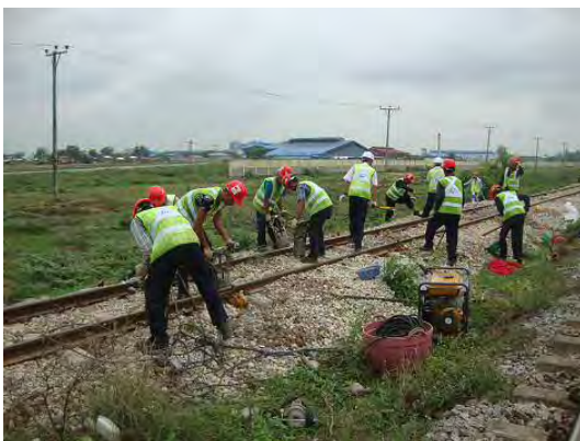
突き固めの状況
