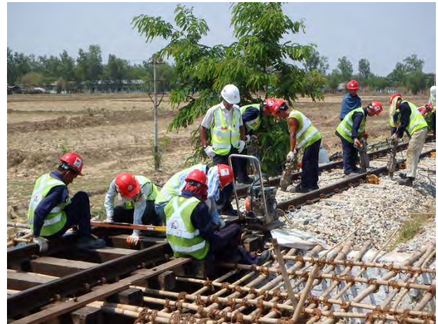
橋りょう部のむら直し
