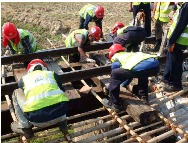
橋マクラギ撤去
