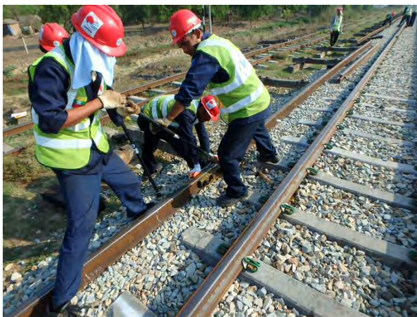
古37k レール継目部のボルト解緊
