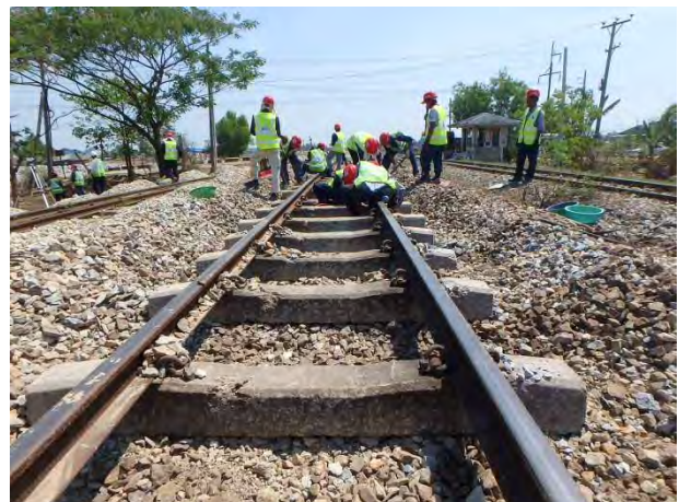
盤下げ後の状況
