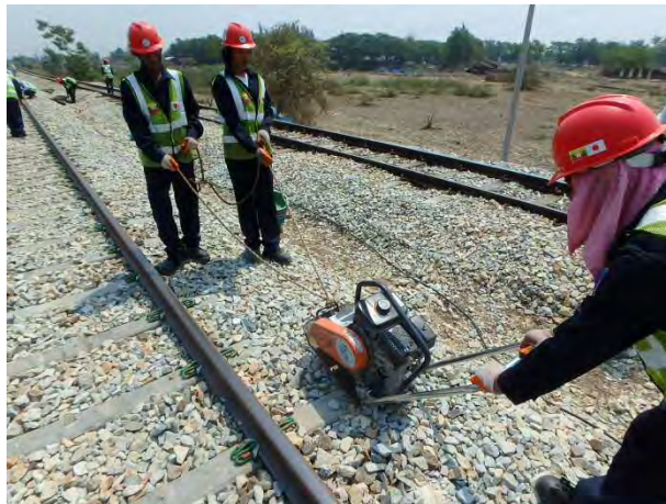
コンパクターでマクラギ肩部締め固め
