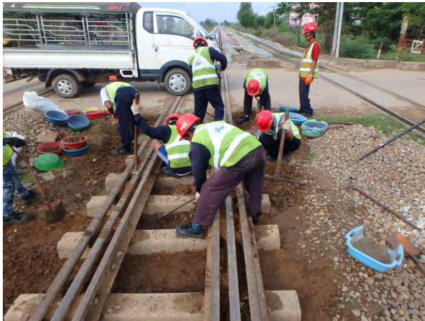
泥バラスト掻き出し
