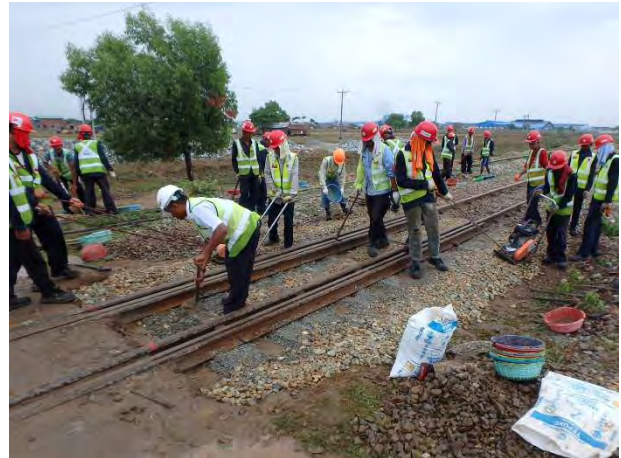
バラスト補充後、コンパクターで締固め
