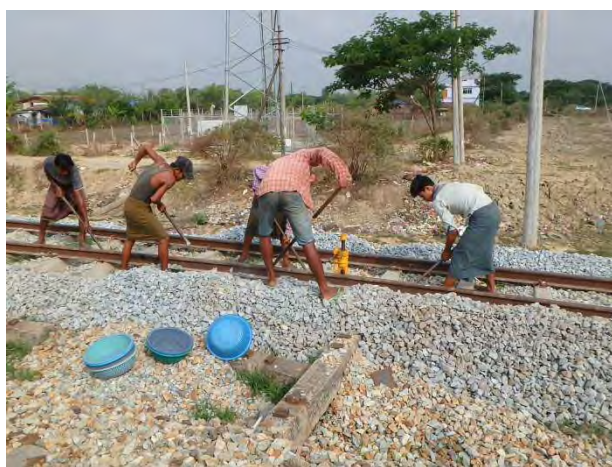
ダゴン大学線バールでつき固め
