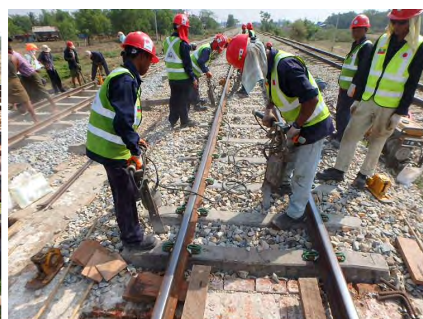
橋りょうアバット部つき固め
