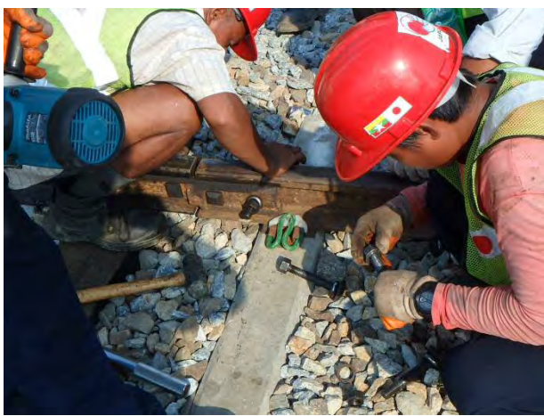
中継レールと37kレール継目の交換(終点方)
