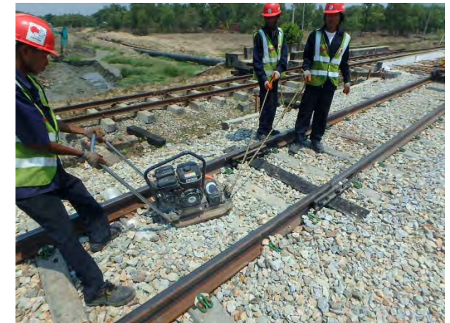
コンパクターで継目部のバラストを締め固め
