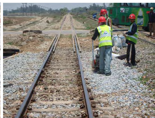
踏切部道床締固め
