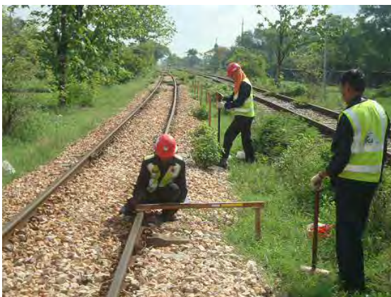
曲線部の基礎杭建植
