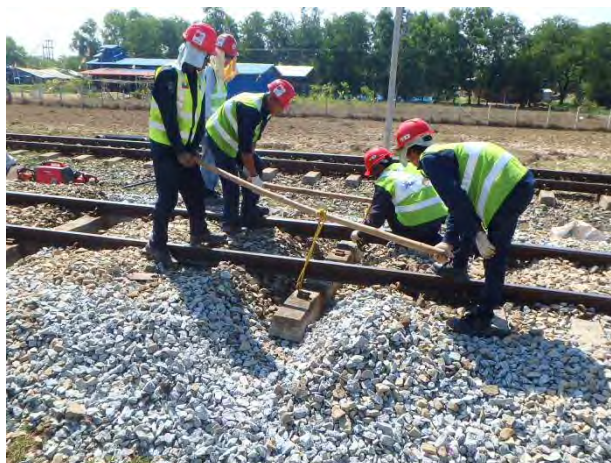
PCマクラギ挿入
