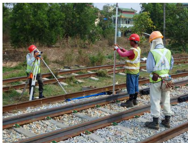
レール交換区間のレベル測量
