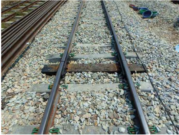
50N レール継目部の木マクラギ
