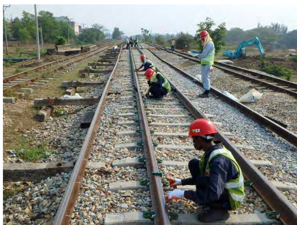
レール交換区間の検測
