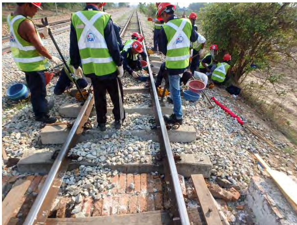
PCマクラギ位置修正
