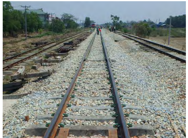
橋りょう中央から終点方 (バゴ方)
