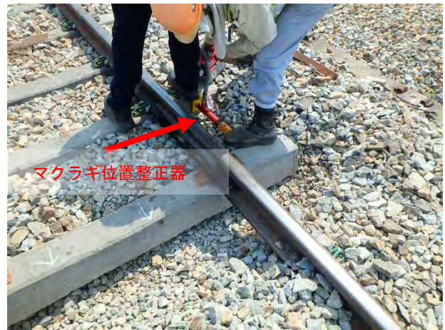
継目部のPCマクラギ位置不正
