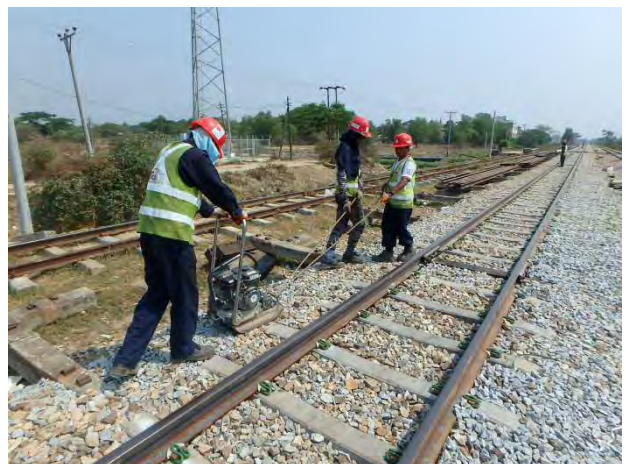
通り整正後コンパクターで締固め
