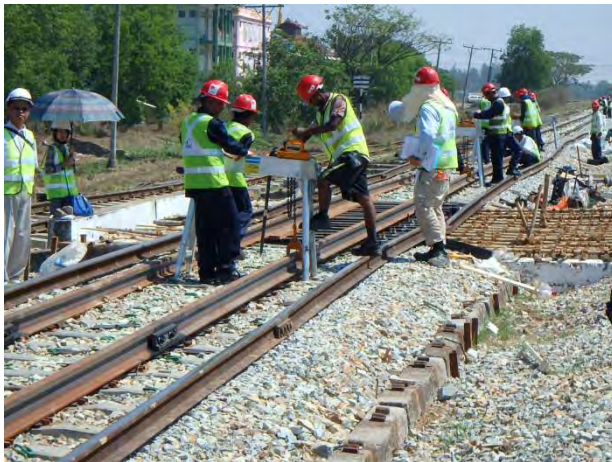
50N レール設置
