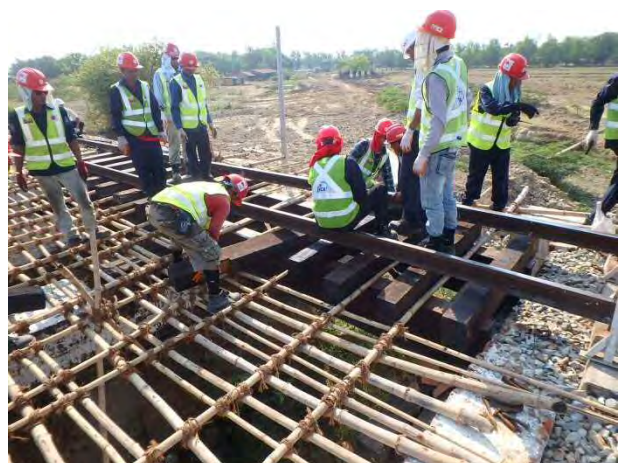
橋マクラギ挿入
