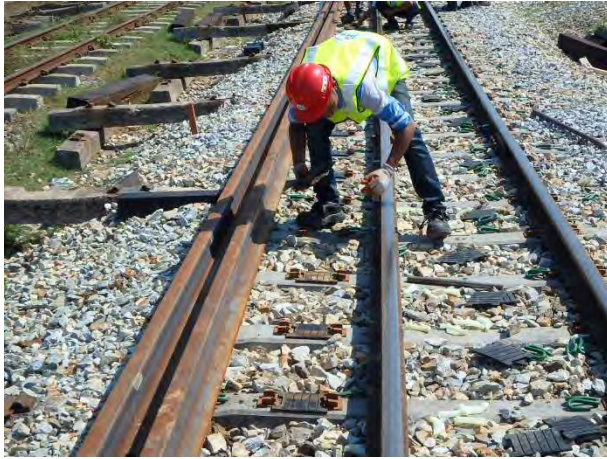
37k レール撤去後、パットの交換
