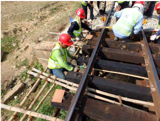
橋マクラギフックボルト取付け
