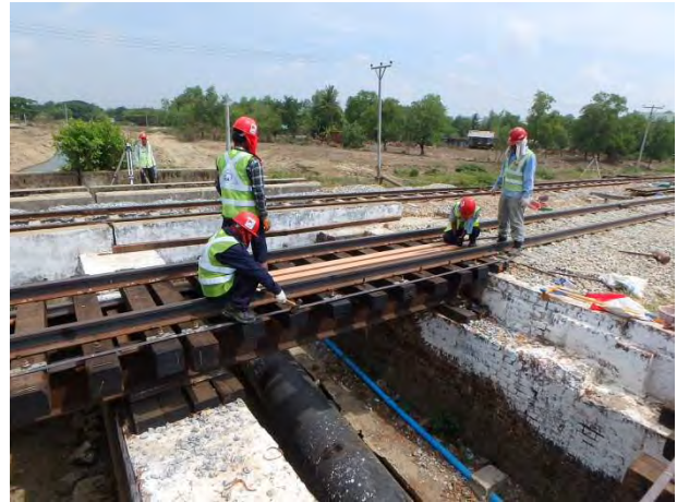
上り線橋りょうケイ材と歩行板の取付け
