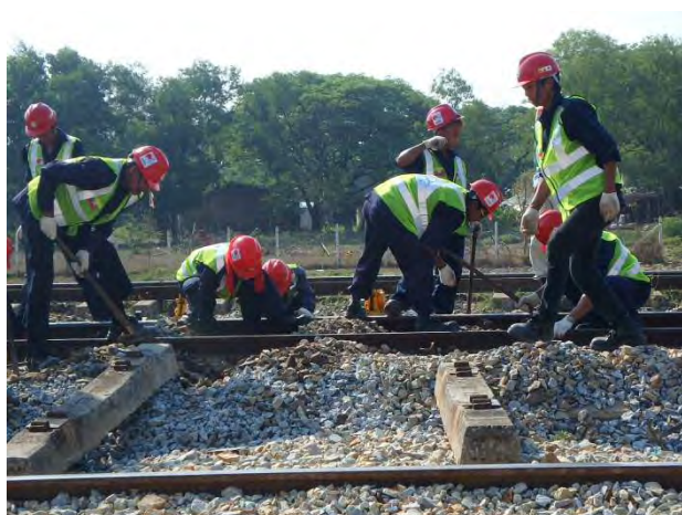
PCマクラギ挿入
