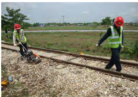
コンパクターによる締め
