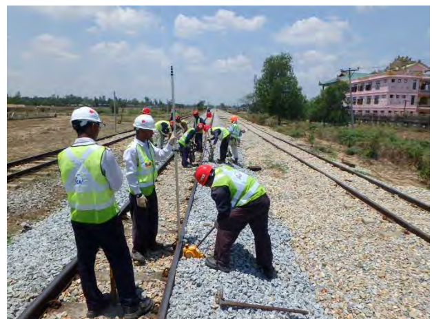
レール扛上とむら直し
