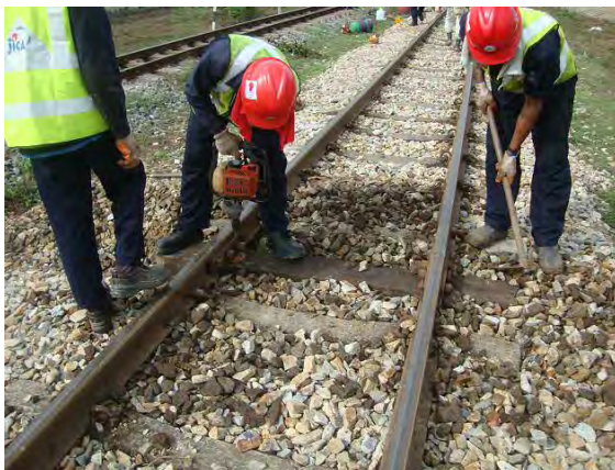
継目木マクラギ施工
