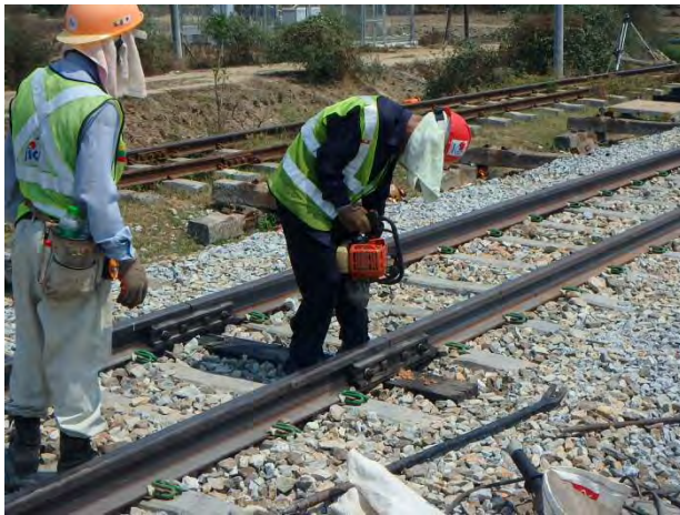
継目部木マクラギ穿孔
