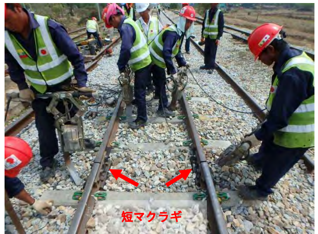
短マクラギ挿入とつき固め
