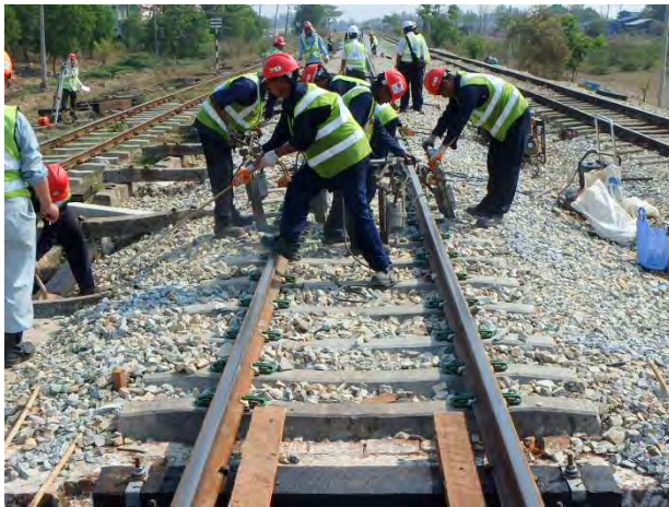
橋りょうアバット裏のむら直し
