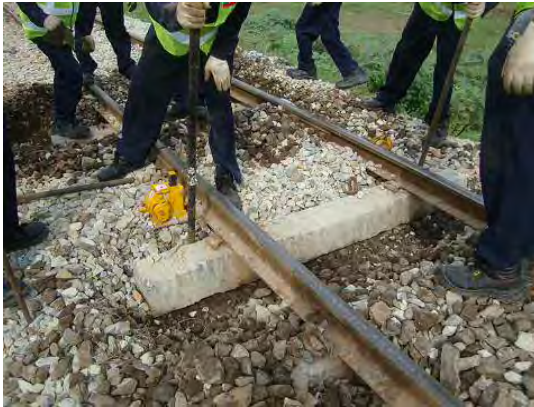
マクラギ位置修正の状況
