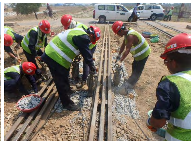
バラスト交換部つき固め
