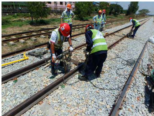
中継レール部のつき固め
