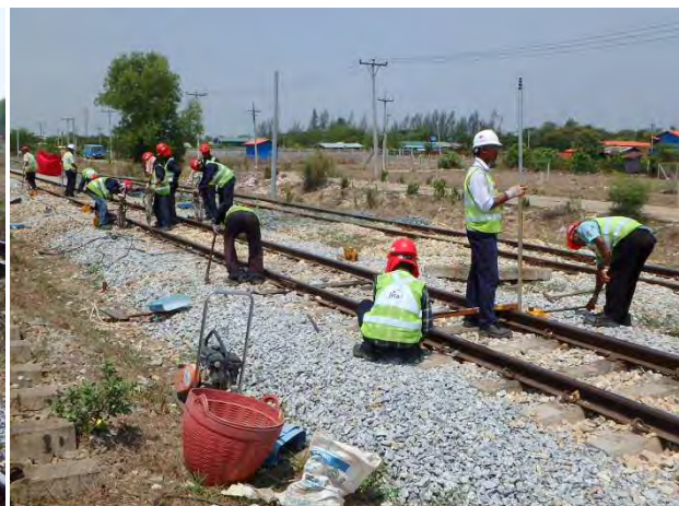
扛上量を確認しながら総つき固め
