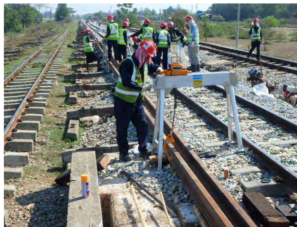
50Nレールを吊り上げ
