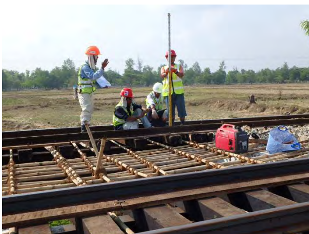
橋マクラギ加工の為、レベル測定 (1本づつ)
