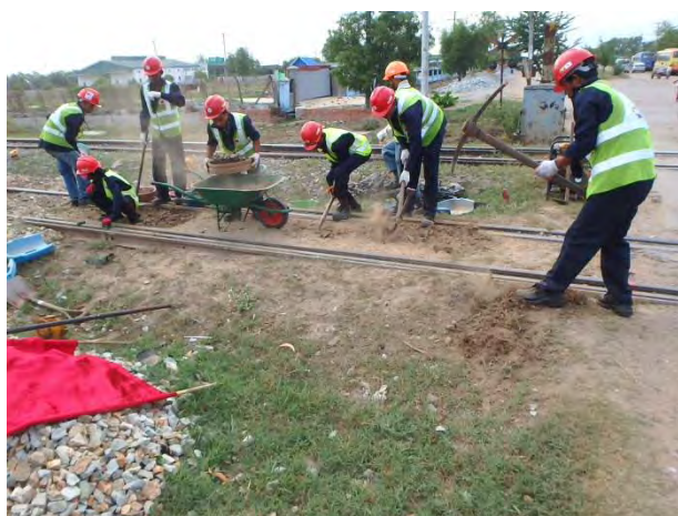
踏切脇の古結した道床を掘削
