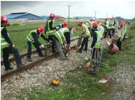
突き固めの状況
