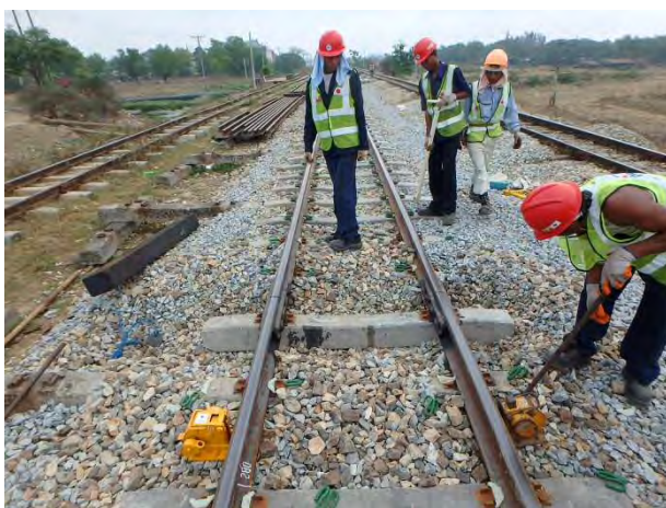
継目部 PC マクラギ交換
