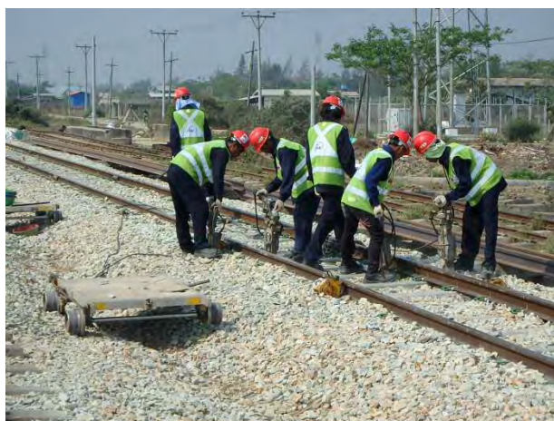
上り線総つき固め
