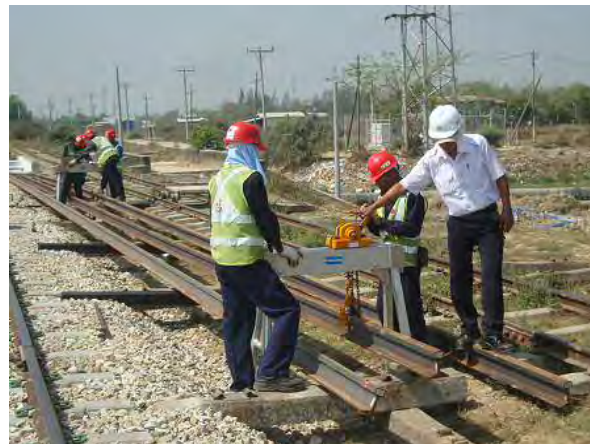
山越器によるレール位置修正
