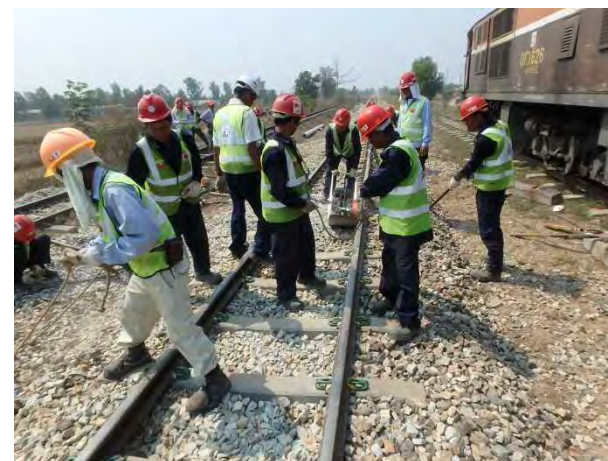
タンパーで道床つき固め
