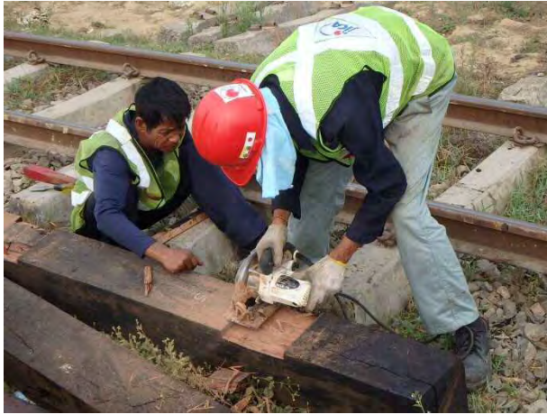
橋マクラギ加工
