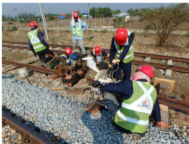
37k 調整レール切断
