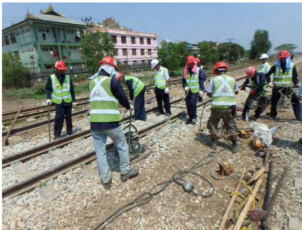
タンパーで道床締固め
