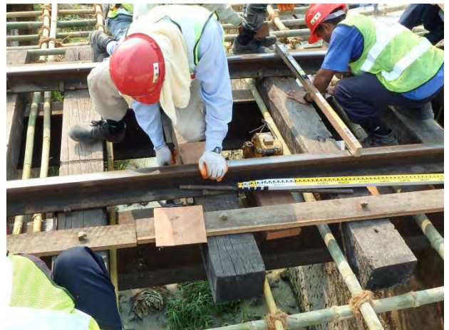
パッキング材を入れて、レベル調整
