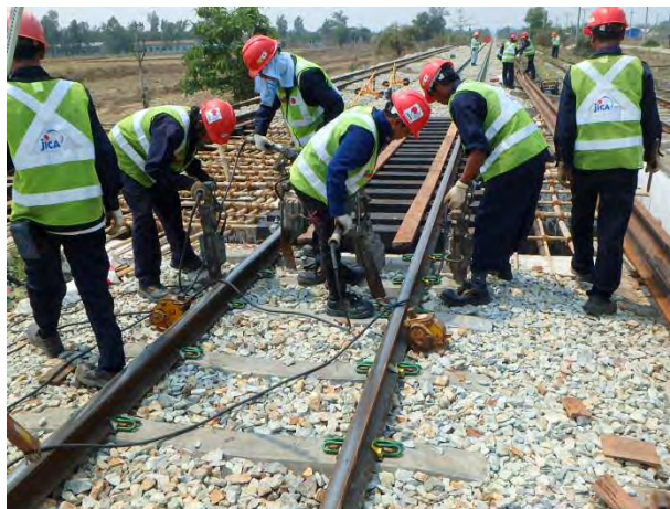
橋りょう前後部のつき固め
