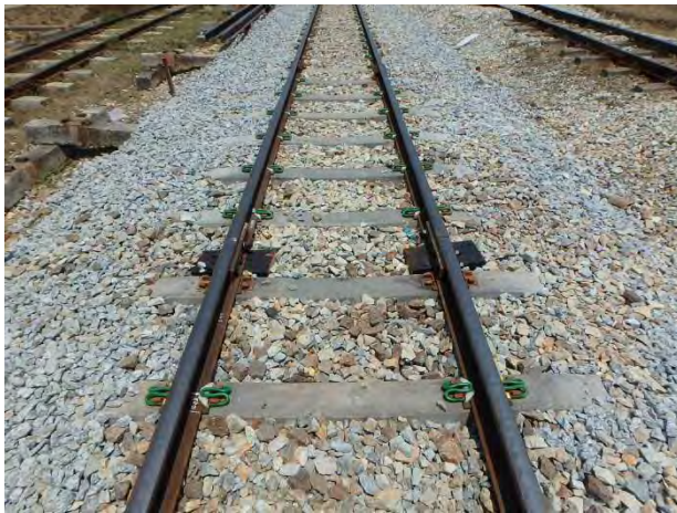
ヤンゴン方レール交換間用継目部
