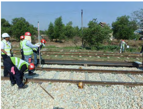
レール扛上量の確認
