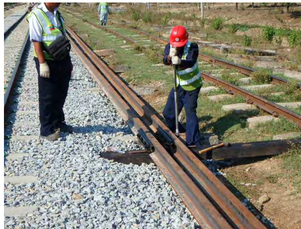
50Nレールを125mで締結解除
