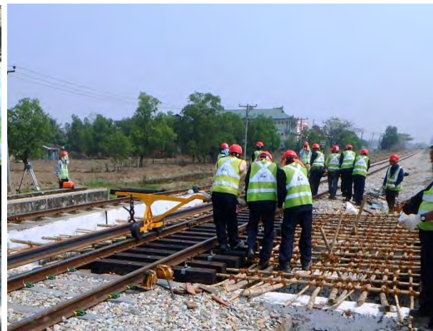
橋りょうにレール運搬
