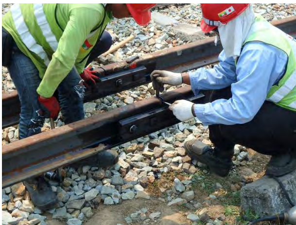
レール遊間確認
