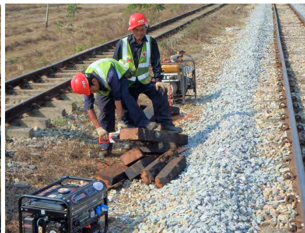
サンドル用マクラギ切断
