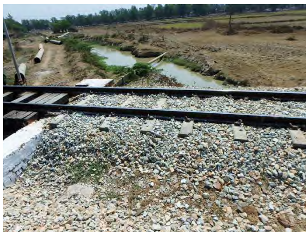
アバット部施工後
