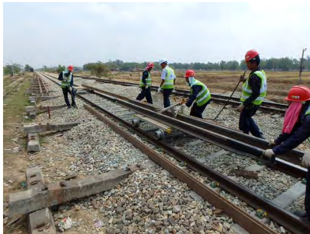
下り線 14k240m レール運搬・取り降し
