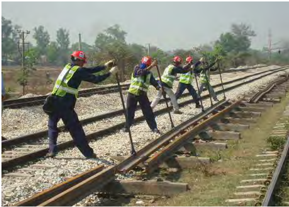
ボールを用いたレールの回転
