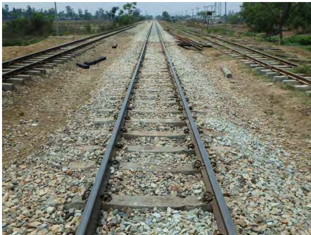
上り線 14k535m ヤンゴン方施工後
