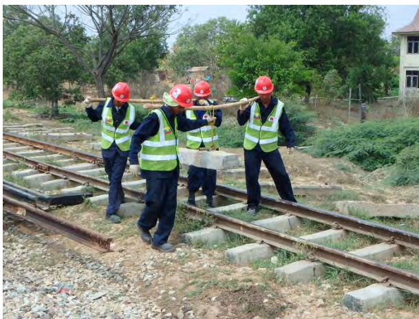
PCマクラギ運搬
