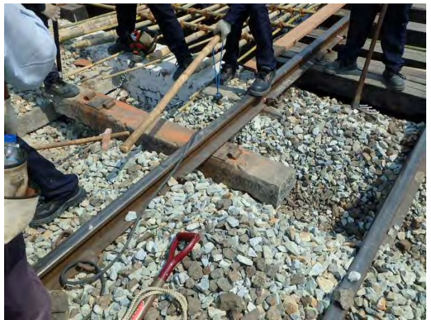
PC マクラギ挿入
