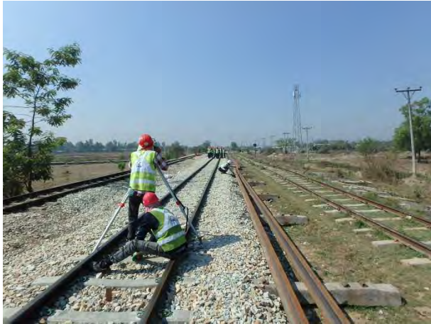
セオドライトでセンター確認後通り整正
