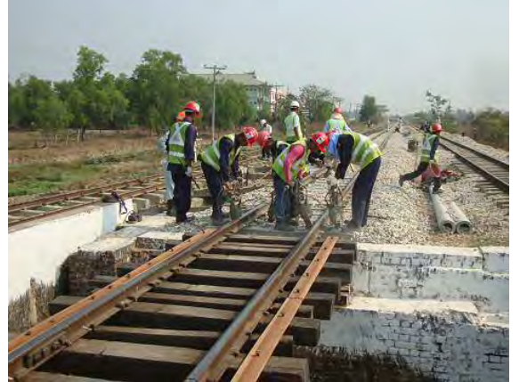
橋台背面部突き固め
