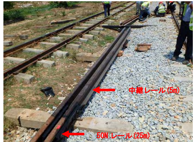
締結された 50N レールと中継レール
