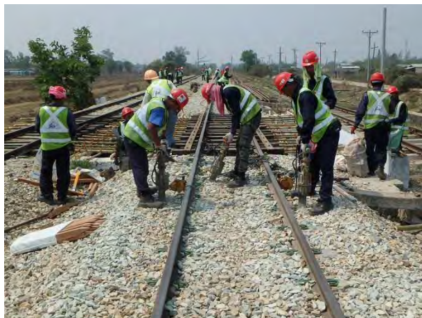
橋アバット部のレール扛上
