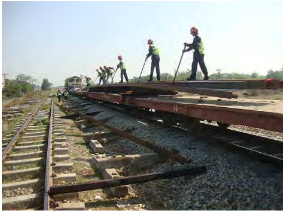
取卸しの状況
