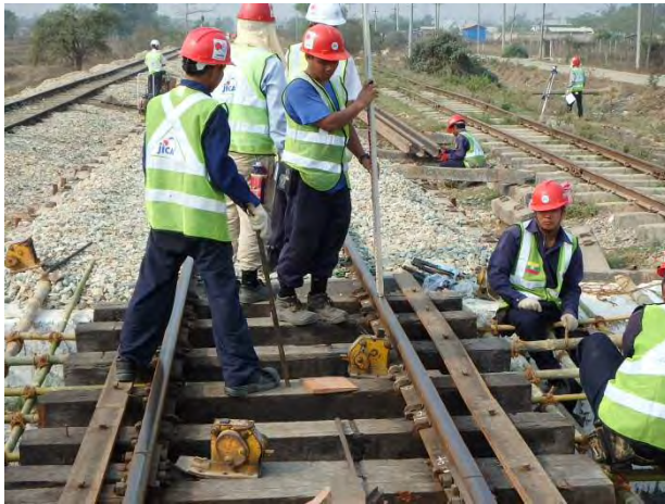
橋マクラギのレベル測定
