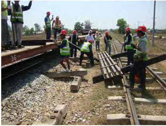
中継レールの取卸し
