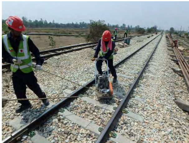
レール扛上後のタンパーによる締固め
