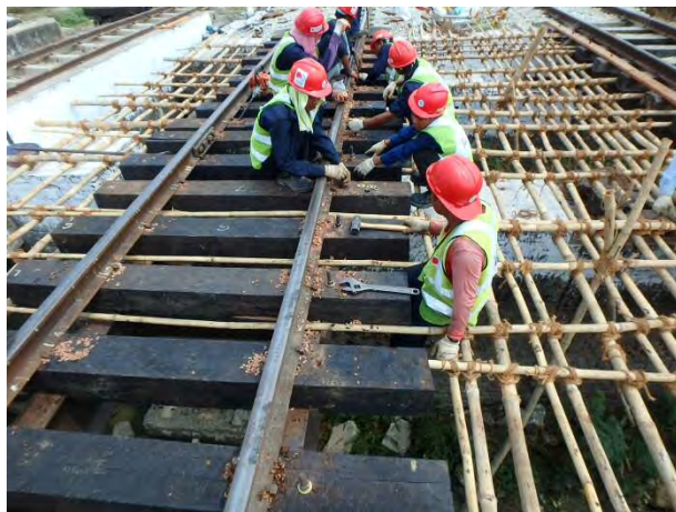
フックボルト取付け (仮)
