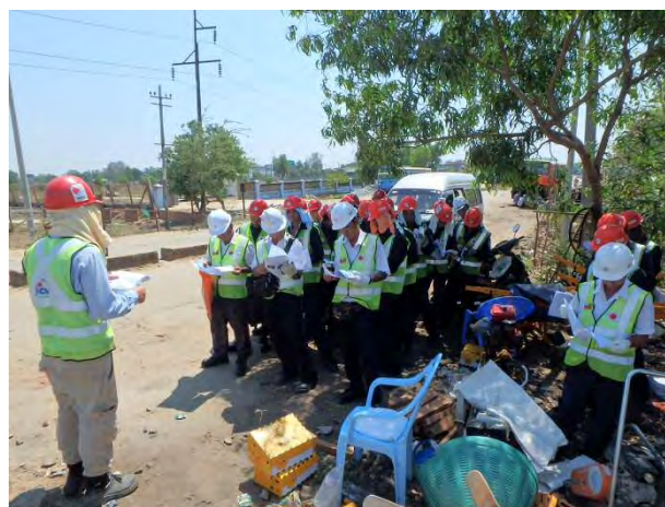
50Nレール交換作業の説明
