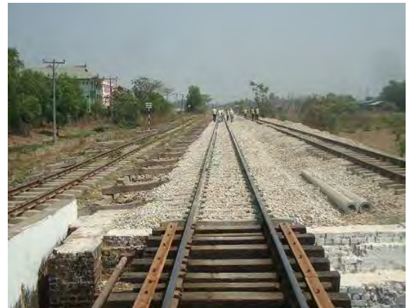
作業終了後の状況
