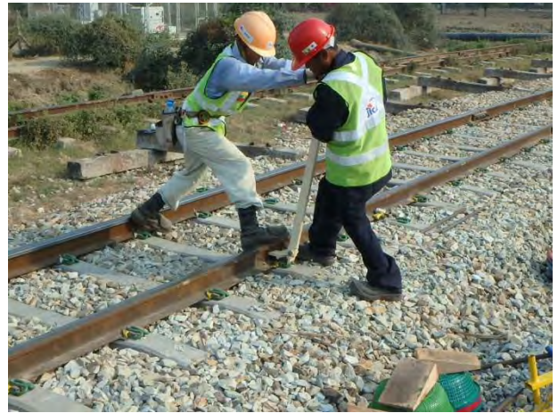
レール吊上げの為施工区間のクリップ開放
