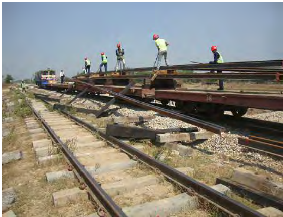
50N レール取卸しの状況
