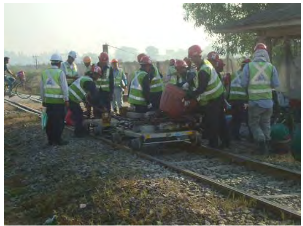
機材運搬状況
