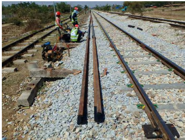
レール端部（起点方）
