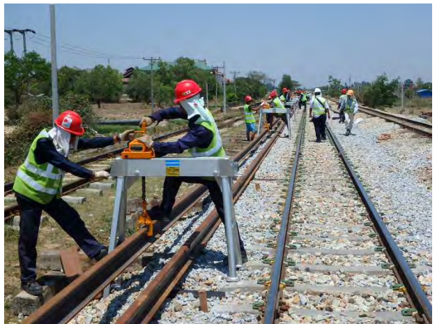
50N レール吊り上げ
