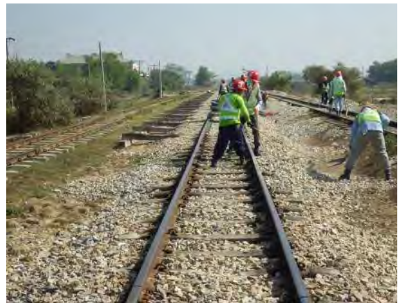
かき上げ作業中
