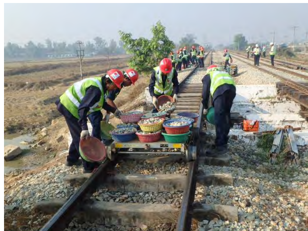
下り線アバット部バラスト補充
