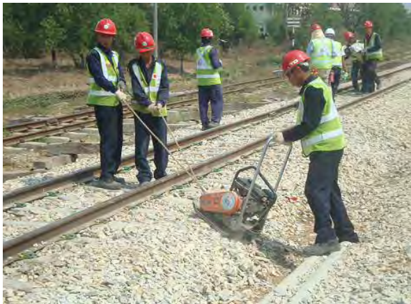
ランマー使用の状況
