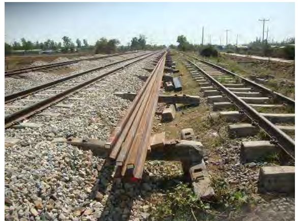
取卸し終了後の状況
