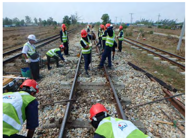
PCマクラギ位置整正
