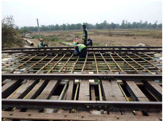
足場工は上下線合わせて行う
