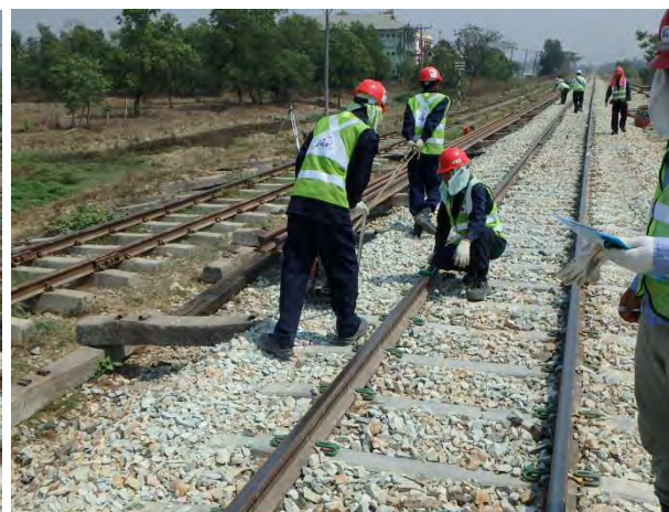
上り線総つき固めの後の検測
