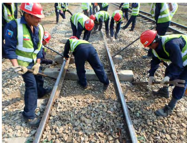
PCマクラギ位置調整
