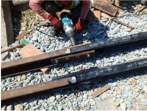
中継レールと調整レールの締結（起点方）
