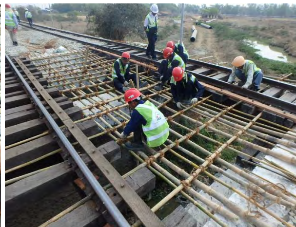
橋マクラギ間隔変更による足場組み直し
