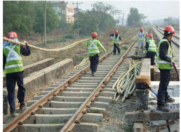
橋りょう足場材運搬
