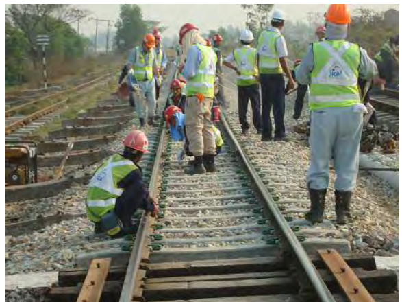
橋台背面検測
