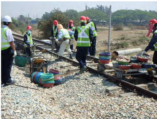
下り線 No16 橋りょうアバット部へバラスト補充
