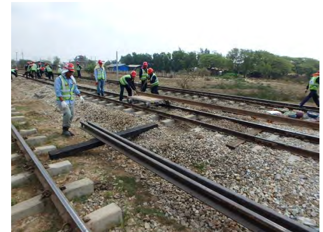
下り線 14k500m レール運搬・取り降し
