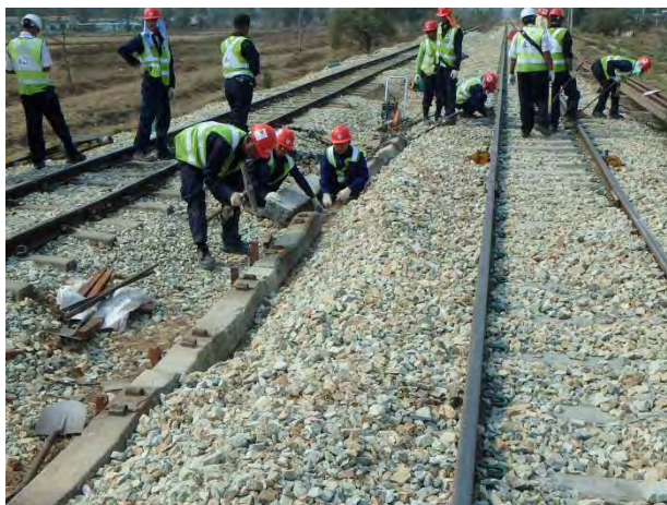
バラスト止め設置
