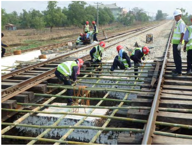
マクラギ交換足場工
