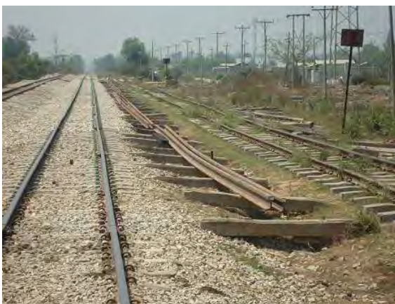
20本の取卸し終了後の状況
