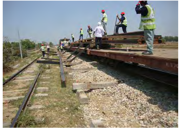
50N レール取卸し準備の状況
