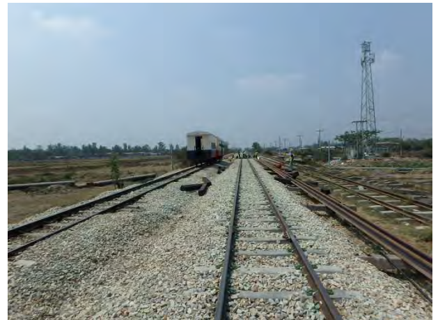
施工後の下り線 14k400m 付近 (ヤンゴン方)
