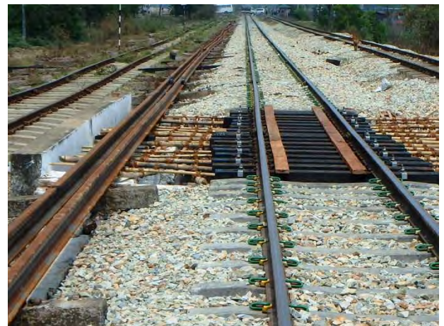
仕上がり橋りょうと交換を待つ50Nレール
