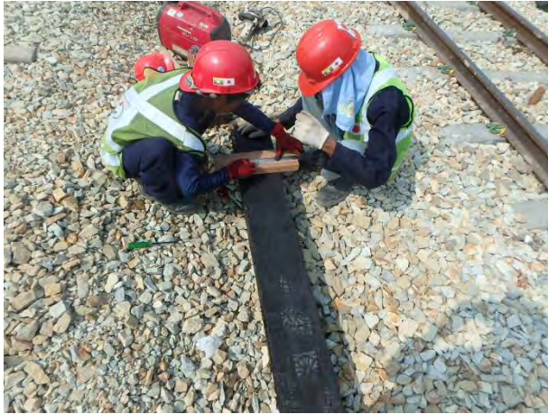
橋マクラギ加工 1
