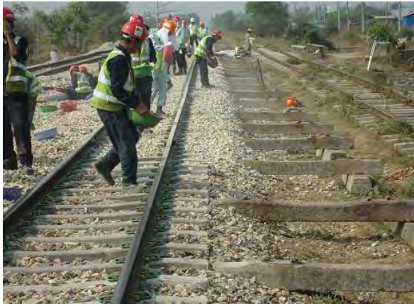
マクラギ端補充状況
