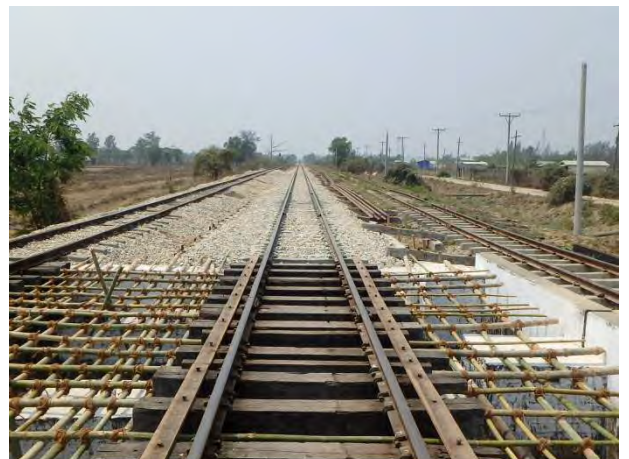
完成後の足場工
