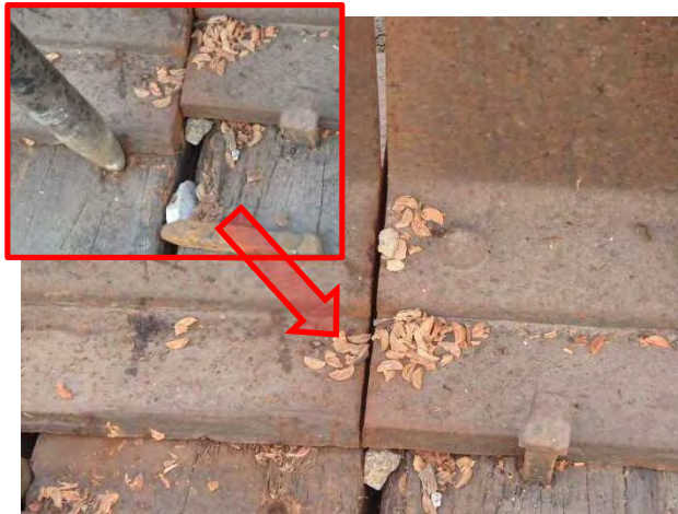
下り線橋りょう桁整正
