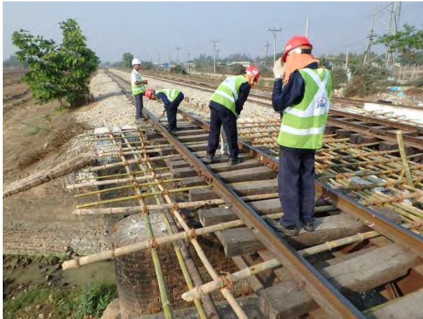
下り線 No16 橋りょう橋マクラギ位置整正
