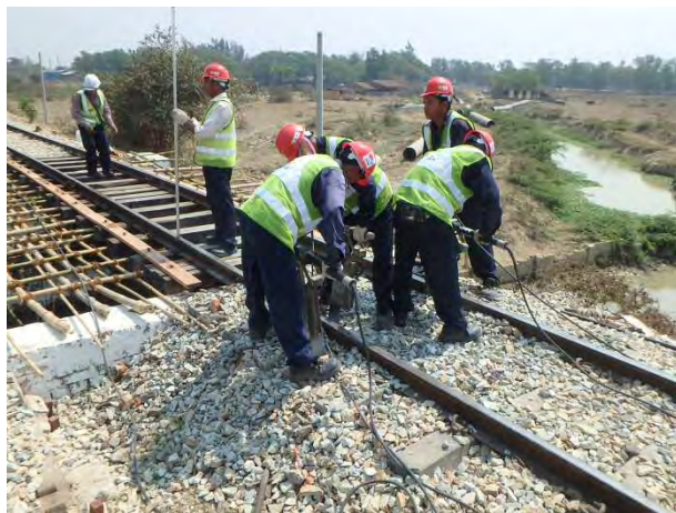
下り線橋アバット部のつき固め
