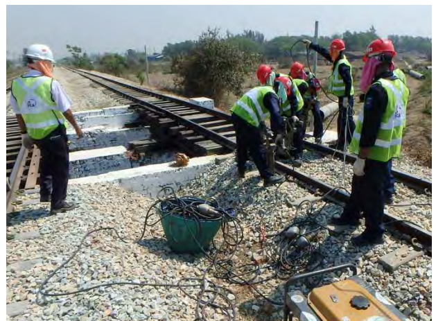
アバット部のつき固め
