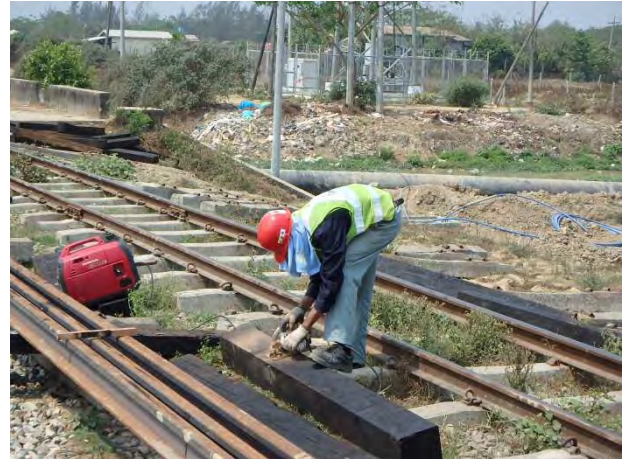
橋マクラギ加工 2
