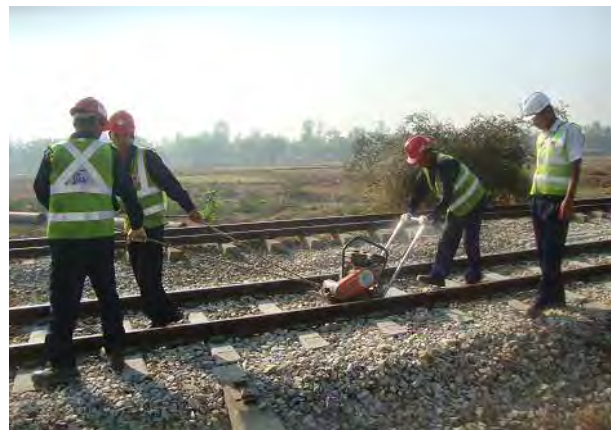
ランマーの使用
