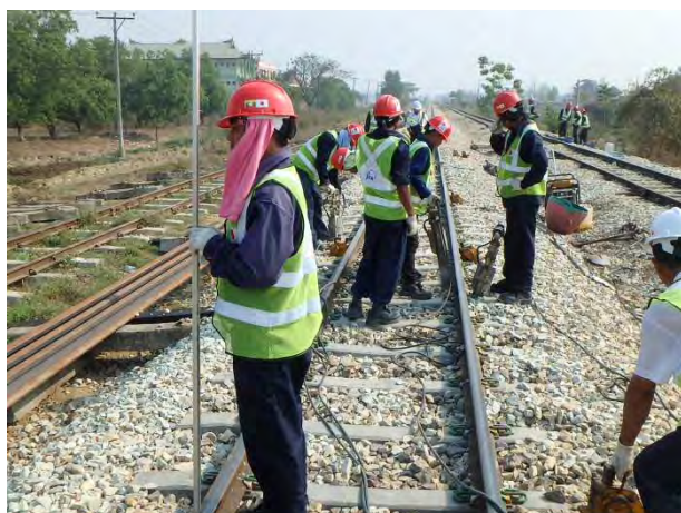
上り線レベル計測とつき固め
