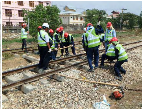
PCマクラギ挿入
