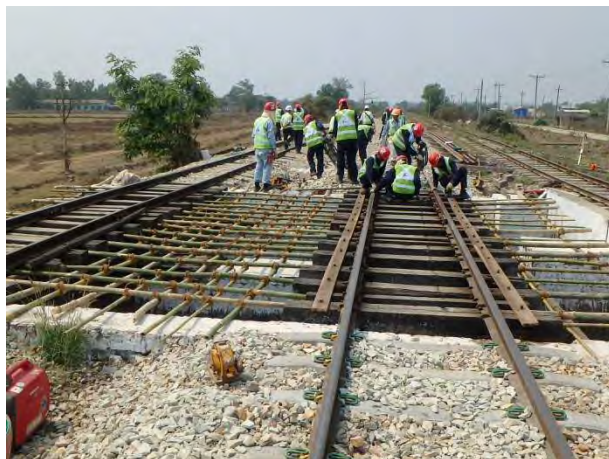
ほぼ完成した足場工
