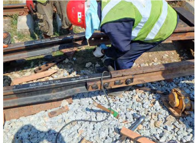
調整レールと中継レールの締結（終点方）
