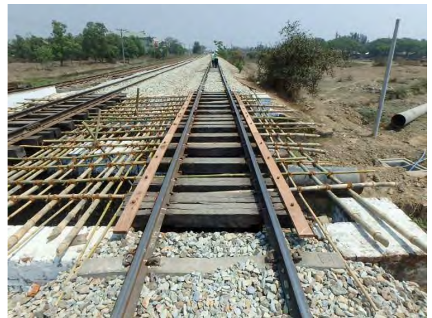
施工後の下り線橋りょう (バギー方)
