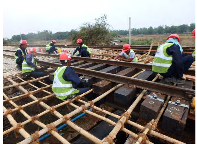
フックボルト取付け
