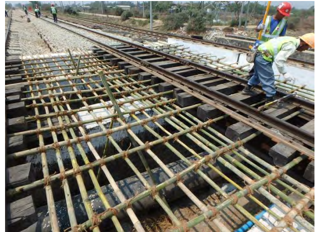
橋下からも補強
