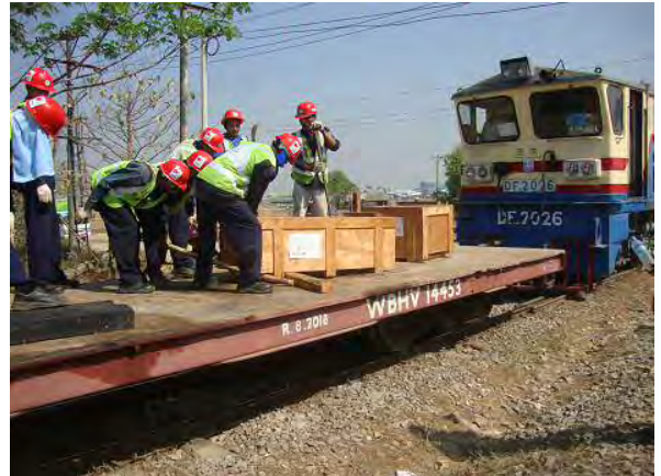
継目板とボルトの取卸し
