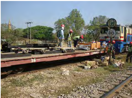
機材積み込み
