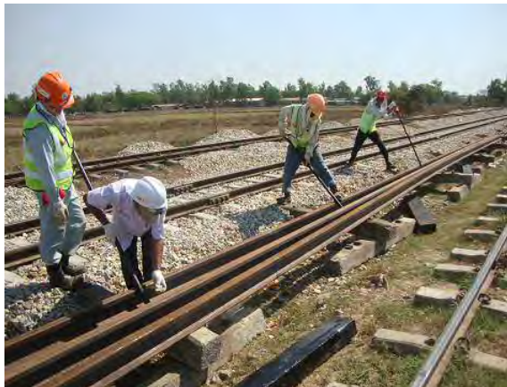
取卸したレールの整正
