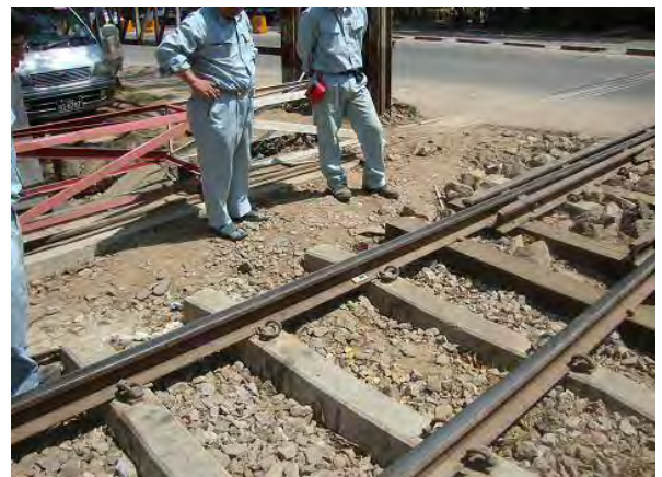
環状線でのレール温度測定
