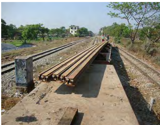
分岐器通過時のレール運搬の状況
