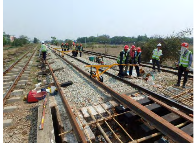
橋りょうにレール運搬 (2本目)
