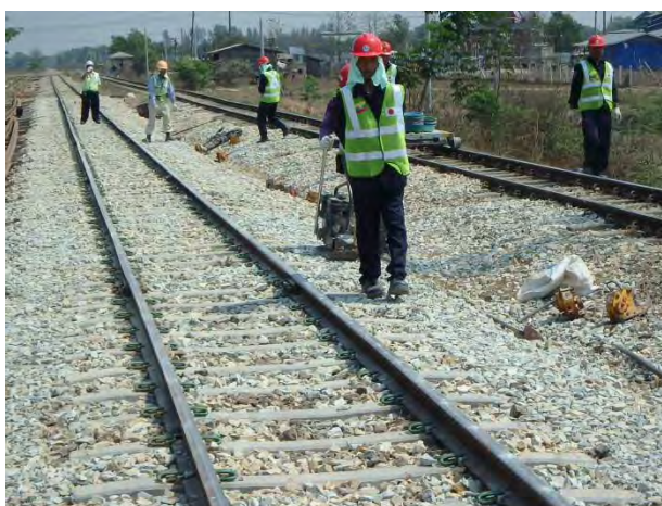
むら直し後タンパーで締固め
