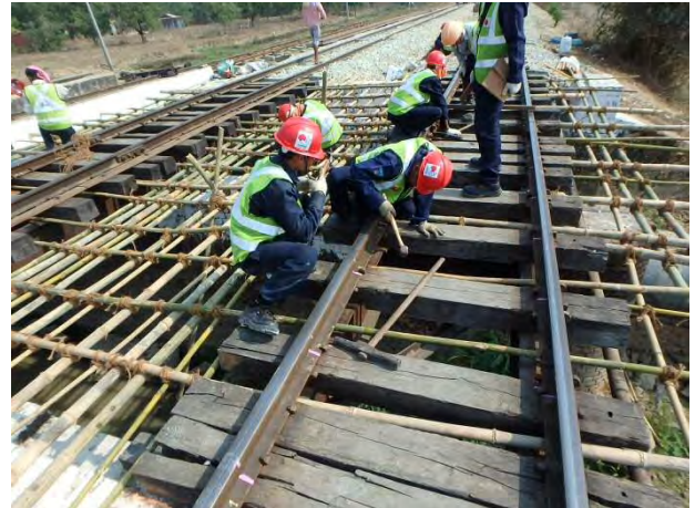
橋マクラギのレベル整正
