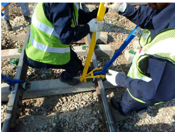
持上工具と締結工具組合せて締結
