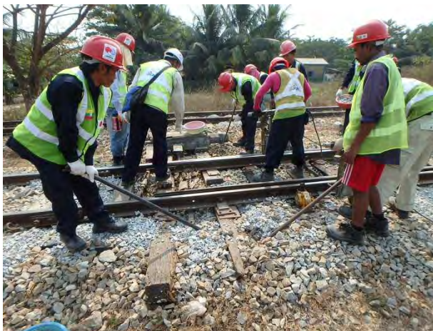
分岐モーター一部つき固め
