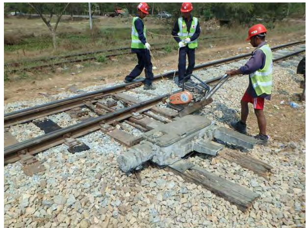
コンパクターで道床つき固め
