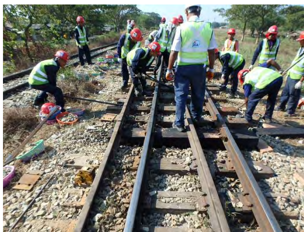
分岐マクラギ交換
