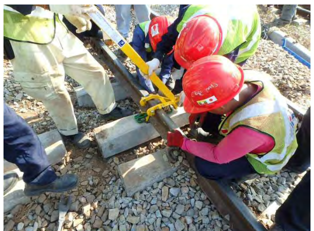
もう片方は締結工具だけで締結
