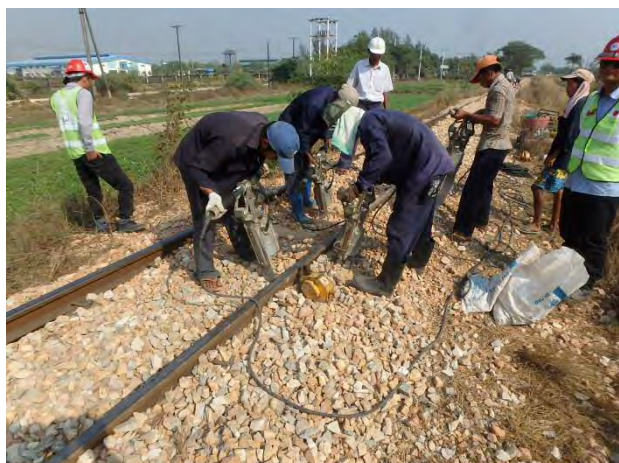
作業ワーカーによるつき固め
