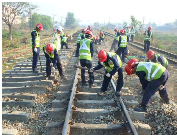
バラスト撤去作業
