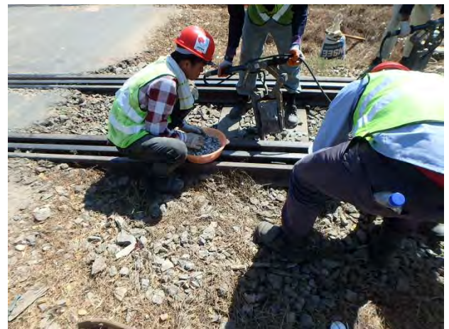
踏切脇で豆砕石を入れてむら直し
