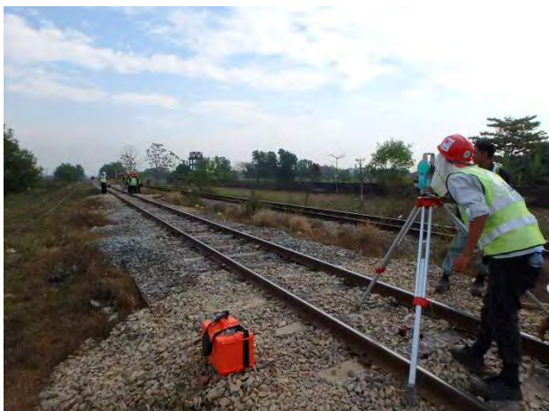
トランシットを使って通り修正
