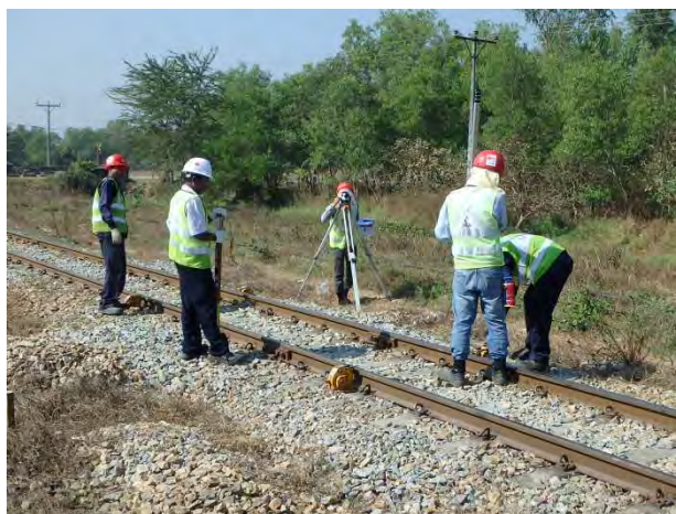
レール扛上量の測量
