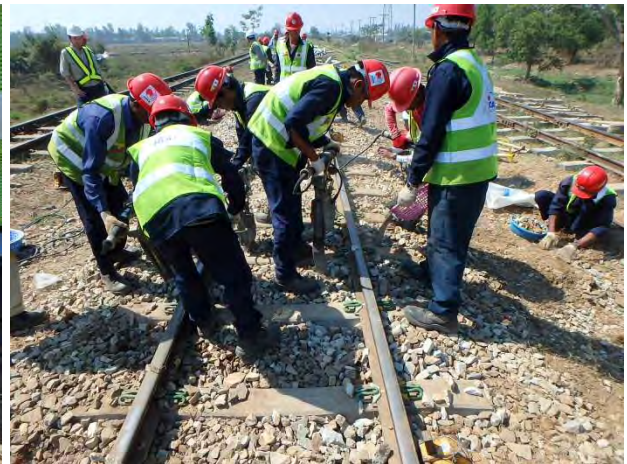
新マクラギ交換後はむら直し
