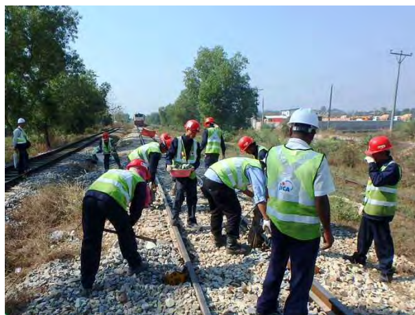
列車を抑止してつき固め
