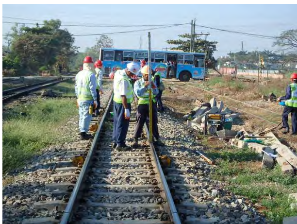
レベル計測でレール扛上
