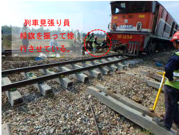
クリップを半分締結して列車通過（徐行）
