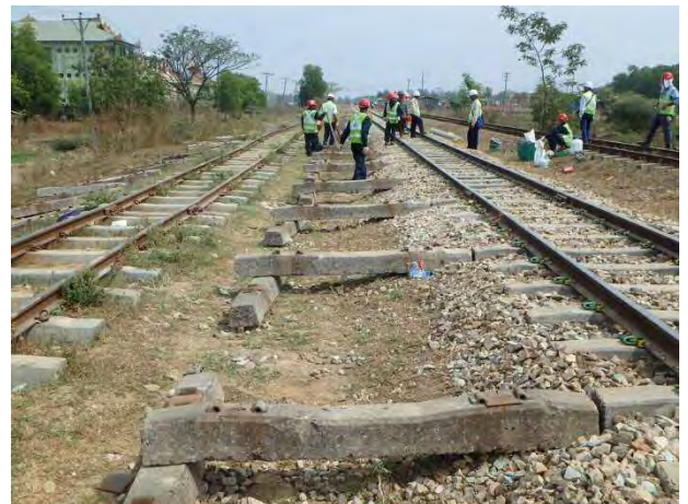
14k400m からバギー方 50N レール仮受け台
