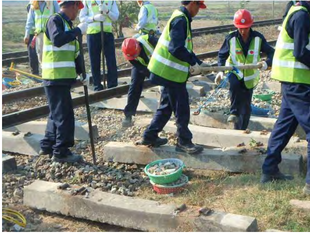
PC マクラギ撤去
