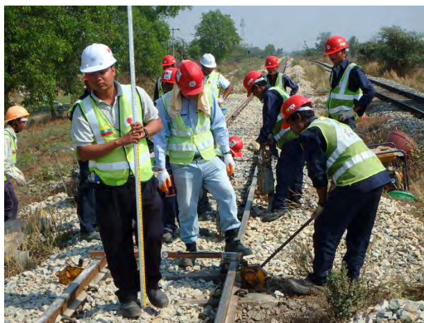
レベルを確かめながらレール扛上
