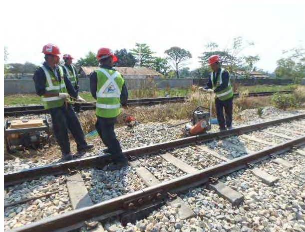
コンパクターで道床つき固め
