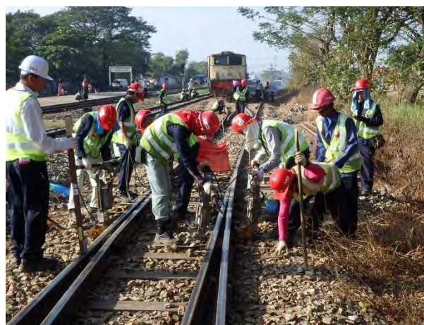
列車を抑止して分岐器扛上
