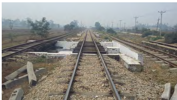
橋マクラギ交換は 50N レール交換後
