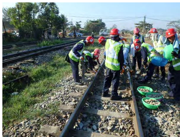
タイタンパーでつき固めとバラスト補充
