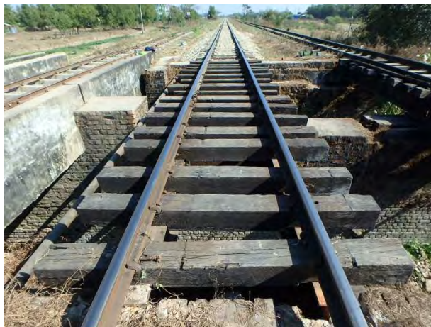
施工前の No16 橋りょう
