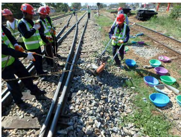
タンパーで道床固め
