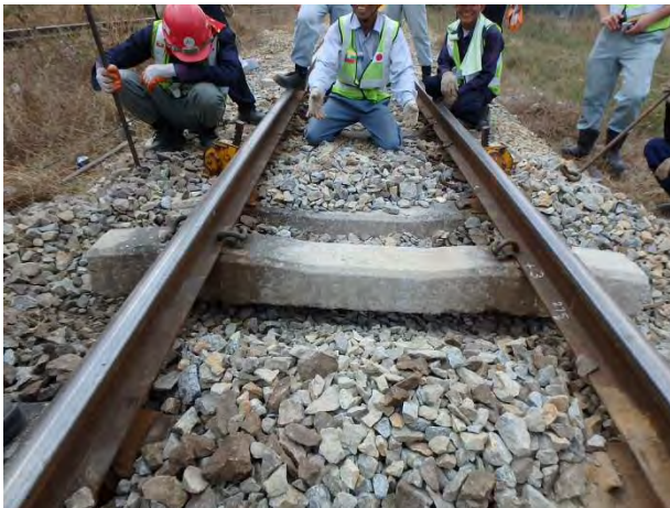
ジャッキアップしてマクラギ下を確認
