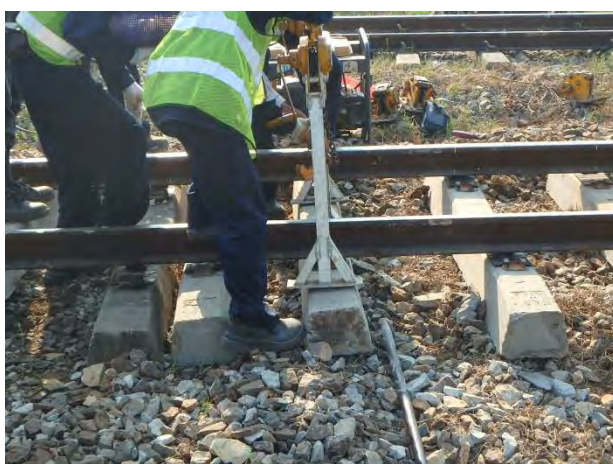
レール吊上げ
