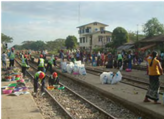
作業全体の状況
