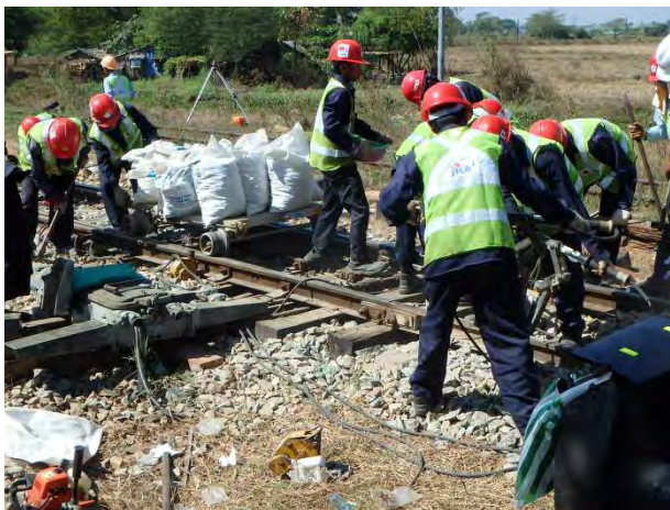
モーター部バラスト補充しながらつき固め
