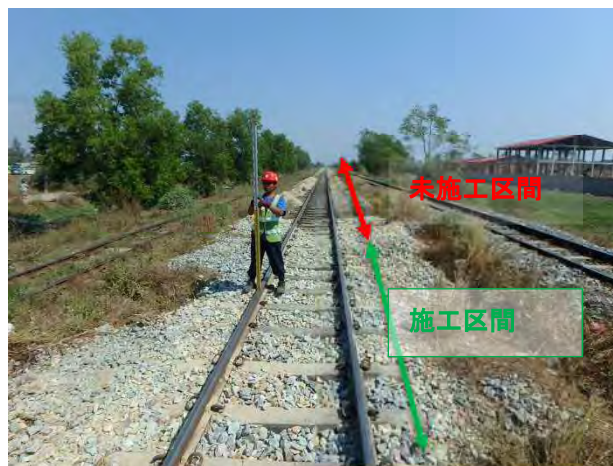
13k550m 付近施工後
