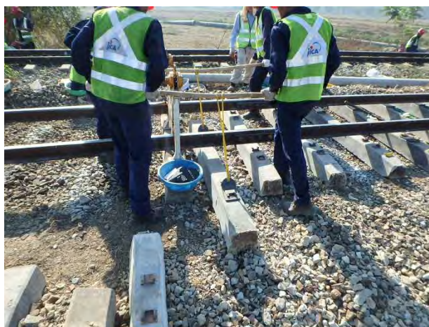
レールを吊り上げて、新マクラギ挿入
