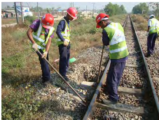
マクラギ位置修正
