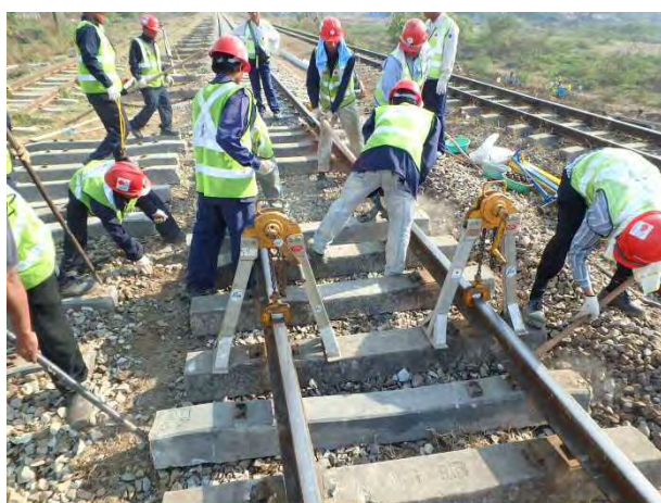
レールを吊り上げて、マクラギ交換
