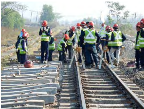
マクラギ交換作業
