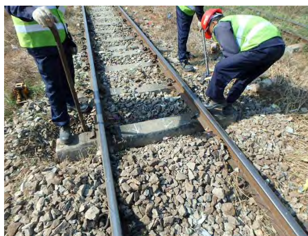
PC マクラギ位置整
