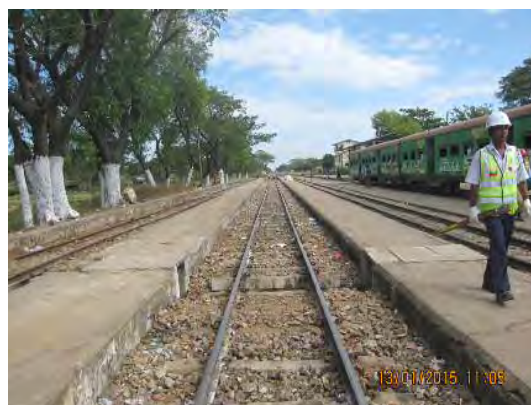
整備後の状況
