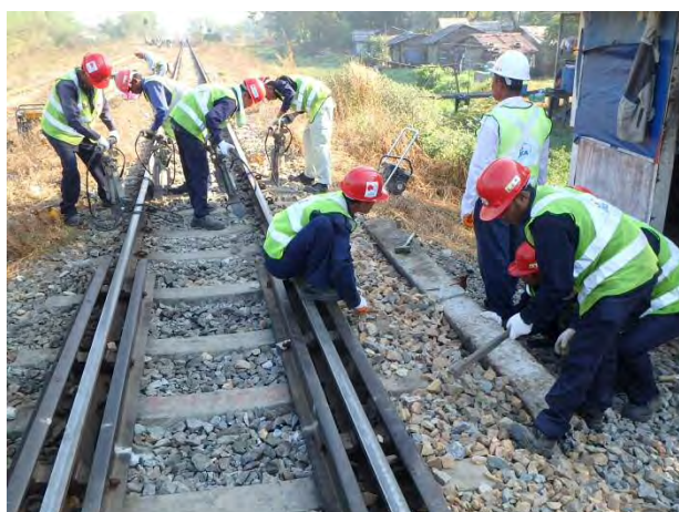
下り線踏切脇むら直しとバラスト止め設置
