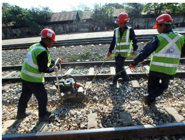
道床肩のつき固め
