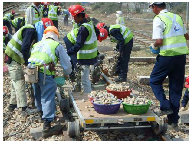
バラスト補充しながら、つき固め
