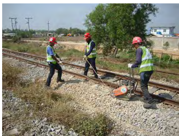
ランマーによる締固め
