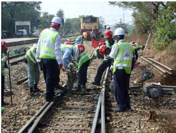
列車を抑止して分岐器のむら直し
