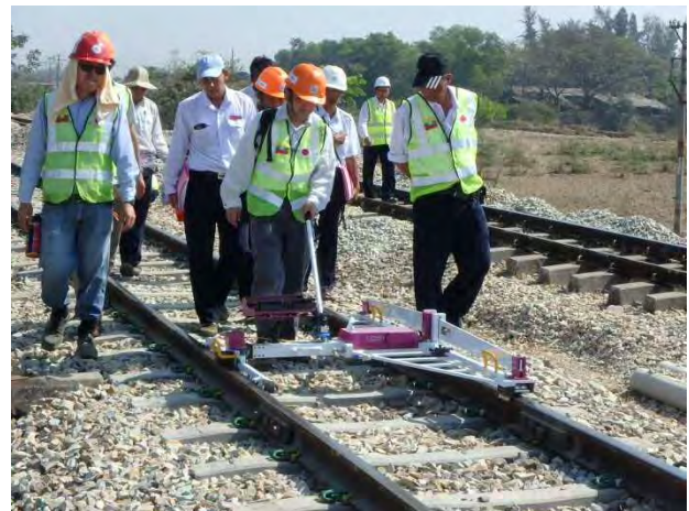
トラックマスターで測定（直線部）
