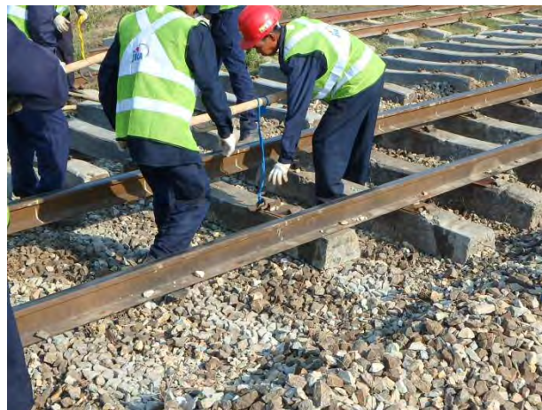
PCマクラギ撤去
