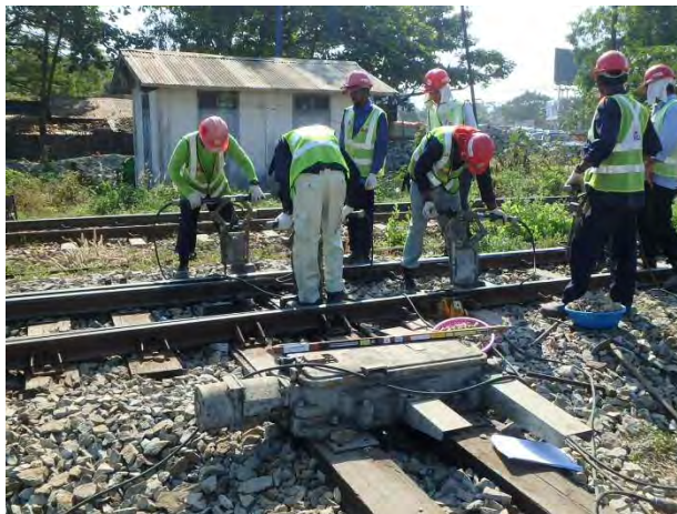
54号分岐器のむら直し
