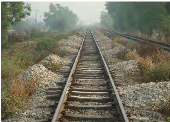
搬入されたバラスト
