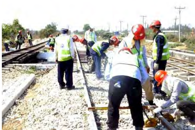
レール扛上・むら直し
