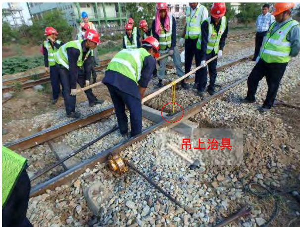
新 PC マクラギ挿入
