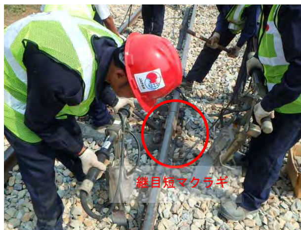
継目短マクラギのつき固め
