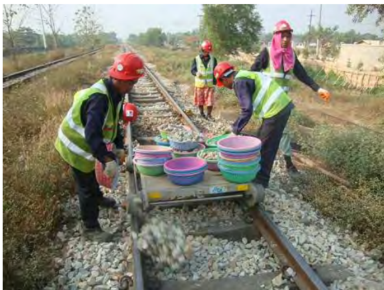
バラスト投入の状況
