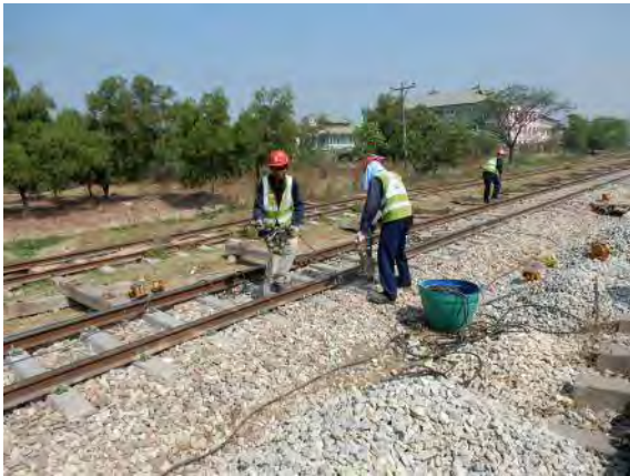
つき固め作業
