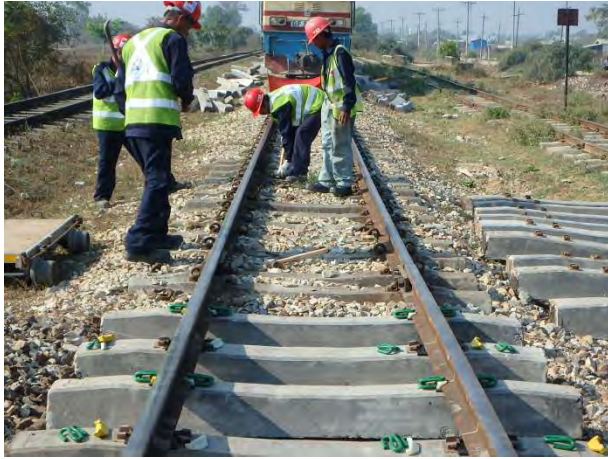
列車抑止してクリップ締結
