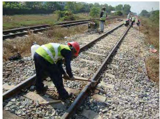
短マクラギの犬釘打ち
