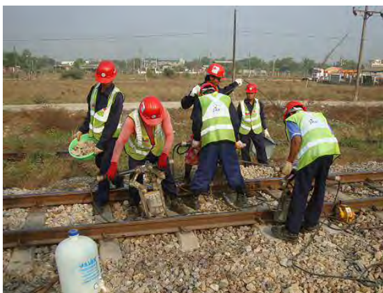
突き固めの状況
