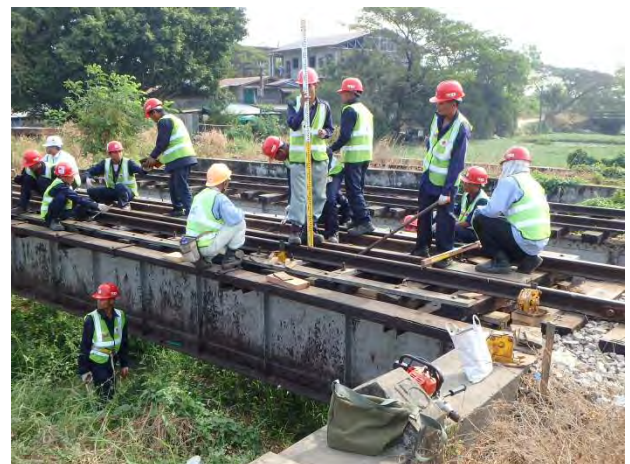
橋りょうのレベル調整
