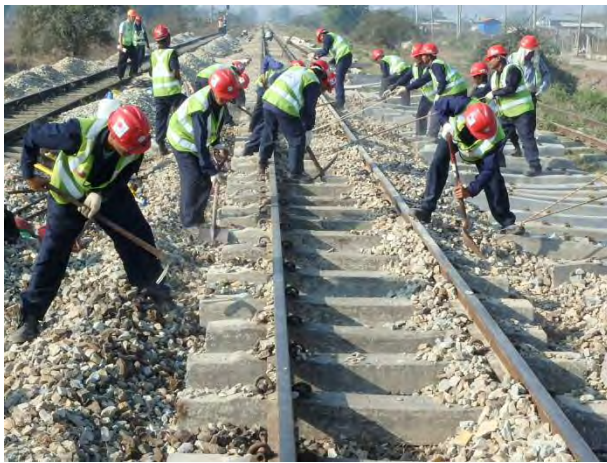
バラスト撤去作業開始
