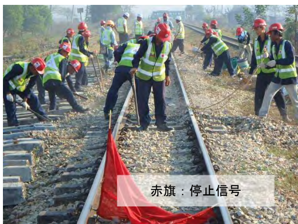
赤旗：停止信号 バラスト撤去作業開始
