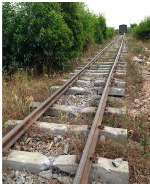
1月17日ティラワ線の脱線で折れたPCマクラギ
