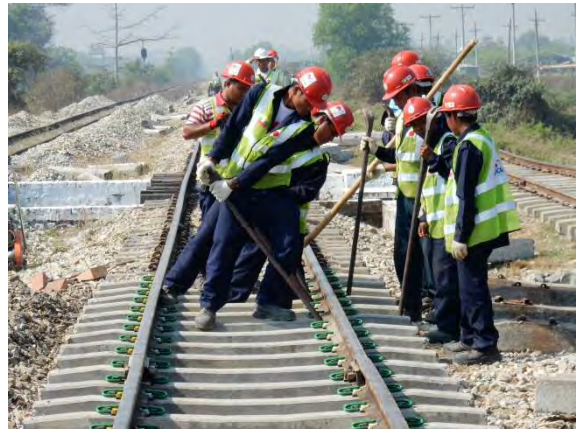
通り整正作業
