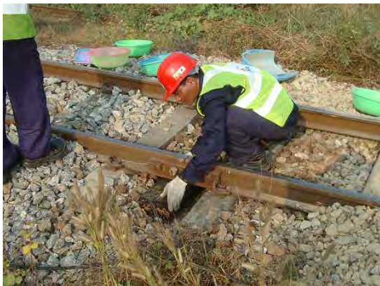
短マクラギ挿入の状況
