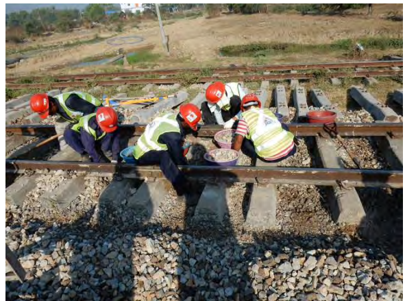
道床交換作業
