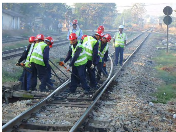
上り線分岐器の通り直し
