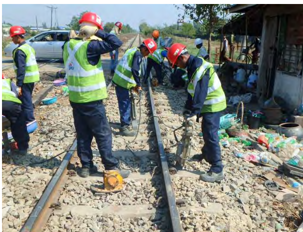
下り線踏切脇むら直し
