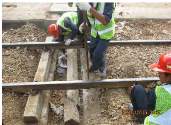
破損したマクラギの交換
