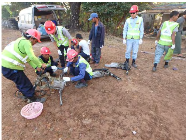
タイタンパーのブレード交換
