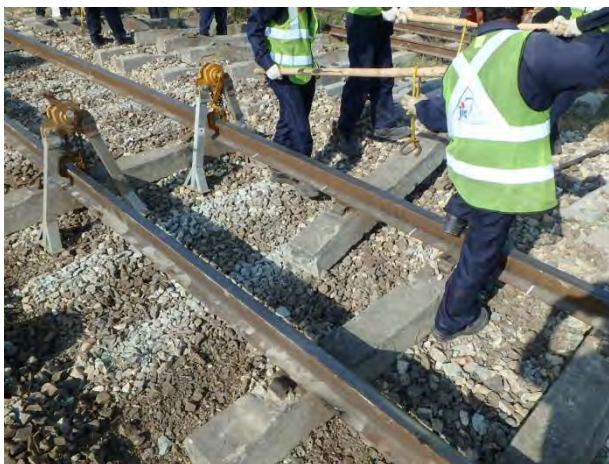
レールを吊り上げ、マクラギ撤去
