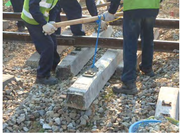
PC マクラギ挿入
