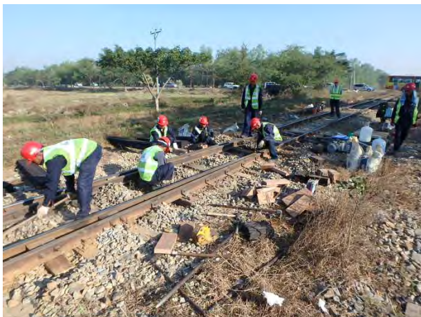
パッキンを入れレールを扛上
