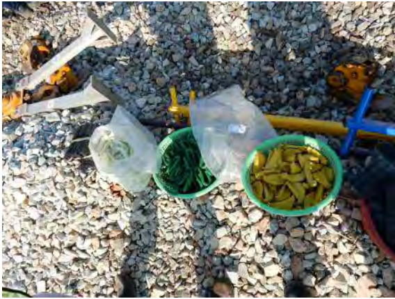
新材料（ファーストクリップ）交換
