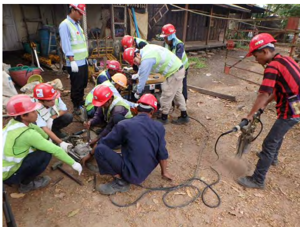
タイタンパーと発電機の点検調整
