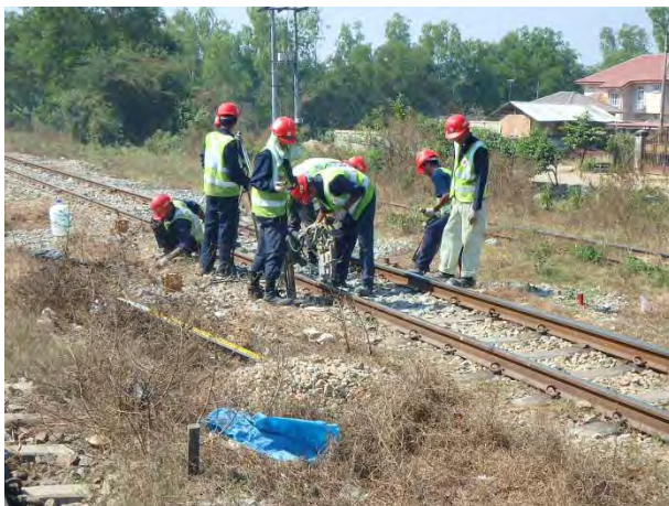
上り線 12k940m 付近むら直し
