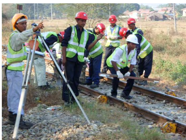
上り線 11k400m むら直し
