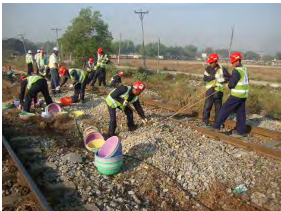
バラスト掻き入れの状況
