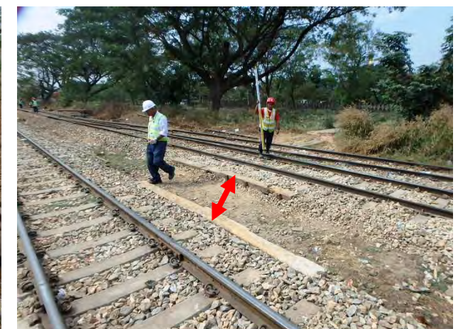
バラスト止め設置
