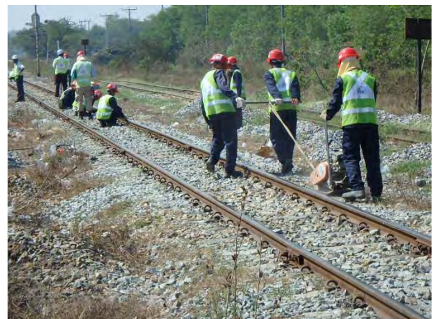
事後検測とコンパクター-締固め
