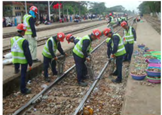
突き固めの状況
