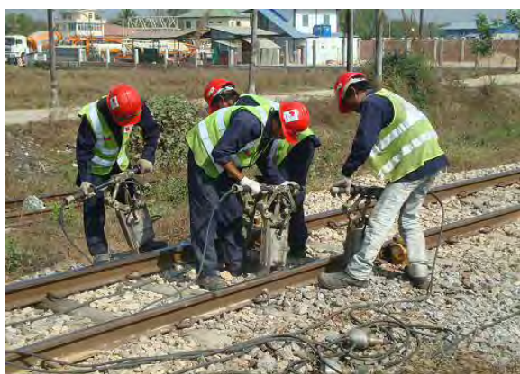
総突き固めの状況
