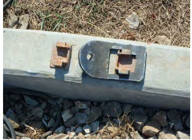
PC マクラギ吊上治具
