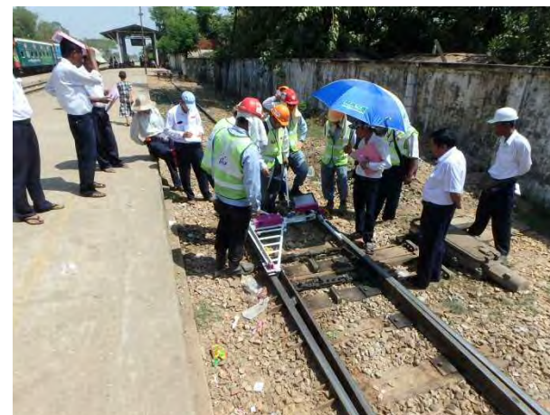
分岐器直線部の測定
