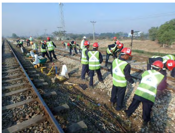
バラスト撤去作業開始
