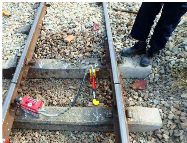
マクラギ位置修正器を使ってPCマクラギ移動
