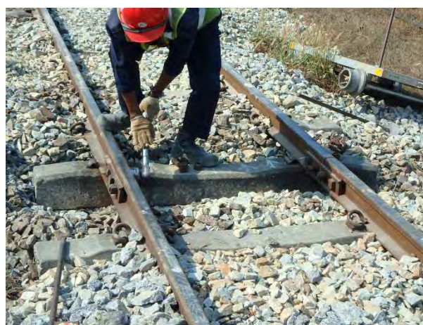
PCマクラギ位置修正
