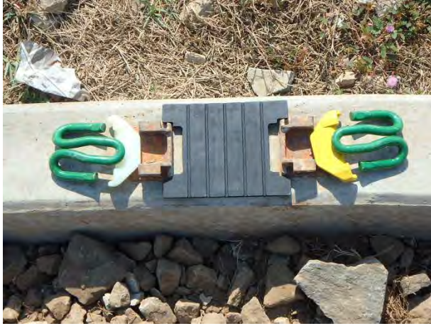
締結装置、パットとインシュレーター
