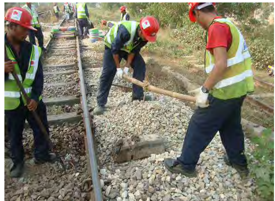
破損したPCマクラギの撤去
