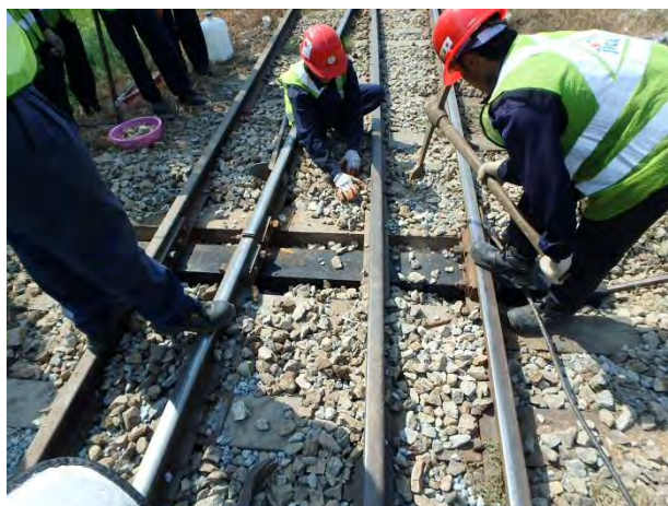
下り線分岐マクラギ挿入
