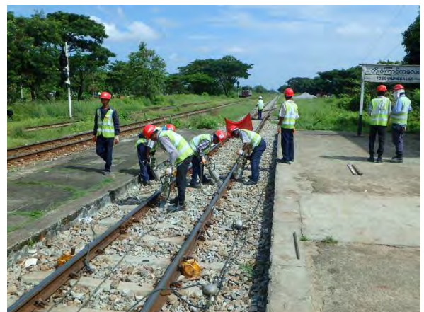
11k830m 付近総つき固め
