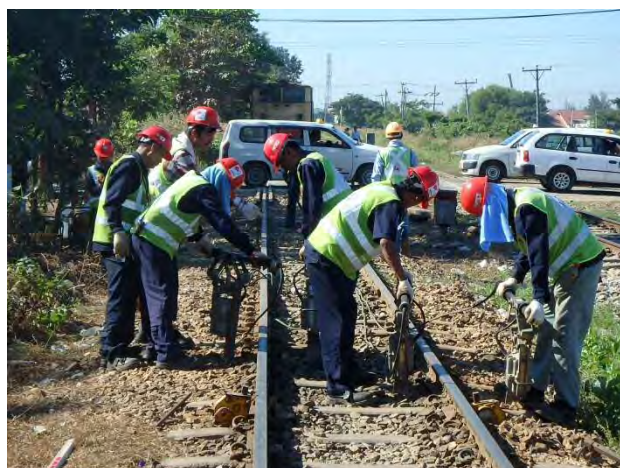
列車を抑止してレール扛上
