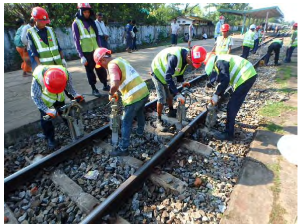
11k740m 付近総つき固め
