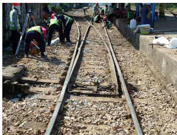
施工後の分岐器
