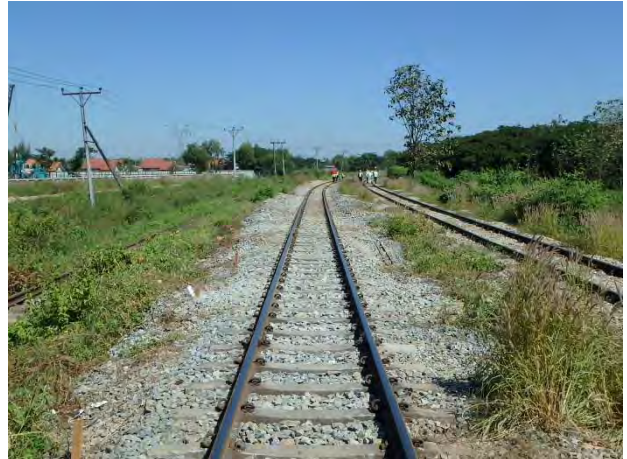
上り線 10k900m バゴ一方向施工後
