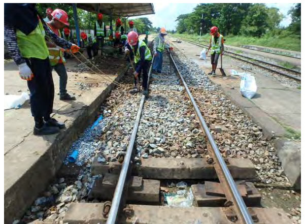
排水管の周囲は豆碎石を敷き詰める
