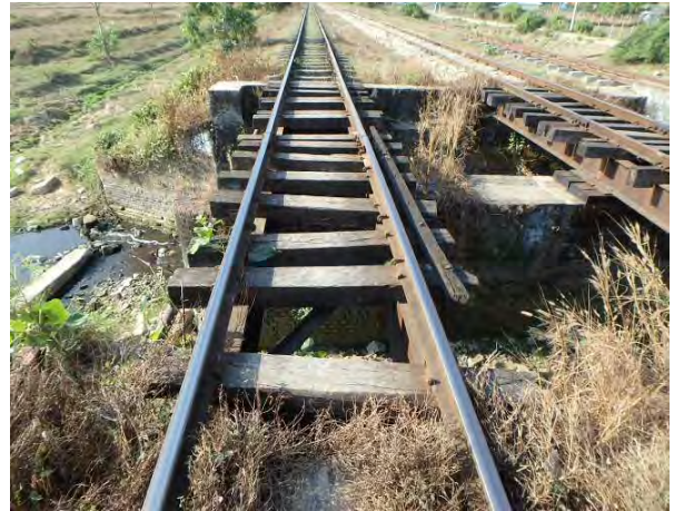
下り線 14 km 350m のマクラギの無い橋りょう
