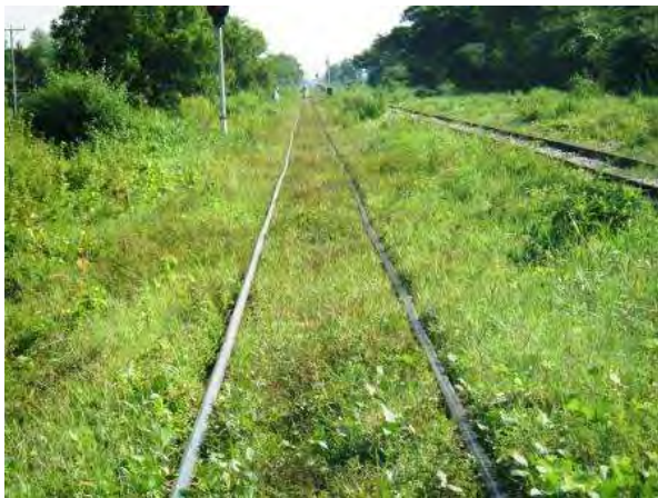
滞水箇所の除草(施工前)
