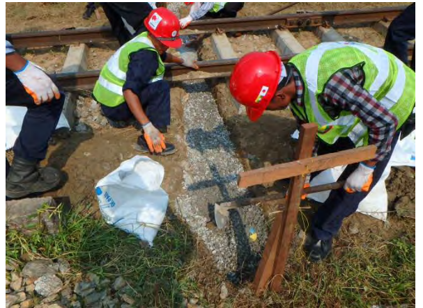
横断排水管敷設
