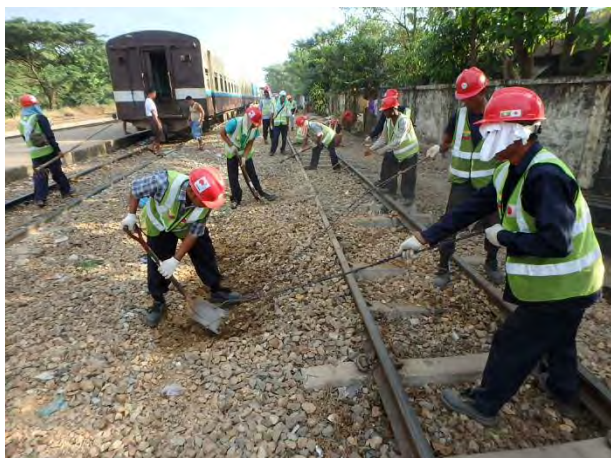
機廻し線の扛上準備でバラストかき上げ
