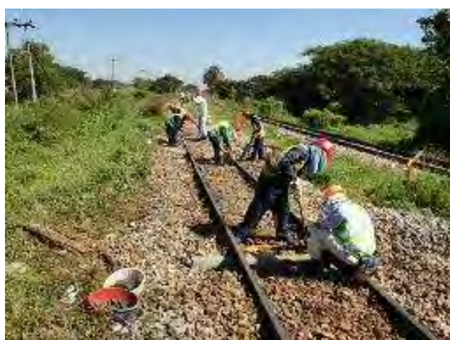
交換した箇所から水準を確認、つき固め
