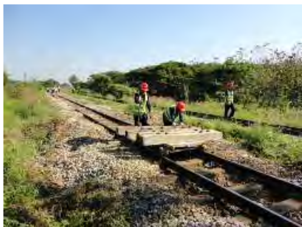
マクラギ交換はトロでの運搬作業から
