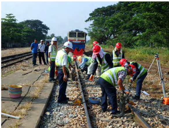
列車抑止してつき固め
