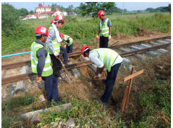
横断排水管敷設; 丁張で確認しながら掘削
