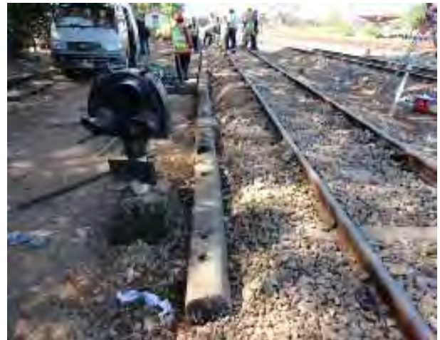
バラスト止め設置
