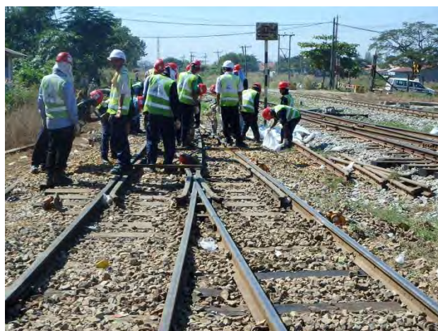
分岐器扛上
