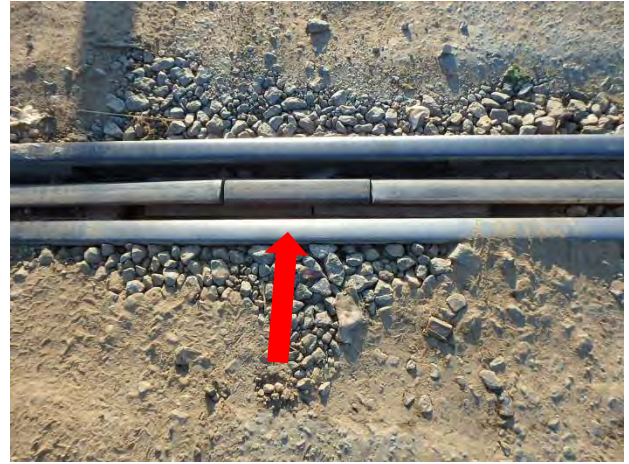
夜間作業で短尺レール交換の応急処置
