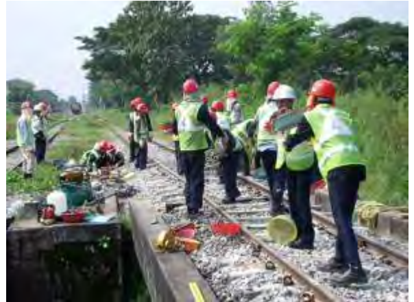
バケツリレーでバラスト小運搬
