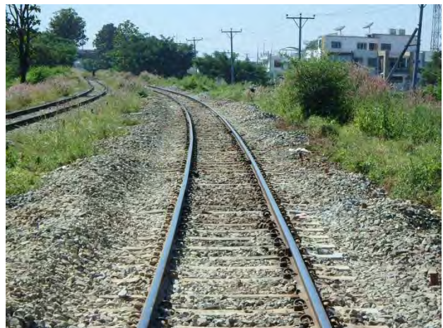
上り線 11k0m ヤンゴン方向施工後
