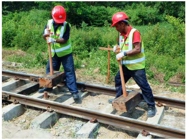
小たこで路盤転圧
