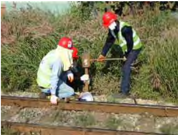
曲線整正用基準杭の設置
