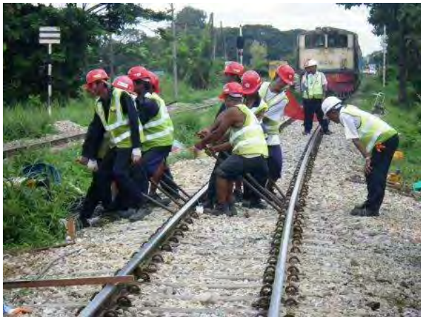
曲線整正(通り直し)
