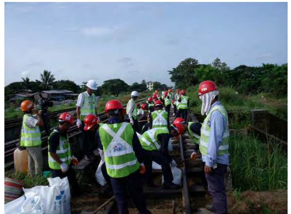
橋りょう部土砂すきとり
