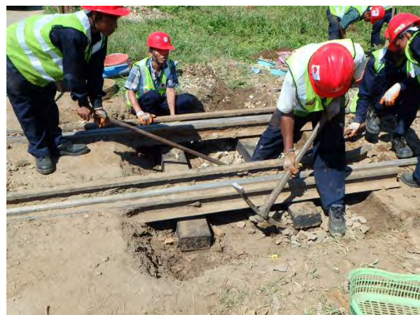
バラスト掘削とマクラギ交換
