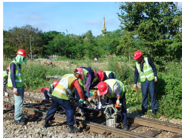
上り線 11k600 付近総つき固め
