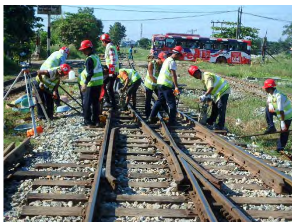
下り線 54A 号分岐器扛上
