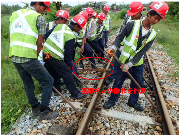
曲線部通り整正実習
