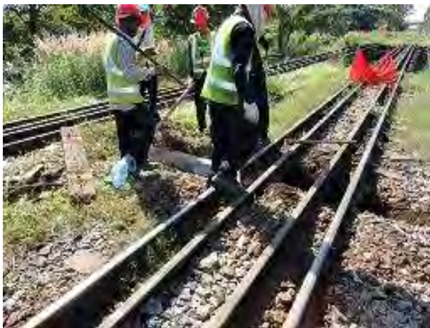
橋梁脇の安全レール区間でのマクラギ交
