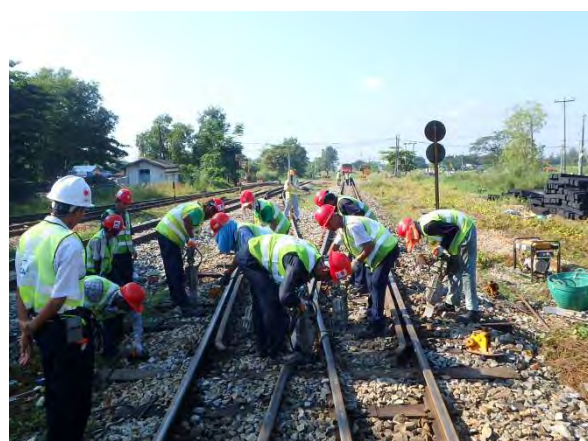
分岐器扛上 1
