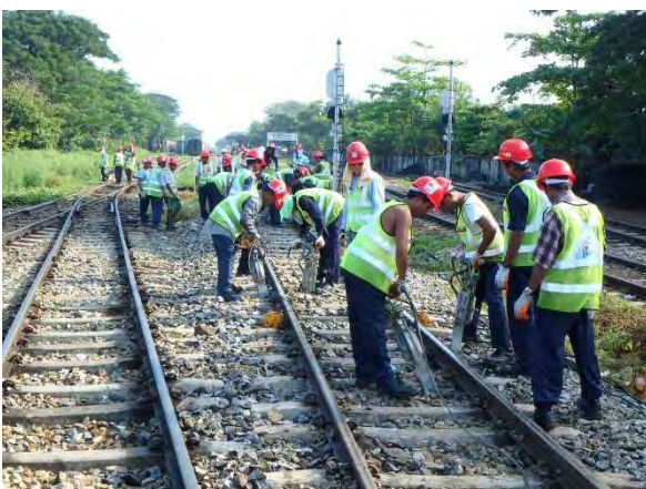
11k500m付近総つき固め
