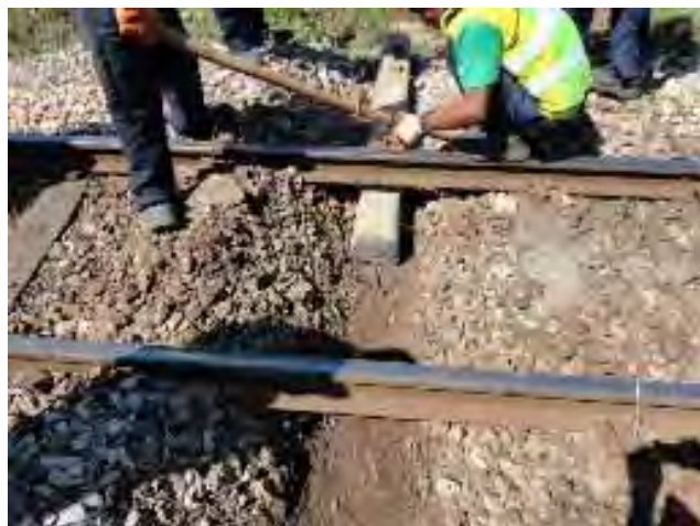
マクラギ下が直接土砂の箇所もあり (今後、レール扛上の予定)
