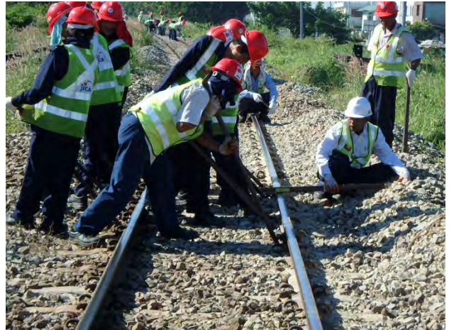
ボールによる曲線整正
