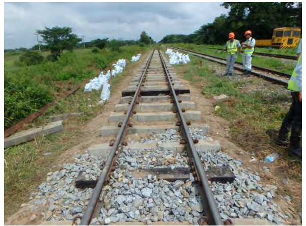
12k110m から大学方 (路盤施工中)
