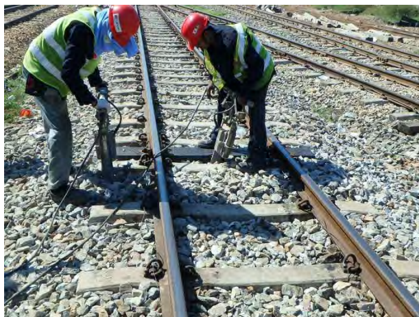
下り線絶縁継ぎ目部に木マクラギを挿入
