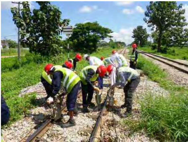
レール扛上(タイタンハンマーによる突き固め)
