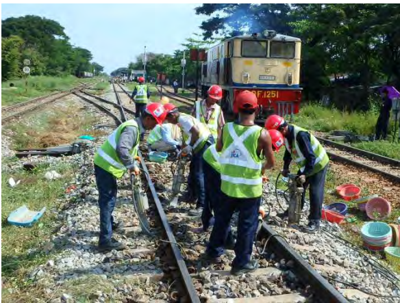
踏切～分岐器間のむら直し
