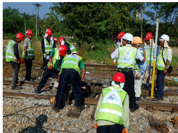
55A号分岐器扛上
