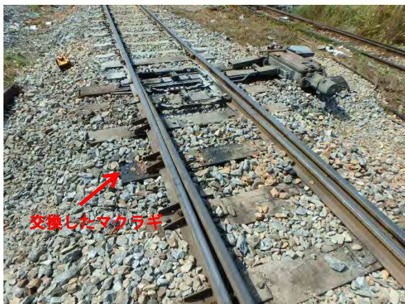
55A号分岐器施工後とマクラギ交換
