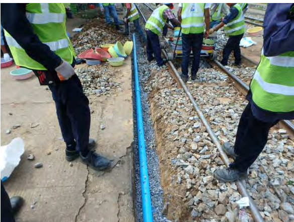
多孔排水管敷設
