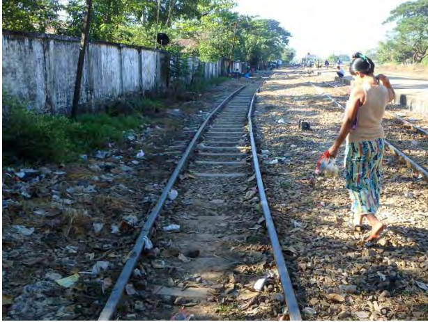
機回し線施工前
