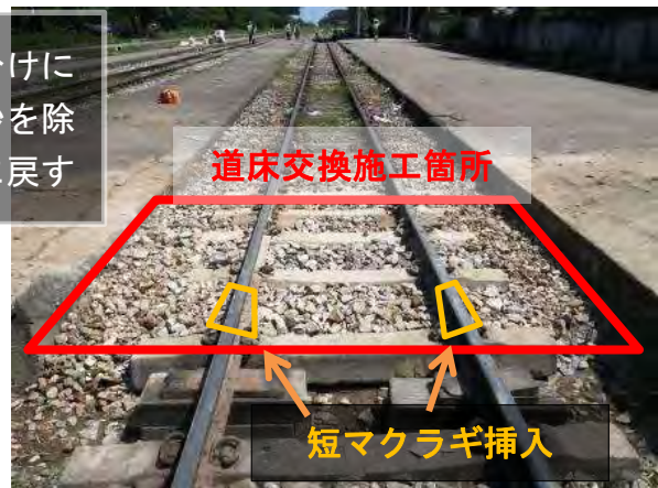
道床交換施工後(噴泥箇所)
