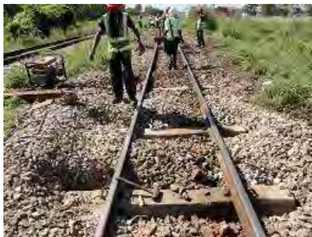
バラストの多い箇所では掘削が大変
