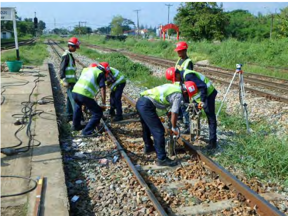
11k600m 付近総つき固め
