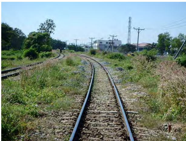
上り線 11k0m ヤンゴン方向施工前
