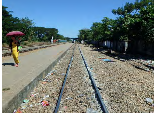
0k160m 駅方施工前
