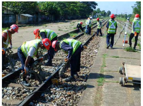
11k640m 付近レール扛上
