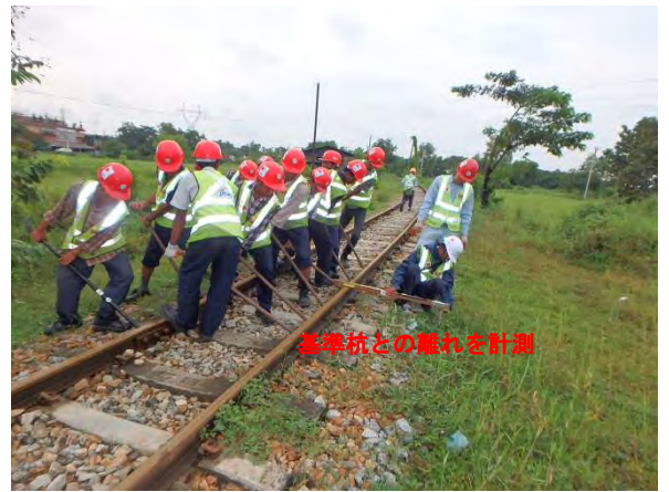
曲線部通り整正実習
