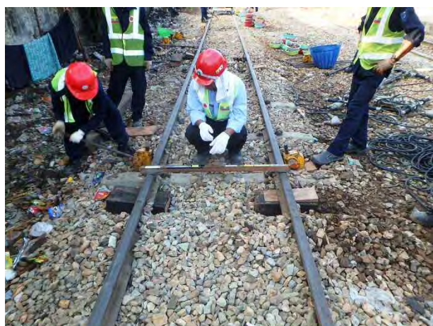
マクラギ、パッキンで仮受してレール扛上
