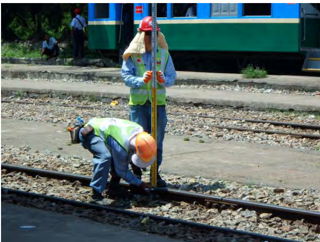
下り線縦断測量
