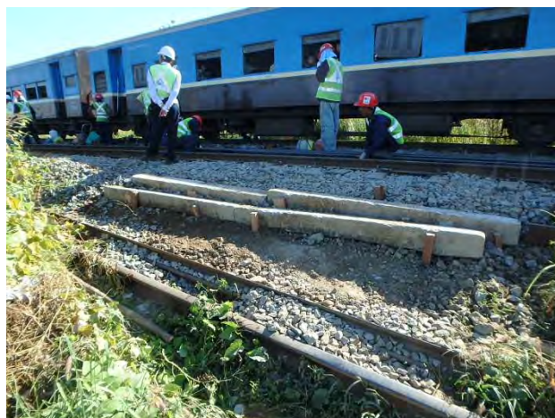
古 PC マクラギによるバラスト止め
