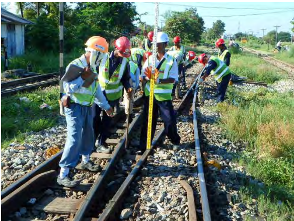
54A号分岐器扛上量確認
