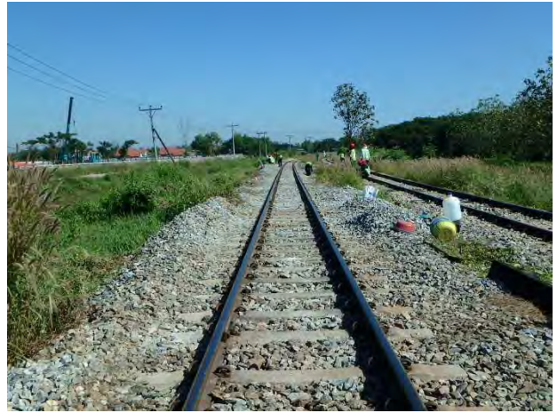
上り線 10k860m バゴ一方向施工後
