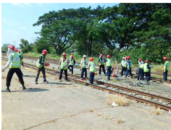
バラストリレーでバラスト運搬
