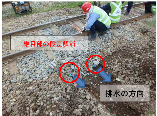
塩ビ管設置による排水処理
