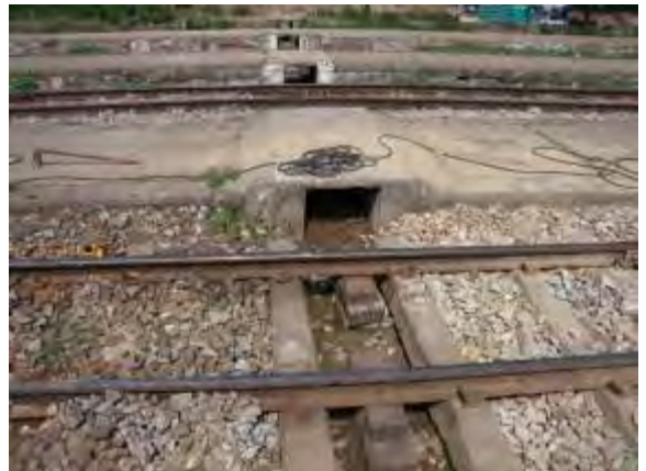
構内排水溝 清掃完了
