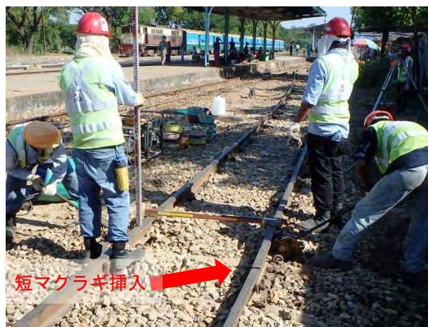
0k80m 付近レール扛上
