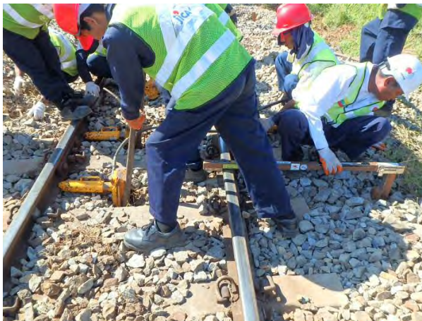
油圧ジャッキによる曲線整正
