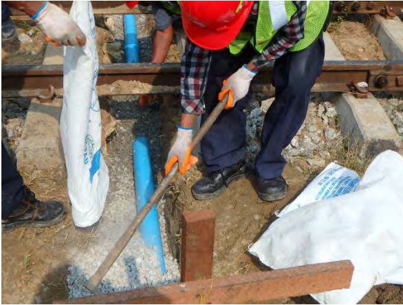
横断排水管を豆碎石で埋める。
