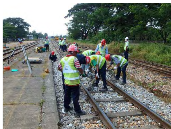
下り線 11k630 付近総つき固め
