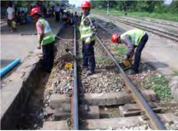
縦断排水 掘削
