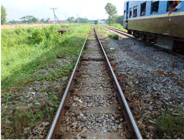
上り線 10k860m バゴ一方向施工前
