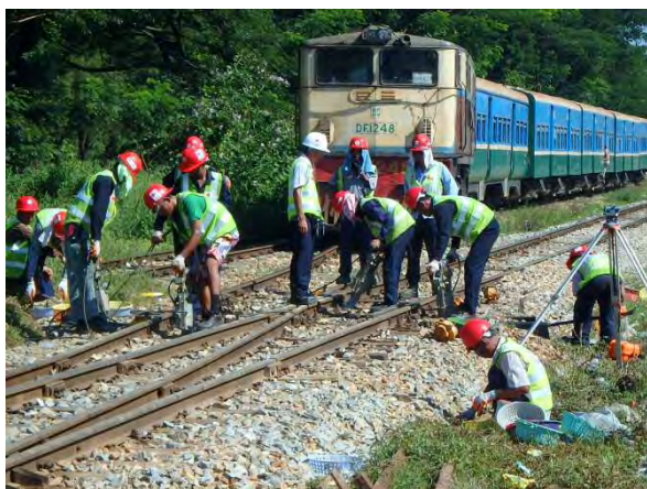
55A号分岐器扛上
