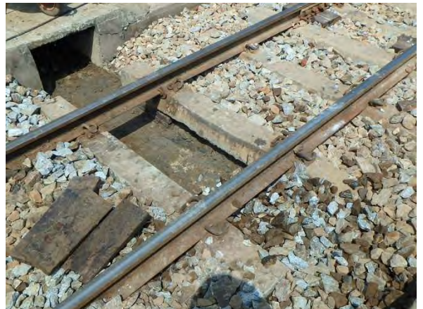
横断排水溝清掃・かさ上げ (11k726m)
