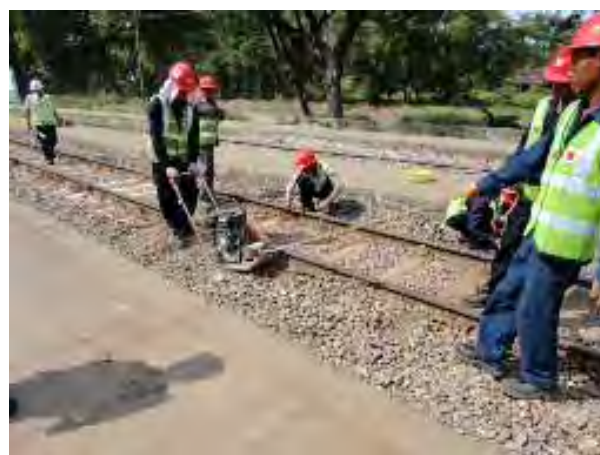
作業後はコンパクターで締固め
