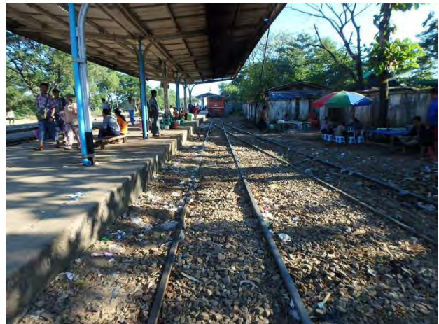
0k70m 駅方施工前
