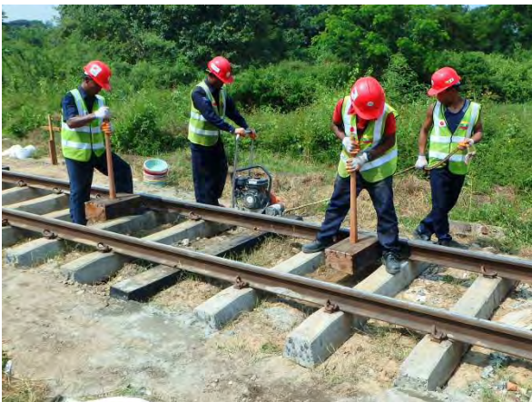
小たこ、タンパーで路盤転圧
