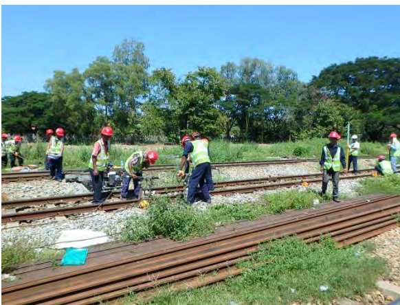
11k550m 付近総つき固め
