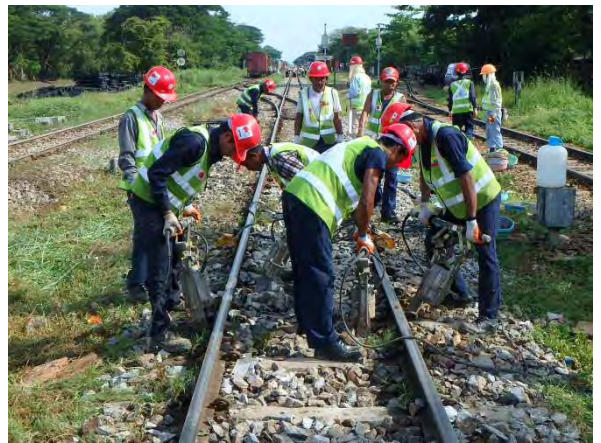
踏切脇のレール扛上
