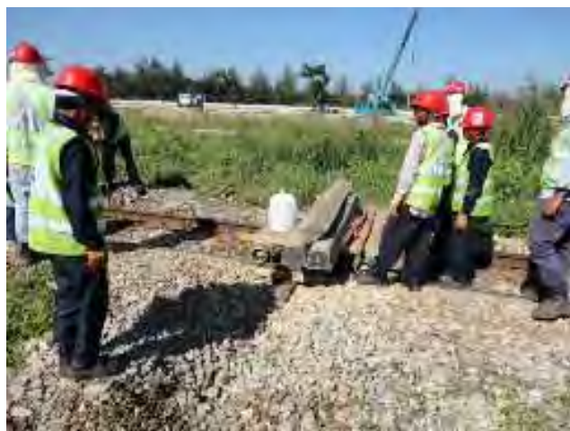
まず、PCマクラギを現場まで運搬
