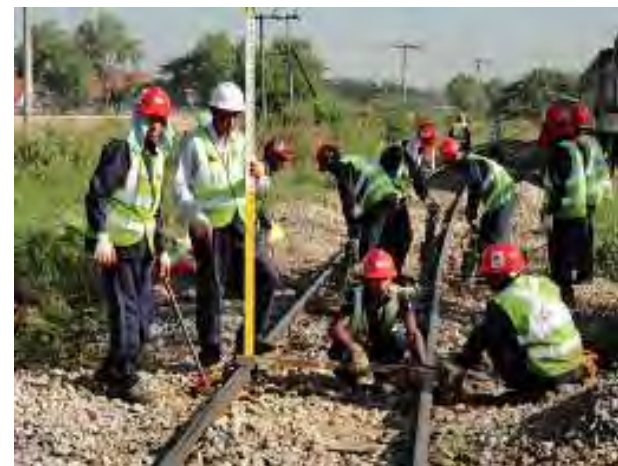
レベル測量と水準ゲージで扛上量を確認
