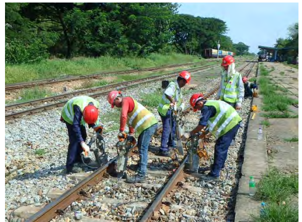
11k620m 付近総つき固め
