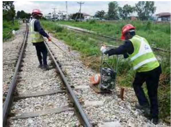
コンパクターによる道床締固め
