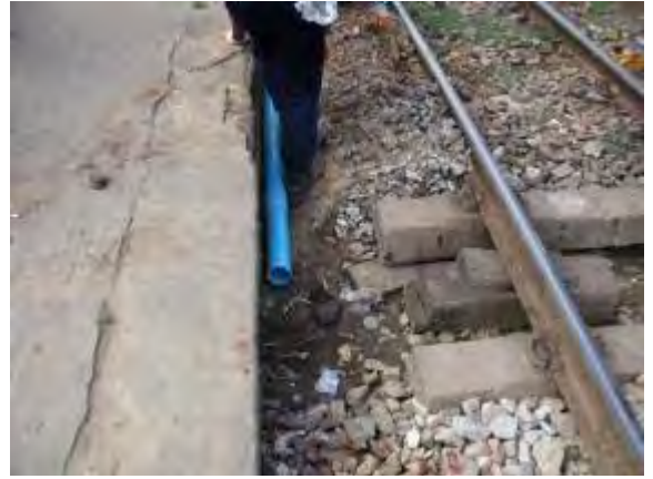
縦断排水管敷設
