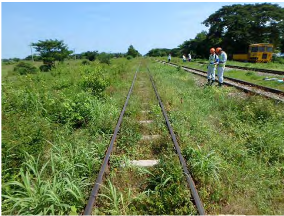
12k110m から大学方 (施工前)
