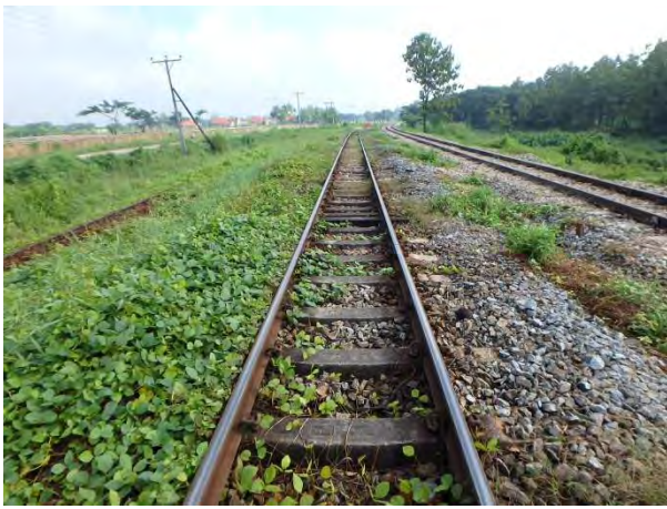
上り線 10k900m バゴ一方向施工前
