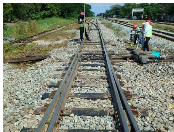
分岐器施工後検測
