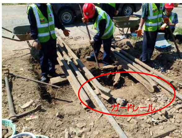
施工前 (ガードレールが上がっている)
