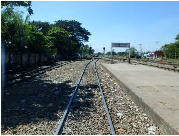
0k160m ティラワ方施工前
