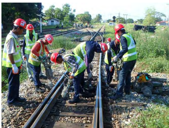
上り線 55A 号分岐器扛上
