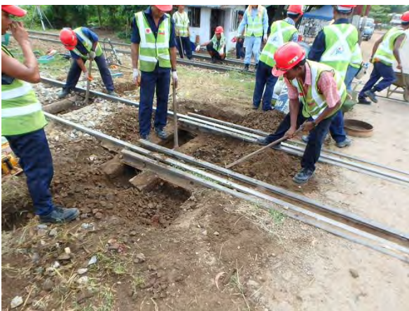
11k460m 付近バラスト交換のための掘削
