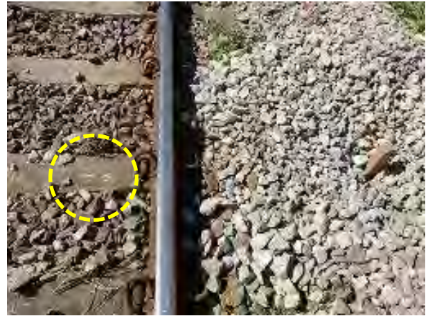
杭脇のマクラギ上にも移動量・方向を記入
