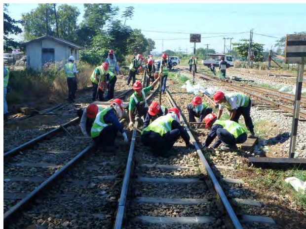
分岐マクラギ交換
