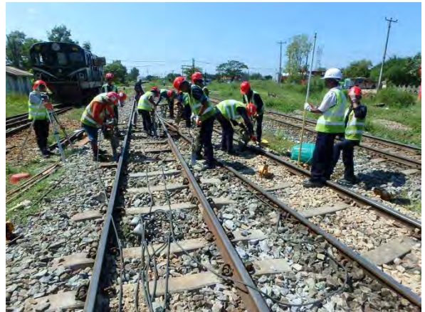
54A号分岐器つき固め
