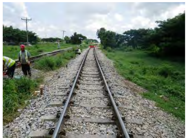
曲線整正施工後(本日 10/1)
