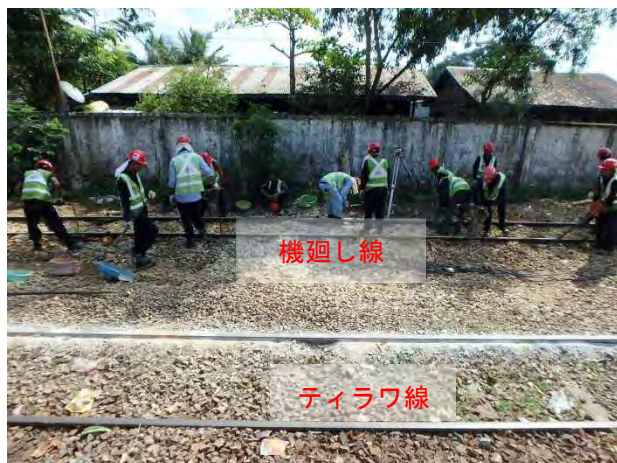
機廻し線 0k90m レール扛上
