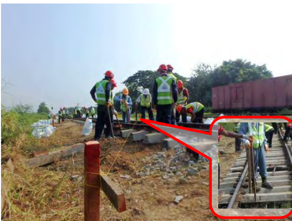
丁張から水系を張り、下がりで高さを確認
