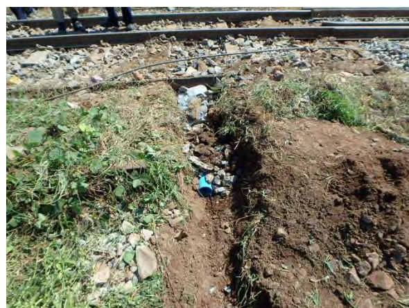
横断排水管敷設
