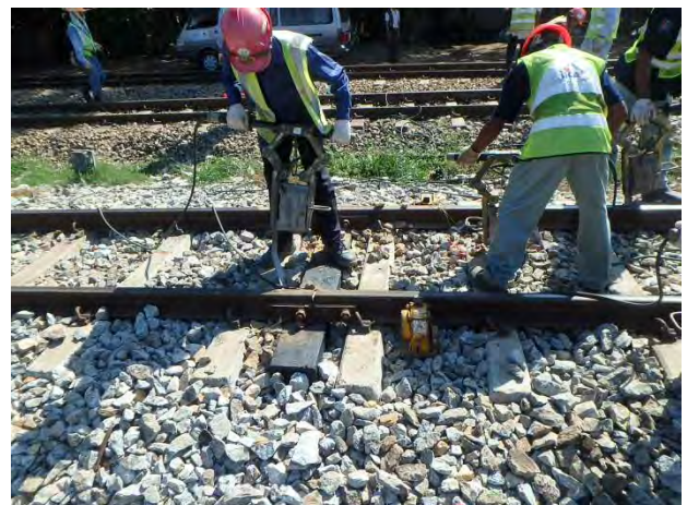
上り線絶縁継ぎ目部のむら直し
