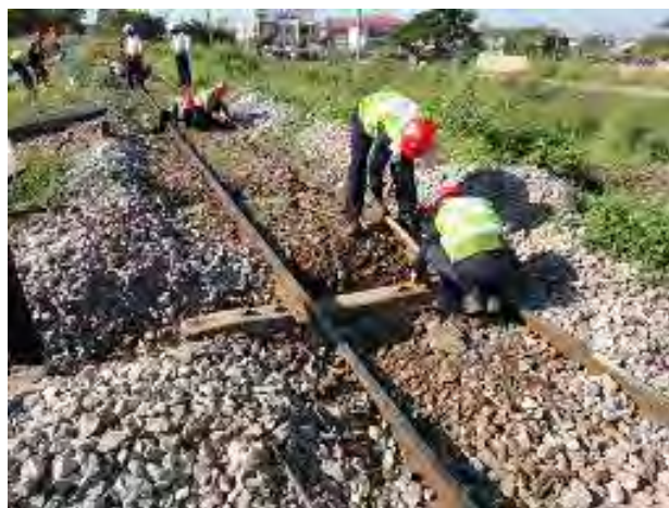
マクラギ撤去部をさらに掘削して挿入
