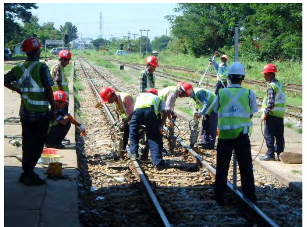
11k690m 付近総つき固め
