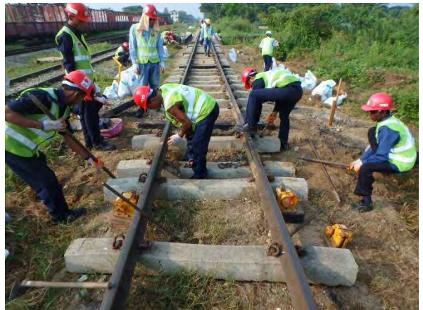
マクラギ位置整正
