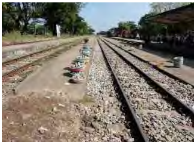
余剰バラストを撤去きれいな線路に
