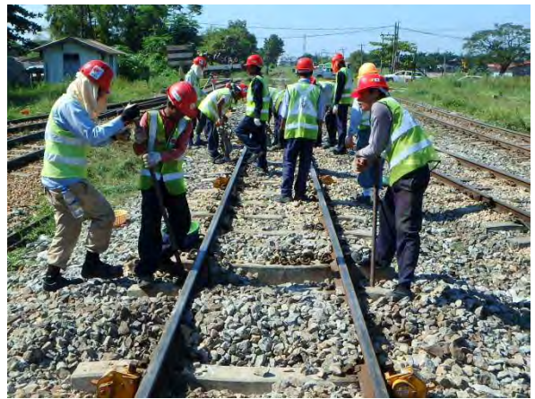
つき固めとマクラギ位置修正
