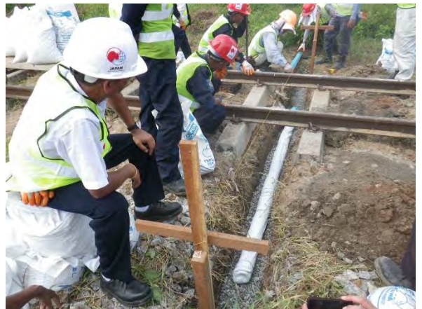
横断排水管設置
