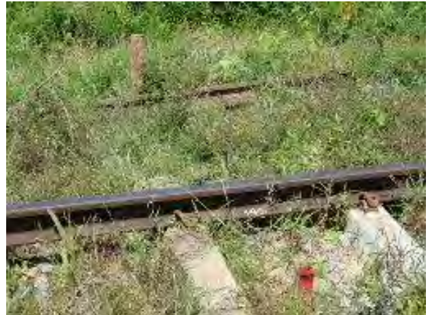
中心杭と丁張用杭
