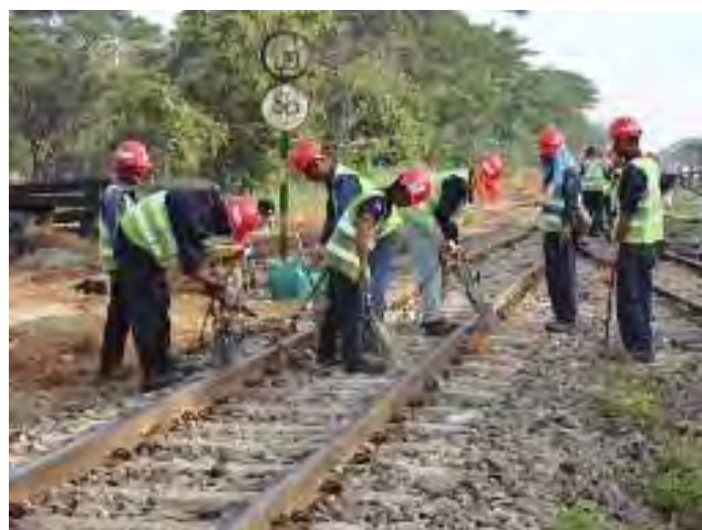
継目落ち箇所をむら直し
