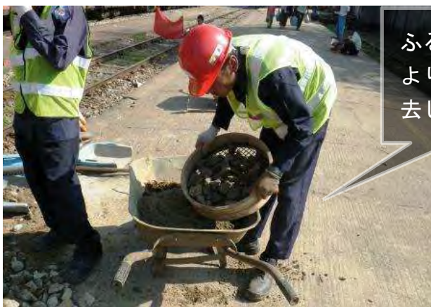
バラストのふるい分け(噴泥箇所)
