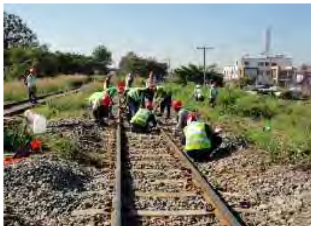
橋梁脇の凹部を2回に分けてレール扛上
