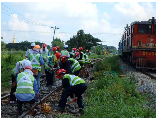
レール扛上(タイタンパー突き固め)
