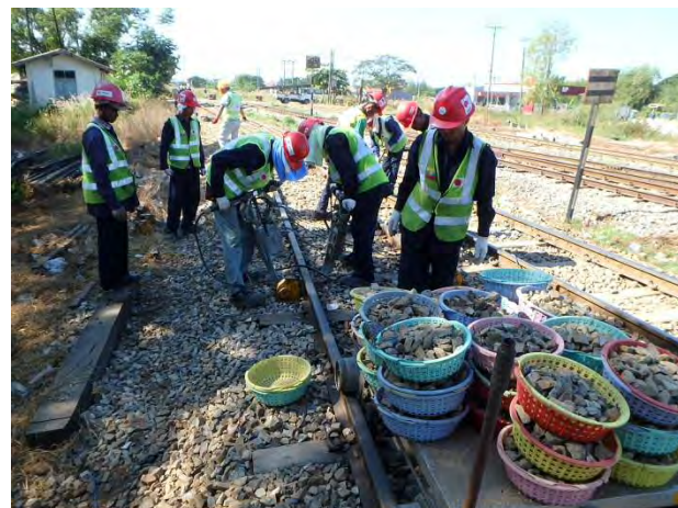
バラストを補充しながらの機回し線の扛上
