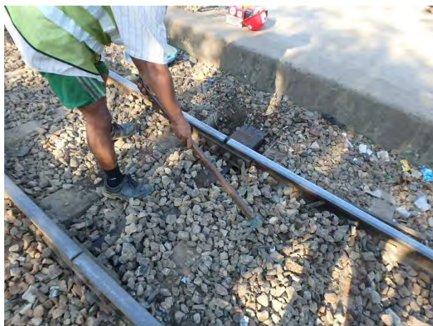
継目木マクラギ挿入
