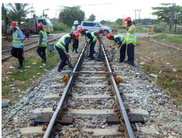
下り線踏切脇むら直しと継目短マクラギ挿入
