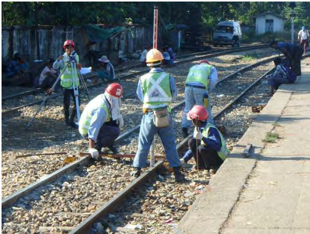
レール扛上量を検測
