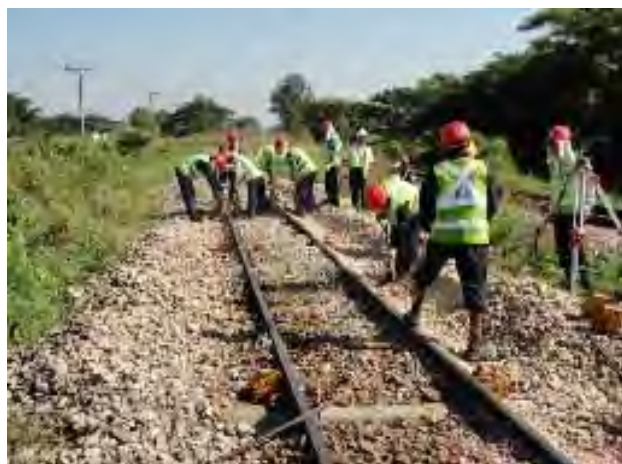
むら直し作業、レベルで扛上量を確認
