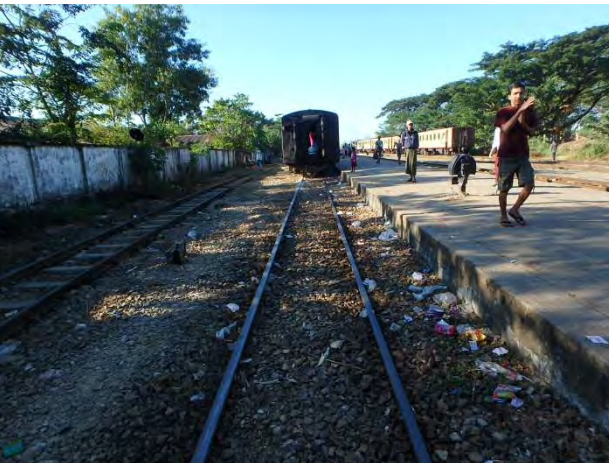
0k90m ティラワ方施工前
