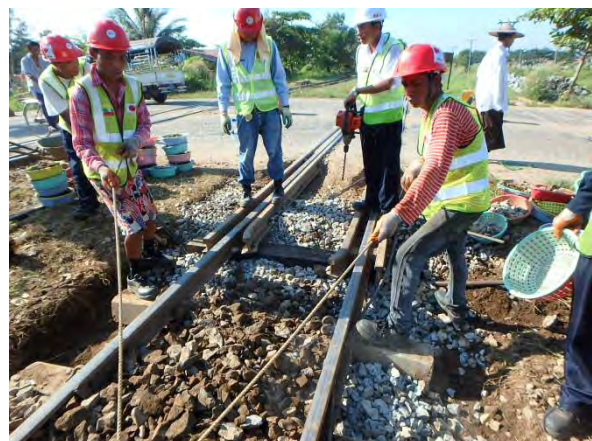
バラスト、マクラギ交換
