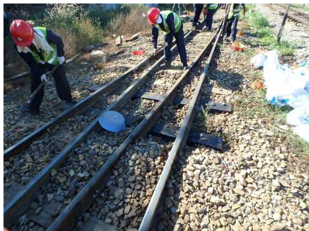
分岐マクラギ交換
