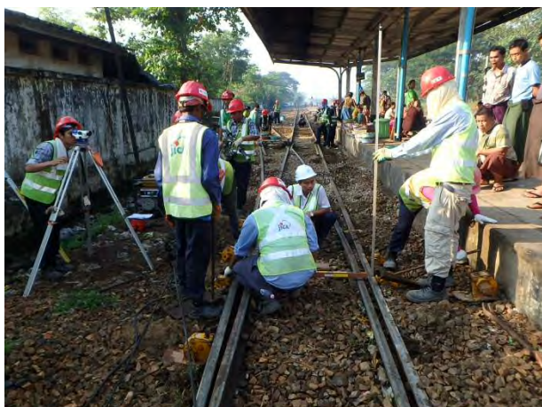
分岐器の扛上量設定
