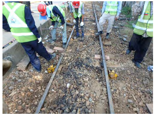
パッキンを入れ、レール扛上の予定だったが
