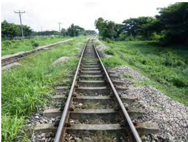
曲線整正施工前(9/12)
