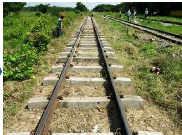
滞水箇所の除草(施工後)
