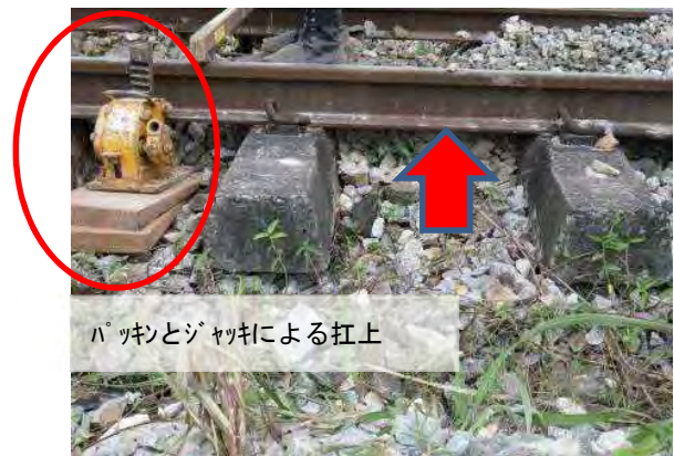
レール扛上(51A分岐器付近)
