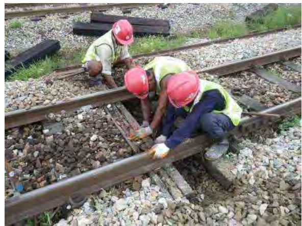
不良マクラギの交換の様子
