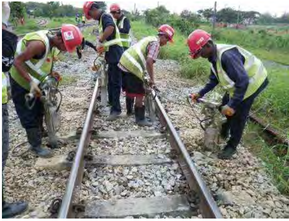
むら直しに伴う突き固め
