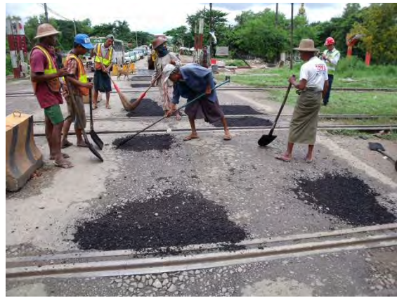
踏切舗装修繕 2 (都市側施工)
