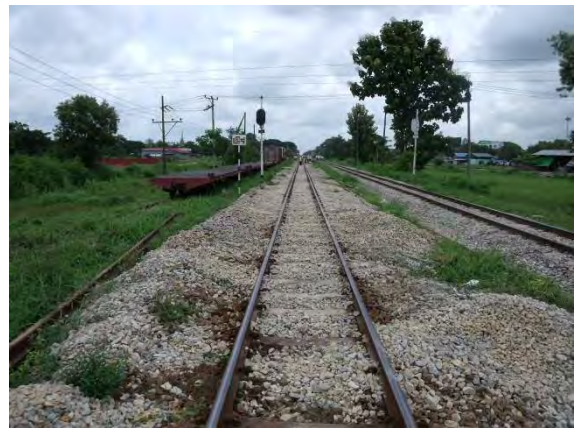
施工後 (ナモイ方より撮影)
