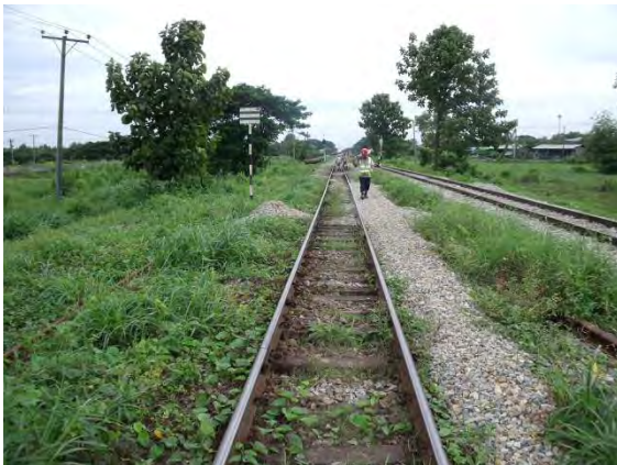
施工前 (ナモイ方より撮影)
