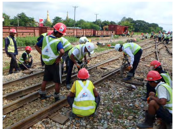
測量研修生もつき固め実習
