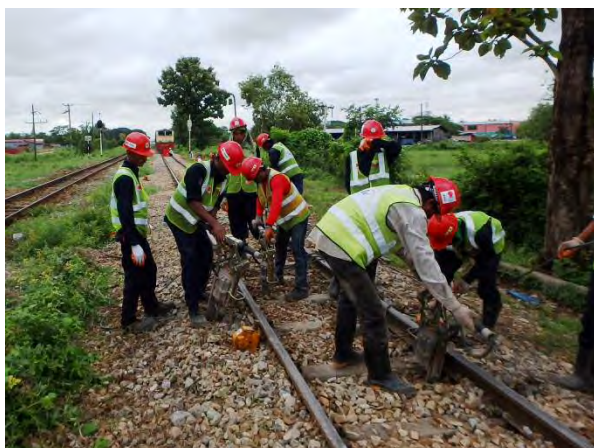
列車を抑止してむら直し
