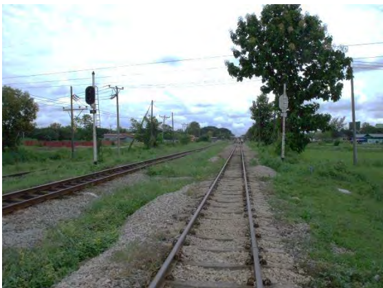
施工前 (ナモイ方より撮影)
