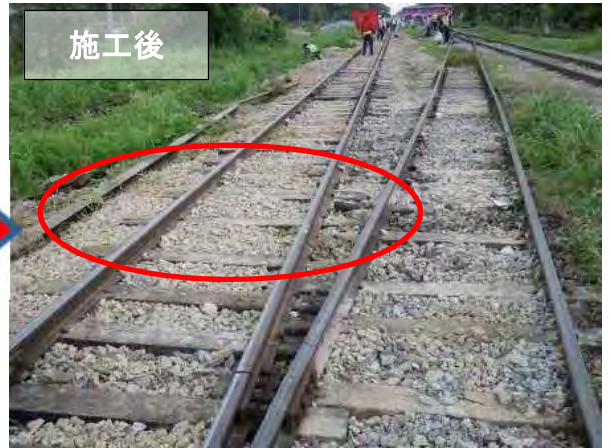
レール扛上(51A 分岐器付近)
