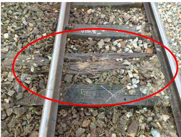
マクラギ位置整正・木マクラギ撤去
