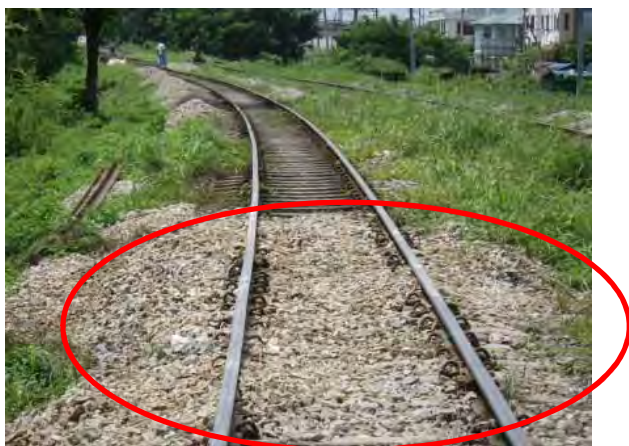
バラスト補充後の軌道
