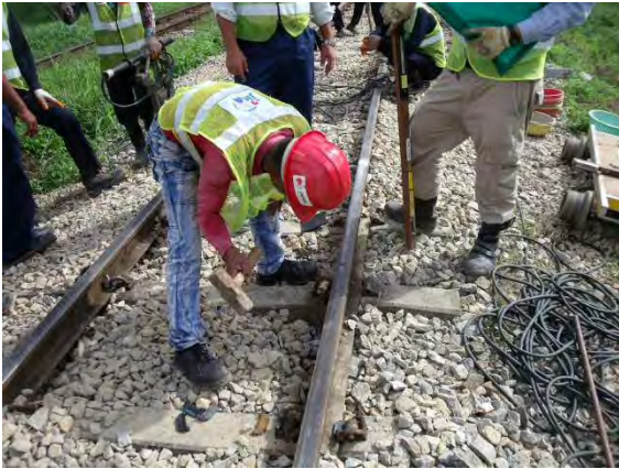
製作した道具を使ってクリップ定着
