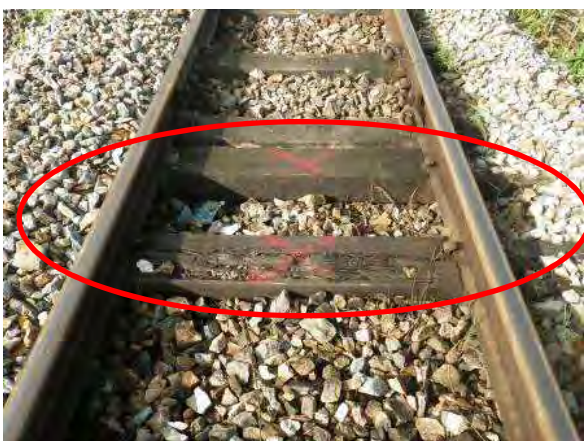
マクラギ不良交換(施工前)
