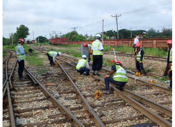
扛上量設定
