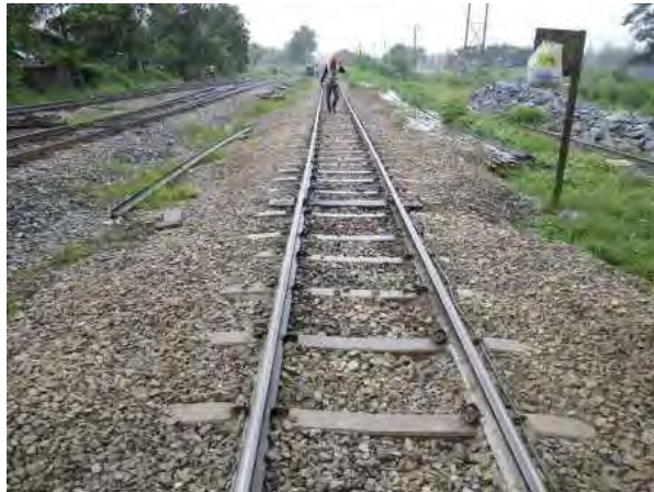
レール扛上後の様子(踏切手前)
