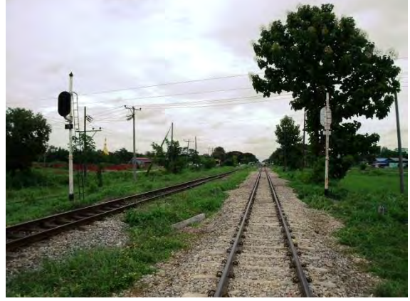
施工後（ナモイ方より撮影）
