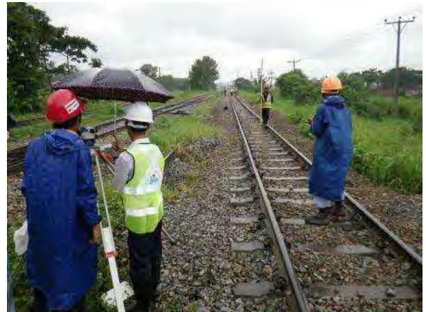
施工後の仕上がり確認(水準測量)
