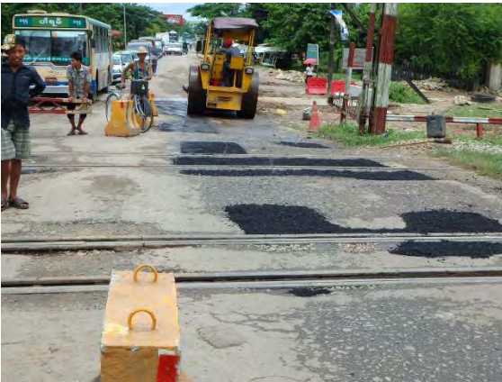
踏切舗装修繕 1 (都市側施工)
