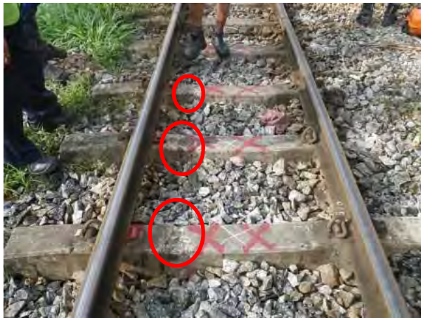
脱線痕の残る PC マクラギ
