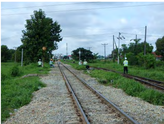
レベル3台を使用して測量研修
