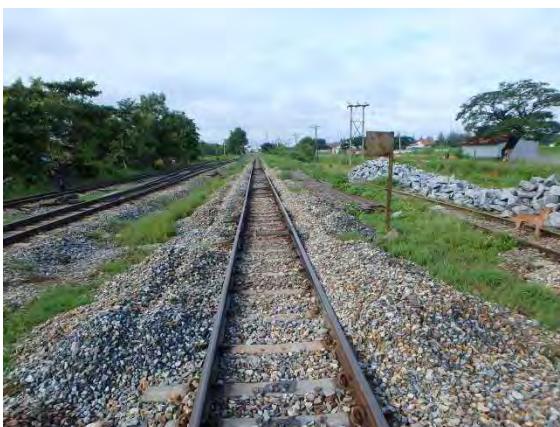
施工前(11k435m 踏切から)
