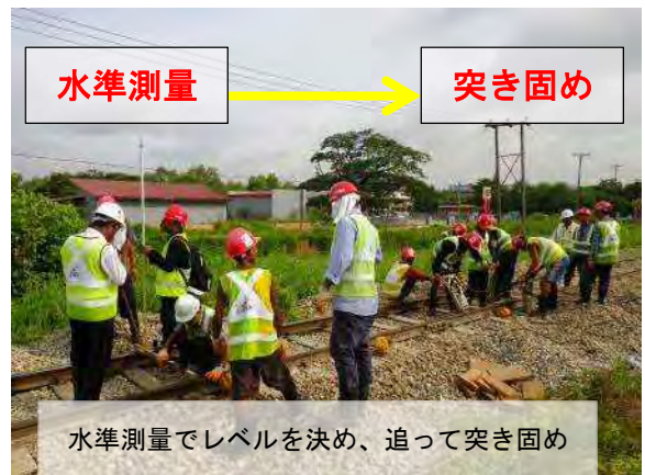
レール扛上の流れ
