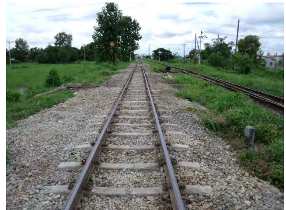
施工後（トウチャンカレー方より）
