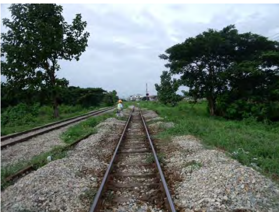
施工前 (トウチャンカレ方より撮影)
