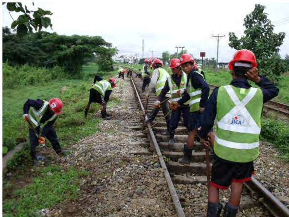
バラストかき上げ・整理
