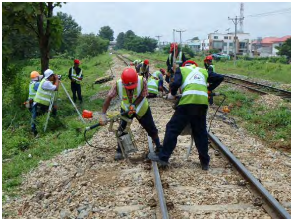
総つき固め (レール扛上)
