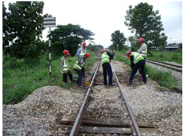
マクラギ位置整正及びマクラギ交換
