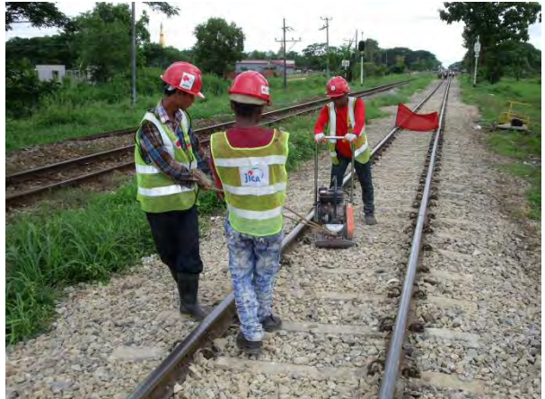
道床締固め
