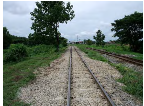
施工後（ナモイ方より撮影）
