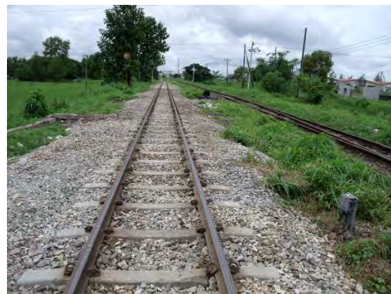
施工前（トウチャンカレー方より撮影）
