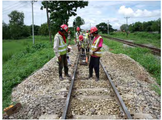
道床締固め
