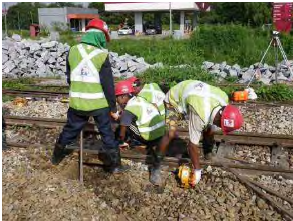
むら直し(水準変位の修繕中)
