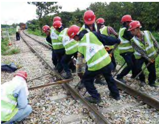
曲線整正(通り直し)
