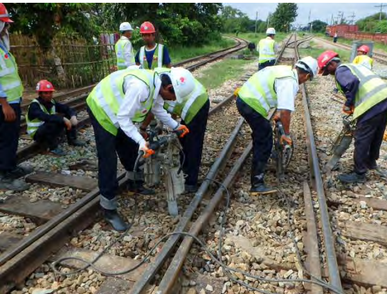
測量研修生もつき固め実習
