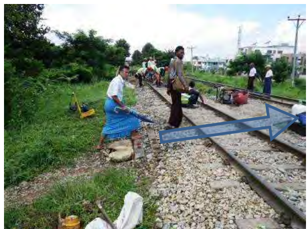
作業現場は通行者の多い作場道
