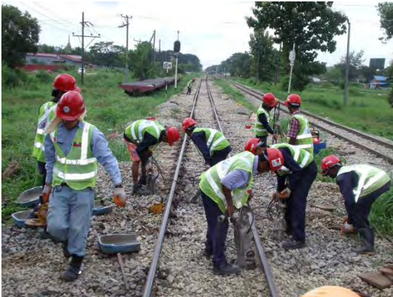
総つき固め 11k145m 付近
