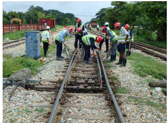
分岐器でのむら直し
