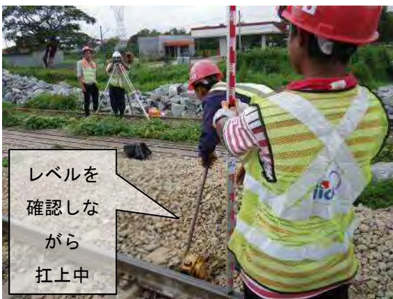
レール扛上の様子
