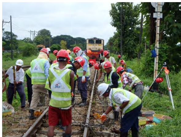
列車を抑止して総つき固め
