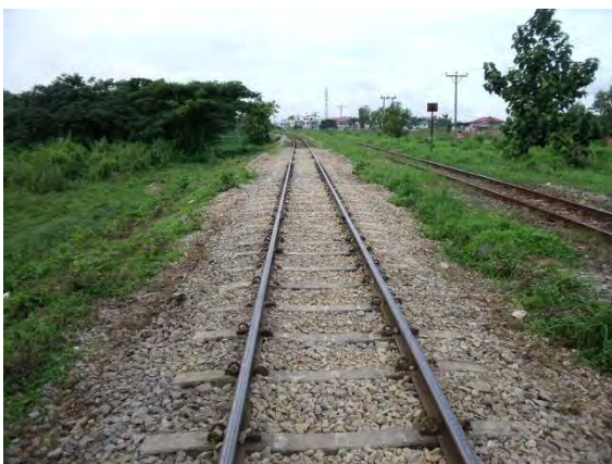
施工前 (ナモイ方より撮影)
