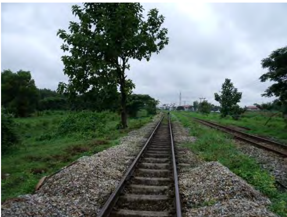
施工前（ナモイ方より撮影）
