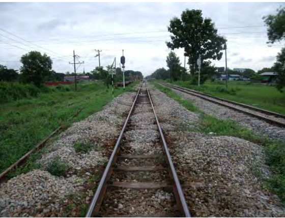
施工前 (ナモイ方より撮影)
