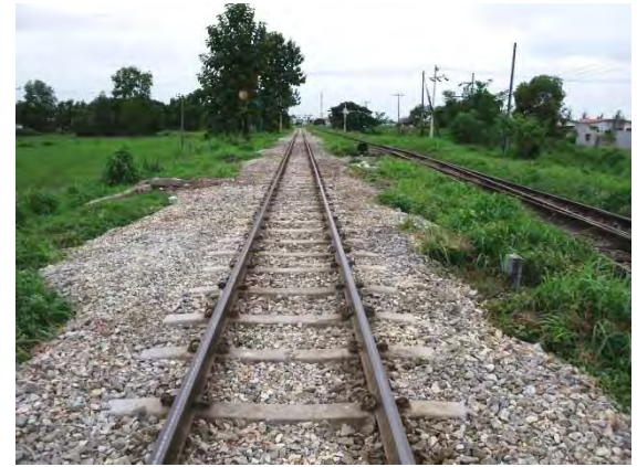
施工後（トウチャンカレー方より撮影）
