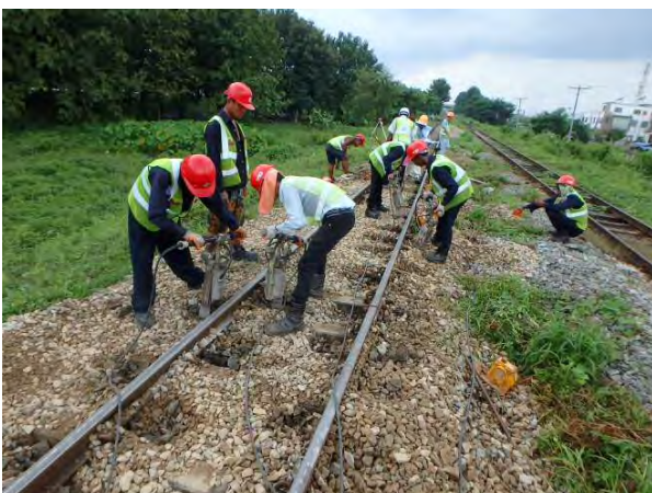
総つき固め (レール扛上)
