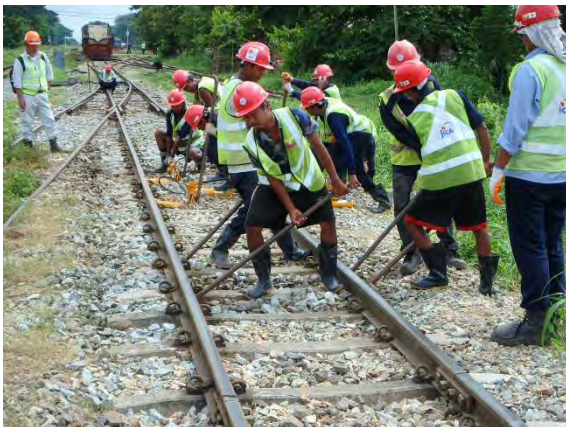
曲線整正器も使用し通り直し
