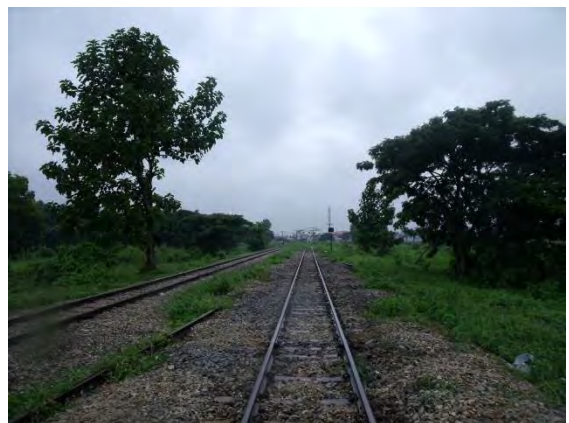
施工後 (トウチャンカレ方より撮影)
