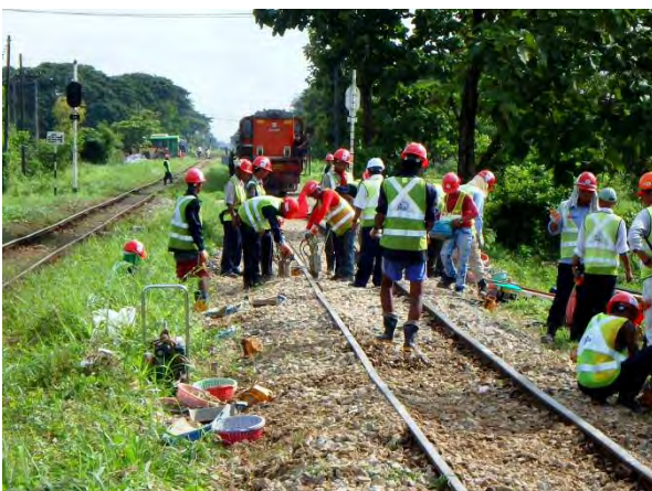
列車を抑止してつき固め
