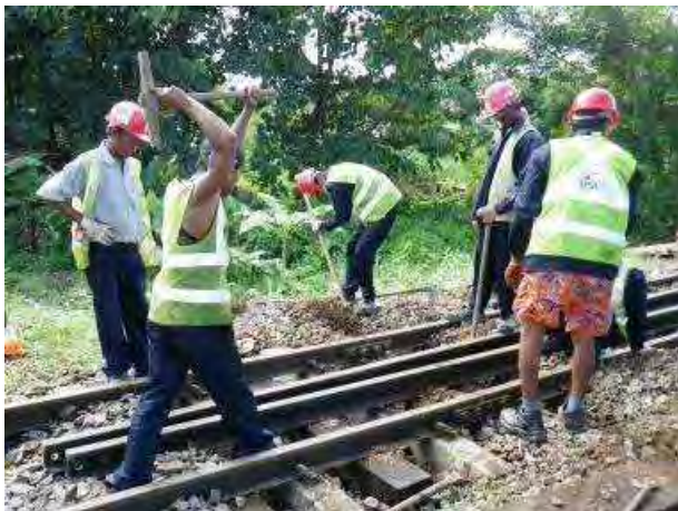
ガードレールを固定する木マクラギ交換
