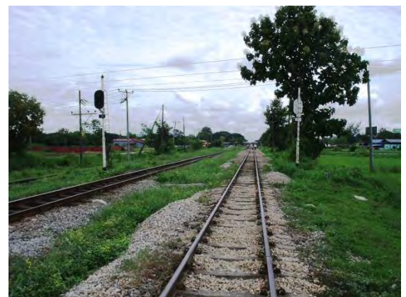
施工後（ナモイ方より）
