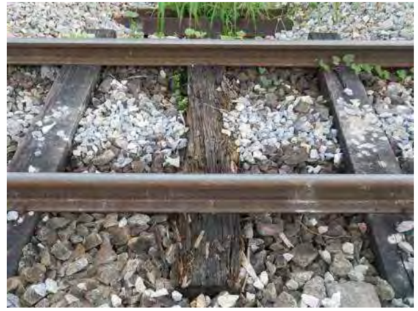
締結力・支持力を失った木マクラギ
