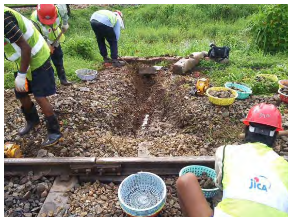
排水設備整備
