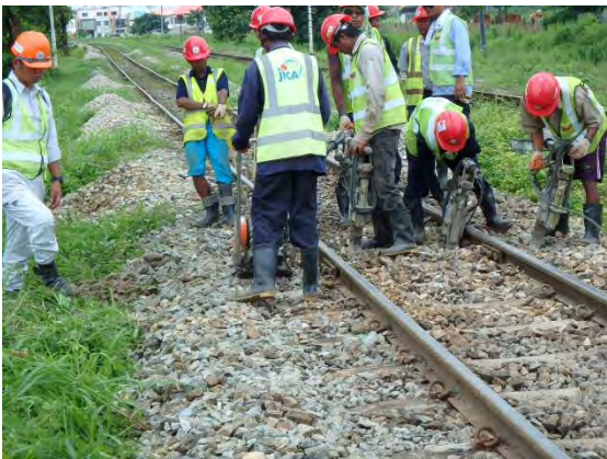
道床締固めとつき固め
