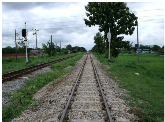
施工後 (ナモイ方より撮影)
