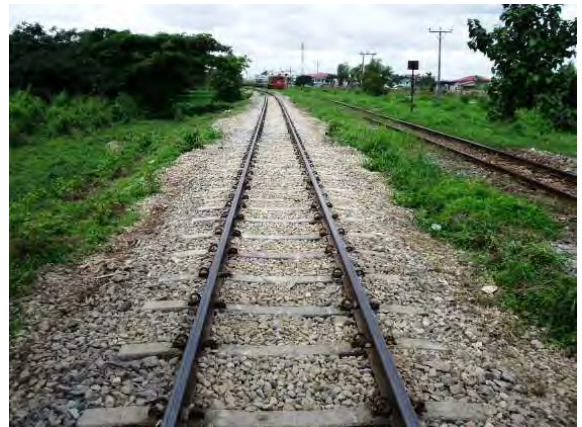
施工後 (ナモイ方より撮影)
