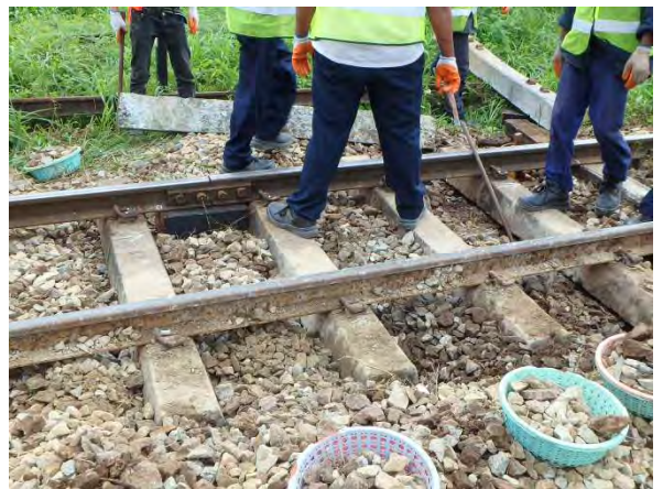
マクラギ位置整正及び継目短マクラギ挿入
