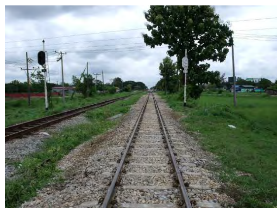
施工前（ナモイ方より撮影）
