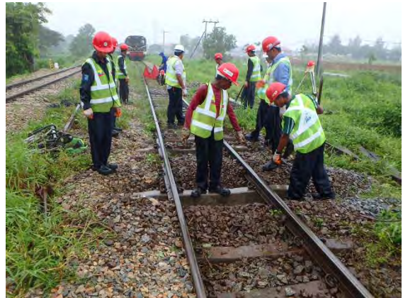
雨の中で列車を抑止してマクラギ交換
