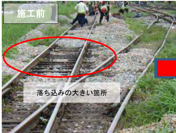
レール扛上(51A 分岐器付近)
