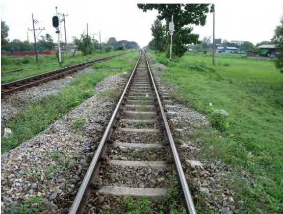
施工前（ナモイ方より）
