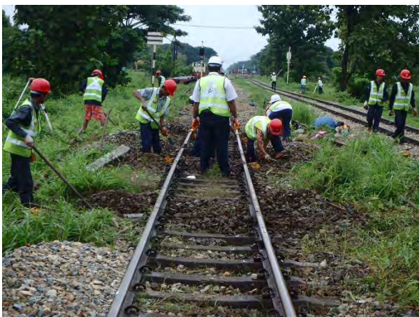
マクラギ交換(PCマクラギ挿入)
