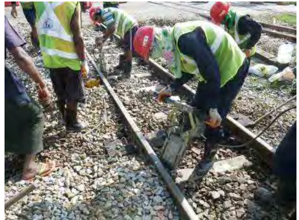
むら直し(タイタン-による突き固め)
