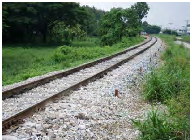
曲線整正を終えた軌道
