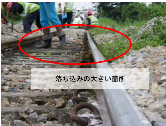
レール扛上(51A分岐器付近)
