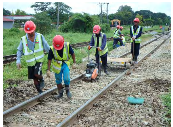
道床締固め
