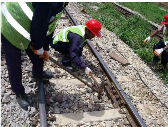
継目部短マクラギ挿入
