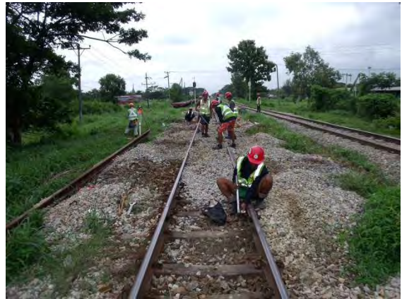
継目ボルト交換
