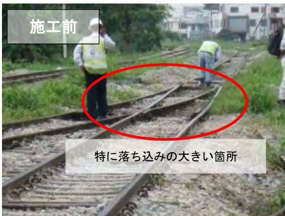
レール扛上(51A号分岐器付近)(施工前)
