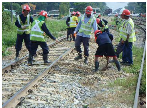
バラストかき上げの様子
