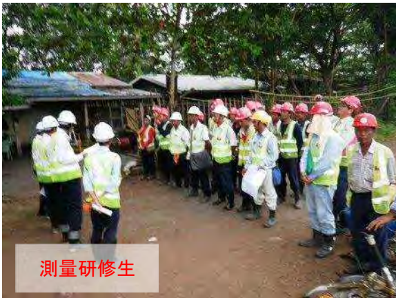
測量研修生による現場点呼の様子
