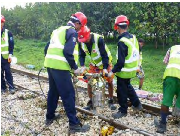
むら直し(タイタンによる突き固め)
