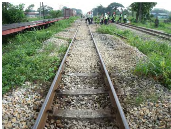
施工前 (ナモイ方より撮影)
