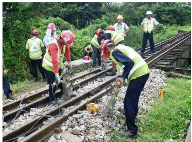
マクラギ交換後の突き固め
