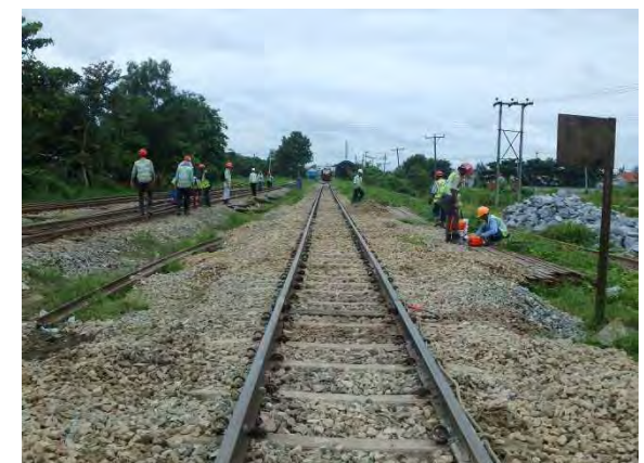
施工後(11k435m 踏切から)
