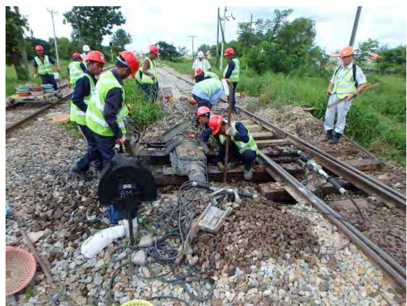
51号分岐器の盤下げ
