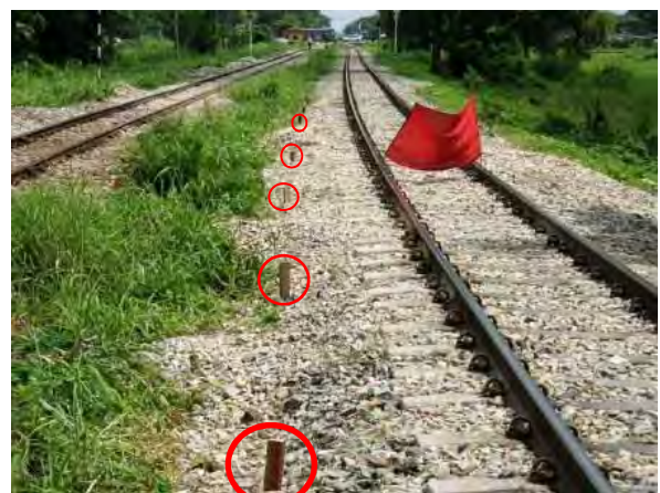
基準杭設置の様子
