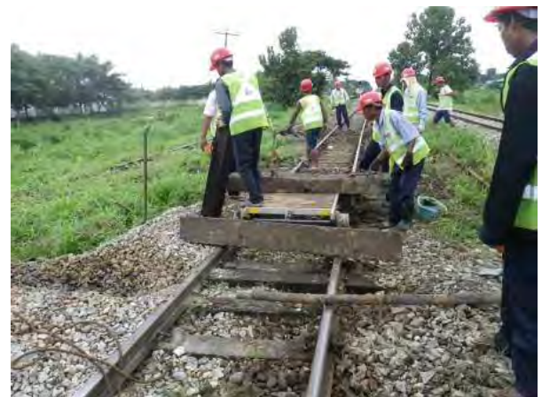
マクラギ交換(マクラギ運搬)
