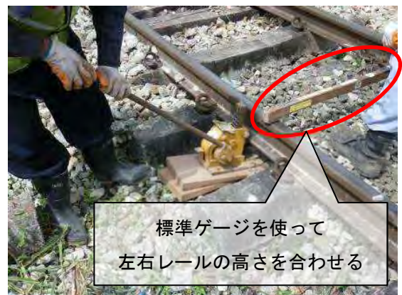
レール扛上の様子
