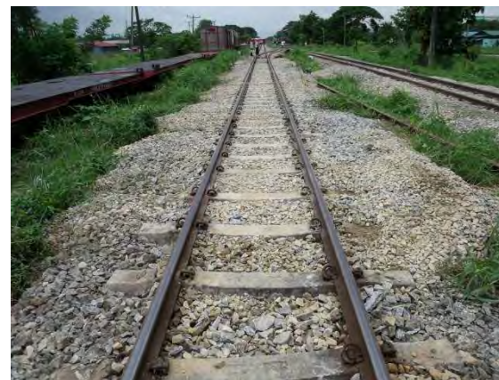
施工後 (ナモイ方より撮影)
