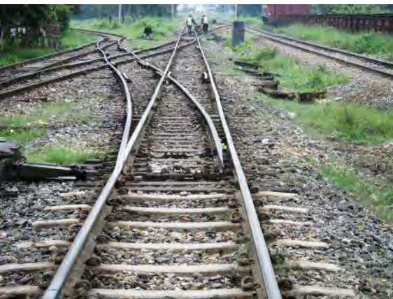
むら直しが不完全な分岐器
