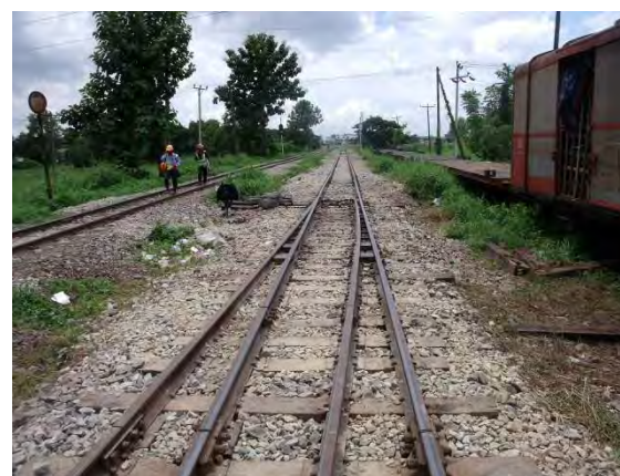
施工後 (トウチャンカレー方より撮影)
