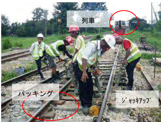
ジャッキアップ後にパッキンを仮挿入し列車を通す
