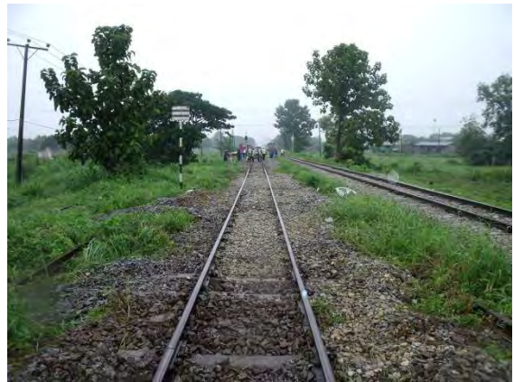
施工後 (ナモイ方より撮影)
