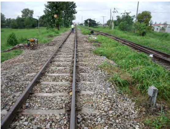
施工前（トウチャンカレー方より）
