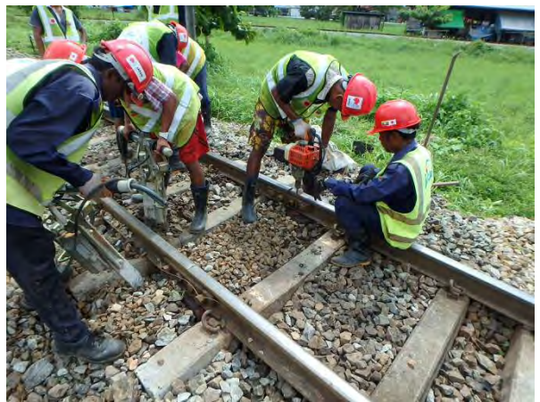
継目短マクラギ穿孔とつき固め
