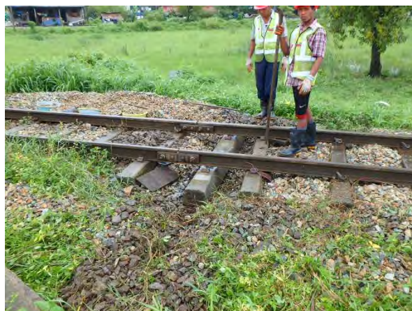
PCマクラギ交換と位置修正
