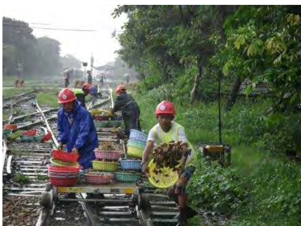
雨の中、分岐器部へバラスト補充
