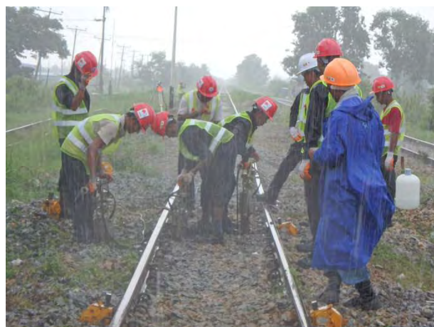
スコールの中の総つき固め
