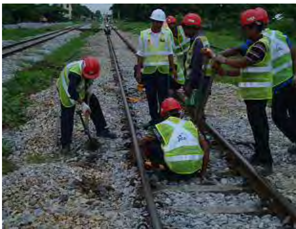
通り修正機セッティングの状況
