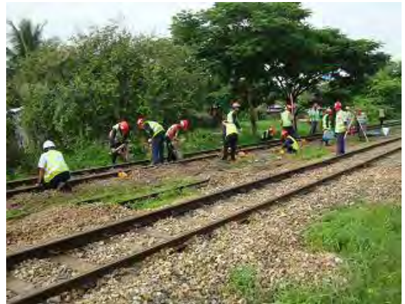
突き固めの状況
