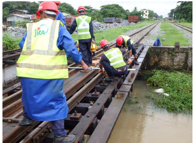
橋りょうレール扛上
