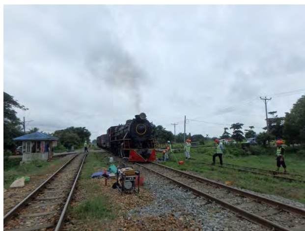
レベル測量中蒸気機関車の通過
