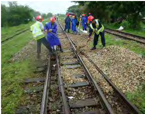
分岐器内へのバラスト掻き入れ
