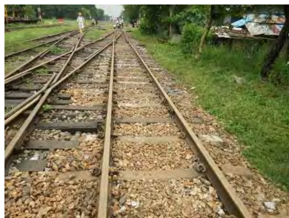
むら直し後の軌道状態(分岐器部)
