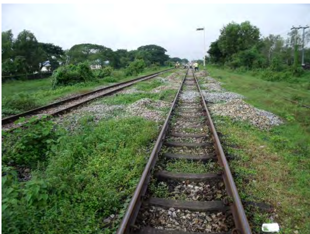
13 k 040mよりヤンゴン方 (施工前)
