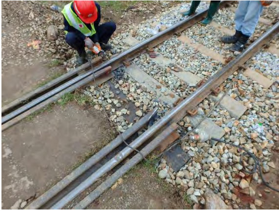
ガードレール切断面加工
