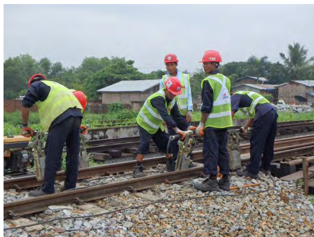
アバット部からレール扛上
