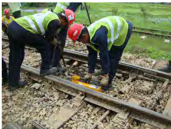
分岐器部の通り直し（機械使用）
