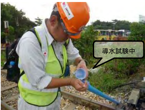
塩ビ管による排水管設置①
