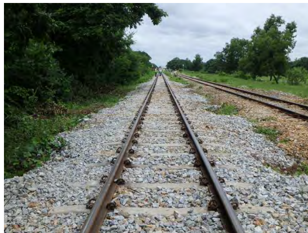
作業終了後(ヤンゴン方)の状況
