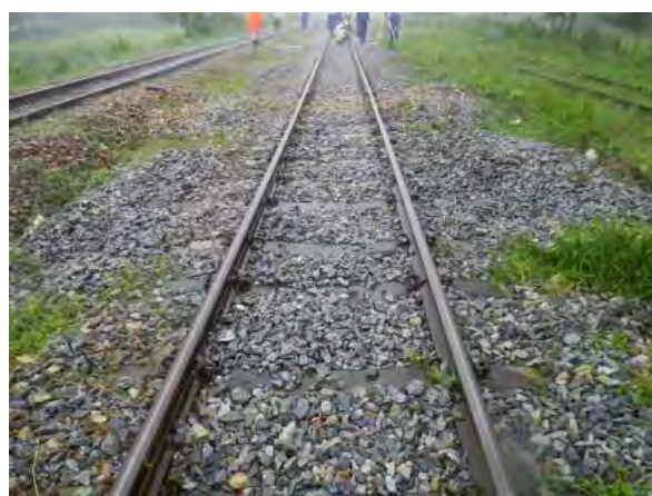
施工後 12k930m よりヤンゴン方
