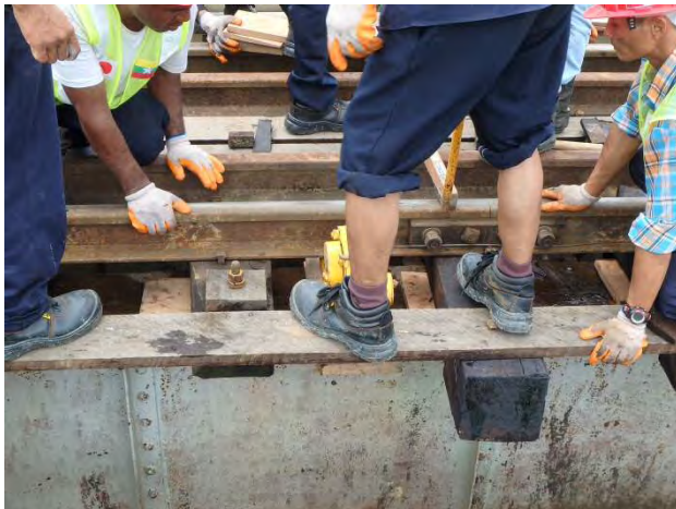
橋りょう継ぎ目部扛上
