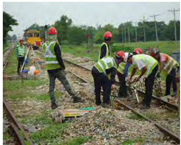
レールこう上、突き固め (RGB (保守用車) を抑止中)
