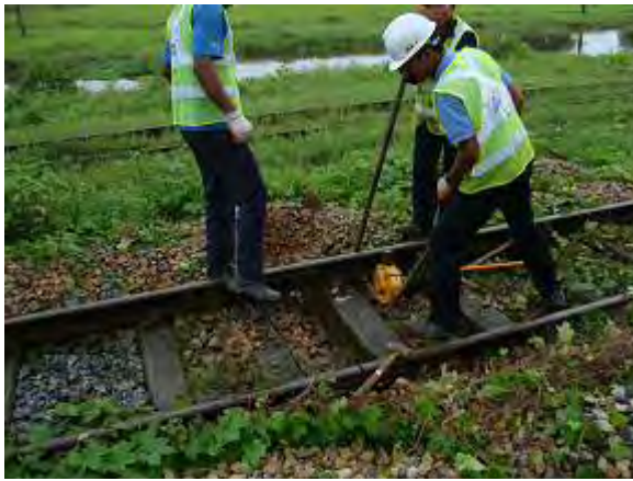
マクラギ位置修正
