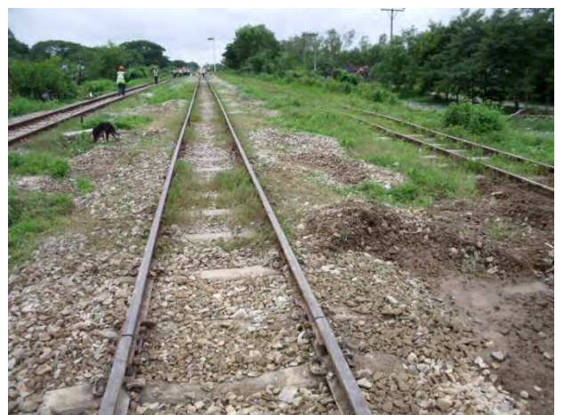
13 k 040mよりヤンゴン方 (施工後)
