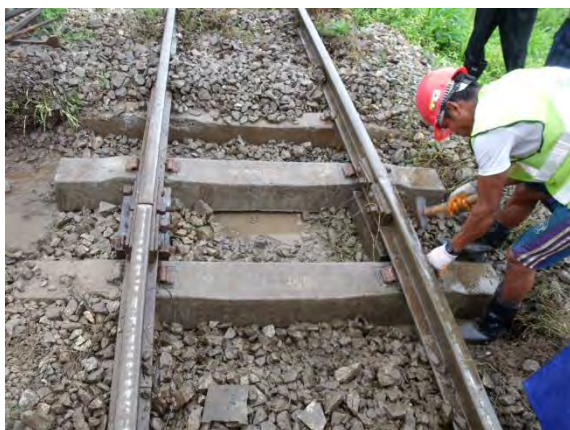
継目部短マクラギ挿入
