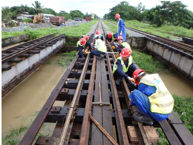
橋りょうフックボルト解禁
