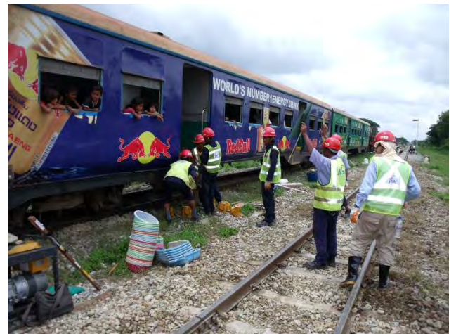
営業列車も資材運搬に協力してくれます。
