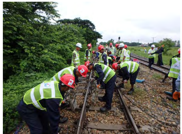
総つき固め (タイタンパー8基)
