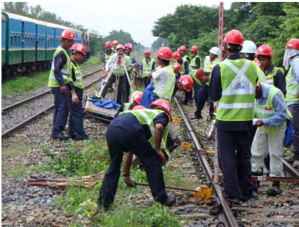
レベル測量で、扛上量を測定
