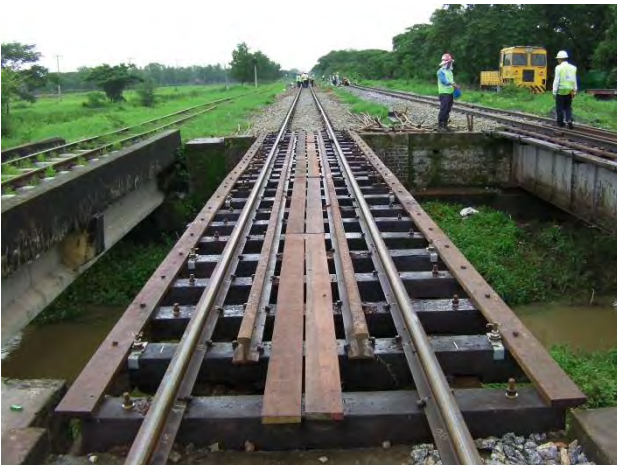
上り線橋りょう バゴ一方
