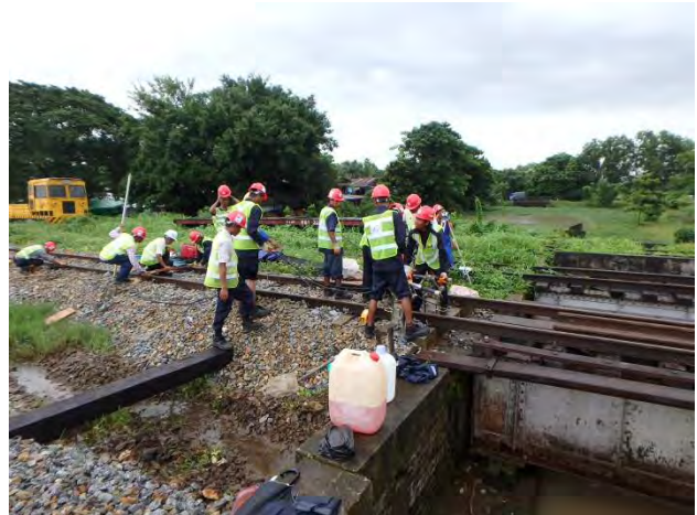
アバット部つき固め
