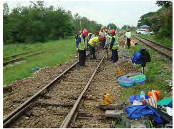
突き固め状況（上り線）
