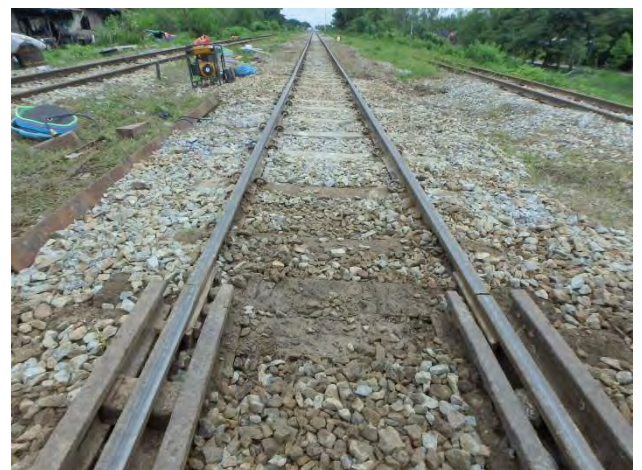
13 k 050mよりヤンゴン方 (施工後)
