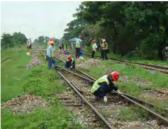
施工前の検測状況 (上り線)
