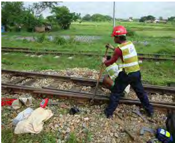
分岐器部ボルト修正
