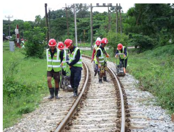
道床肩締固め
