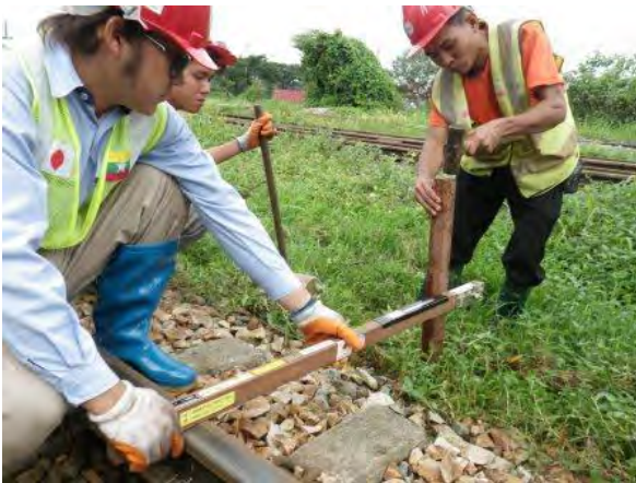
基準杭打ちの様子
