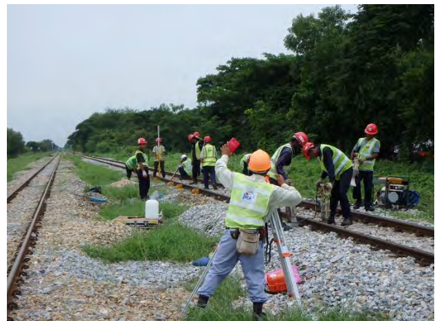
下り線 12k100m 付近レール扛上
