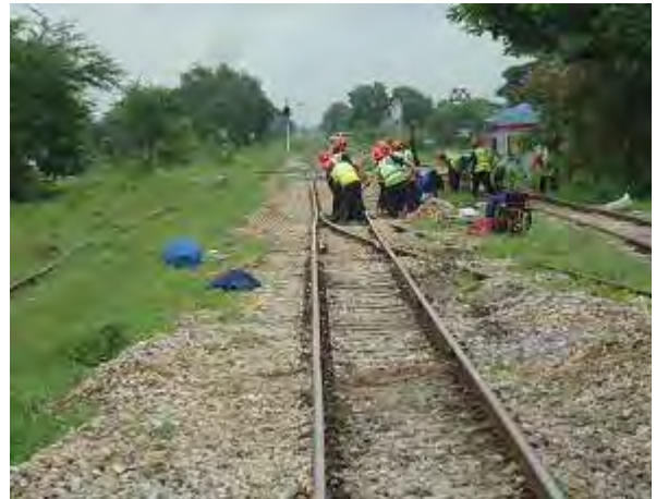
分岐器部の通り直し (人力では作業が進みませんでした)
