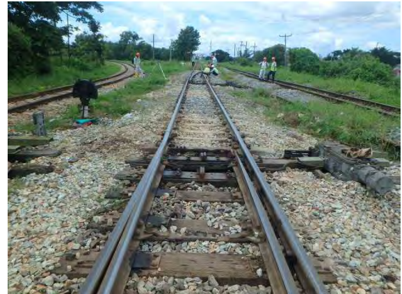
11k360m よりヤンゴン方（施工後）
