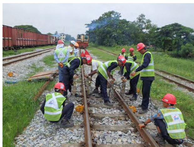
列車抑止してレール扛上
