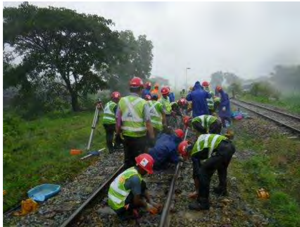
激しいスコールに見舞われる現場
