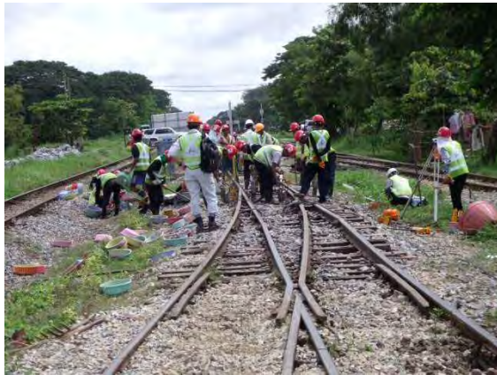
レール扛上・つき固め
