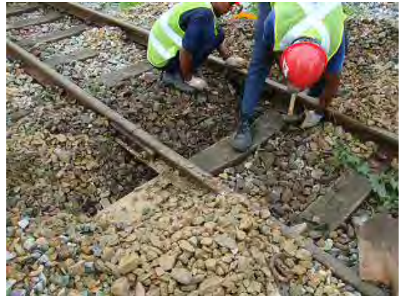
マクラギ位置整正
