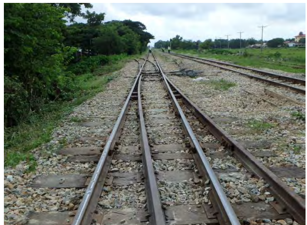
作業終了後(ヤンゴン方)
