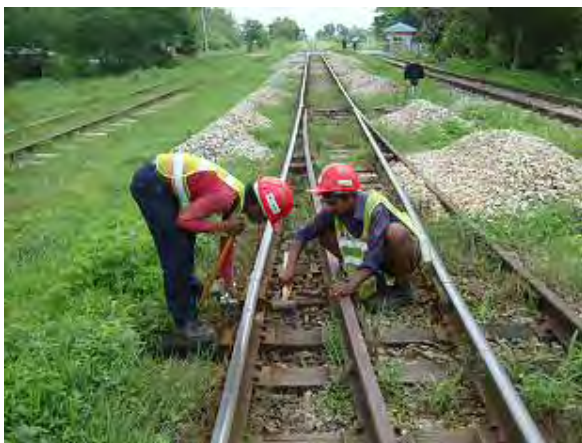
継ぎ目ボルト修正
