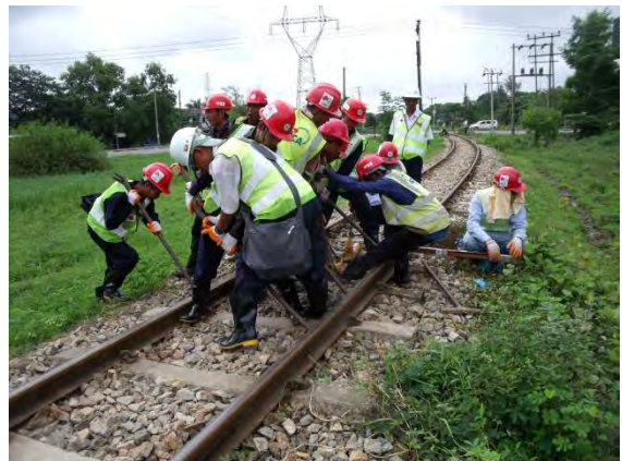
曲線整正器を使用した通り直し
