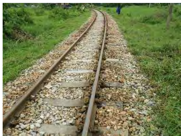
碎石投入後の軌道状態
