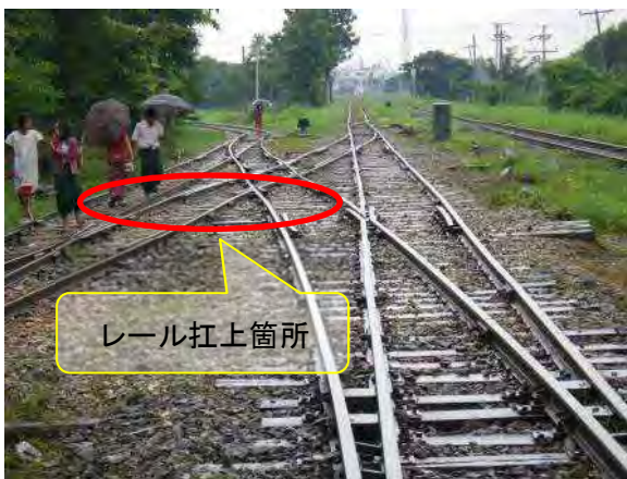
分岐器レールこう上(施工後)
