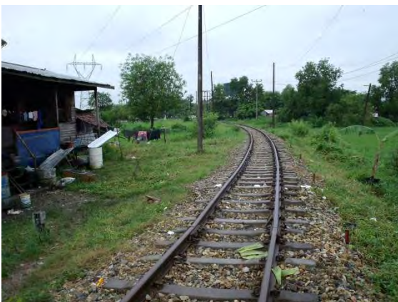
通り直し 施工前
