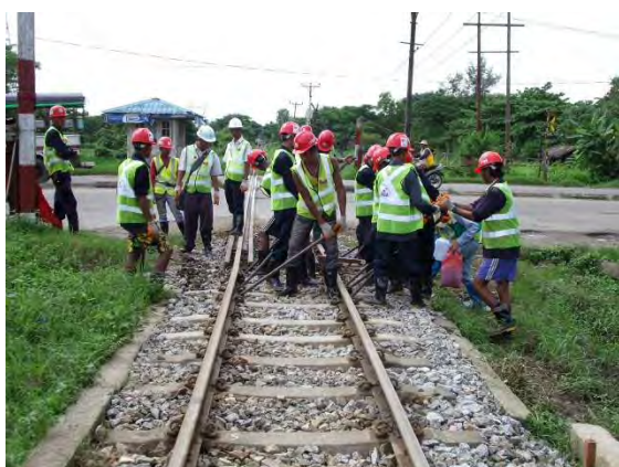
曲線修正(通り直し)
