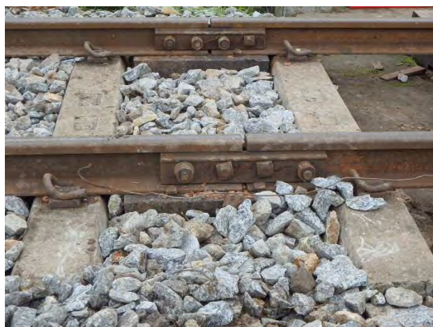
アバット部の継目縦マクラギ
