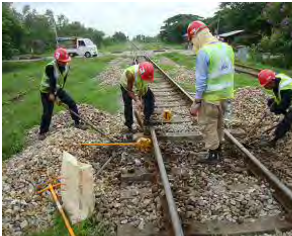
踏切付近継ぎ目修正
