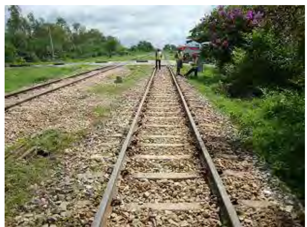
踏切へのすりつけ、突き固め終了後
