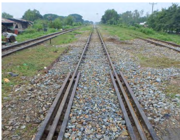
13 k 050mよりヤンゴン方 (施工前)
