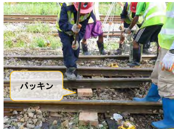
パッキンを挿入し、列車を通す
