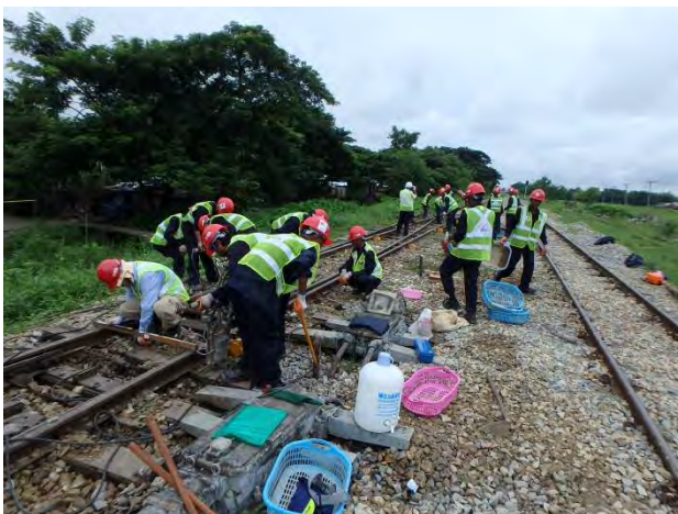
分岐器扛上
