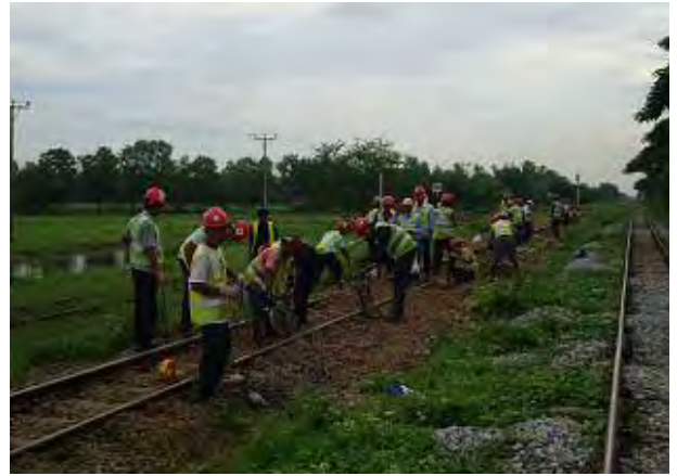
全体の作業状況
