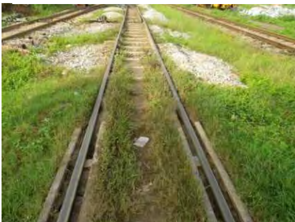
道床交換箇所(下り線) (施工前)
