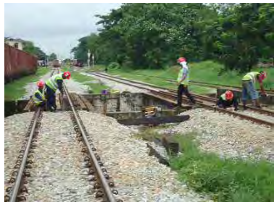
橋台背面の突き固め
