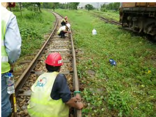
曲線部軌道変位測定
