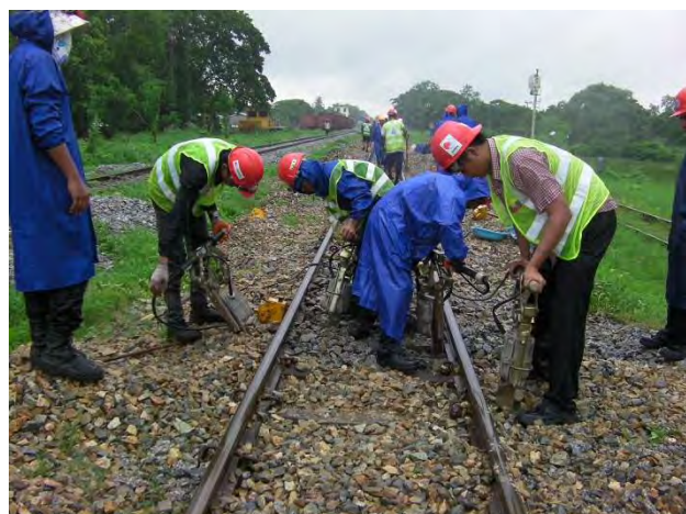
雨の中でのつき固め作業
