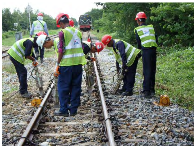
列車抑止してのつき固め
