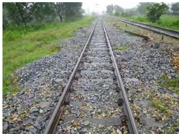
施工後 12k870m よりバゴーフ方
