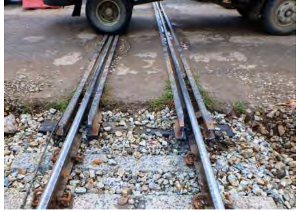
ガードレール切断面加工
