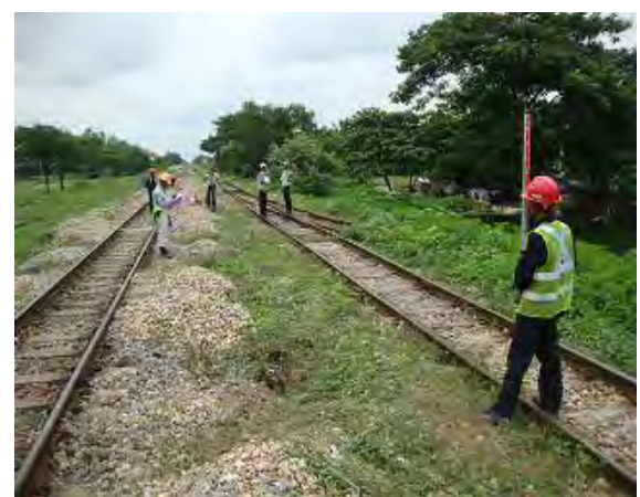
下り線測量 (明日以降の作業準備)
