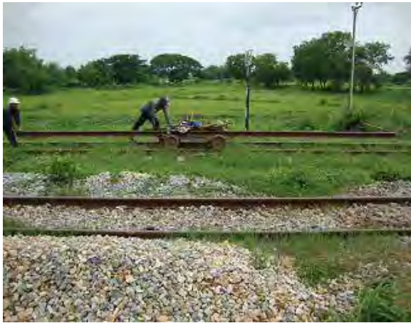
トロで 12m レールを運ぶダゴン線の作業員
