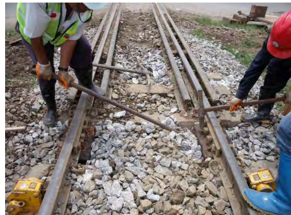
縦短マクラギ挿入
