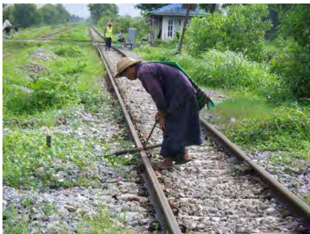
巡視による線路点検の様子
