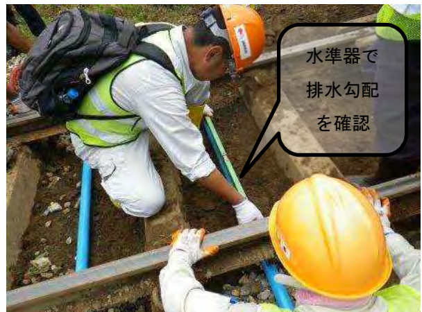
塩ビ管による排水管設置②
