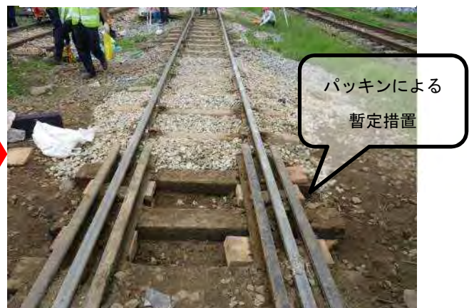
道床交換箇所(下り線) (施工後)
