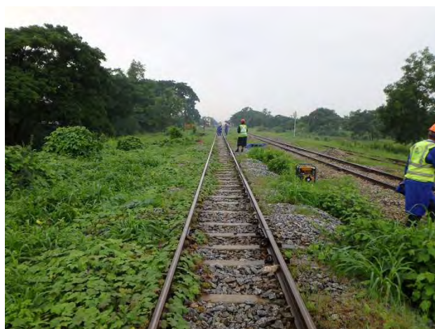
施工前 (12k245m ヤンゴン方)
