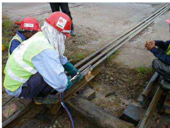
踏切脇の不要ガードレールの切断
