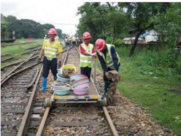
分岐器部へのバラスト散布
