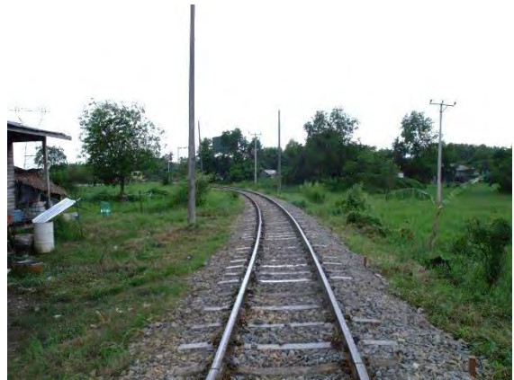
通り直し 施工後
