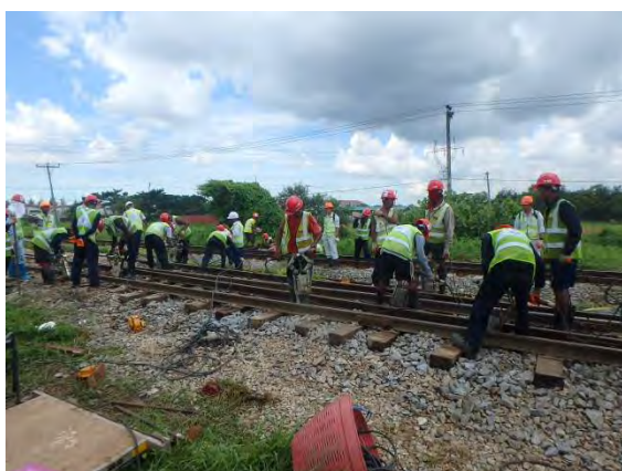
レール扛上・つき固め
