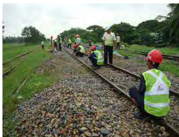
施工前の測定
