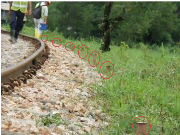
5m間隔に打設した基準杭
