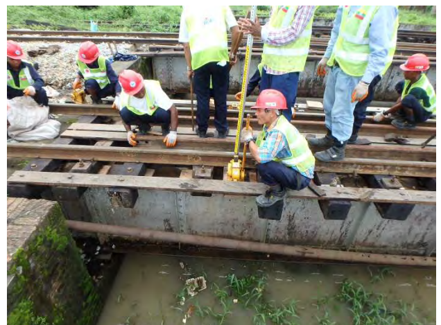
橋りょうのレール扛上
