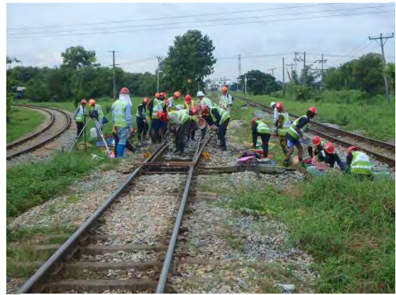
バラスト補充しながらつき固め
