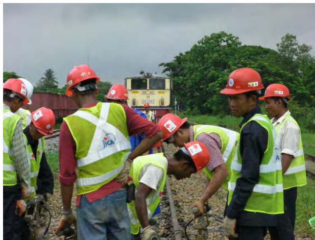
列車を抑止してつき固め
