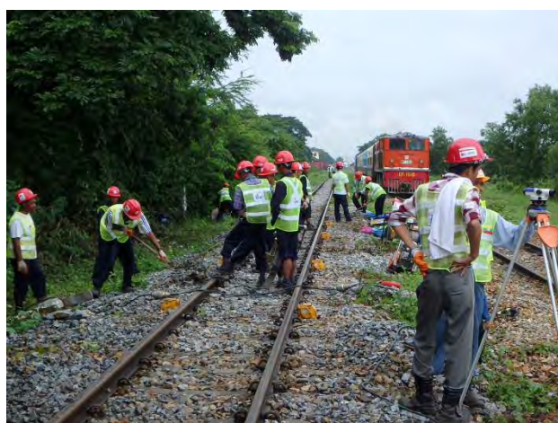
レール扛上準備作業
