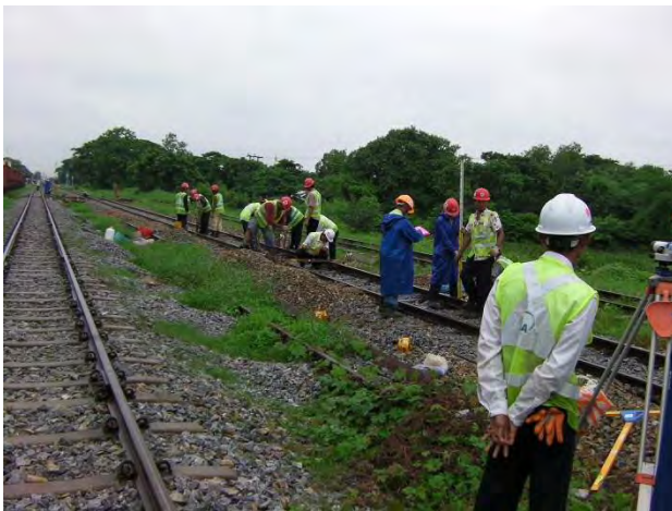
上り線レール扛上量測定
