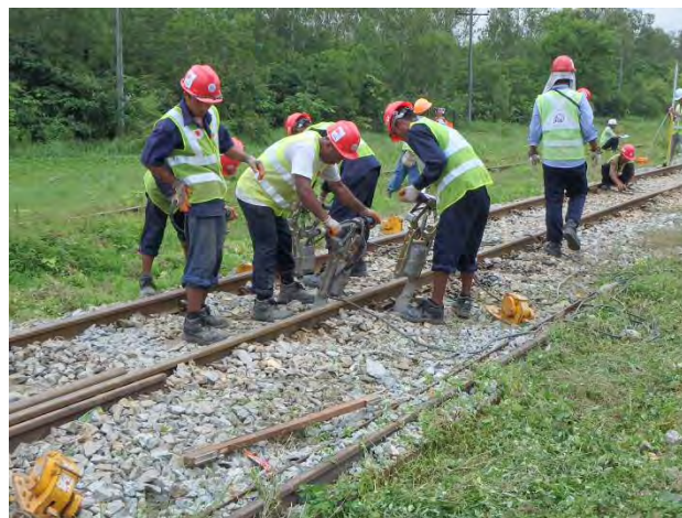
上り線 12k650m 付近レール扛上
