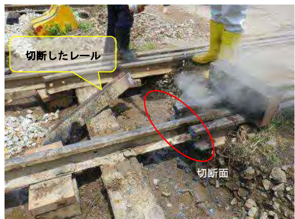
踏切ガードレール切断後の様子
