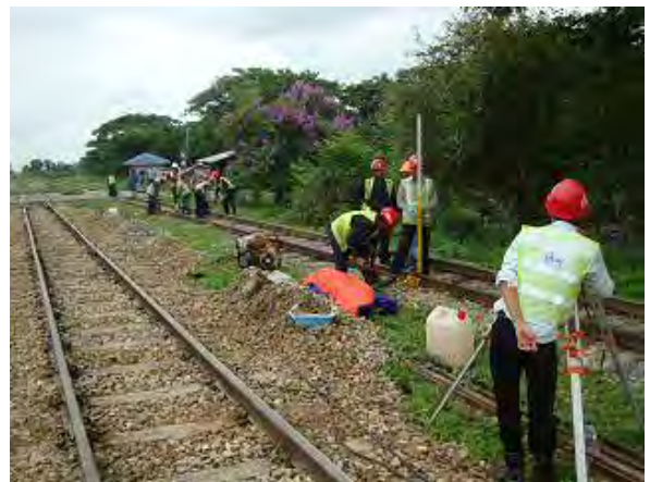
上り線終了後、下り線着手後
