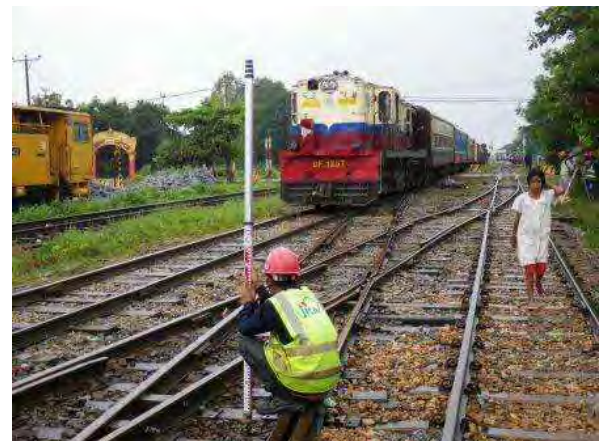
施工後のレベル測量の様子
