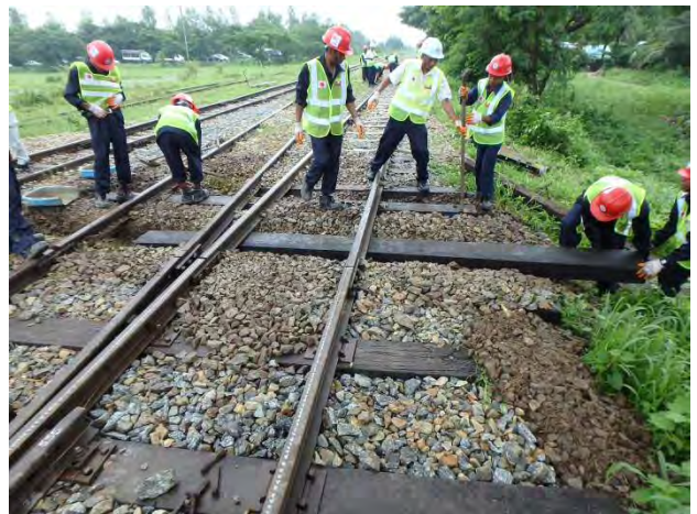
分岐長マクラギ交換
