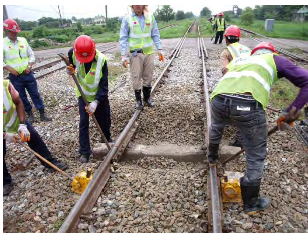
PC マクラギ位置整正
