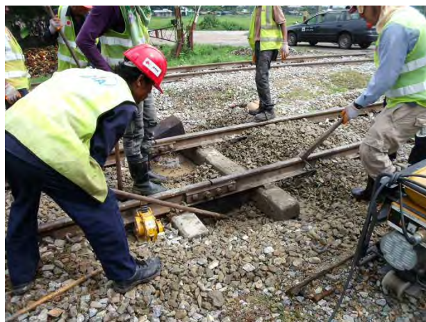
短マクラギ挿入
