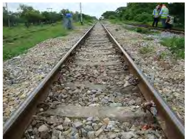
むら直し、突き固め終了後
