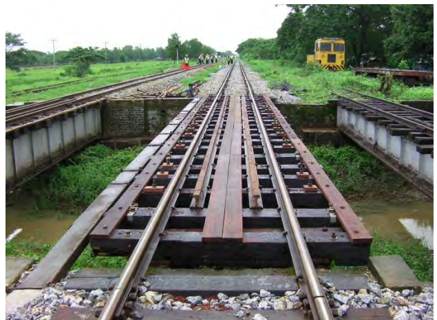
下り線橋りょうバゴ一方
