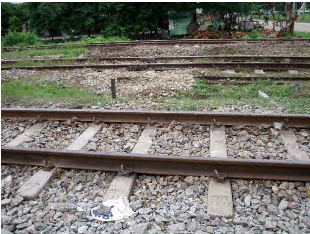
道床交換完了 (下り線より)
