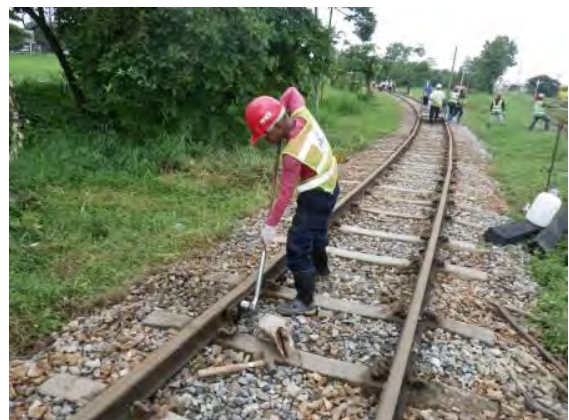
締結ボルトの締め直し
