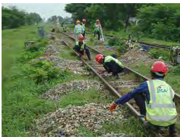
施工前の検測
