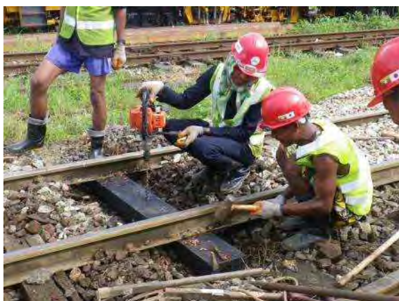
マクラギ交換の様子
