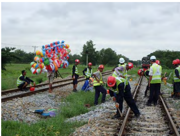
列車抑止して総つき固め
