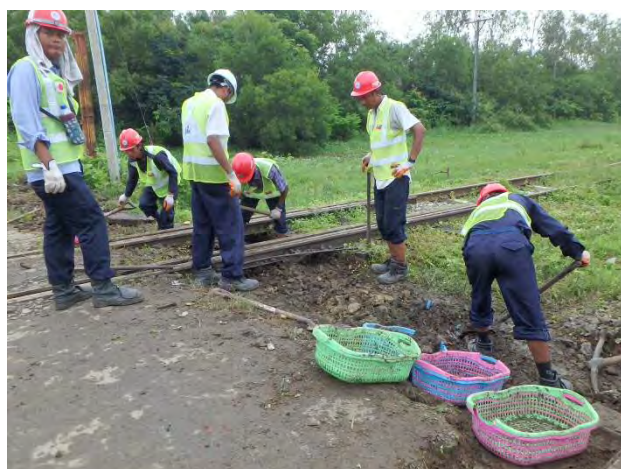
踏切端部掘削整・横断排水工
