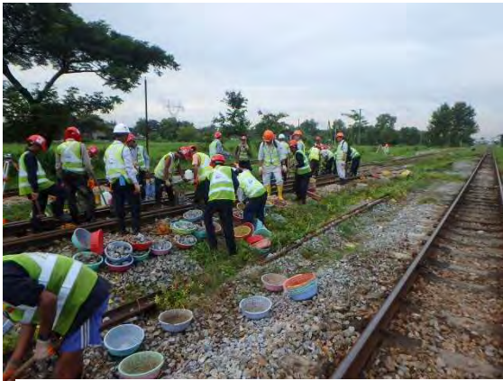
バラスト補充しながらつき固め
