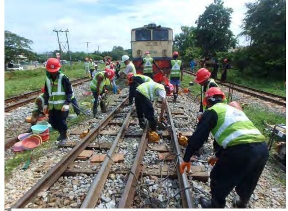
列車を抑止してレール扛上
