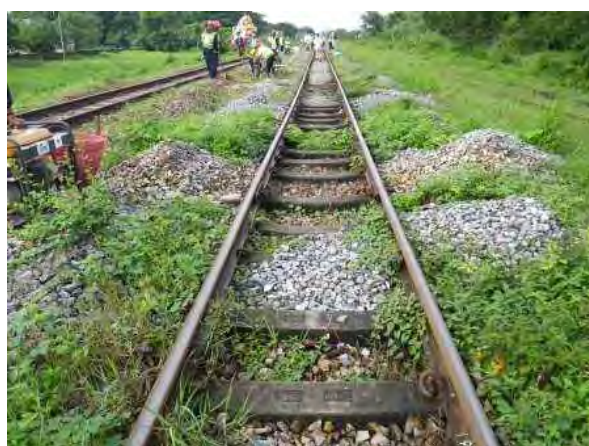
施工前 12k930m よりヤンゴン方
