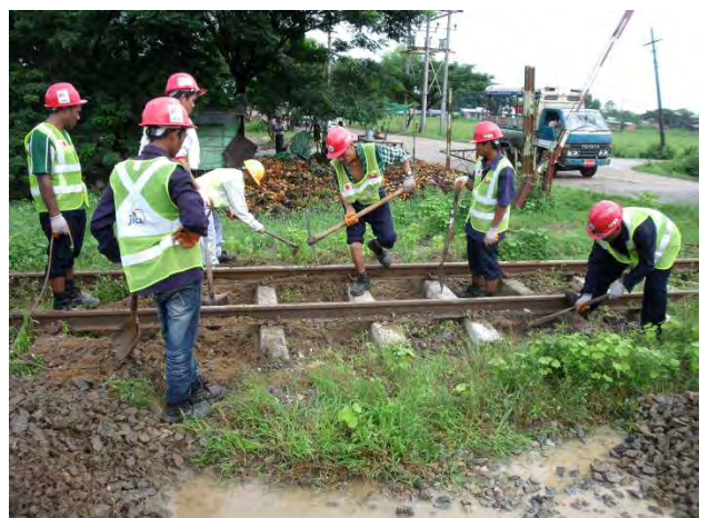
ダゴン大学線道床交換
