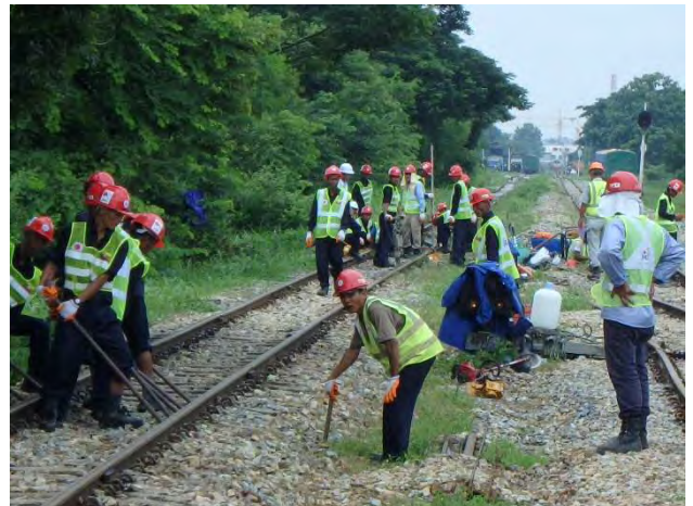
通り直しとつき固め作業
