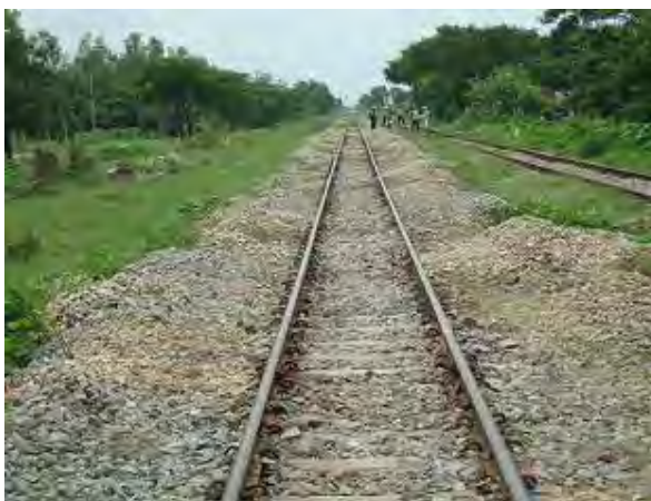
突き固め終了後
