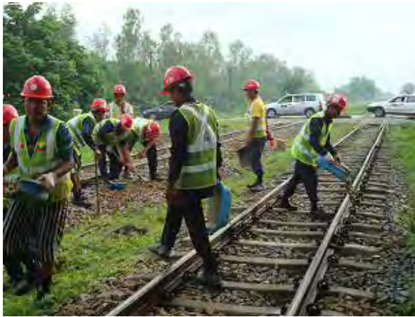
バラスト投入の状況
