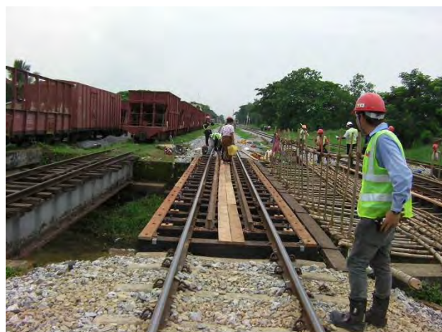
下り線橋りょう改良終了
