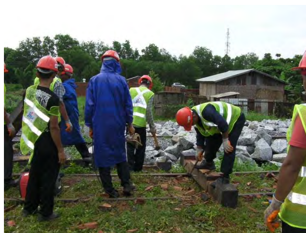
橋マクラギ加工
