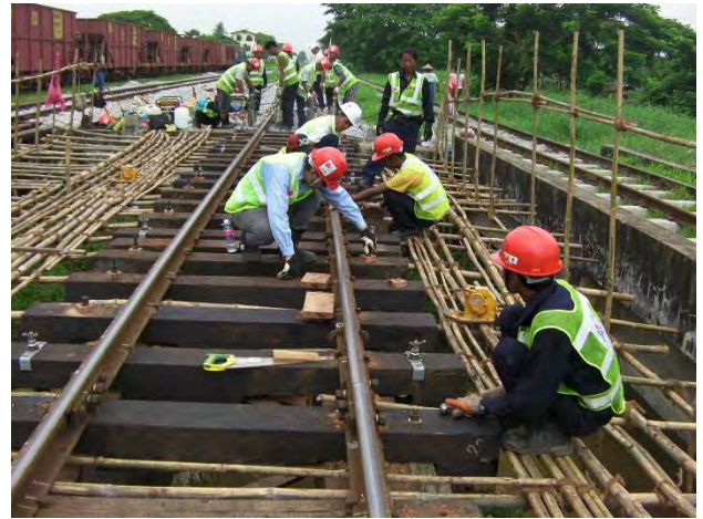
上り線橋りょうレベル調整
