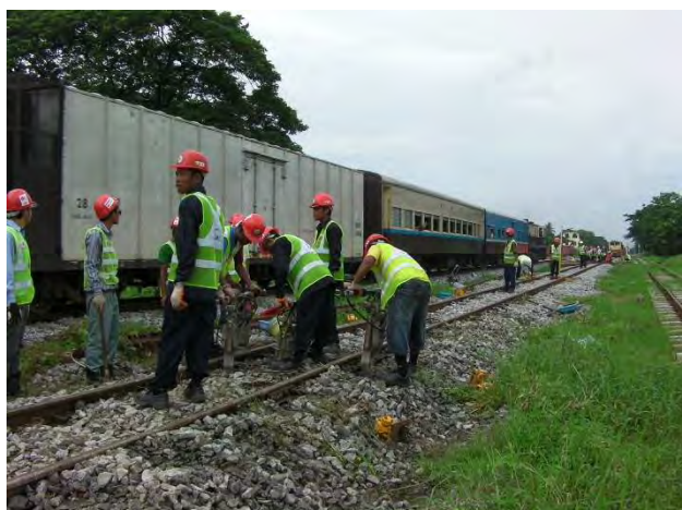
12k180 付近レール扛上
