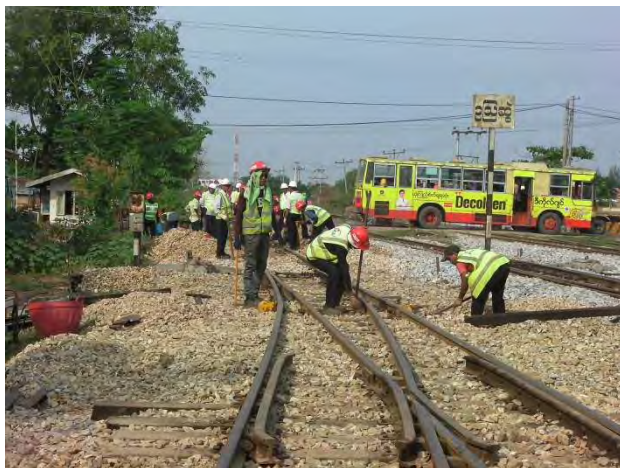
レール扛上(踏切部)
