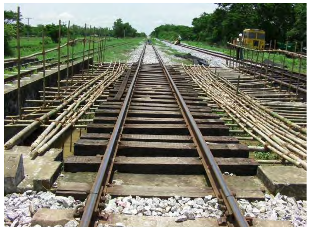
上り線橋りょうの落下防護工
