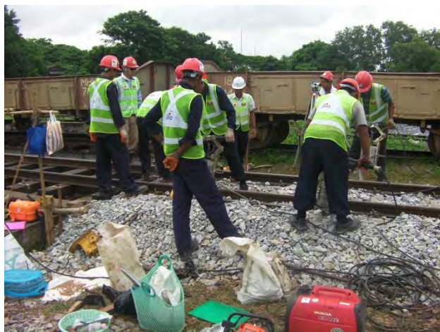
アバット部レール扛上
