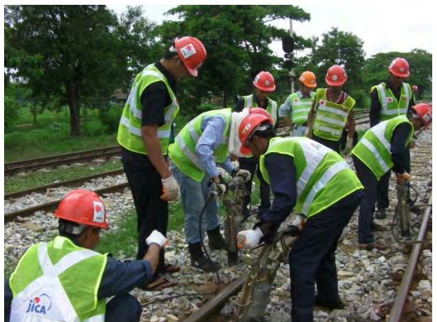
上り線 11k860 総固め
