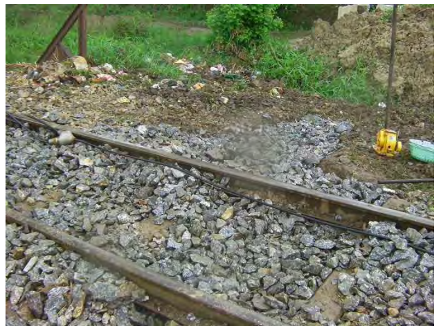
バラスト交換、排水溝し
