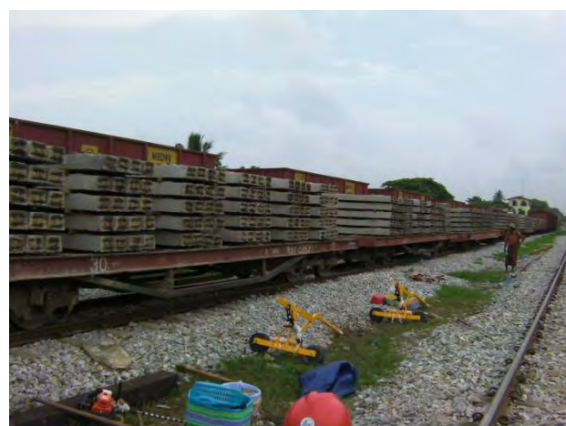
大量の PC マクラギ運搬
