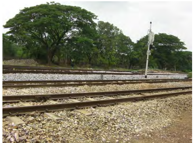
側線(機回し線)扛上施工後
