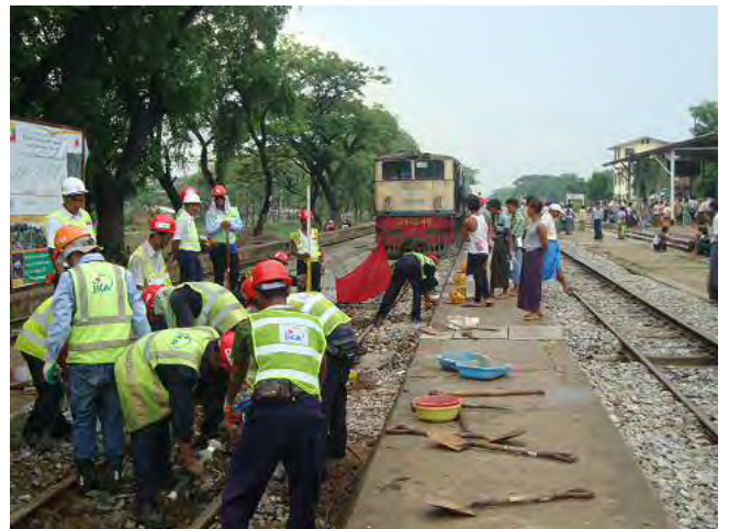
突き固めと測量の状況
