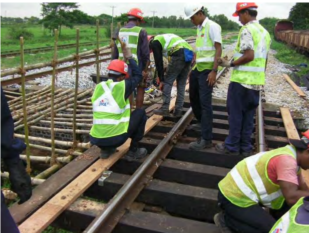
下り線橋りょうけい材取付け
