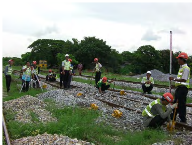
扛上量の計測研修
