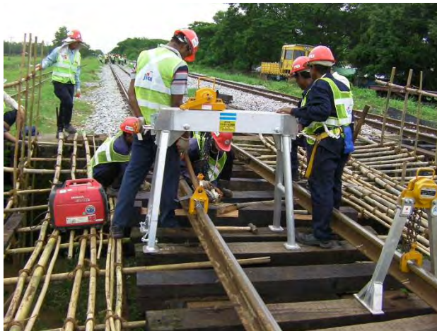
橋マクラギ調整
