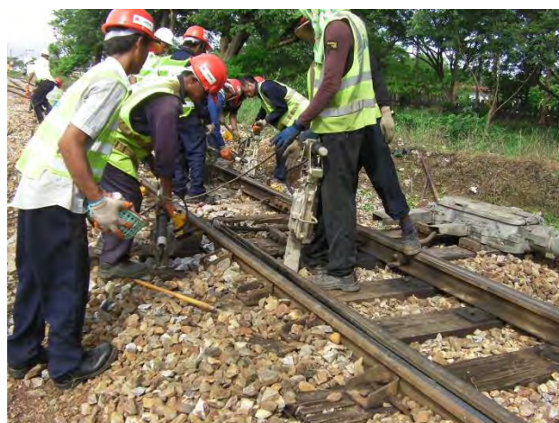
分岐器扛上
