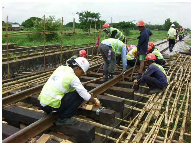
フックボルト取り付け
