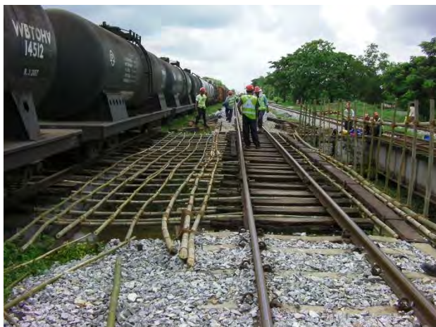
足場組立(まだ途中)
