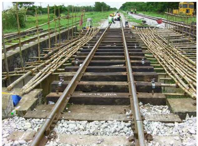
上り線橋りょうマクラギ交換完了
