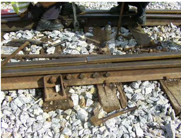
ロックボルト交換
