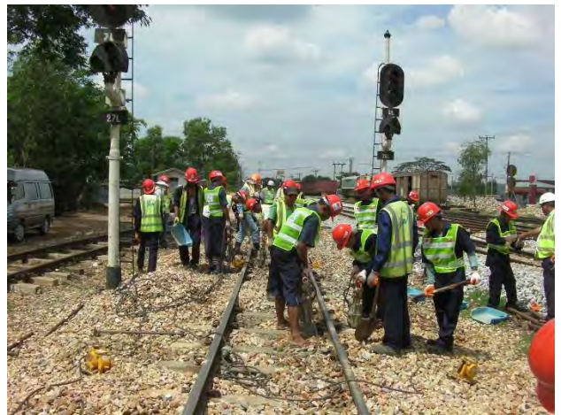
つき固め(今日だけサンダル作業許可)
