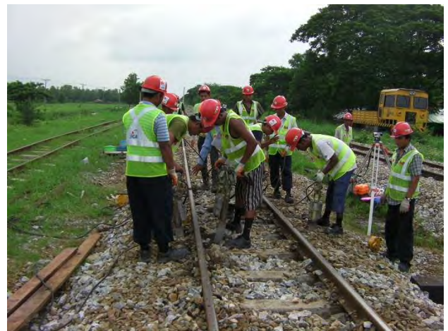
上り線橋りょう後部つき固め
