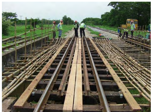
上り線橋りょう改良終了
