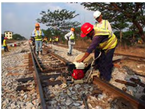
整正整正のためのレール切断
