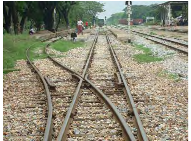
軌道整備後の状況
