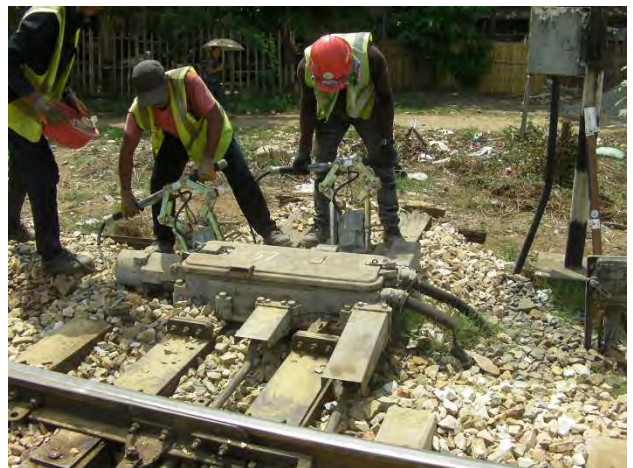
分岐器モータ一部扛上
