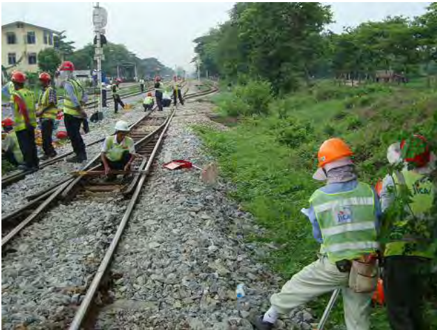
測量・検測の状況
