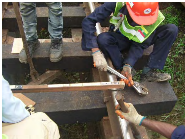
フックボルトでレベル調整
