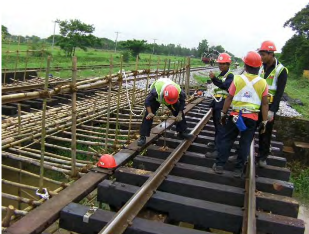
下り線橋りょうフックボルト取付け
