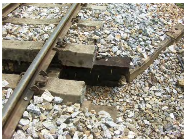
上り 11k550m 横断水路改修
