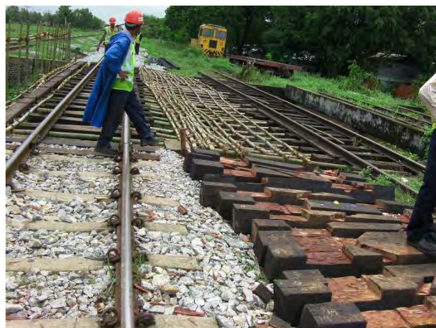
加工橋マクラギと落下防護工
