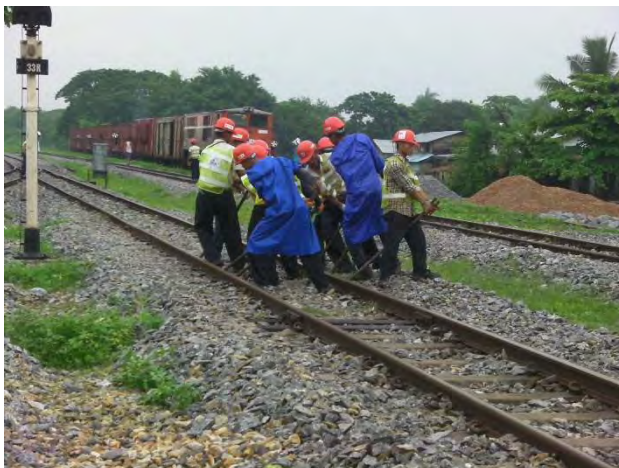
分岐器マクラギ交換
