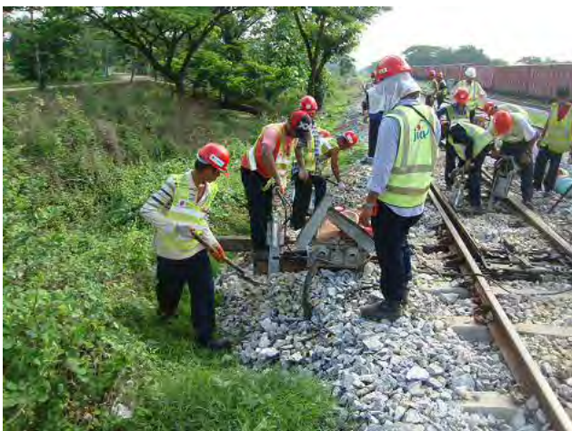
モータ一部突き固めの状況
