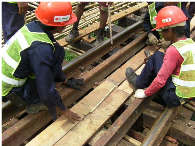
橋りょうガードレール、歩行板取付け
