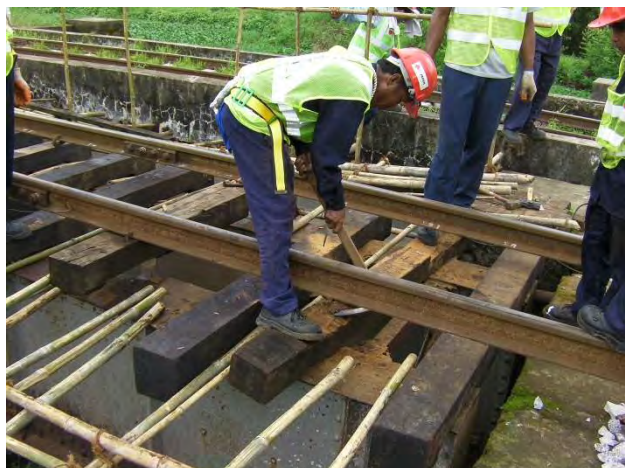
橋マクラギ加工
