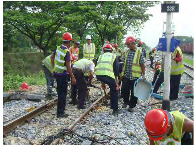
分岐器突き固めの状況
