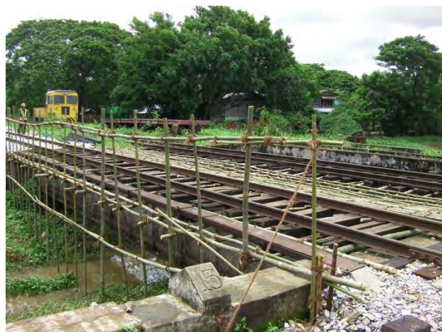
足場架設完成
