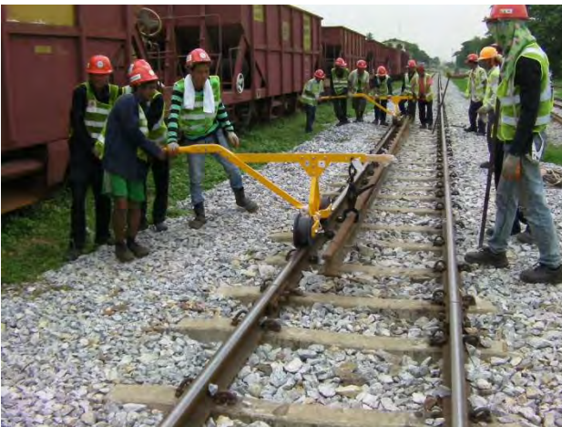
下り線橋りょうガードレール運搬
