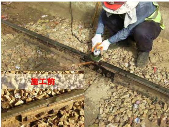
継ぎ目板整備
