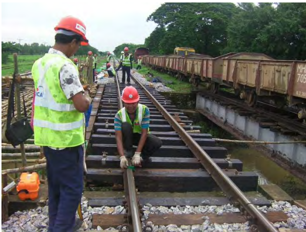
下り線橋りょうレール扛上前検測
