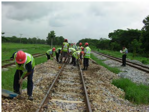
12k130m 付近総つき固め
