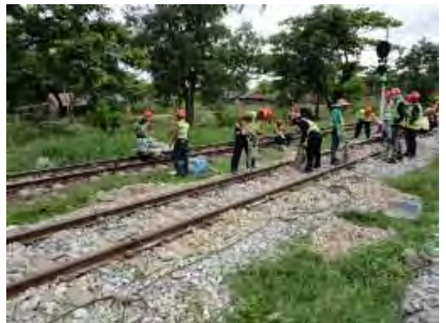
突き固めの状況
