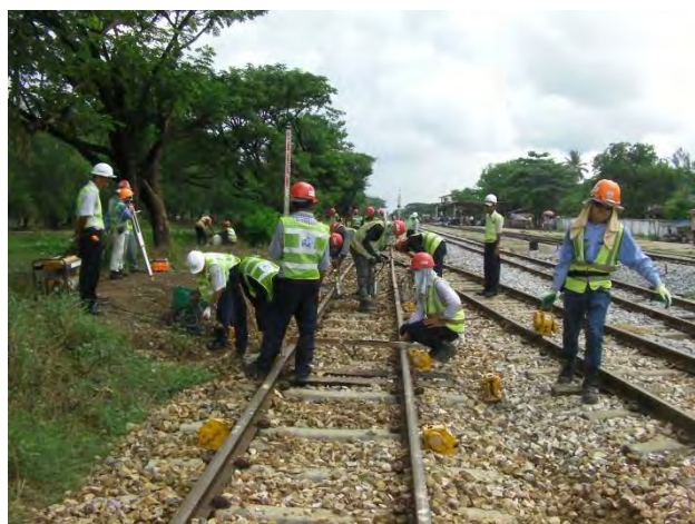
レベル測量で扛上量算定
