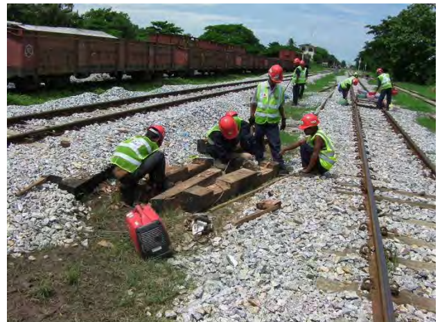
橋マクラギ加工
