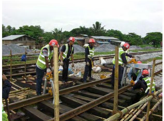
上り線橋りょうレール扛上
