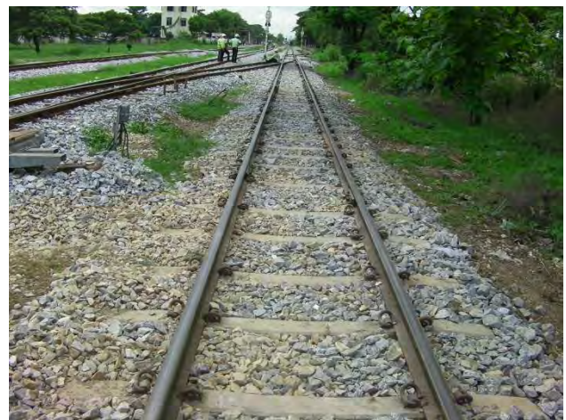
施工後 (12k000 からヤンゴン方)
