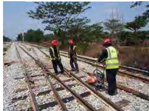
道床締固め
