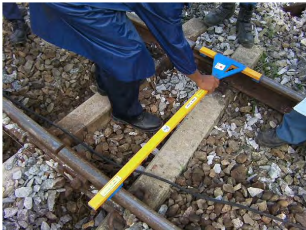
マクラギ位置修正
