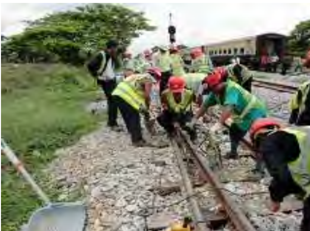
分岐器内の突き固め
