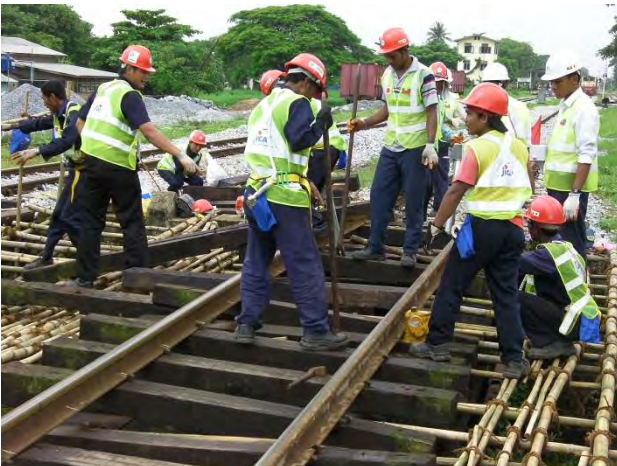
上り線橋りょう橋マクラギ交換
