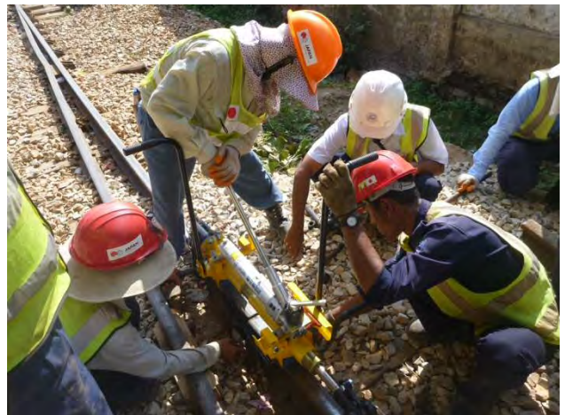
整正機によるレール移動
