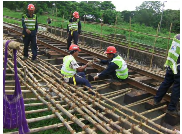
上り線橋りょうロックボルト取付け
