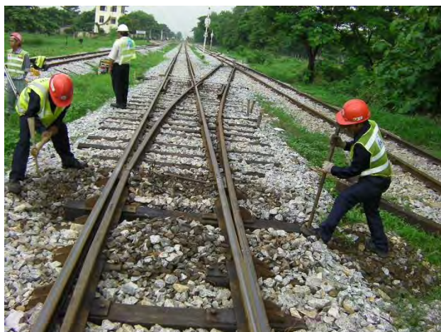
分岐器マクラギ交換
