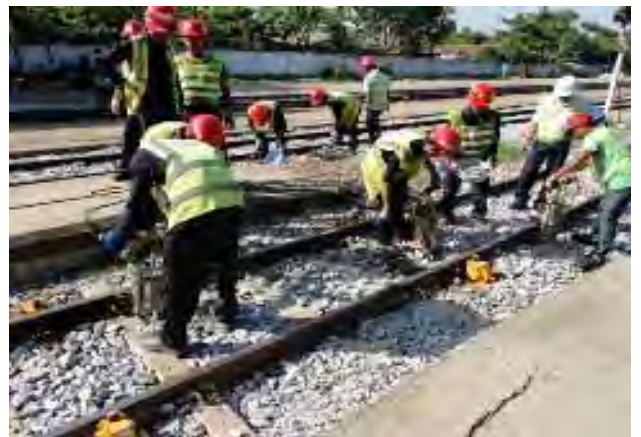
突き固め作業
