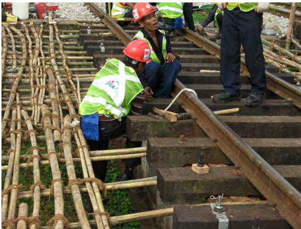
上り線橋りょうロックボルト取付け
