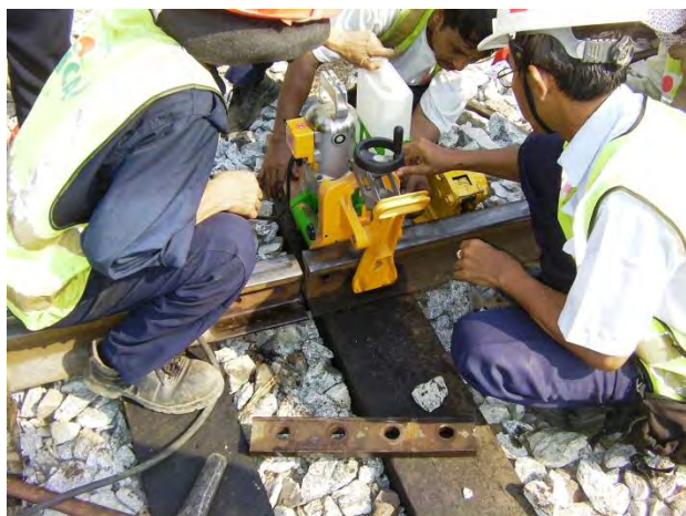
レール継ぎ目部穿孔
