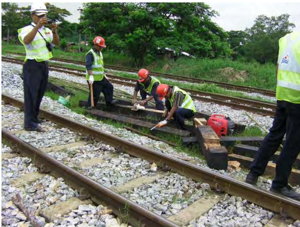
橋マクラギ加工
