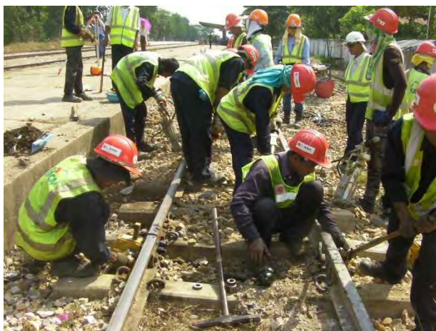
継ぎ目ボルト締結とむら直し
