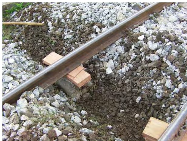
PCマクラギ交換の受け
