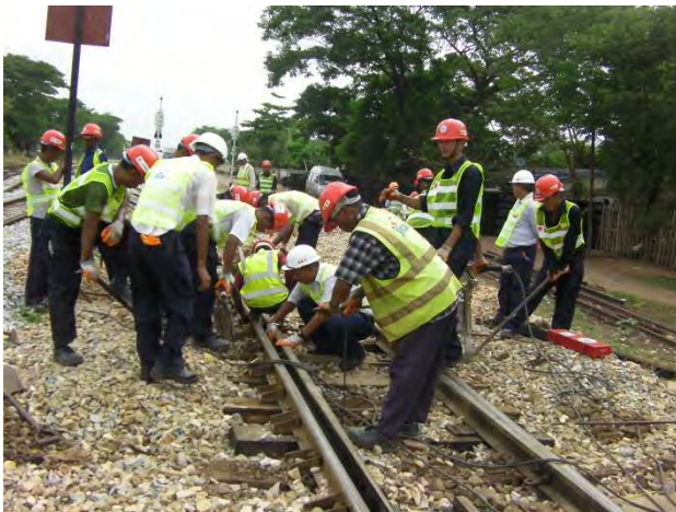
第1回目分岐器扛上
