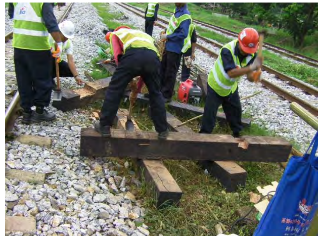
橋マクラギ加工
