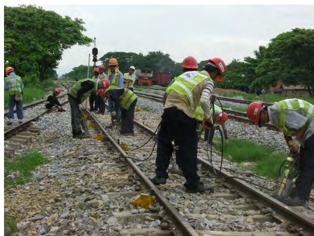
むら直し(レール扛上)
