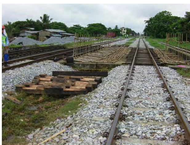
上り線 No15 橋りょう
