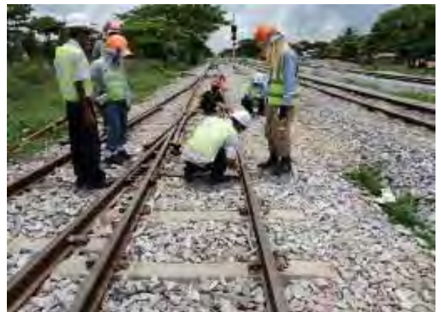
仕上がり検測の状況
