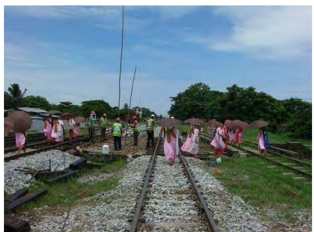
落下防護工架設中の尼さんの列
