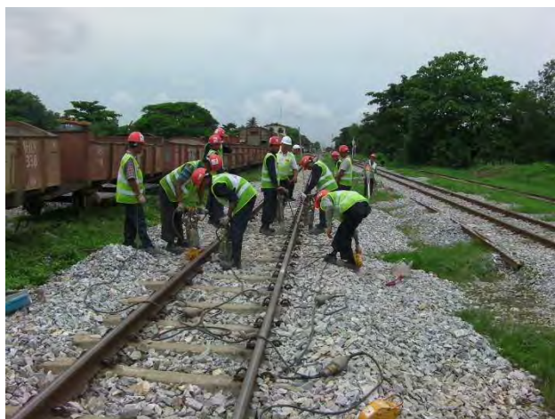
下り 12k050 付近レール扛上
