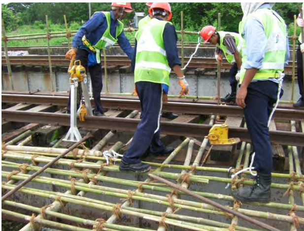
イヌクギ撤去、レール扛上
