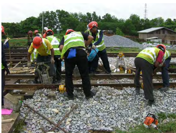
上り線橋りょう取付け部むら直し
