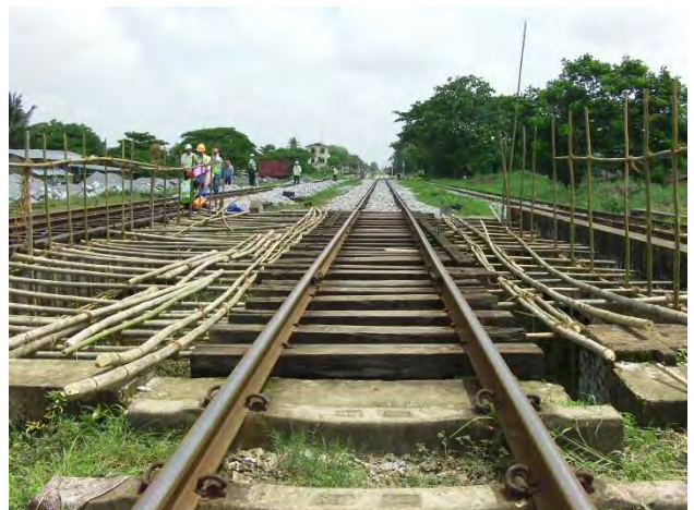
足場・落下防護工移設中の上り線橋りょう
