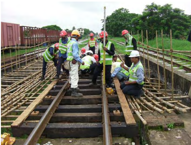
上り線橋りょうレベル調整
