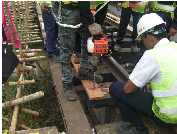
けい材取付け
