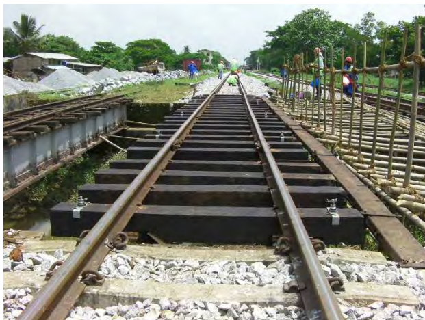
落下防護工を撤去した下り線橋りょう
