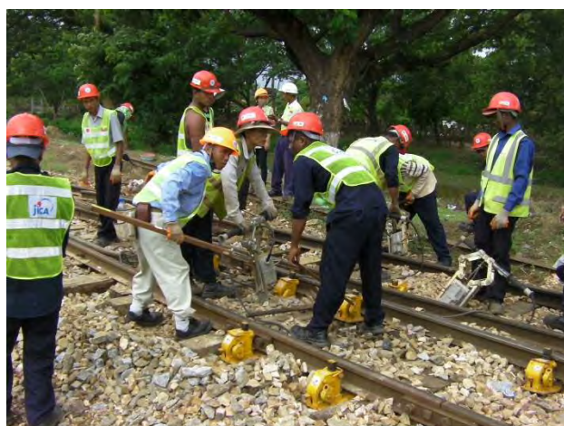
分岐器扛上
