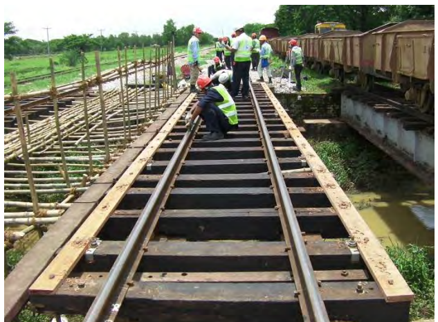
下り線橋りょうけい材取付け完了
