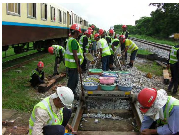
バラスト補充とレール扛上
