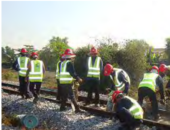
突き固めの状況
