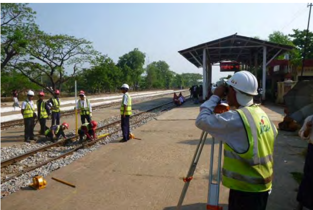
C班の班長による扛上量確認
