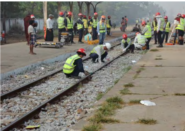
施工前の軌道検測
