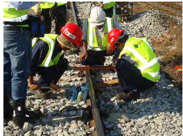
ジャッキアップの状況
