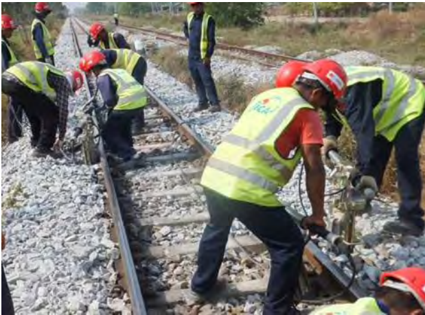
総つき固め 49 mmを 2回で扛上
