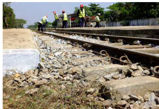
線路こう下(施工後)
