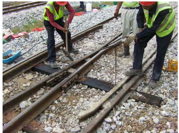
分岐マクラギ交換後の穿孔とイヌクギ打ち
