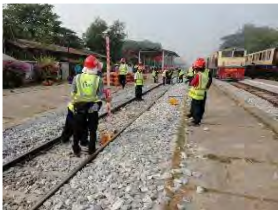
レベルによる扛上量確認
