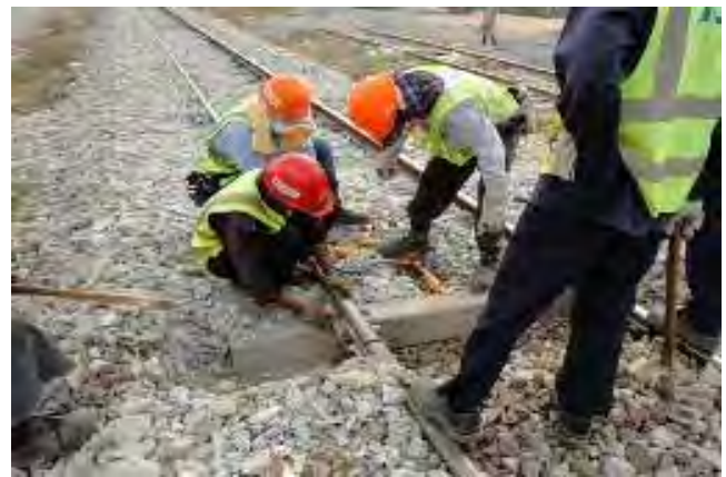
PCマクラギ位置修正
