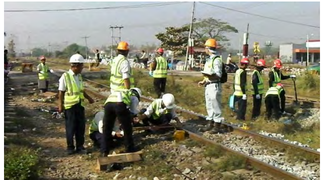
レール扛上量確認
