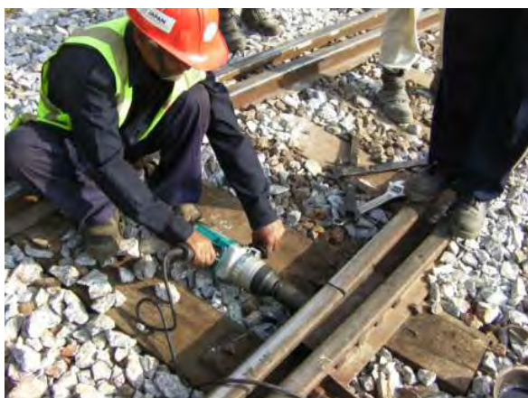
ボルト交換後、緊解機にて緊締
