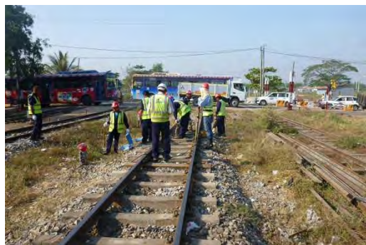
分岐器後方付帯むら直し
