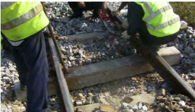
マクラギ位置修正
