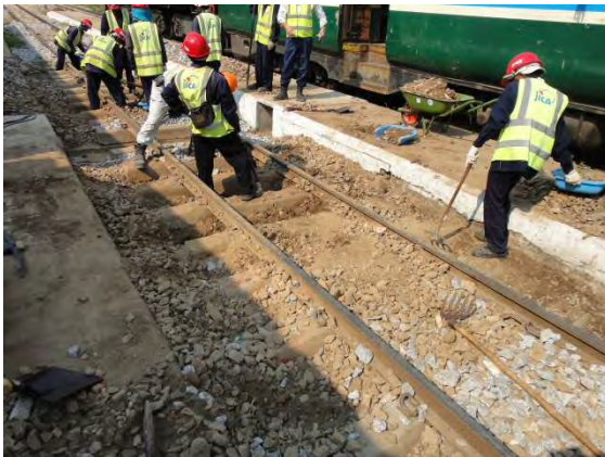
バラスト撤去(施工中)
