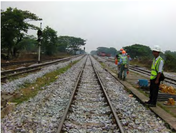
施工前の状態
