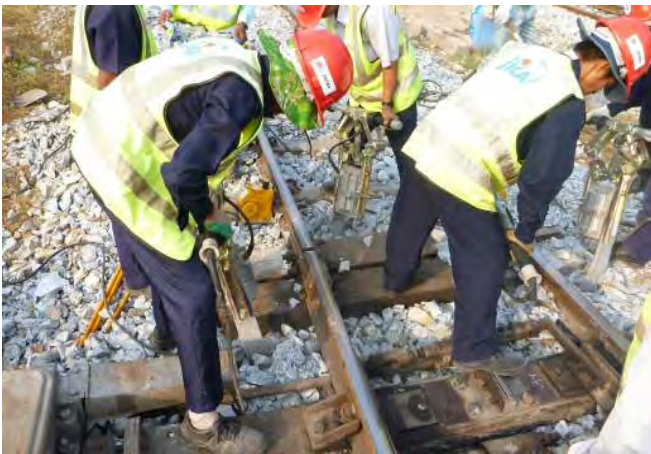
分岐器前端のむら直し
