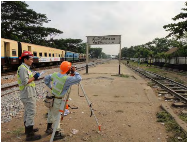
レベルによる縦断測量
