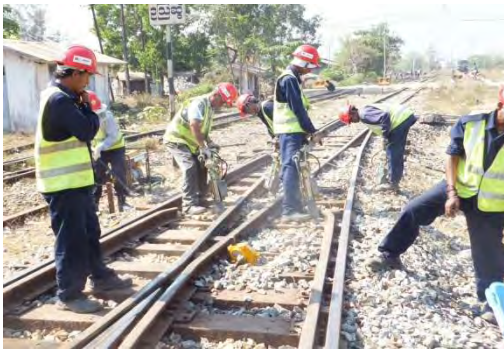
54A号分岐器むら直し
