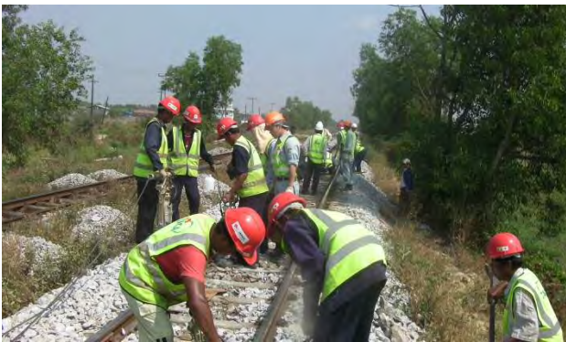
総つき固めで79mmを扛上
