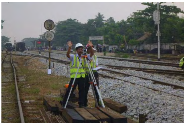
レベルにて扛上量確認
