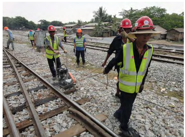
道床締め固め
