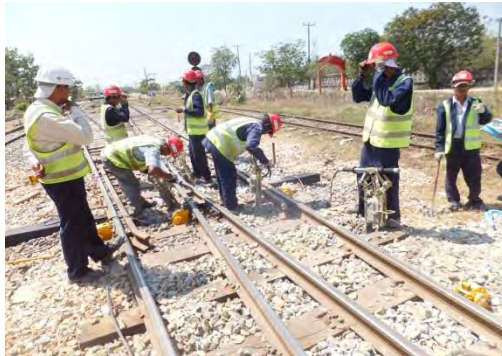
54B号分岐器むら直し
