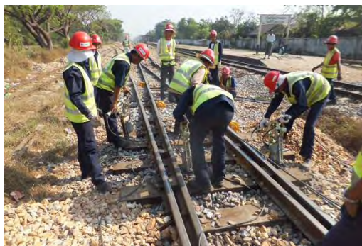
55A号分岐器むら直し
