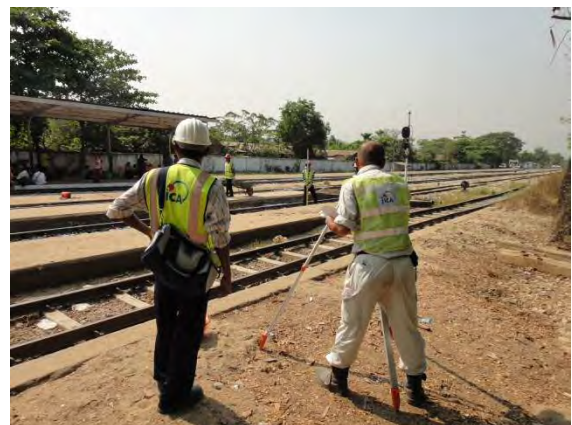
線路縦断測量
