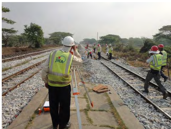
レベルによる扛上量確認
