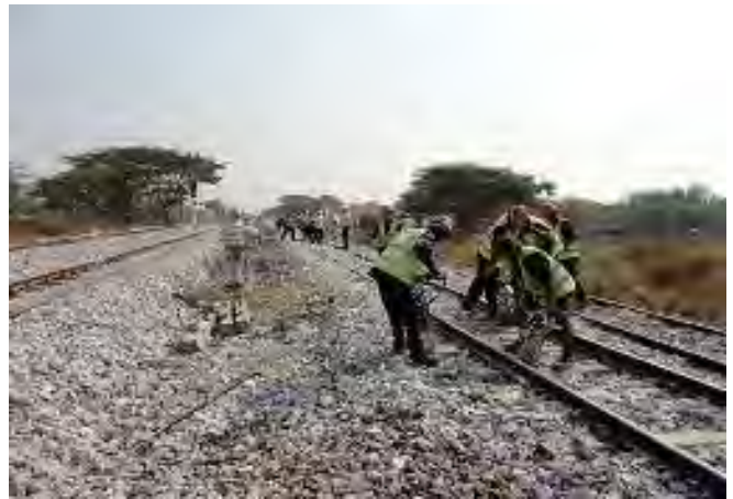
分岐後端の総つき固め
