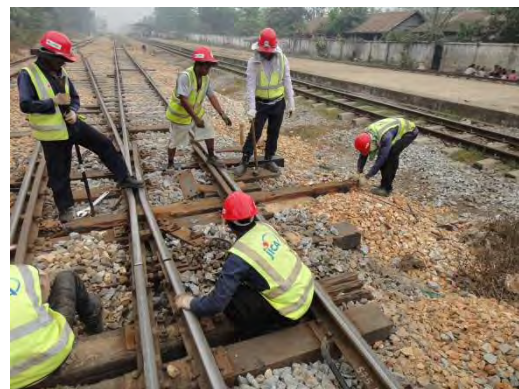
55A号分岐マクラギ交換
