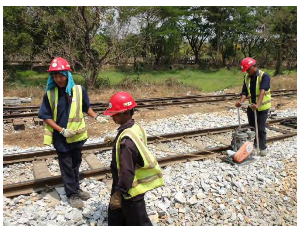
道床締め固め
