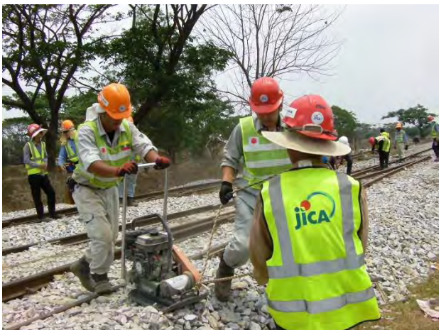
道床締め固め
