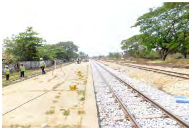
施工後の状態
