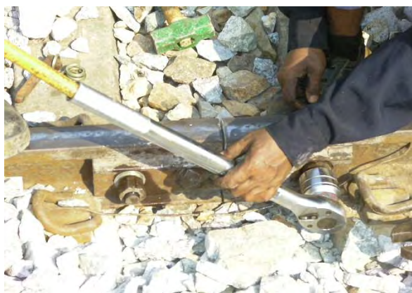
継ぎ目板ナット・ワッシャー交換
