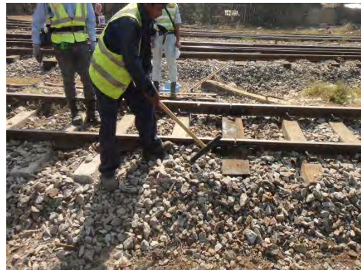
継目マクラギ交換
