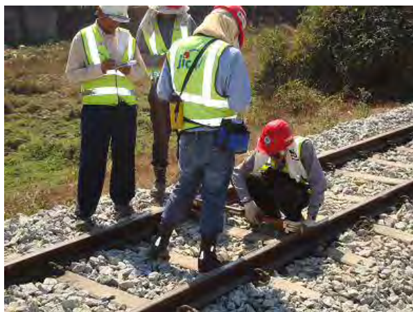
作業終了後検測の状況
