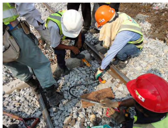
マクラギ位置整正
