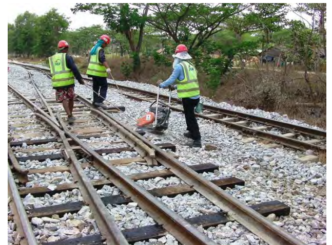
道床締固め
