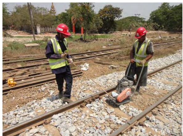
道床締め固め
