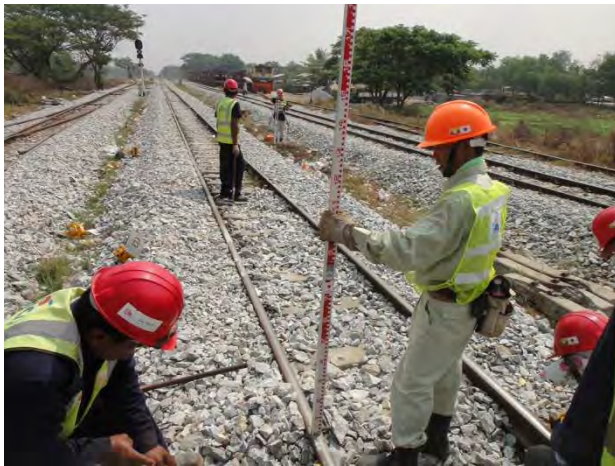
レベルによる扛上量確認
