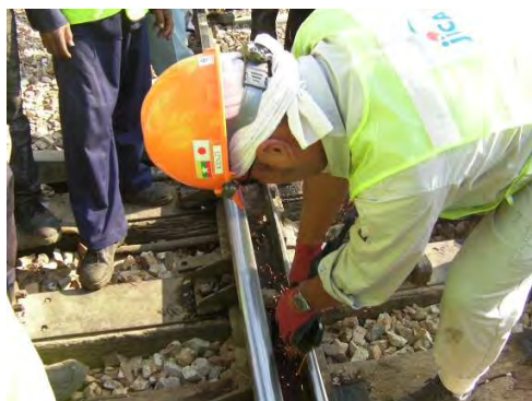
トングレール削正説明
