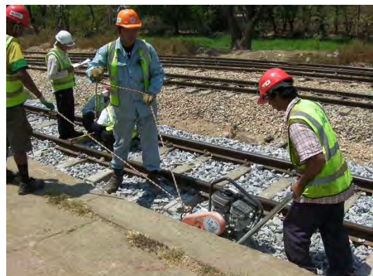
バラスト締め固め
