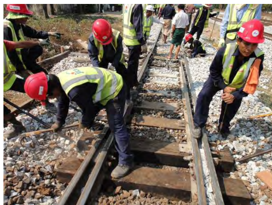
分岐マクラギ交換
