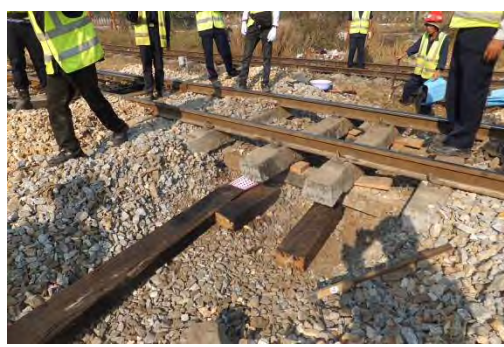
水路修繕(桁下に木マクラギ敷設)
