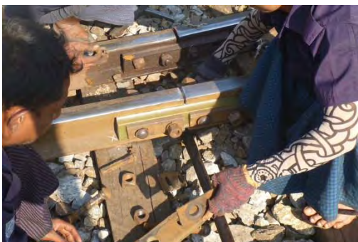
信号屋による絶縁交換
