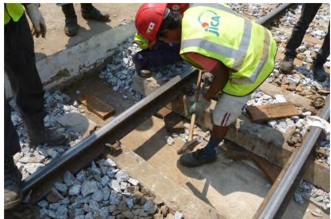
パッキンによる不陸調整(排水溝)
