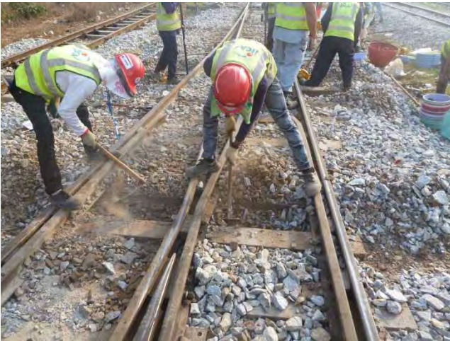
分岐マクラギ交換(施工中)
