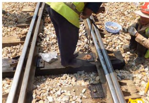
55B号分岐マクラギ交換
