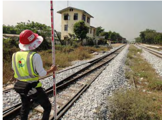
線路縦断測量
