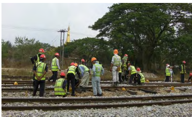
レベル確認で総つき固め
