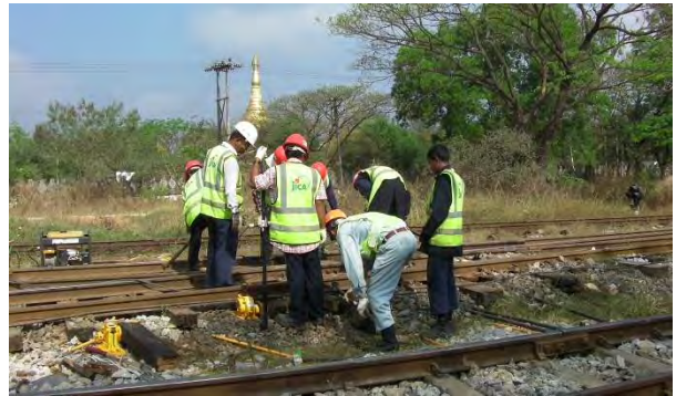
レール扛上量確認
