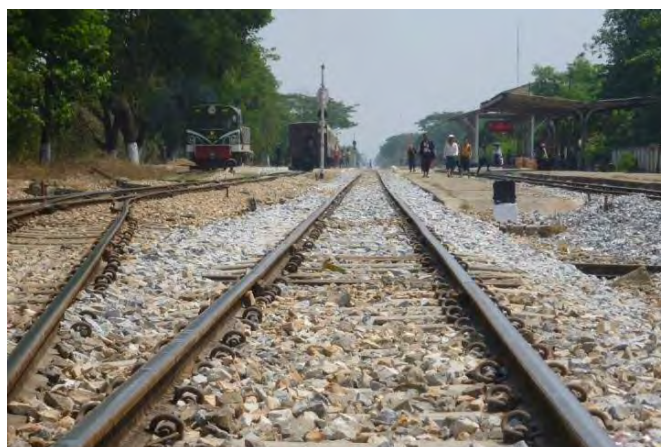
施工後の軌道状態
