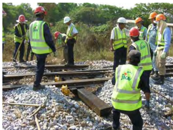
分岐マクラギ交換
