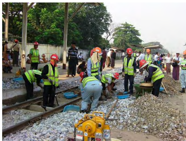
バラスト交換（固結部の掘削）
