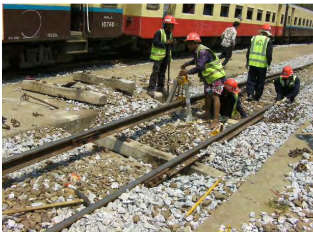
PCマクラギ交換 (施工中)
