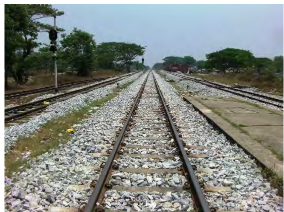
施工後の状態
