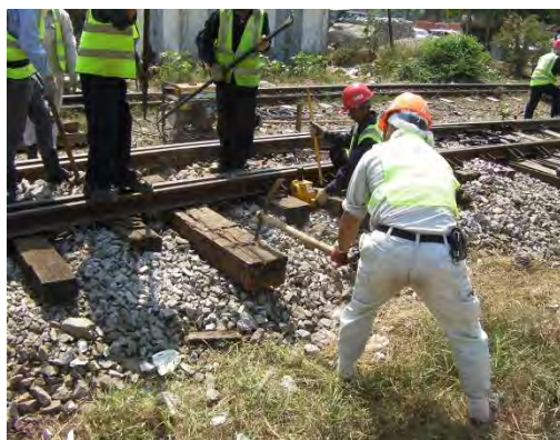
分岐マクラギ交換
