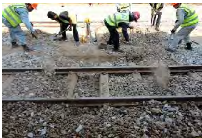
交換箇所へのバラスト投入
