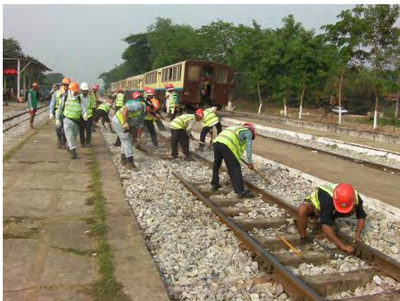
バラスト補充と継目ボルト交換
