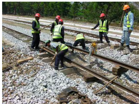
PCマクラギ交換(レール破線)
