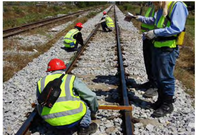
作業後の検測作業
