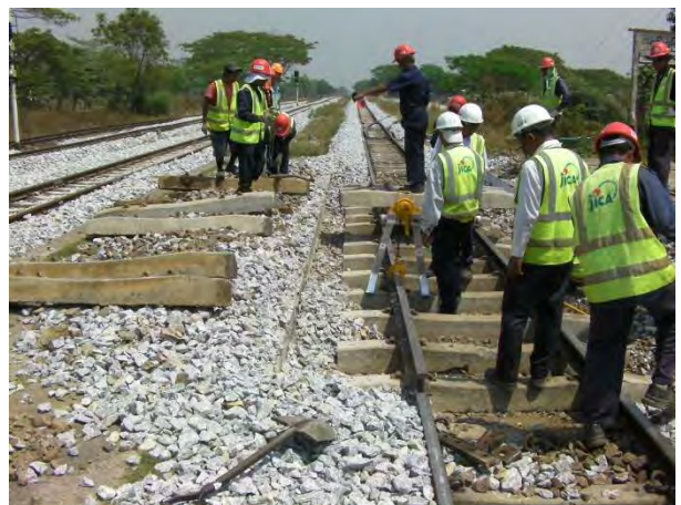
PCマクラギ交換 (施工中)
