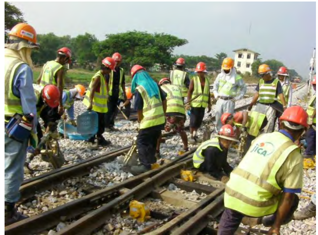
分岐器総つき固め
