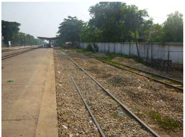
ティラワ線の道床取卸し状況
