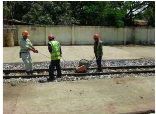
バラスト締め固め
