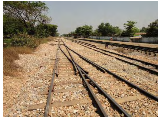
施工後(仕上がり状態)
