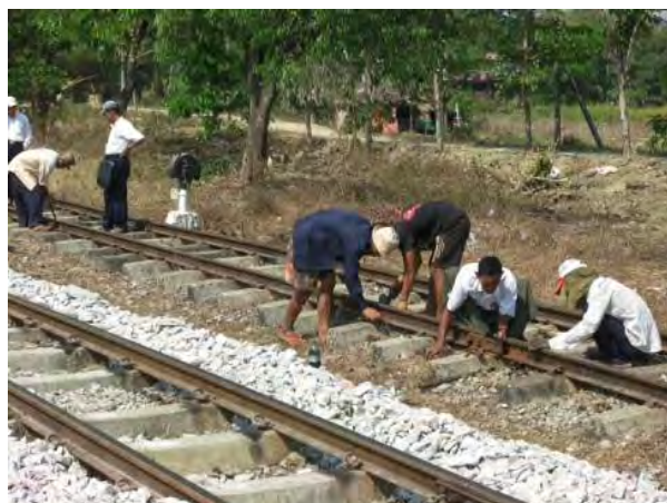
MRによるレール交換作業
