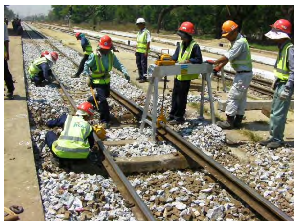
PCマクラギ交換(レール扛上)
