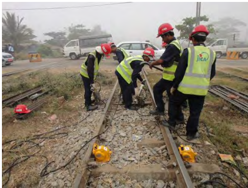
むら直し (踏切~54B分岐器)
