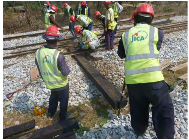
分岐マクラギ交換(施工中)
