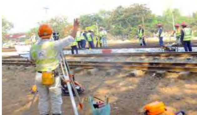
扛上量をレベルにて確認
