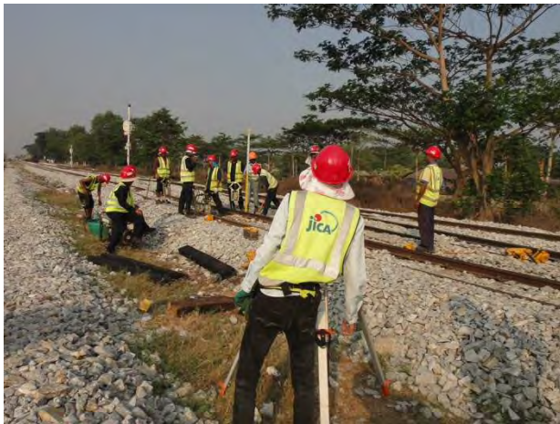
レベルによる線路扛上
