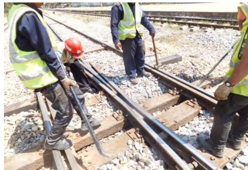
55A号分岐マクラギ交換
