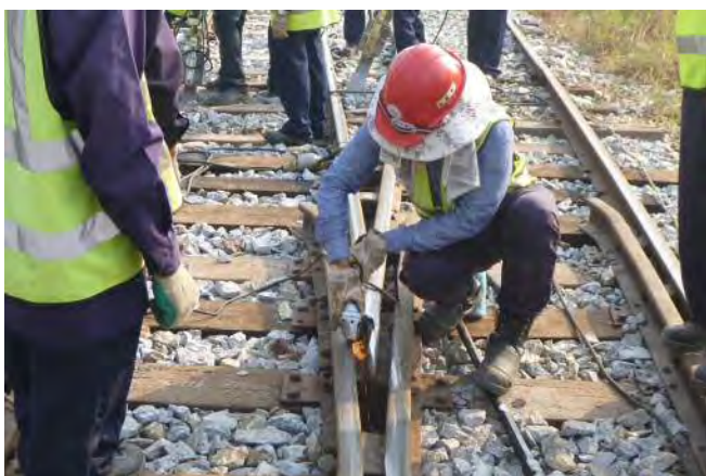
クロッシング部のフロー削正
