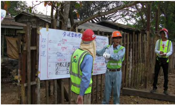
点呼・作業説明
