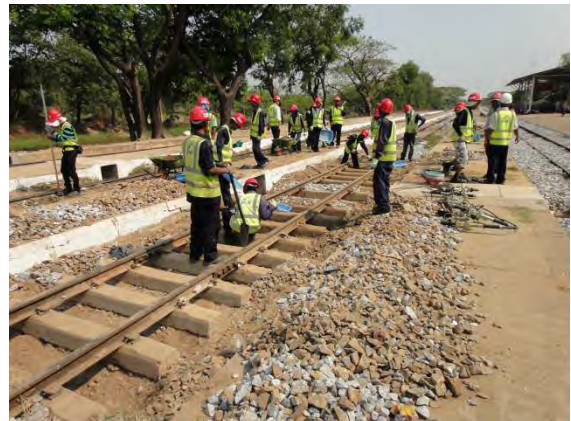
バラスト補充(施工中)
