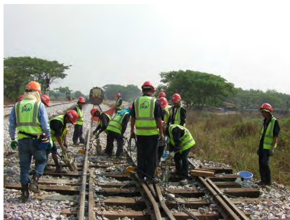
総つき固め(61A号分岐器)
