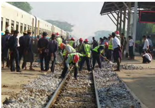
PCマクラギ交換(道床かき出し)
