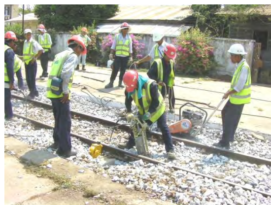
道床締め固め
