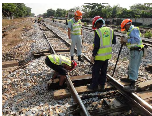
分岐マクラギ交換
