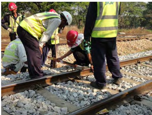
測量結果を基に扛上量の印付け
