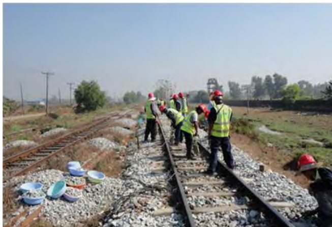
TTによる突き固めの状況
