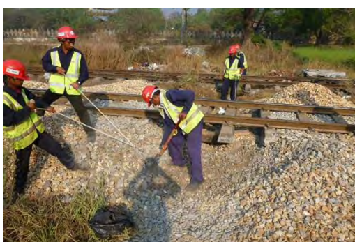
水路修繕(バラスト掻き出し)
