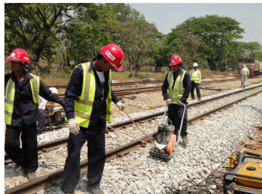
バラスト締め固め
