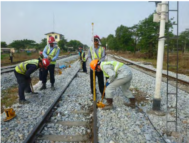
レベルによる線路扛上
