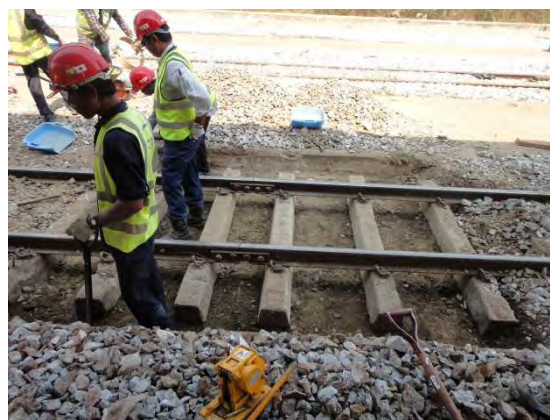
道床交換(道床撤去状況)
