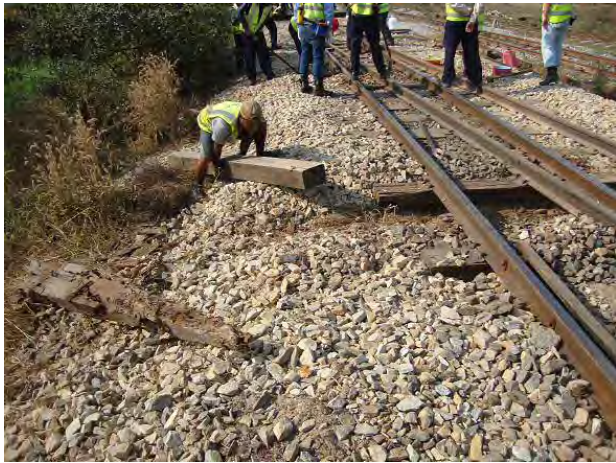
古枕木と新枕木
