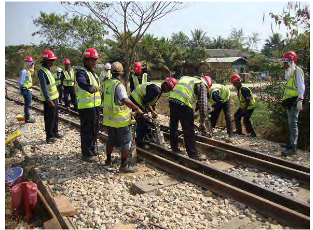
分岐器付近突き固め②
