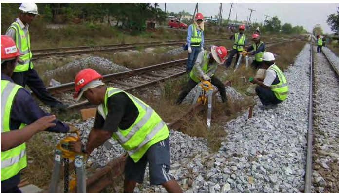
レール吊り上げ器を使ってレール位置整理
