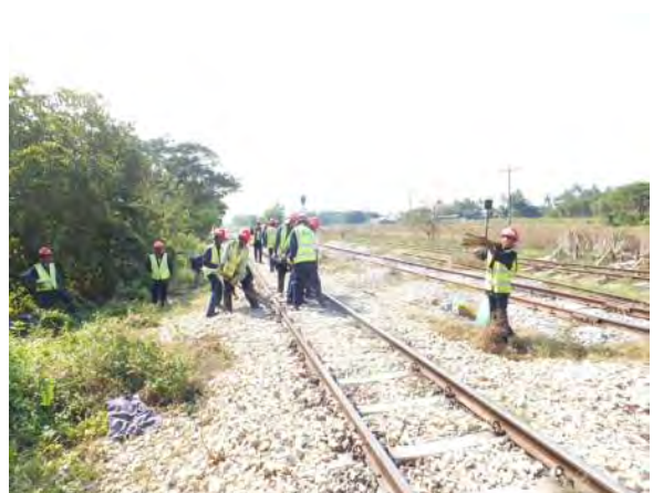
下り線 12km460m 付近通り直し
