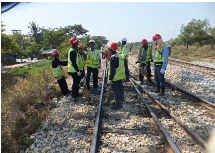
分岐器浮き木マクラギつき固め
