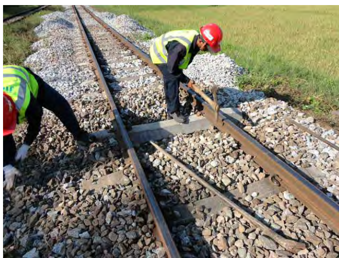
損傷PCまくらぎ交換
