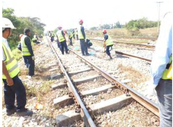
下り線 12km480m 付近道床補充
