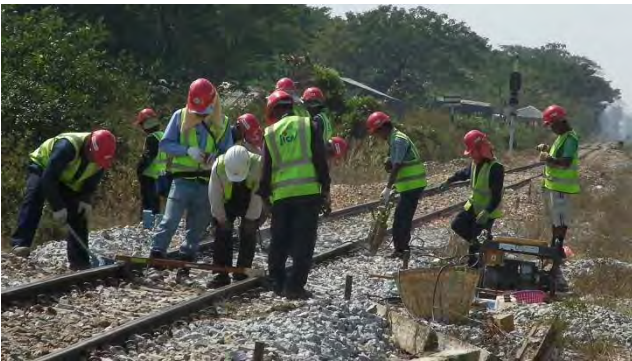
レール扛上量計測と総つき固め
