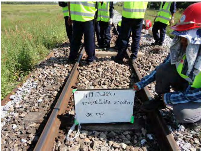
まくらぎ位置整正施工中
