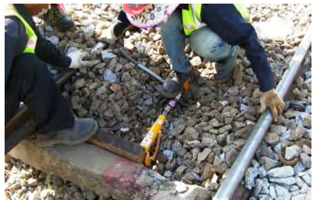
レマクラギ位置整正器を使って破損マクラギの移動
