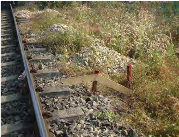
バラスト投入前
