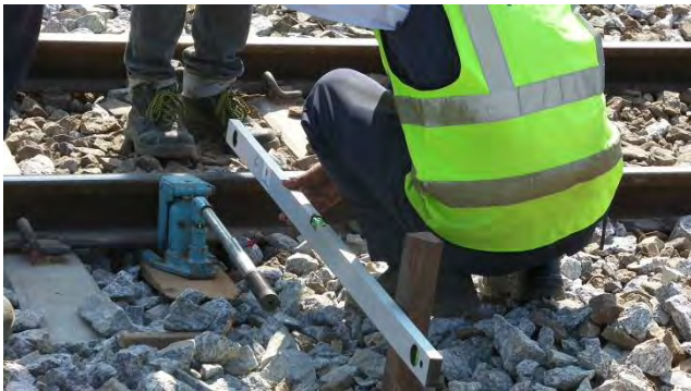
レール扛上量マーキング
