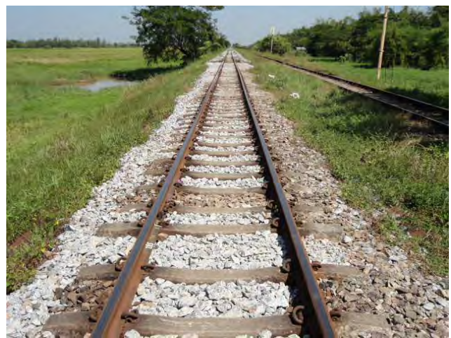
作業終了時 (橋梁部を含めた区間)
