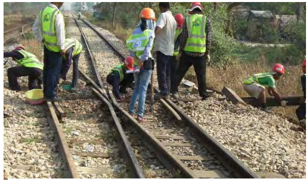
5m マクラギ挿入
