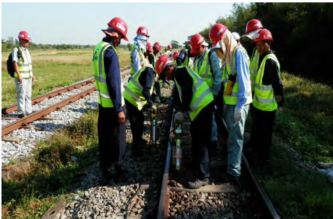
T・Tによるつき固め
