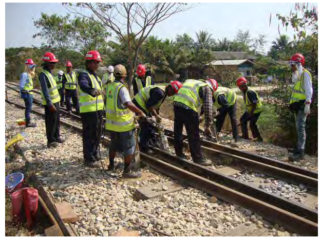
分岐器付近突き固め
