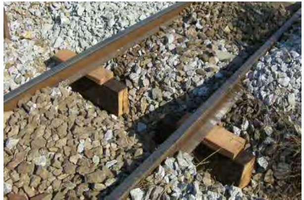
短木マクラギを使って仮レール受け
