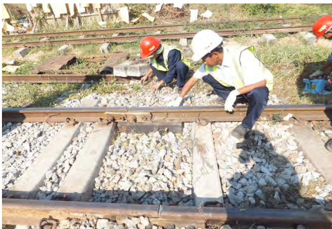
縦短マクラギ挿入
