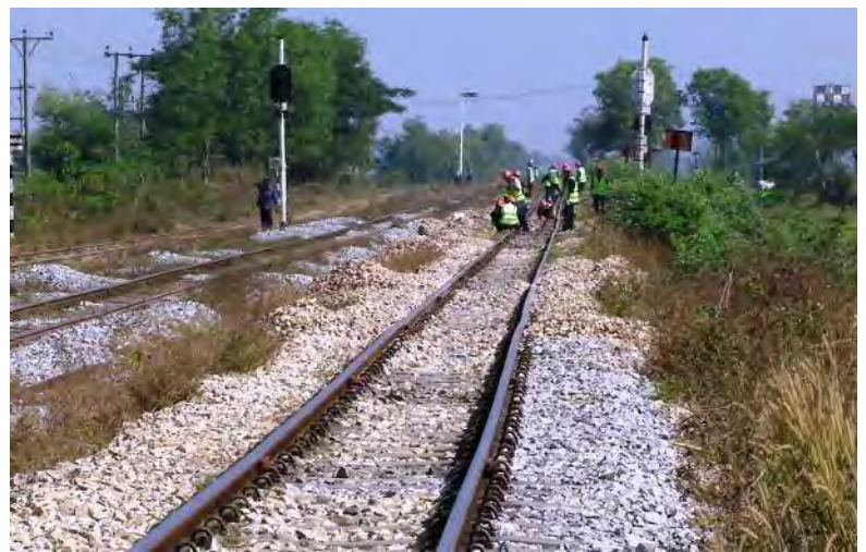
砕石補充とマクラギ位置修正
