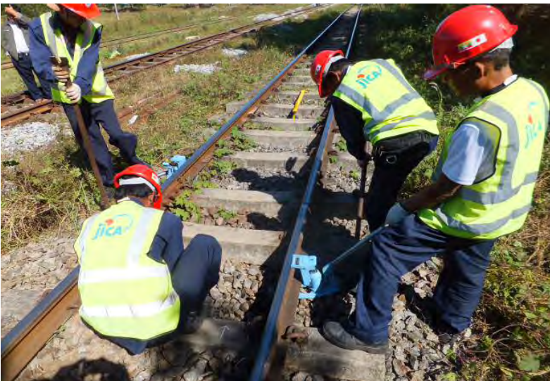
マクラギ位置修正
