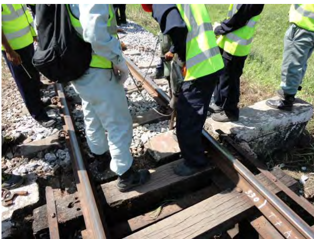
橋梁アバット部つき固め
