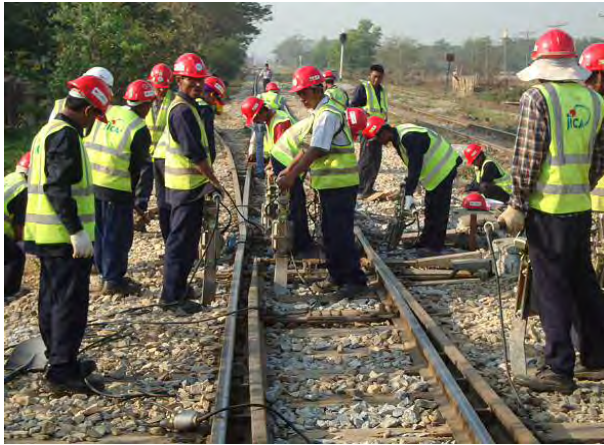
分岐器付近突き固め①
