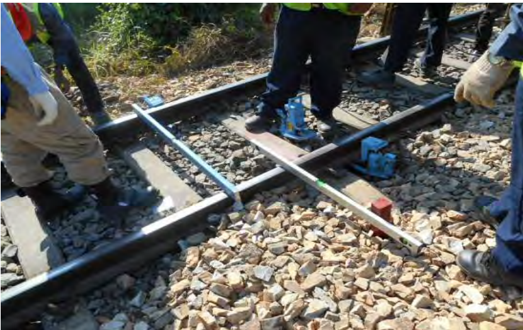
基準杭と基準レールのレベル合わせ
