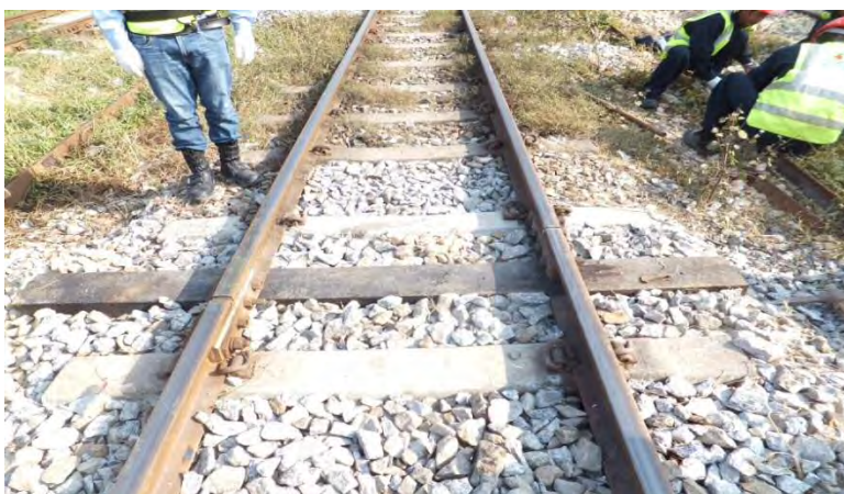
継目用木マクラギ挿入
