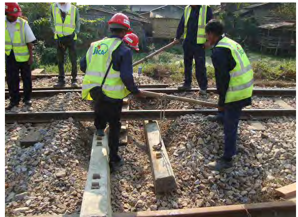
PC 枕木挿入
