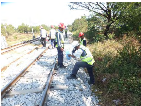
下り線 12km480m 付近右側肩道床補充
