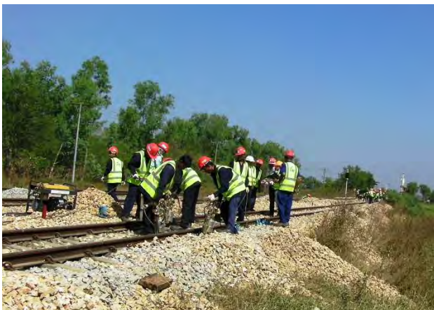
総突き固め(ヤンゴン方)
