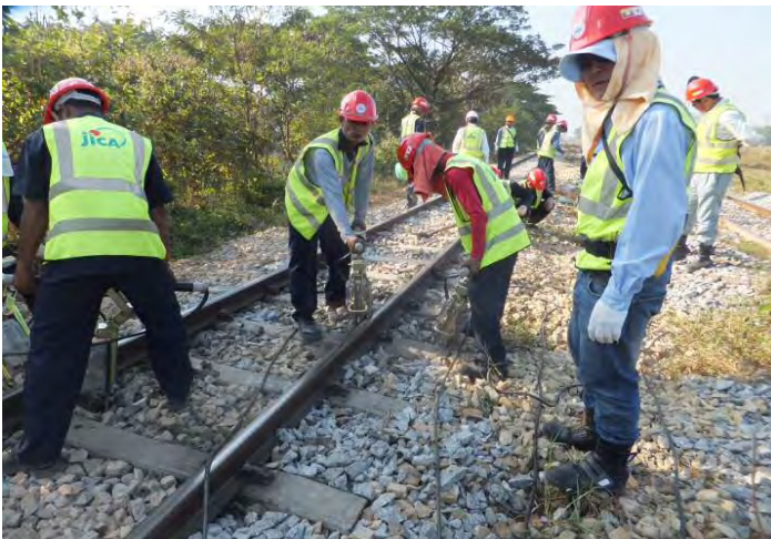
マクラギつき固め
