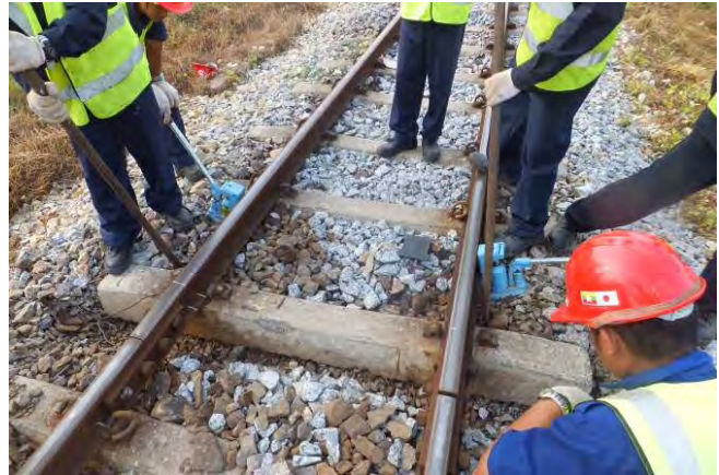
マクラギ位置整正指導 (A・Bグループ)
