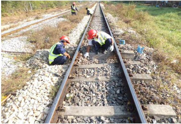
マクラギ位置修正
