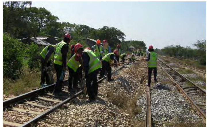
総突き固め(バゴ一方)
