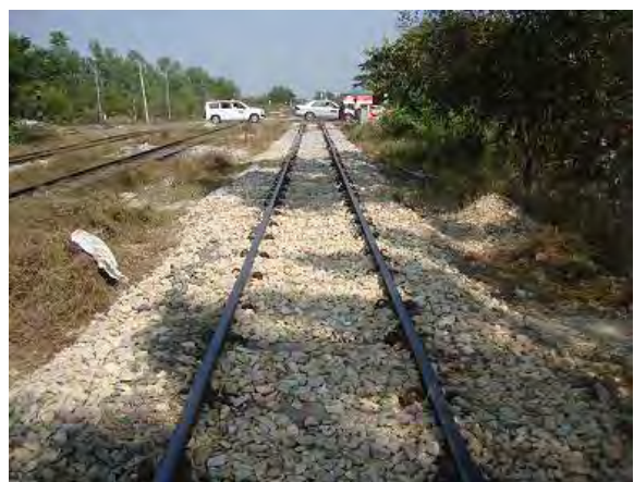
道床補充・道床整理後の状況
