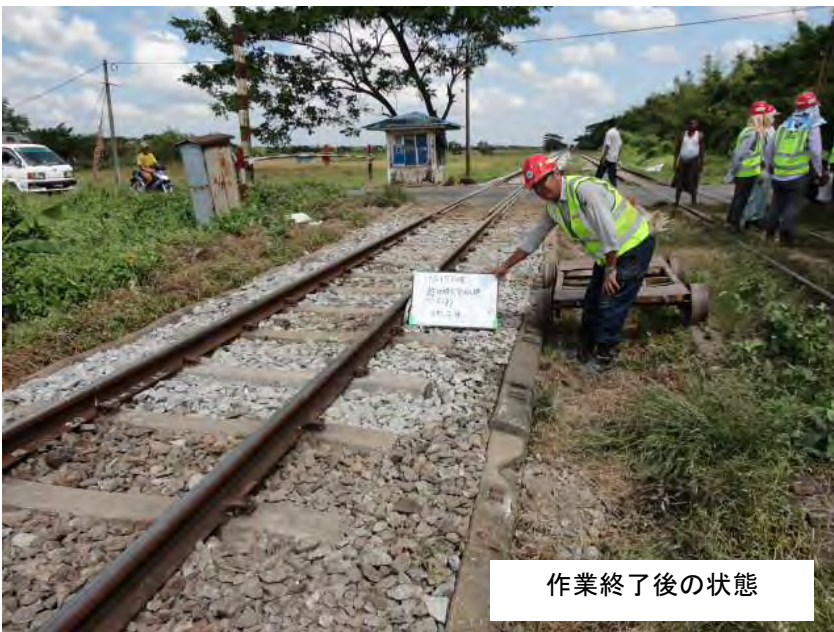
踏切起点方の高低調整・むら直し
