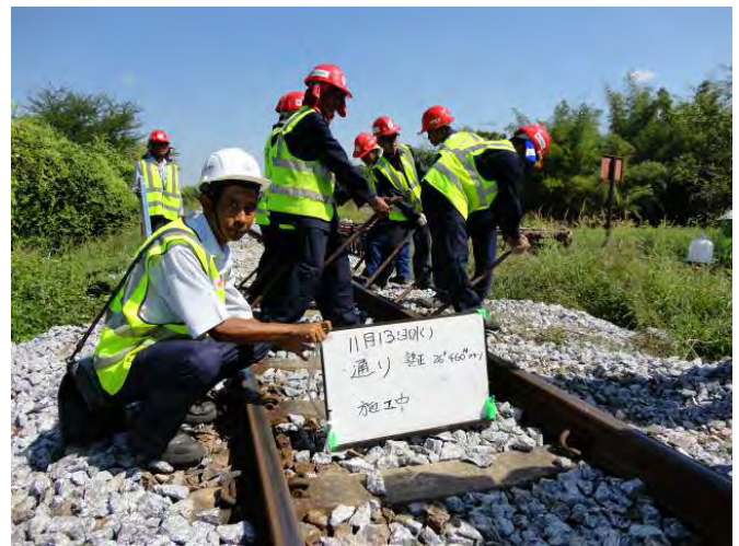
通り整正作業中
