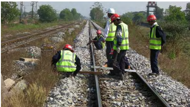
レール扛上量計測
