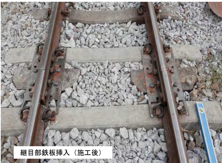
上り線 不良まくら木(折損)交換 1
