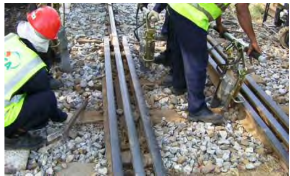
踏切脇つき固め
