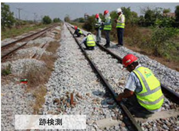
マクラギ位置修正
