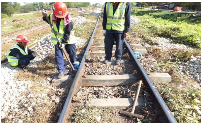
マクラギ位置修正
