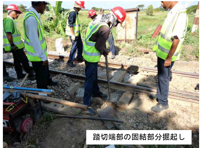
踏切起点方の高低調整・むら直し
