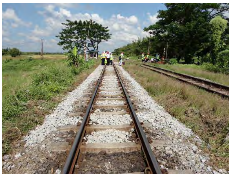
作業終了後の状態
