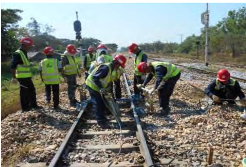
下り線 12k810 付近総つき固め
