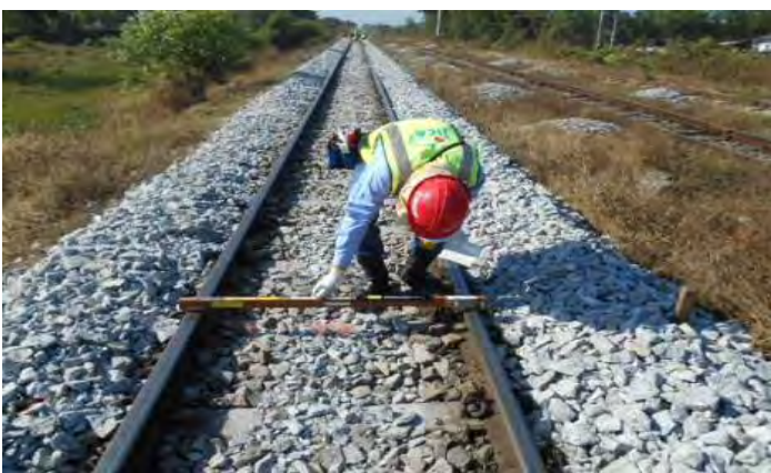
施工後の水準測定
