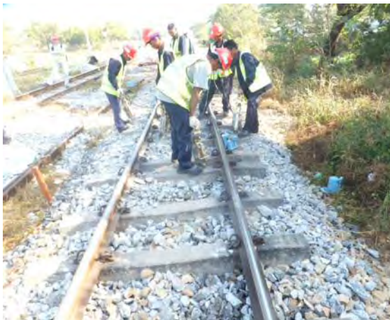
下り線 12km400m 付近むら直し
