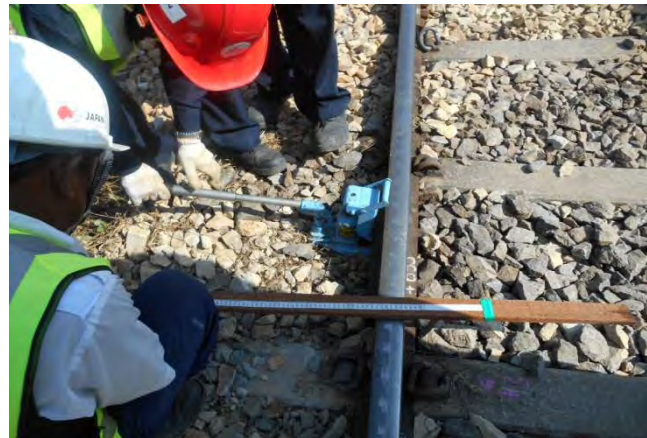
基準杭と基準レールのレベル合わせ
