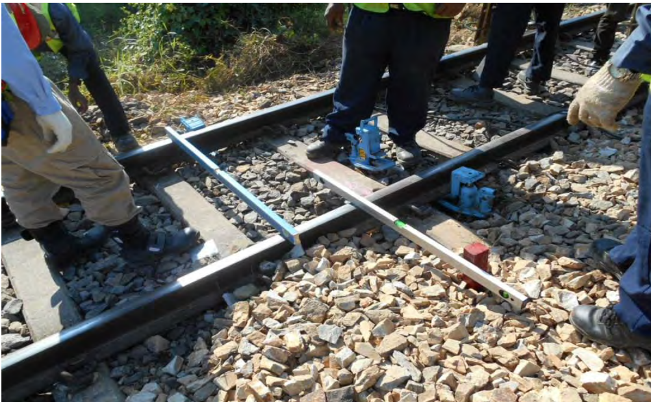
基準杭と基準レールのレベル合わせて、レール扛上
