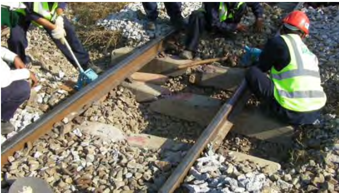
破損マクラギ撤去
