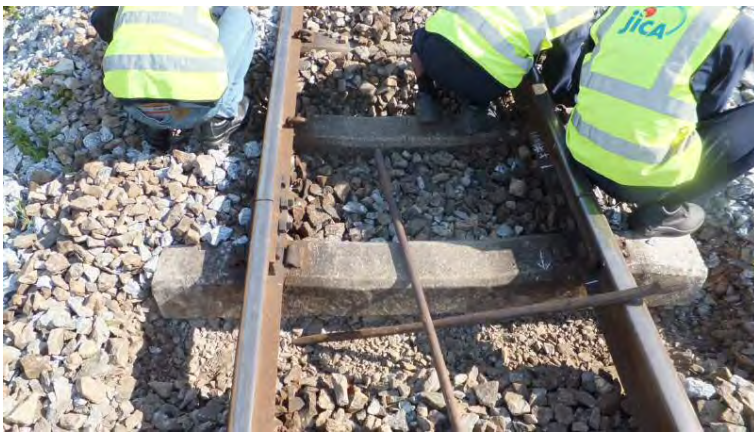
マクラギ位置修正指導 (C・Dグループ)
