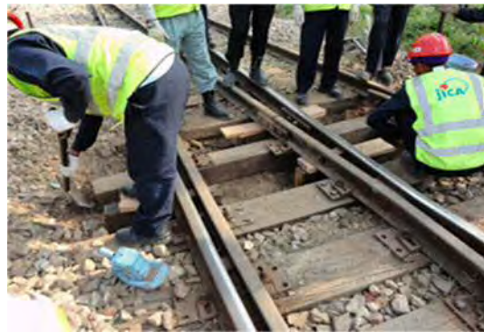
分岐マクラギ挿入
