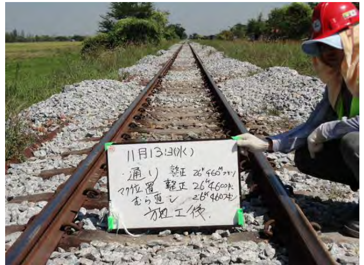
施工後の線路状態
