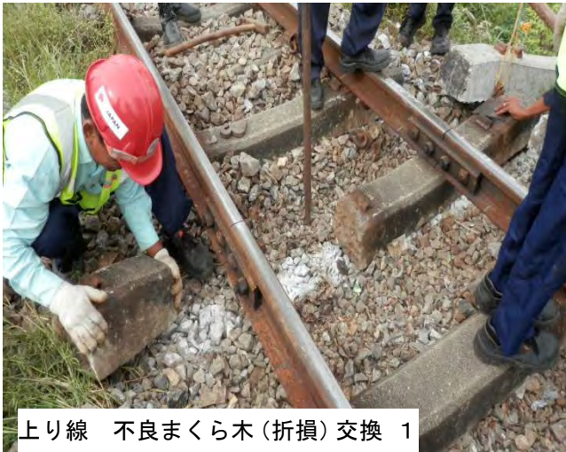
上り線 不良まくら木(折損)交換 2
