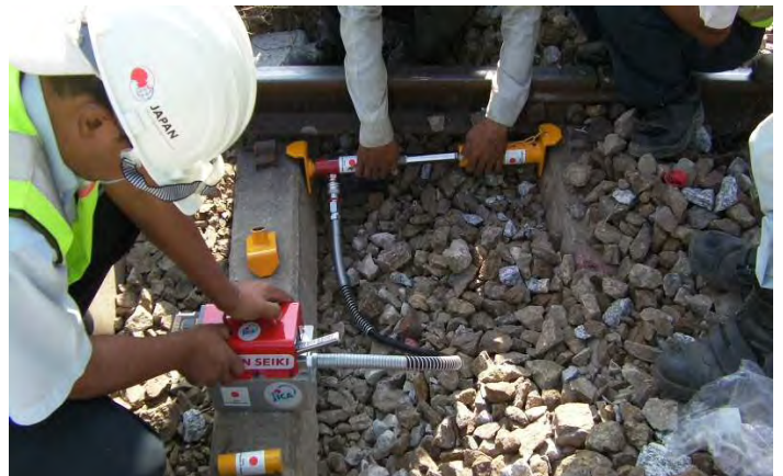
マクラギ位置修正器を使って位置修正
