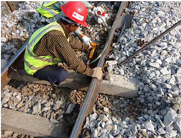
マクラギ位置修正
