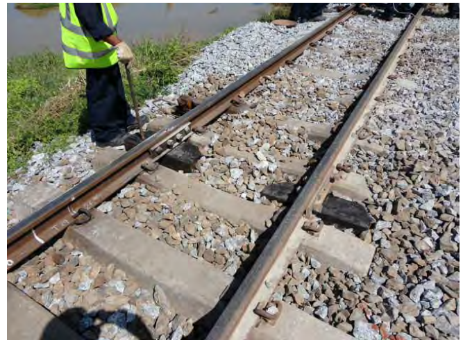
継目部四つ切まくらぎ挿入
