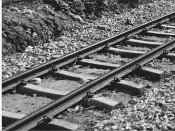
Ballast မလုံလောက်ခြင်း၊ပုံသဏ္ဍန်မမှန်ခြင်း။
