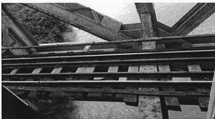
တံတား: Guard Rail ၏ Construction အခြေအနေ
