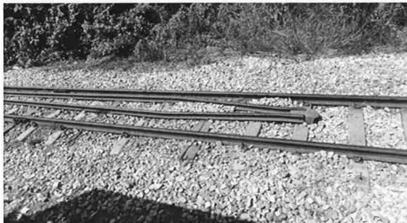
Guard Rail ထိပ်ပိုင်းရှိ installation အခြေအနေ
