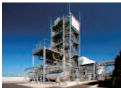
สิ่งอำนวยความสะดวกเก็บรวบรวมและแยก คาร์บอนไดออกไซด์ที่ได้ติดตั้งไว้ที่ โรงไฟฟ้าพลังงานความร้อนถ่านหิน
