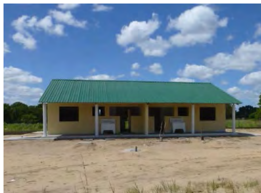
写真6 マンジャカゼ校の教員宿舎（建設中）
