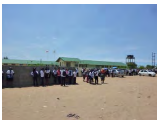
写真 2 マプト州コンゴロテ校
