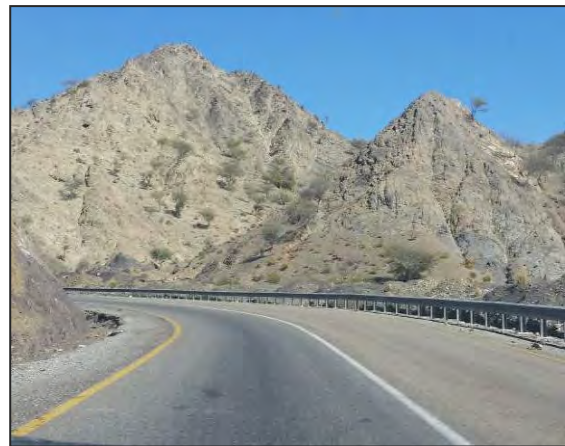
改良された道路
