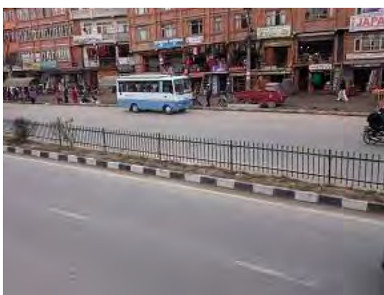
写真 1 中央分離帯の防護柵
