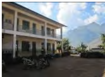
写真 1:プロジェクトにより建設された小学校。午前中はミャンマー学校、午後はプライベートで中国人教師による授業が行われている。
