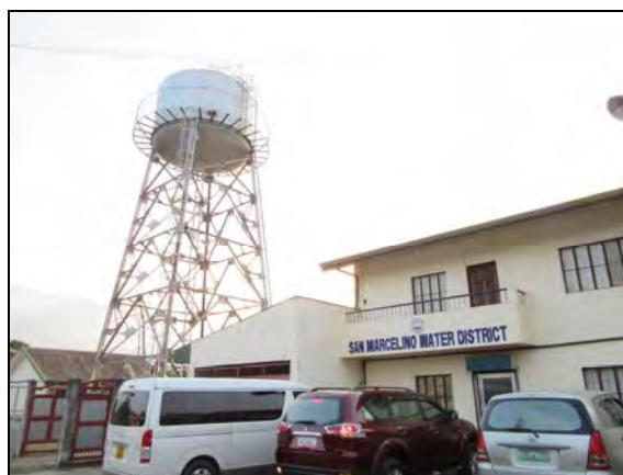
本事業で建設した高架水槽 (サン・マルセリノ水道区)
