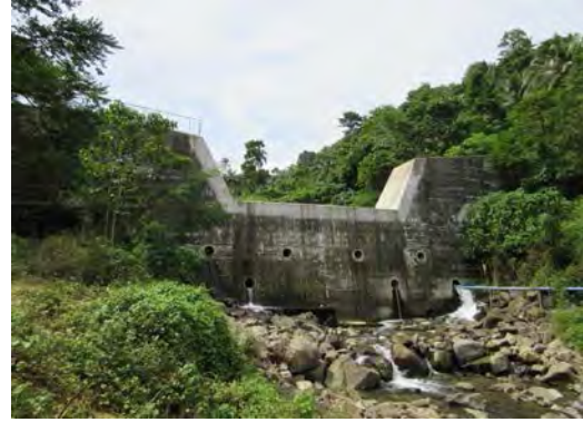
事業で整備した砂防ダム（下流側）
