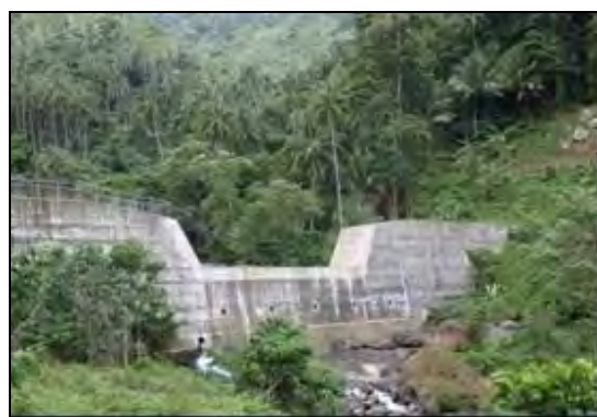
事業で整備した砂防ダム（上流側）
