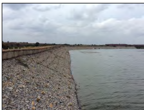
本事業で新設されたアラガヌル調整池
