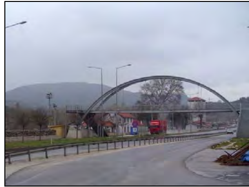
写真4 国道 D650 号線の歩道橋
