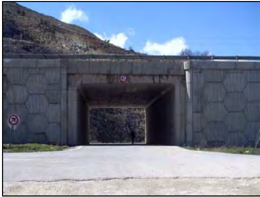
写真3 国道 D650 号線下の通路
