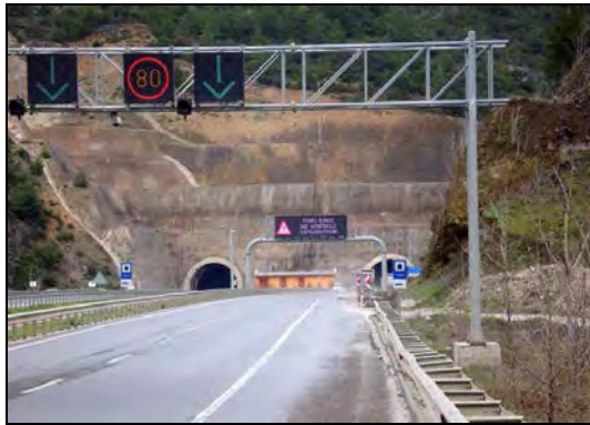
写真1 D国道650号線のトンネル
