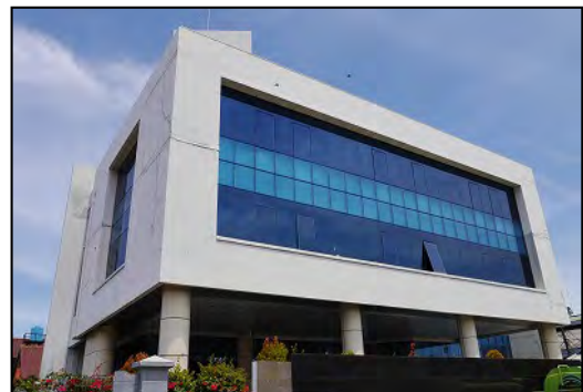
写真 6：増設された漁港管理事務所 (UPT) （事後評価時）
