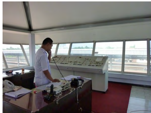
写真 8：整備された管制塔・運行制御装置
