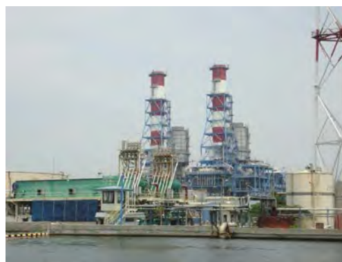
ムアラカランガス火力発電所（ブロック2）
