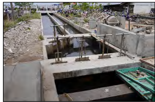
写真 8：海水浄化システム （事後評価時）
