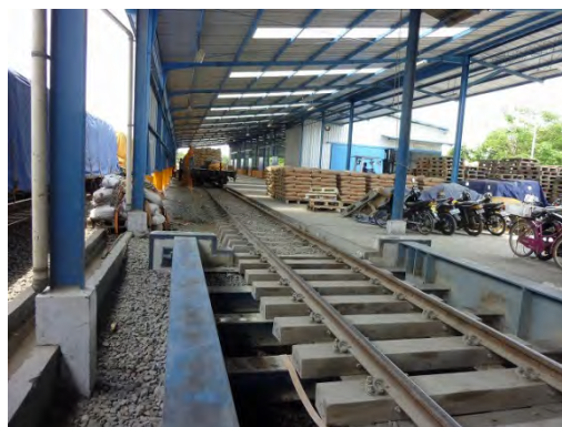
本事業で整備された路床部分 (軌道はインドネシア側自己資金にて実施)
