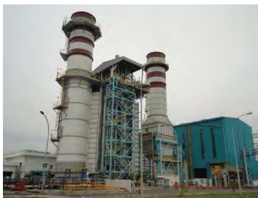
ムアラタワルガス火力発電所（ブロック 5）
