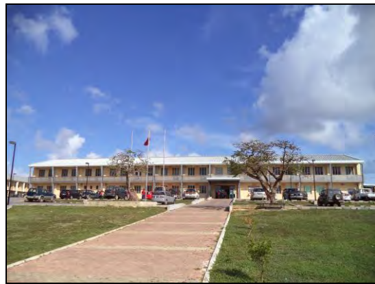
本事業で整備した外来棟
