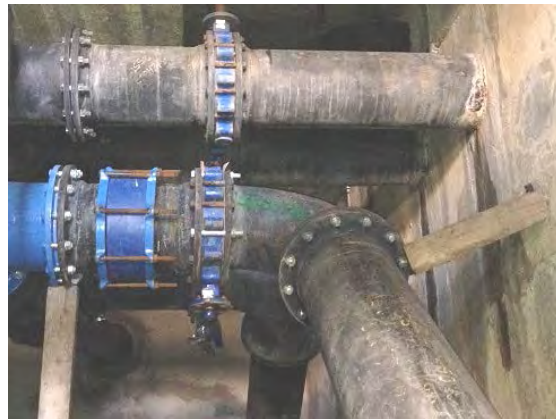
アランプェス浄水場で修理されたパイプ
