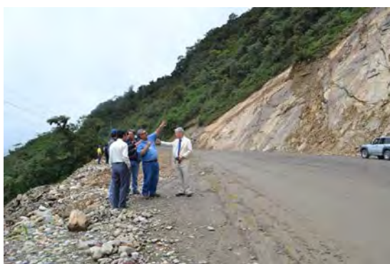
国道4号線の法面崩壊現場 法面が大規模に崩壊したため、本来の幅員よりも大幅に広い道路幅員となっている。
