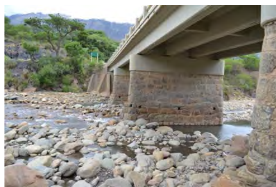
国道7号線ポホ橋の補修 主桁、床板に発生していたひび割れを補修し、大型車両荷重へ対応可能となった。 (パイロットプロジェクト)
