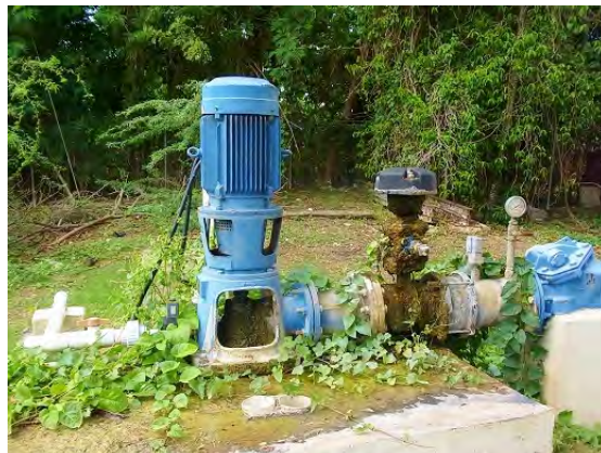
片方の塩素注入ポンプがスペアパーツ として取り外された井戸 (Friendship Well)
