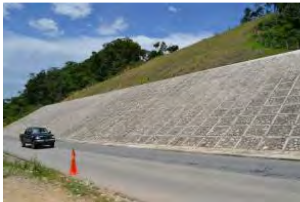
国道1号タリハ県バリアンテにおける法面保護工 (パイロットプロジェクト)
