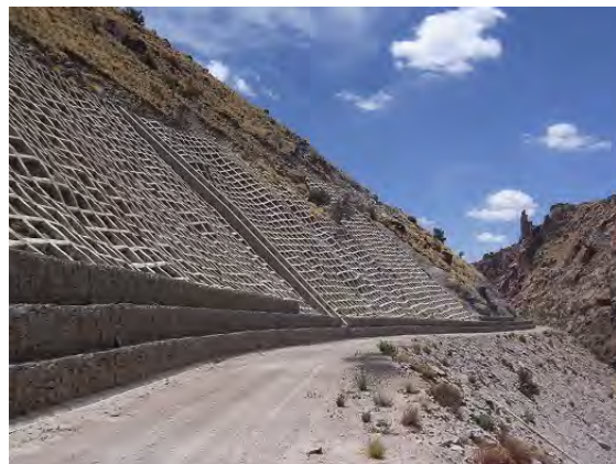
取水口アクセス路の斜面保護工
