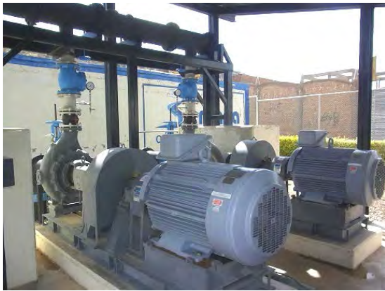
シグロベインテポンプ場
