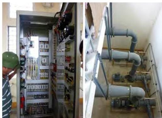
写真 2：ナムチュン・ポンプ場内の制御機器（左）及びポンプユニット（右）
