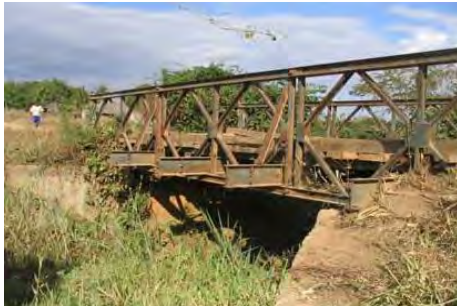
(出所) 準備調査報告書 図3 事業前 冠水していた橋梁
