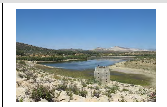
本事業により建設された小規模ダム (撮影：2015年6月、スース県)
