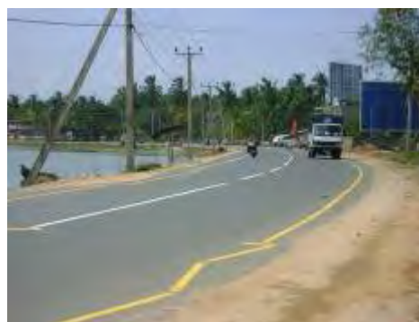
国道15号線 バティカロア周辺 事業完了後
