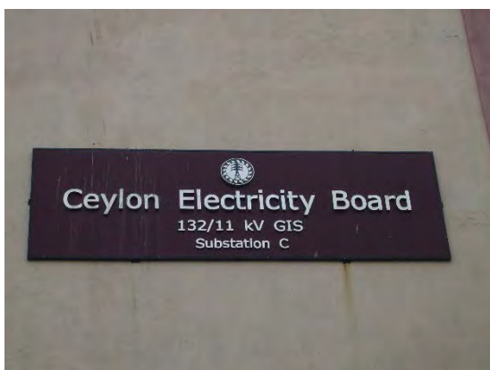
変電所 C 入り口
