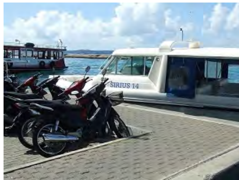
本事業で修復した マレ港湾岸壁の一部
