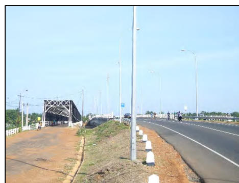
カラディ橋アプローチ（左側は旧橋）
