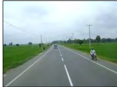
国道4号線アダラクチェナ周辺 事業完了後
