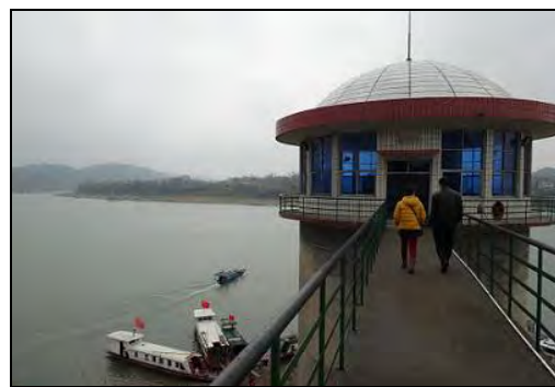
整備後はポンプで川から水を汲み上げ、 浄水場で処理を行った後、各家庭に送られる
