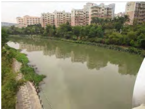
写真2 竹排水路の護岸
