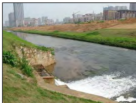
写真 3 新開鋪污水处理場の処理水放流先（圭塘河）
