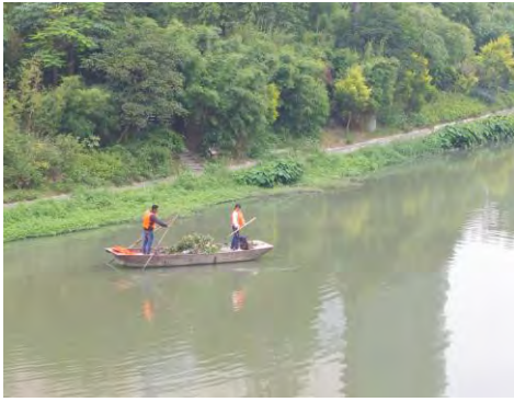
写真 8 竹排水路の定期的な清掃
