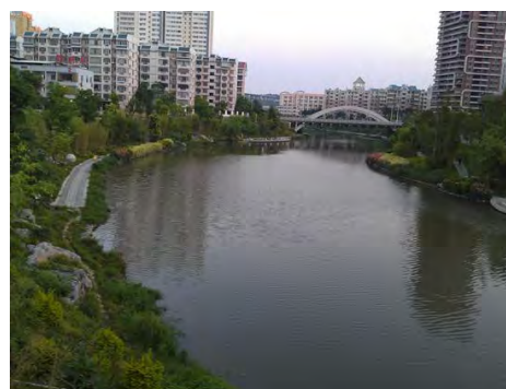
写真1 南寧市：本事業によって整備された護岸と橋
