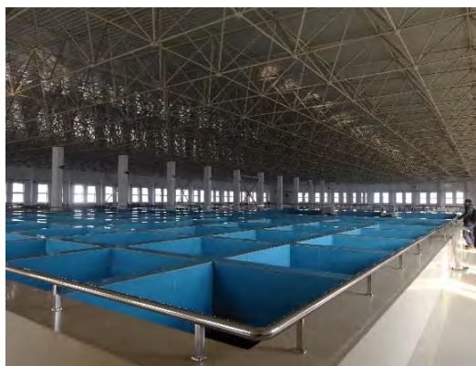
写真1 上水道整備事業で建設された浄水場
