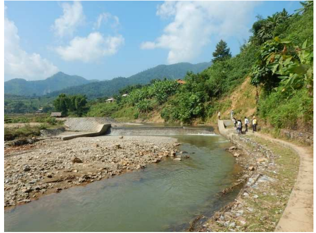
NORRD で建設した取水口 (ムオング 1 村パイロット地区、タンザオ郡)
