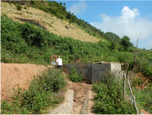
NORRD で建設した分土工 (ホーチム 2 村パイロット地区、ムンチャ郡)
