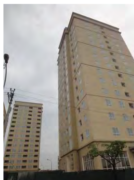
2013年12月に入居開始予定の15階建て住棟 (夫婦用住宅も完成)
