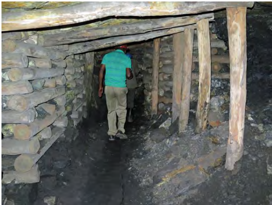
7 : 坑口近傍部の支保状況
