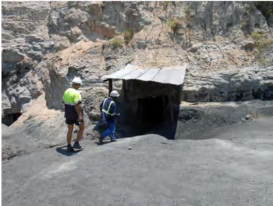
3 : 作業員用坑道坑口
