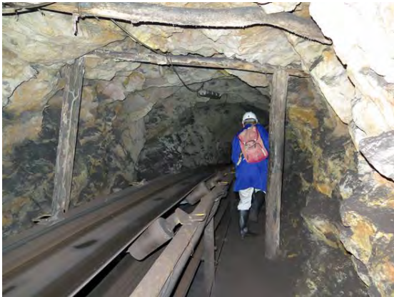
3 : コンベイヤー用坑道
