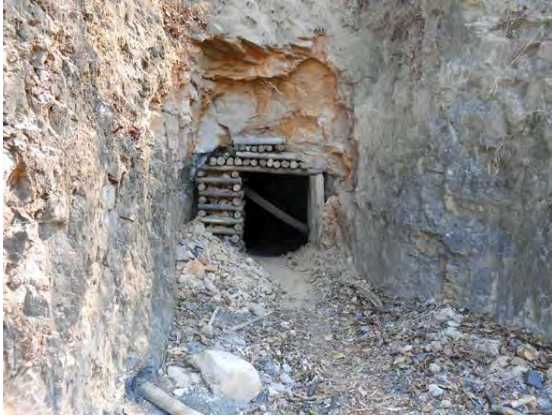
5 : 廃坑の坑口状況
