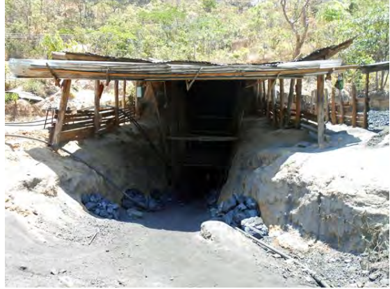
2 : 運搬用坑道坑口
