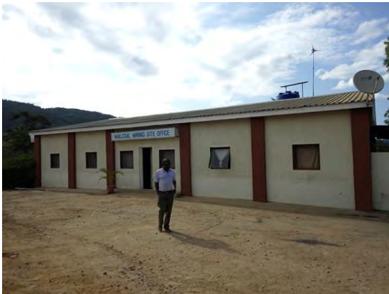
1 : Nkhachira 炭鉱事務所
