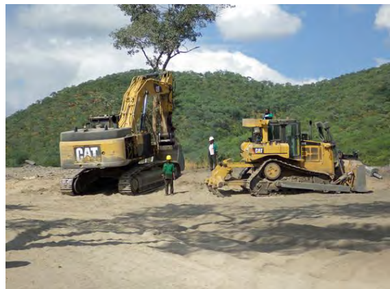
4 : 使用重機 エクスカベーターとドーザー
