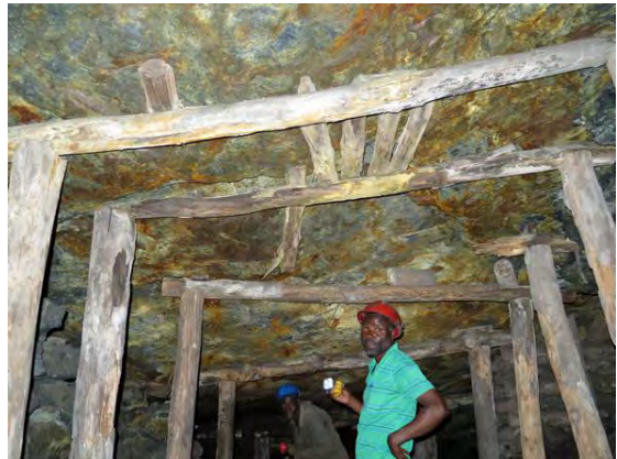
8 : 坑口近傍部の天盤状況
