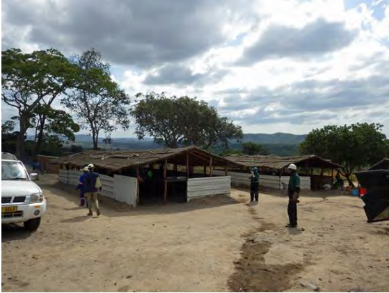
11：休憩などの建屋
