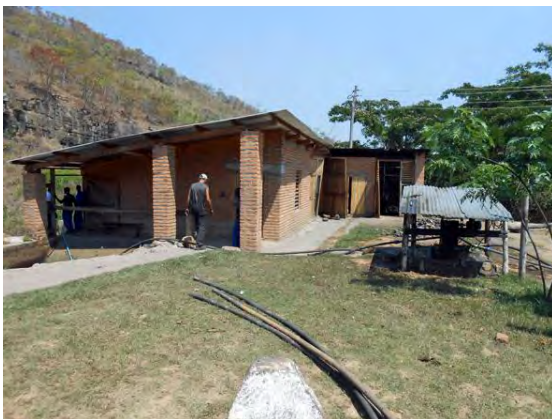
11：水力発電の建屋
