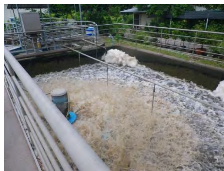
QTSC の集中排水処理施設
