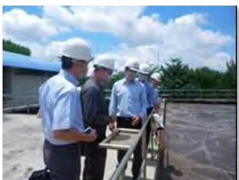
Hiep Phouc 工業団地の集中排水処理施設
