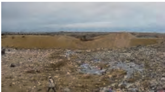
Commencement de l'excavation et de la suppression d'une partie de la digue périphérique.
