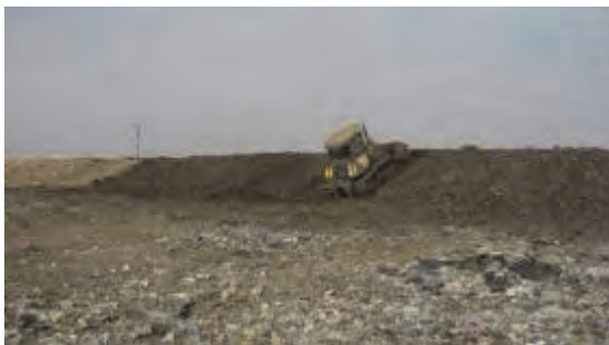
Formation de la pente de DMA et compactage avant la couverture
