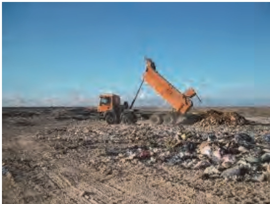
Deuxième phase de la couverture de sol de la zone à gauche de l'entrée (couverture avec l'apport de débris de construction et d'excavations de sédiments générés dans la commune)
