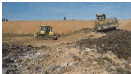
Travaux de couverture après le compactage dans l'aire au fond à gauche dans la fosse
