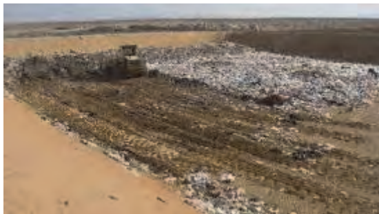
Travaux d'épandage des DMA dans l'aire au fond à gauche dans la fosse
