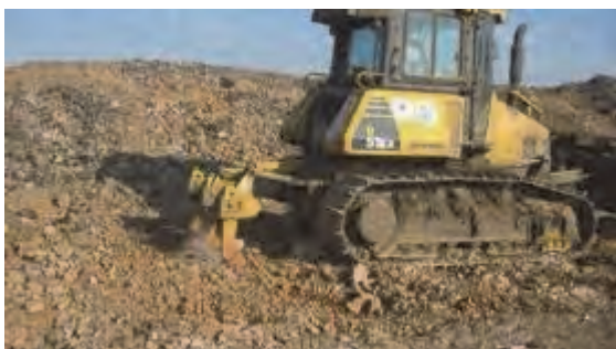
Approvisionnement au matériau de couverture en creusant dans le sol à proximité du pied de la pente.
