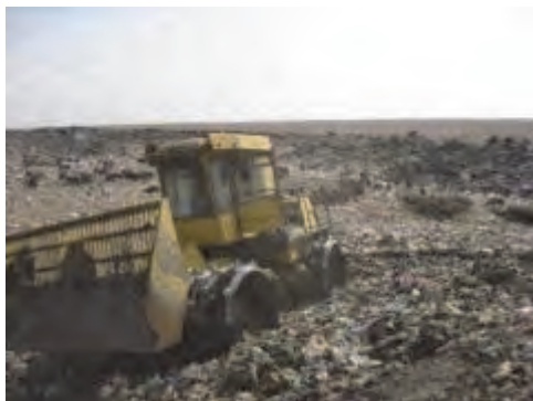
Essais à part de travaux de compactage déplaçant en continu la pente dans le sens longitudinal
