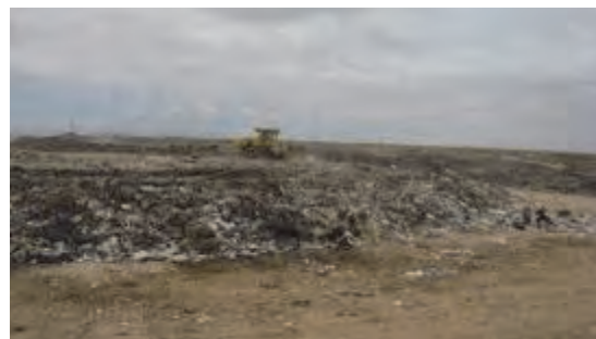
Situation de la deuxième phase d'enfouissement à gauche de l'entrée fin septembre 2015
