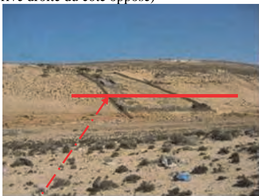
Niveau d'eau supposé lors des inondations en novembre 2014
