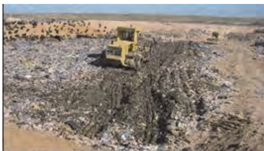
Compactage de l'aire d'enfouissement existante avant de commencer la couverture de sol (vue sur le centre de la fosse à partir d'un endroit proche de l'entrée)
