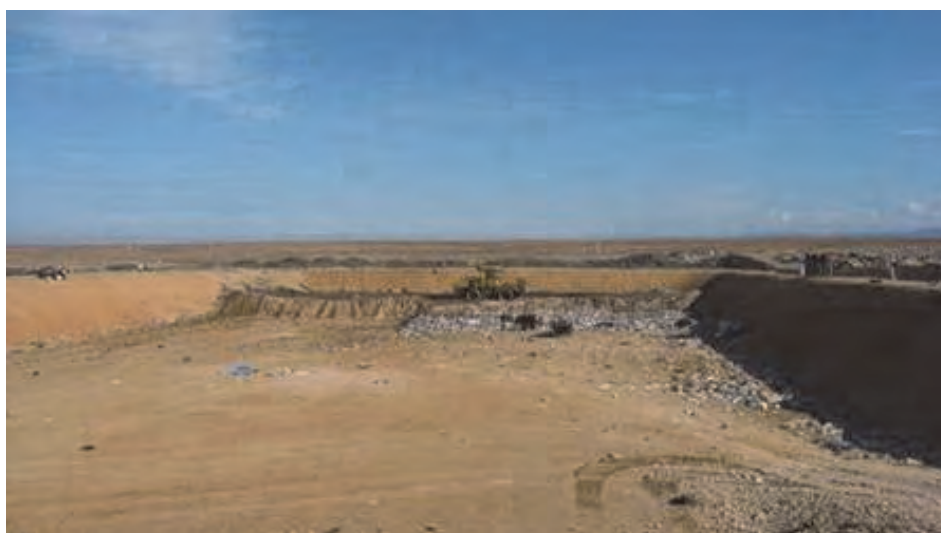
Situation de l'enfouissement au fond de la fosse (cliché d'octobre 2014, avant les pluies torrentielles fin novembre)
