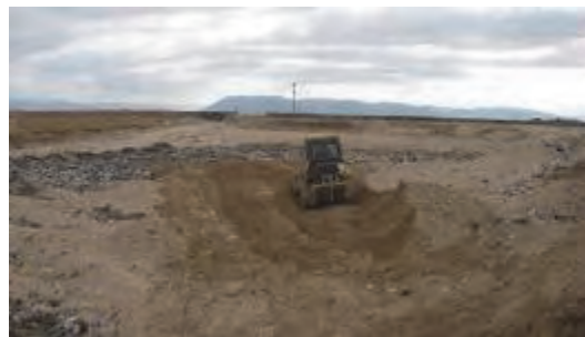
Élargissement de la couverture de sol par excavation d'une portion à côté de la partie de digue retirée pour l'élimination des eaux des inondations.
