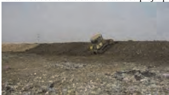
Mise en forme et compactage de la pente des déchets avant la couverture
