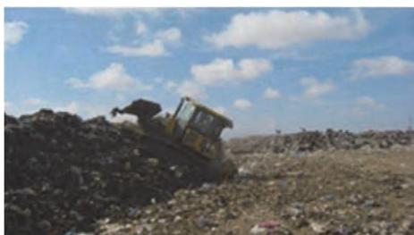
Épandage et compactage de la pente
