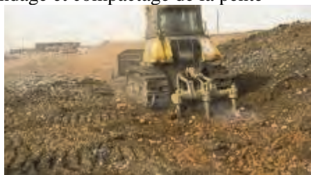
Excavation de la terre au pied de la pente
