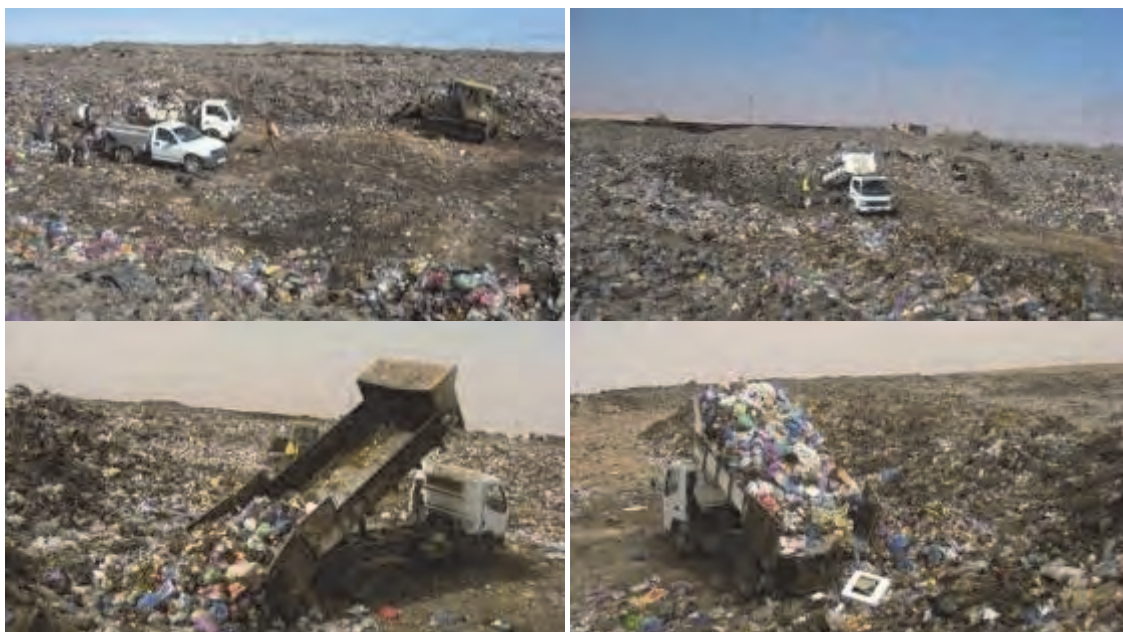
M. Arhil Abdelhadi M. Arhil Abdelhadi, superviseur qui guide les véhicules à décharger les DMA à proximité du pied de la pente
