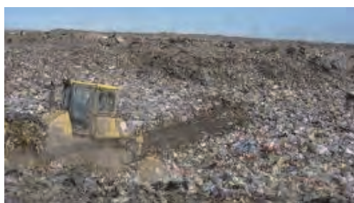
Travaux d'épandage des déchets en utilisant la lame du bulldozer
