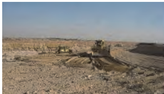
Élargissement de la couverture de sol par excavation d'une portion de la digue à proximité de l'entrée de la fosse.
