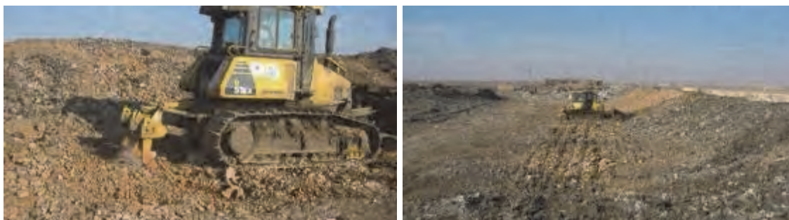
Approvisionnement au matériau de couverture en creusant dans le sol à proximité du pied de la pente.
