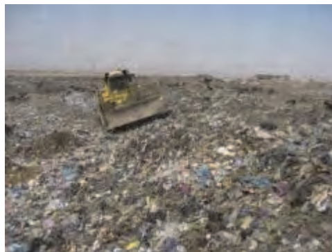
Essais à part de travaux de compactage déplaçant en continu la pente dans le sens longitudinal
