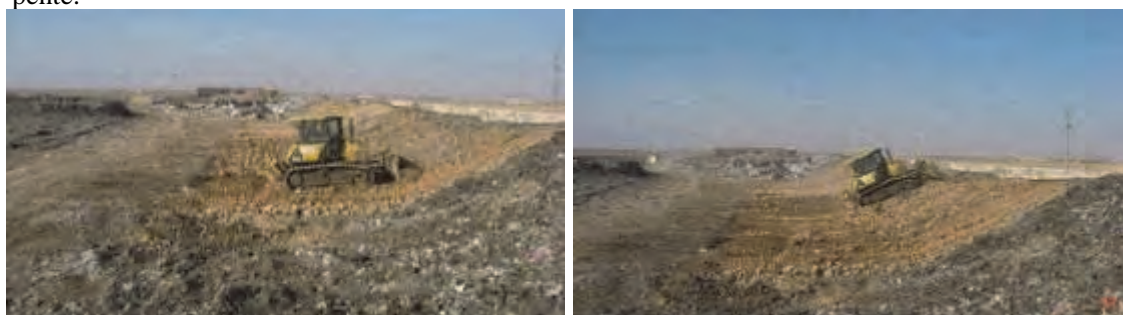
Approvisionnement au matériau de couverture en creusant dans le sol à proximité du pied de la pente.
