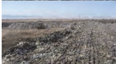
Essais de travaux de compactage par passages successifs dans le sens longitudinal de l'extrémité de la pente.
