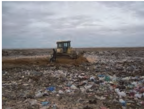
Deuxième phase de la couverture de sol de la zone à gauche de l'entrée (couverture avec l'apport de débris de construction et d'excavations de sédiments générés dans la commune)
