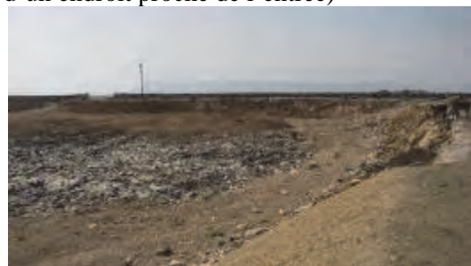
Excavation de l'intérieur de la pente à deux côtés de la digue entourant l'aire d'enfouissement existante à l'entrée, et élargissement de la couverture.
