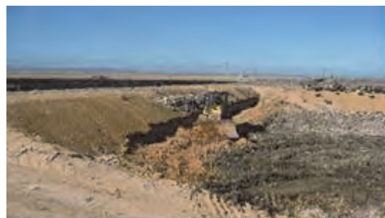
Excavation de la pente interne de la digue à l'aide d'un bulldozer et utilisation de ce matériau pour la couverture (proximité de l'entrée)
