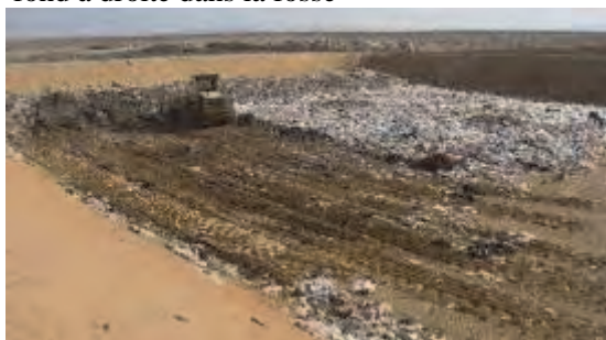
Travaux d'épandage des DMA dans l'aire au fond à droite dans la fosse
