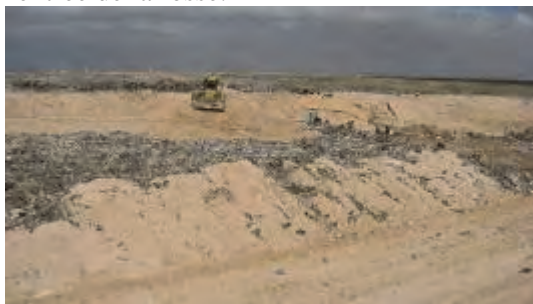
Élargissement de la couverture de sol par excavation d'une portion à côté de la partie de digue retirée pour l'élimination des eaux des inondations.
