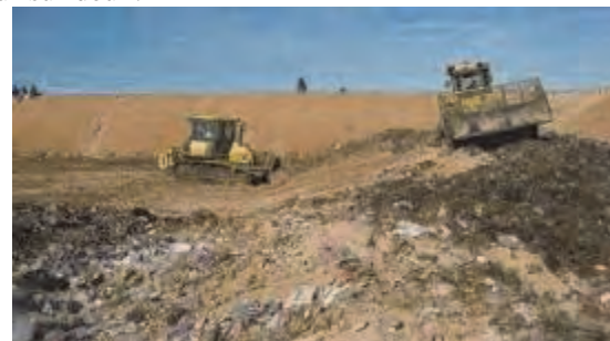
Travaux de couverture après le compactage dans l'aire au fond à gauche dans la fosse
