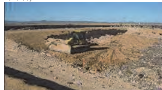
Excavation de l'intérieur de la pente à deux côtés de la digue entourant l'aire d'enfouissement existante à l'entrée, et élargissement de la couverture.
