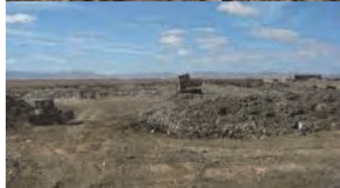
Essais de travaux de compactage par passages successifs dans le sens longitudinal de l'extrémité de la pente.
