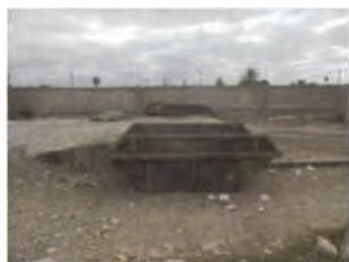
Simple centre de transfert
