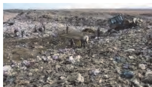
Travaux d'épandage des déchets en utilisant la lame du bulldozer
