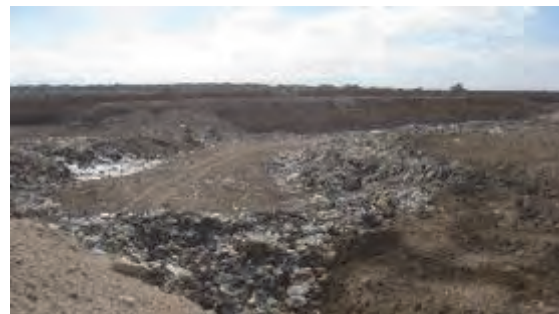
Aire de la première phase d'enfouissement qui a diminué restant au milieu de la fosse (achèvement de la première phase de couverture de sol à l'entrée, à droite de la photo, aire dont l'enfouissement est terminé au fond de la fosse à droite de la photo) février 2015
