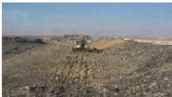
Approvisionnement au matériau de couverture en creusant dans le sol à proximité du pied de la pente.
