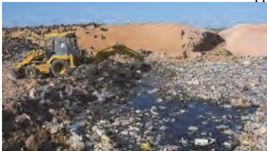
Commencement de l'excavation et de la suppression d'une partie de la digue et élimination de l'eau des inondations. Ensuite, rétrécissement progressif de la zone inondée.
