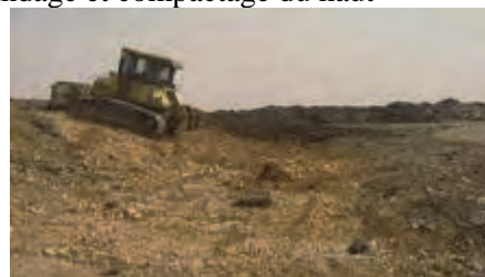
Couverture sur la pente en utilisant le matériau de déblai
