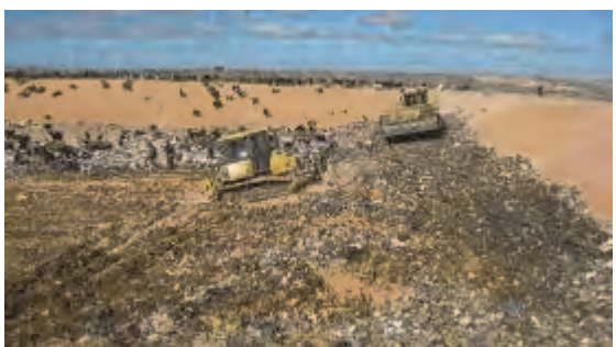
Compactage après épandage et accumulation des déchets ménagers et assimilés
