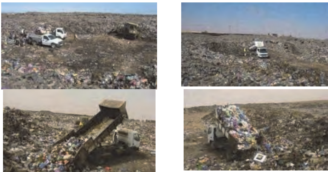
M. Arhil Abdelhadi, superviseur qui guide les véhicules à décharger les DMA à proximité du pied de la pente
