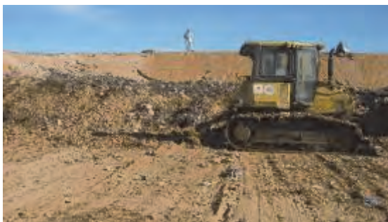
Excavation du sol au pied de la pente et utilisation de la couverture du sol de déblai
