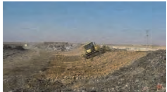
Apport de matériau de couverture composé de sol excavé au pied de la pente
