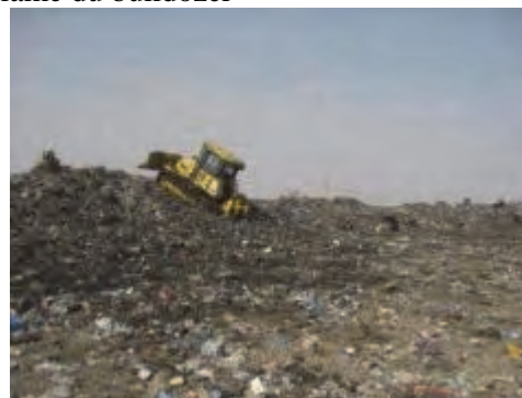
Travaux de compactage à l'aide de la chenille, sans utiliser la lame en la relevant
