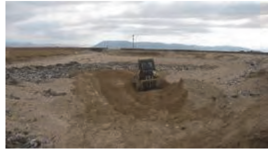
Élargissement de la couverture de sol par excavation d'une portion à côté de la partie de digue retirée pour l'élimination des eaux des inondations.
