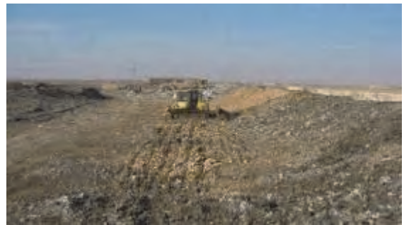
Apport de matériau de couverture composé de sol excavé au pied de la pente
