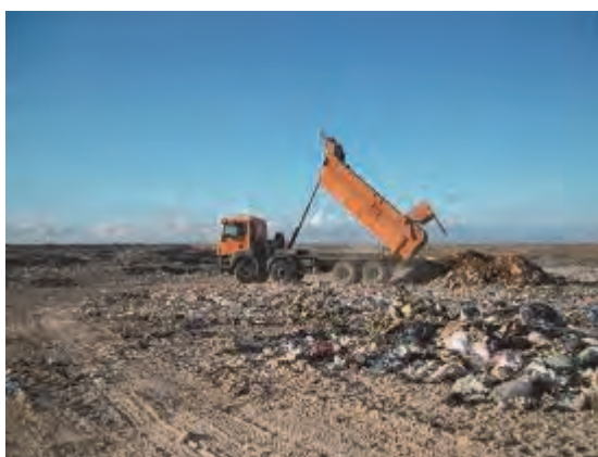
Deuxième phase de la couverture de sol de la zone à gauche de l'entrée (couverture avec l'apport de débris de construction et d'excavations de sédiments générés dans la commune)
