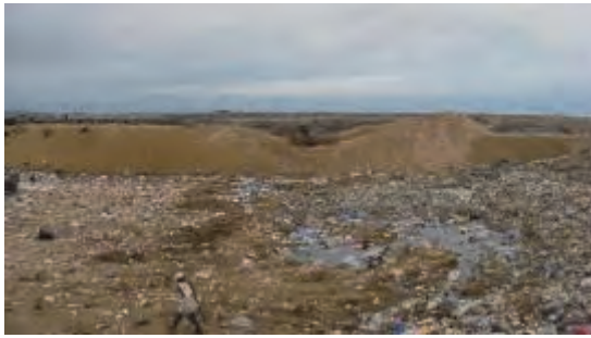
Commencement de l'excavation et de la suppression d'une partie de la digue périphérique.
