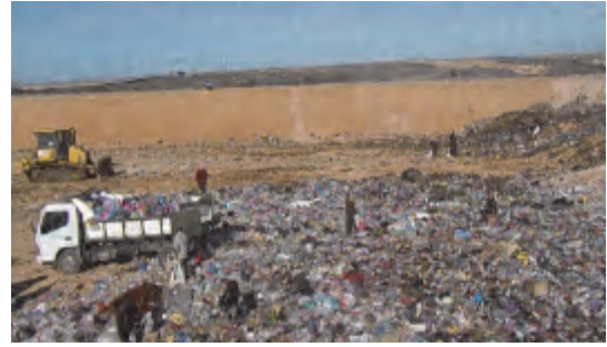
Déchargement dans l'aire au fond à droite dans la fosse
