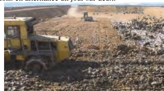
Opérations de compactage du sol sur la zone dans laquelle l'enfouissement est terminé à l'intérieur de la fosse
