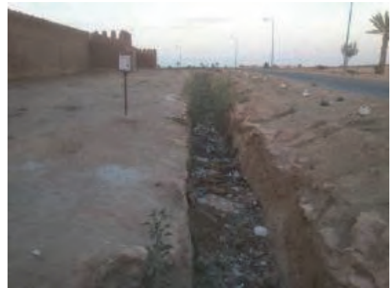
Photo 5-4 : Panneau d'interdiction de déverser des ordures (à gauche) et Blocs de maçonnerie de prévention de déversements illégaux (à droite)
