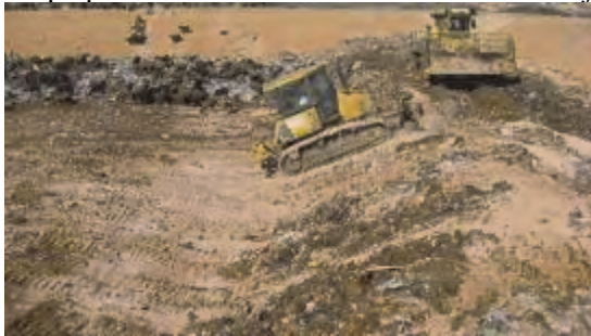
Travaux de couverture après le compactage dans l'aire au fond à droite dans la fosse
