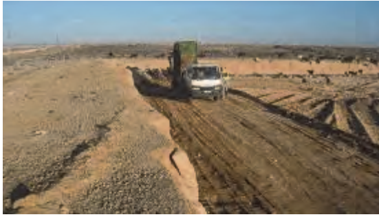
Essai de la deuxième phase d'enfouissement de déchets (au fond à gauche de l'entrée) Février 2015
