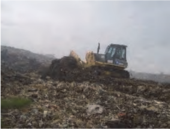
توزيع النفايات القديمة عند سفح المنحدر المشتغل بغرض الضغط عليها
