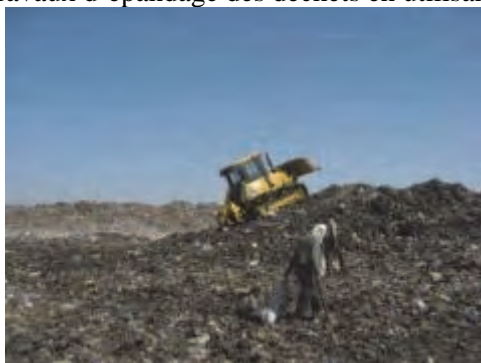
Travaux de compactage à l'aide de la chenille, sans utiliser la lame en la relevant
