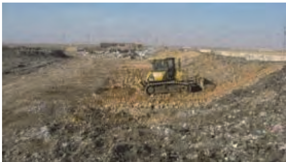
Travaux de couverture de la pente
