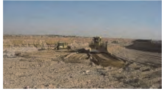
Élargissement de la couverture de sol par excavation d'une portion de la digue à proximité de l'entrée de la fosse.
