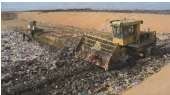
Compactage après épandage et accumulation des déchets ménagers et assimilés
