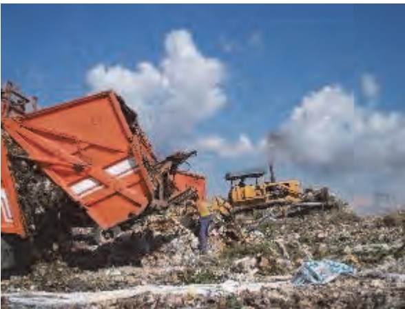
تفرغ النفايات عند سفح المنحدر. تقوم الجرافة بتسوية النفايات وضغطها عند المنحدر (زاوية معكوسة مقارنة مع الصورة الأعلى)
