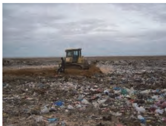
Deuxième phase de la couverture de sol de la zone à gauche de l'entrée (couverture avec l'apport de débris de construction et d'excavations de sédiments générés dans la commune)
