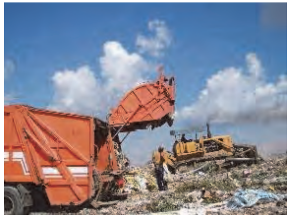
تفرغ النفايات عند سفح المنحدر. تقوم الجرافة بتسوية النفايات وضغطها عند المنحدر (زاوية معكوسة مقارنة مع الصورة الأعلى)
