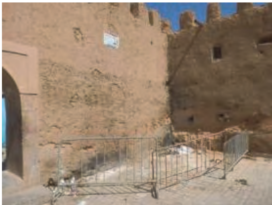
Photo 5-5 : Mise en place d'un panneau et de barrières visant la prévention de déversements illégaux
