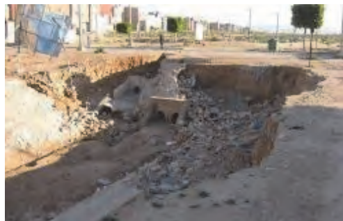
Endroit endommagé par l'érosion due aux écoulements d'eau lors d'inondations dans la commune.
