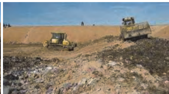
Excavation du sol au pied de la pente et utilisation de la couverture du sol de déblai
