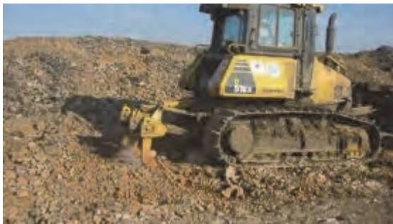
Apport de matériau de couverture composé de sol excavé au pied de la pente
