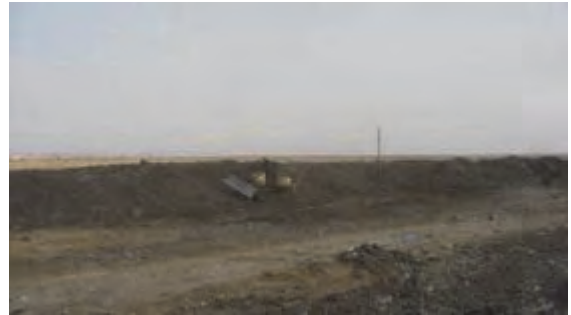
Mise en forme et compactage de la pente des déchets avant la couverture
