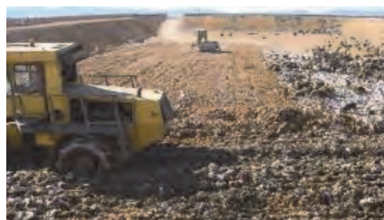
Opérations de compactage du sol sur la zone dans laquelle l'enfouissement est terminé à l'intérieur de la fosse
