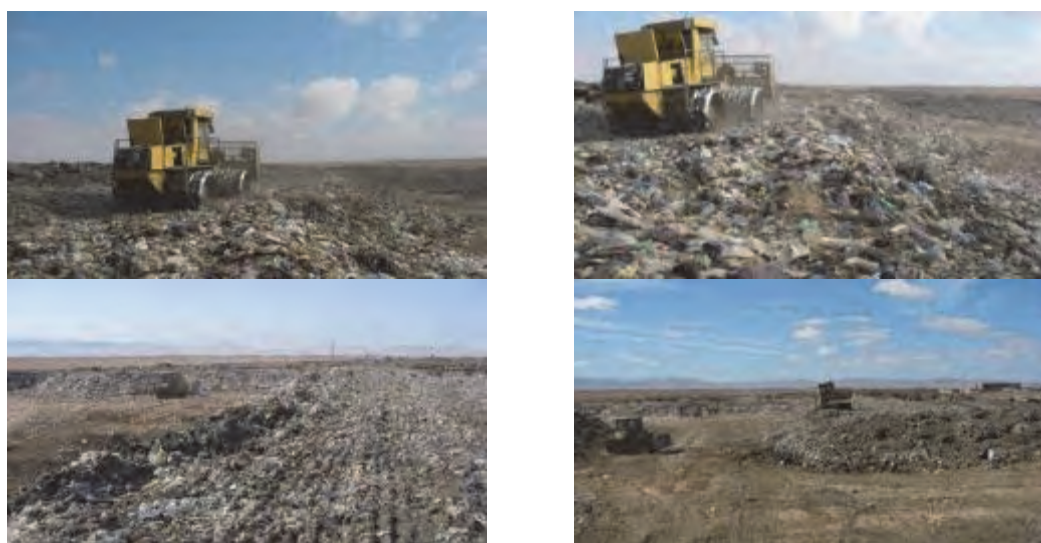
Essais de travaux de compactage par passages successifs dans le sens longitudinal de l'extrémité de la pente.
