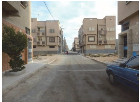
Expansion d'un côté de la nouvelle ville
