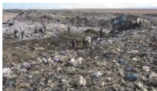
Travaux d'étalement des déchets en utilisant la lame du bulldozer
