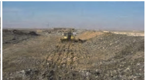
Approvisionnement au matériau de couverture en creusant dans le sol à proximité du pied de la pente.
