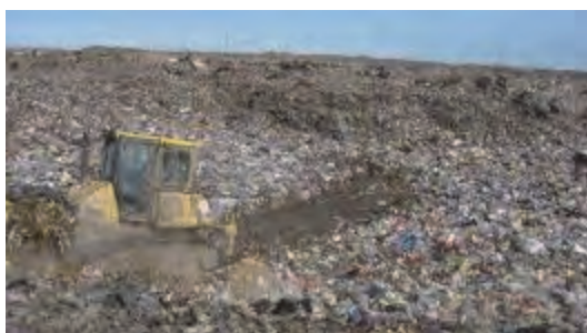
Travaux d'étalement des déchets en utilisant la lame du bulldozer
