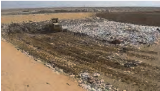
Travaux d'étalement des DMA dans l'aire au fond à gauche dans la fosse
