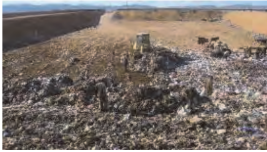
Travaux d'étalement des DMA dans l'aire au fond à droite dans la fosse
