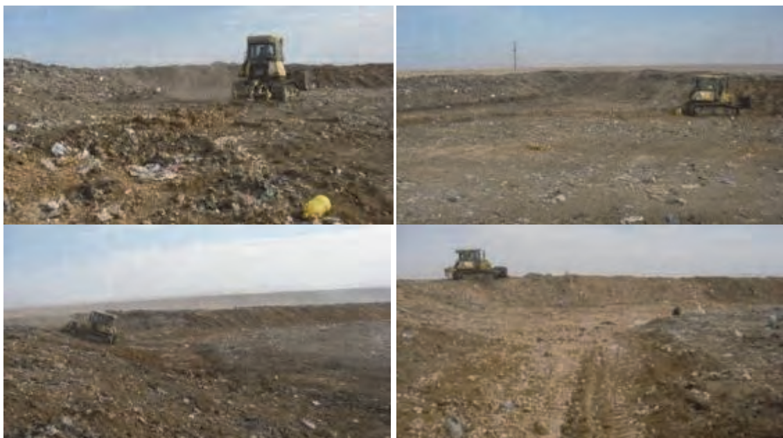
Travaux d'excavation du fossé latéral (section courbe)
