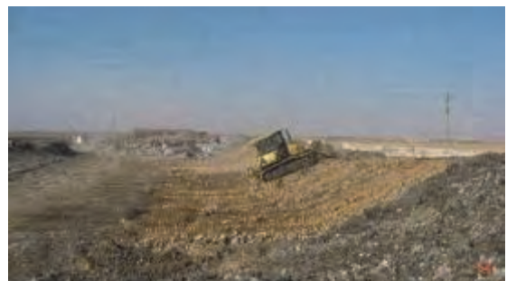
Approvisionnement au matériau de couverture en creusant dans le sol à proximité du pied de la pente.
