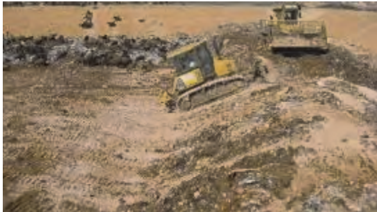
Travaux de couverture après le compactage dans l'aire au fond à droite dans la fosse
