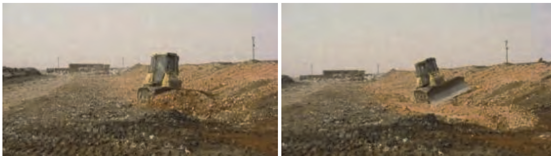
Travaux d'excavation du fossé latéral (section droite)
