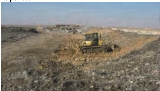
Travaux de couverture sur la pente.
