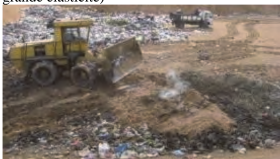
Isolement des DMA comprenant des déchets embrasés, et extinction du feu avec une couverture terreuse
