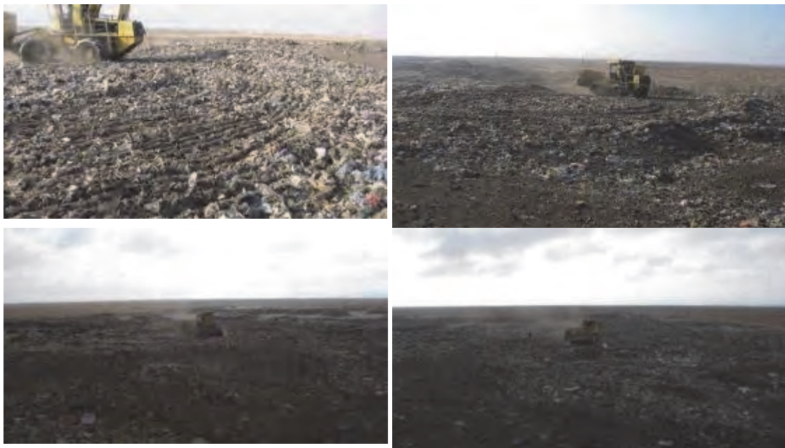
Essais de travaux de compactage du sol par passages successifs.
