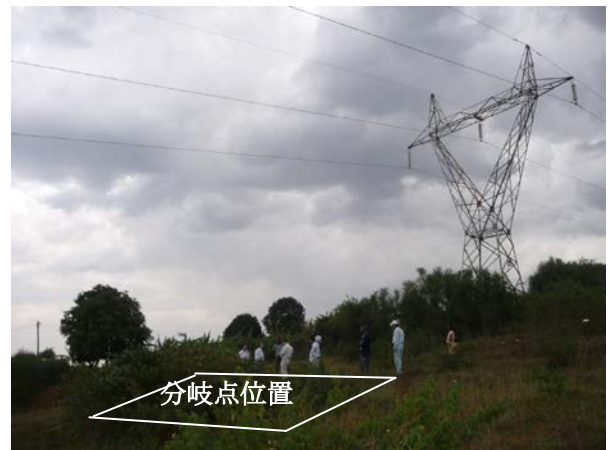
110 kV 送電線分岐点(本計画対象)の様子
