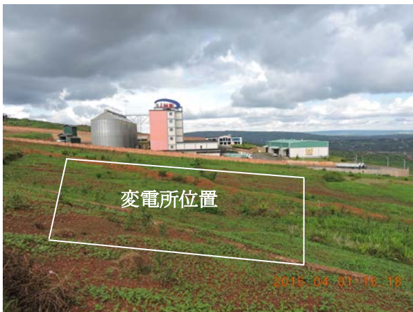
110/15kV ンデラ変電所(本計画対象)
