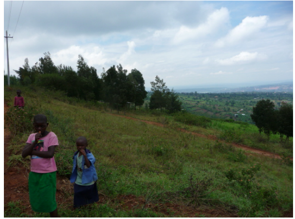
15 kV 配電線(本計画対象)のルートの様子
