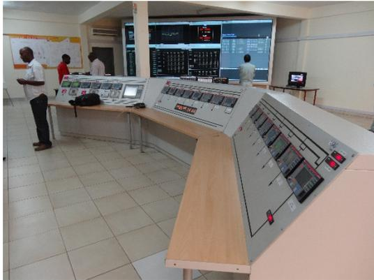
図 2-1-4.1 総合給電指令所の制御室
