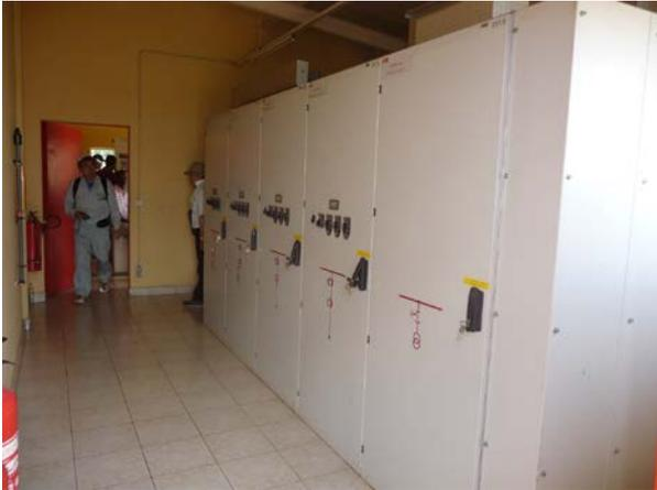
ガソギ変電所の 15 kV 開閉設備(既設)の様子
