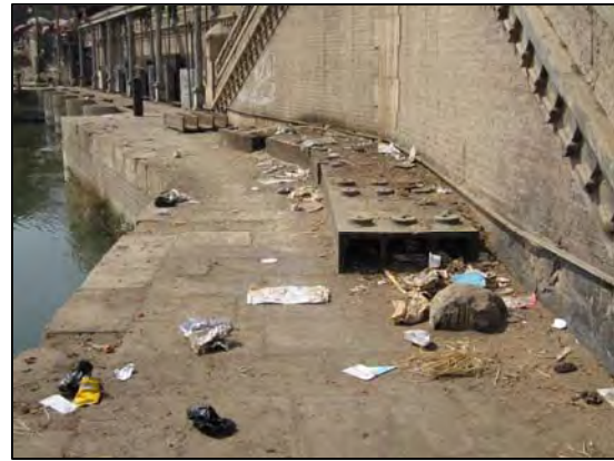
(写真-9 ダイリュート堰群上流)
