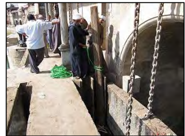
写真：ゲート全閉操作時の様相
