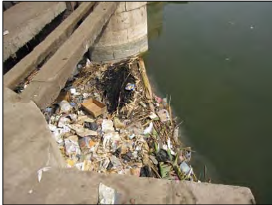
(写真-8 ダイリュート堰群上流)
