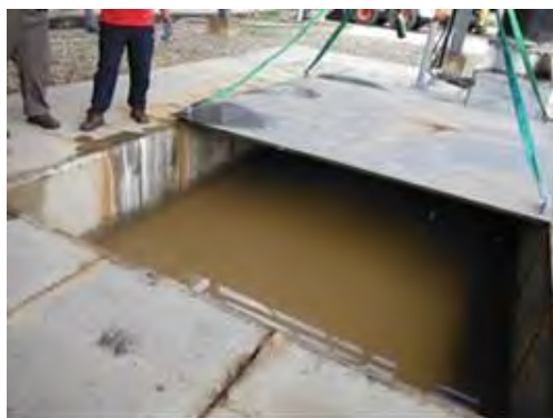
平窯式炭化システム内に流入した地下水
