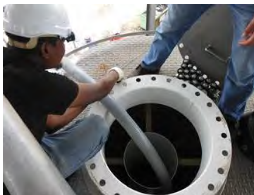
嫌気種汚泥移送
