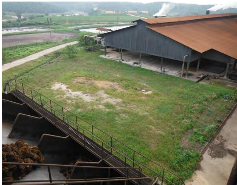
パイロットプラント建設用地
