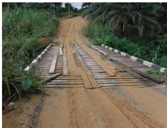
未舗装路に架かる簡易橋
