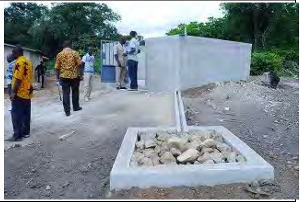
Langama 村と Yobouekro 村 (Diabo コミュニティ) 共有で新設する給水施設
