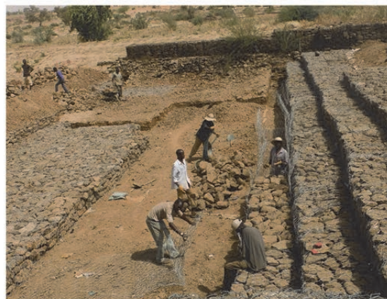
Travaux de réhabilitation de la Retenue d'eau du site de Koumchi en Janvier 2013
